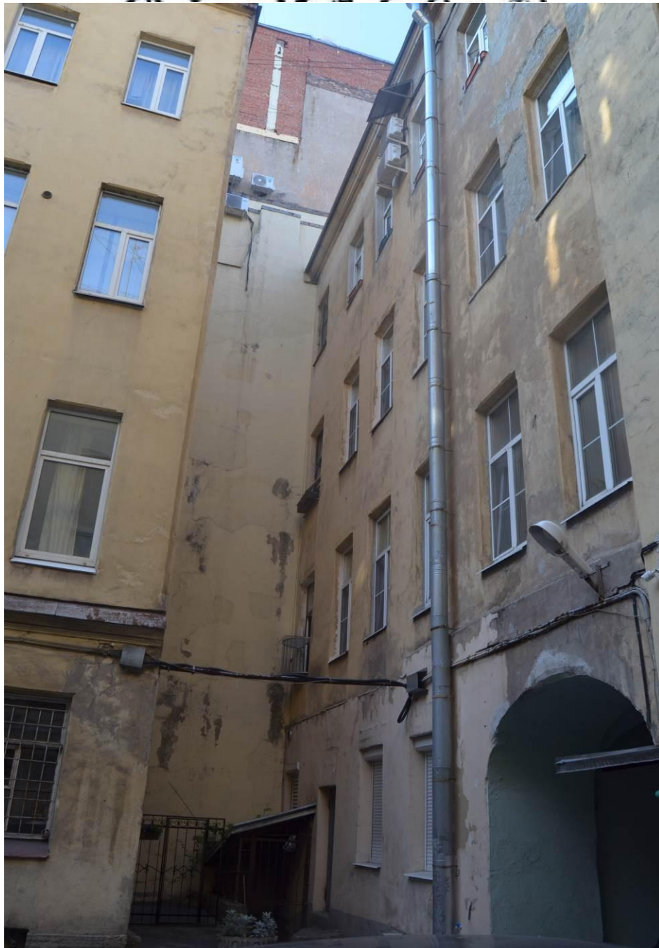
18. Выявленный объект культурного наследия «Дом А.Р. Гешвенда».
