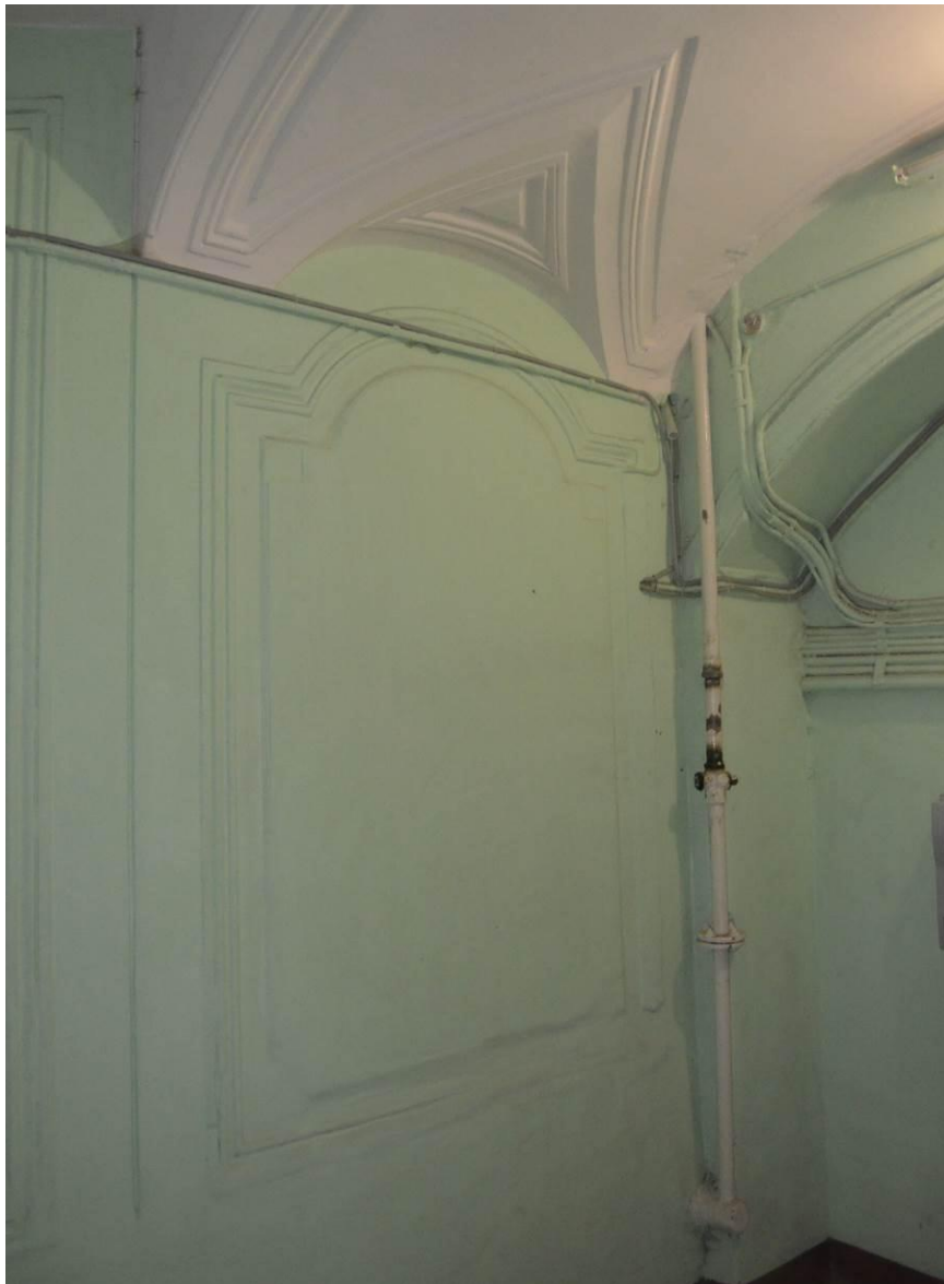
23. Выявленный объект культурного наследия «Дом А.Р. Гешвенда». Парадная лестница. Оформление стен лестничной площадки первого этажа. Вид с юга. Съемка 21.05.2021. Автор съемки Егорова Т.Г.
