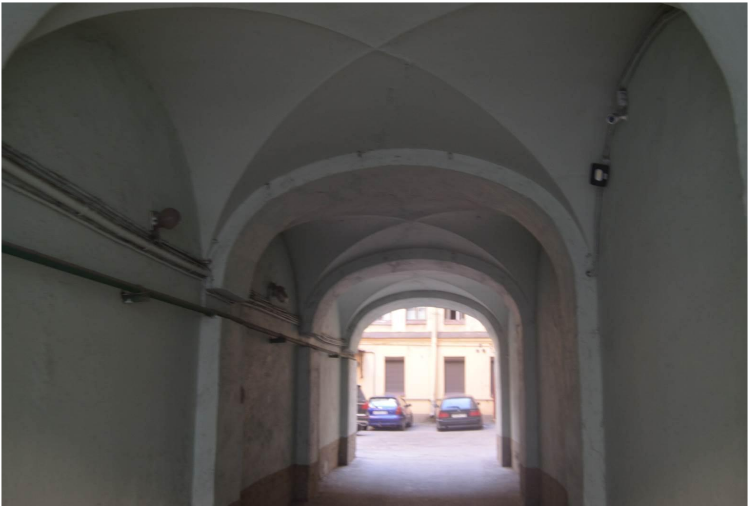
10. Выявленный объект культурного наследия «Дом А.Р. Гешвенда». Воротный проезд. Вид с северо-востока. Съемка 21.05.2021. Автор съемки Егорова Т.Г.
