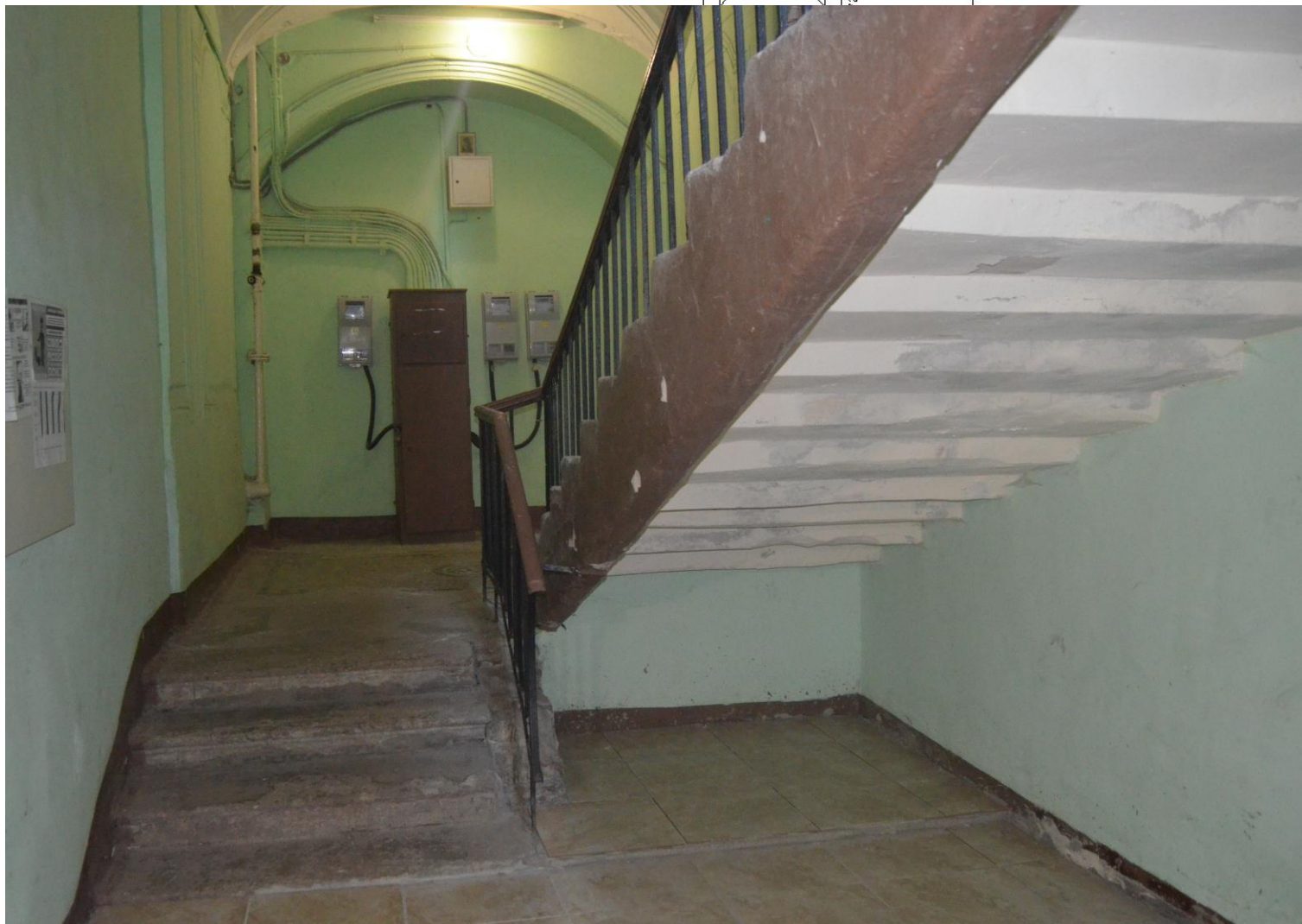
20. Выявленный объект культурного наследия «Дом А.Р. Гешвенда». Парадная лестница. Вестибюль. Вид с юго-запада. Съемка 21.05.2021. Автор съемки Егорова Т.Г.
