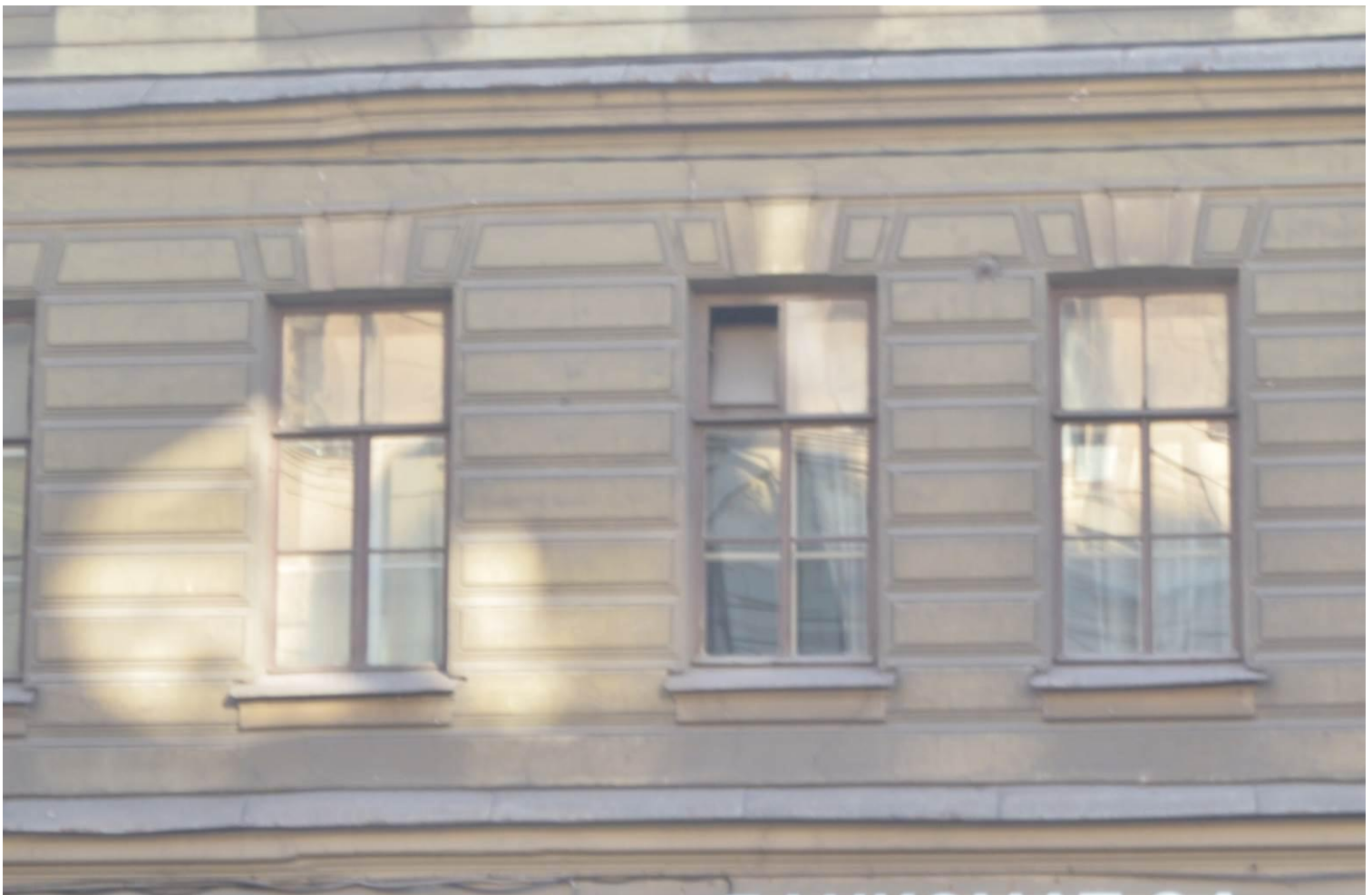
4. Выявленный объект культурного наследия «Дом А.Р. Гешвенда». Лицевой (северо-восточный) фасад. Оформление центральной части второго этажа.
