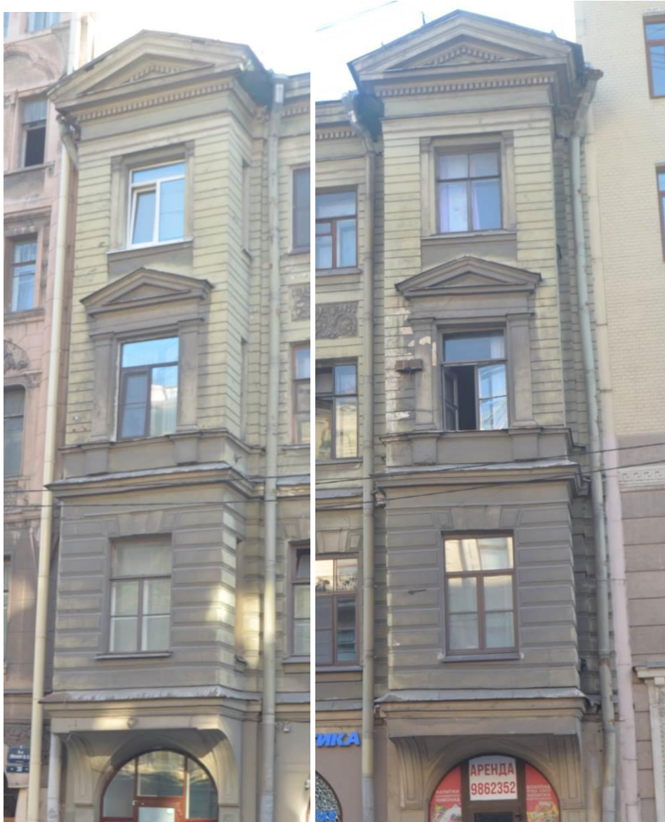
2. Выявленный объект культурного наследия «Дом А.Р. Гешвенда». Лицевой (северо-восточный) фасад. Эркеры лицевого фасада. Вид с северо-востока.
