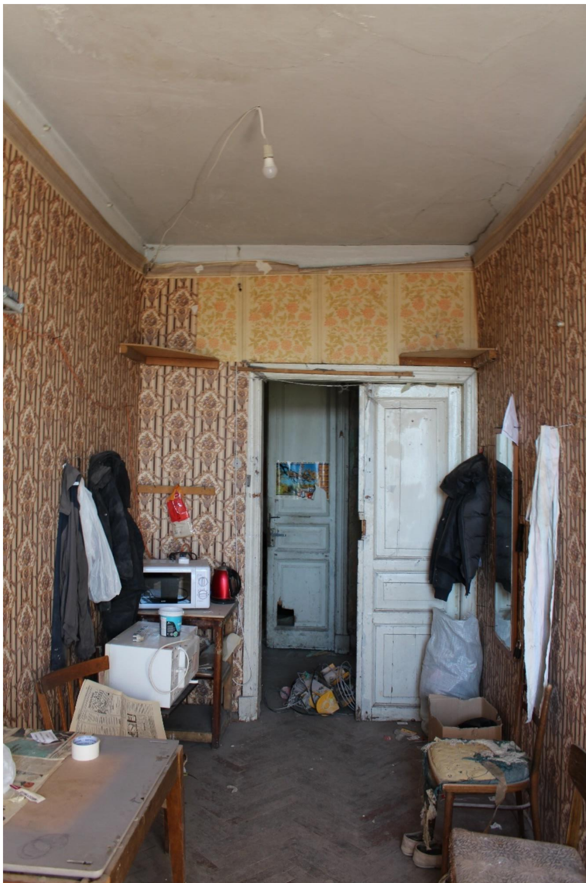
Фото 22. Вид на помещение № 17.
