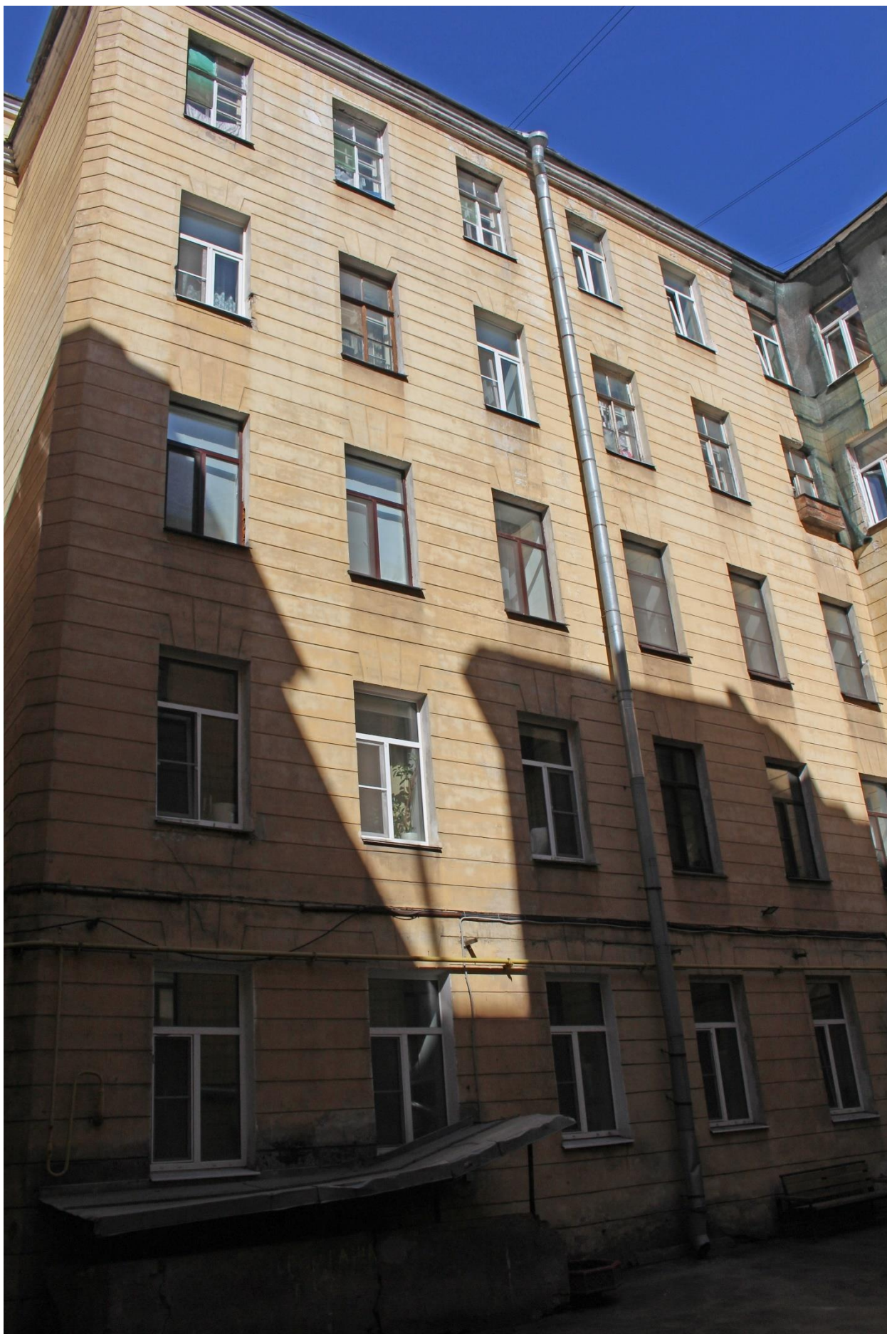
Фото 11. Вид на северный дворовый корпус южного двора.
