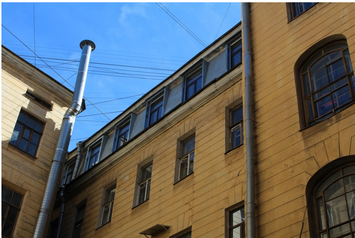
Фото 9. Вид на оконные проемы квартиры № 11 со стороны двора.
