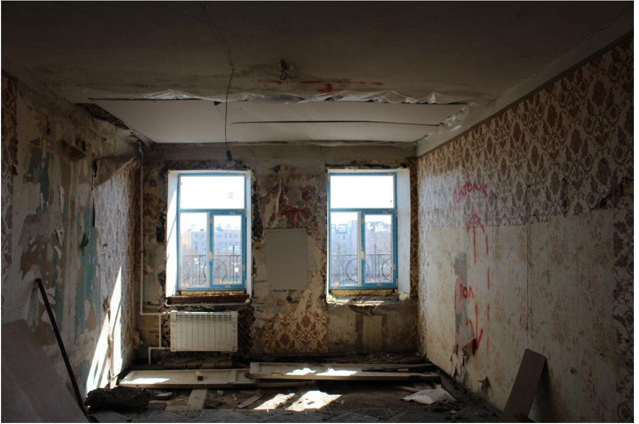
Фото 36. Вид на помещение № 14.
