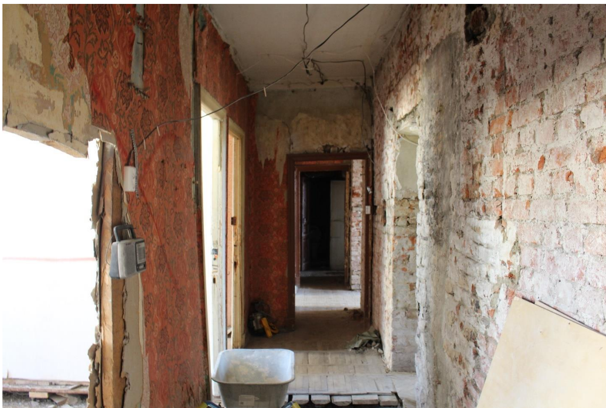
Фото 30. Вид на помещение № 19 в сторону помещения № 20.
