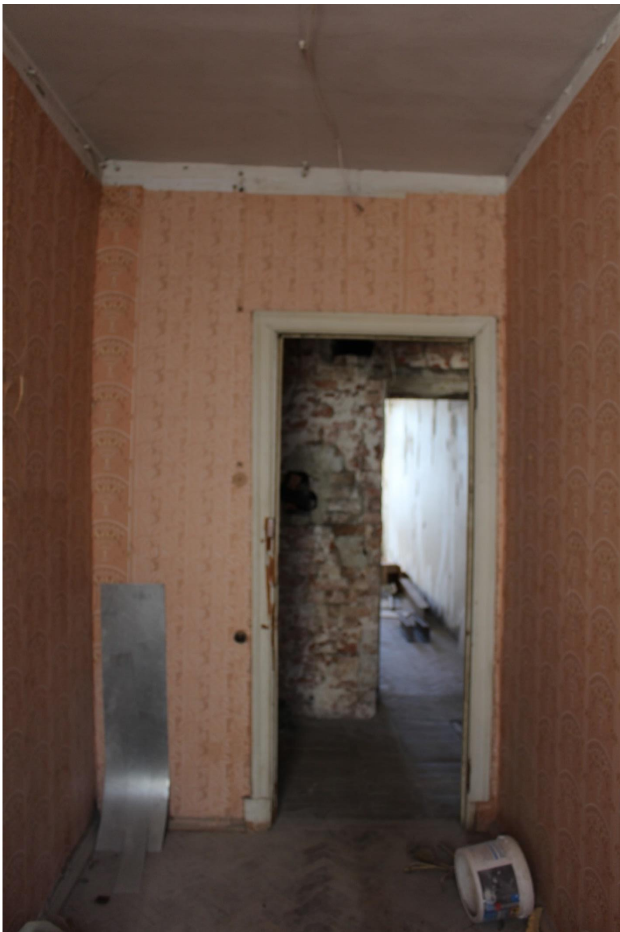
Фото 34. Вид на помещение № 5.
