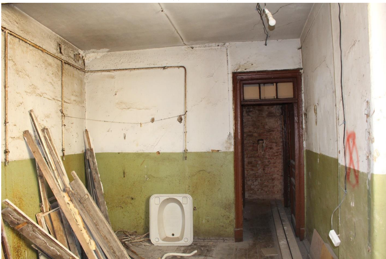
Фото 46. Вид на помещение № 8.
