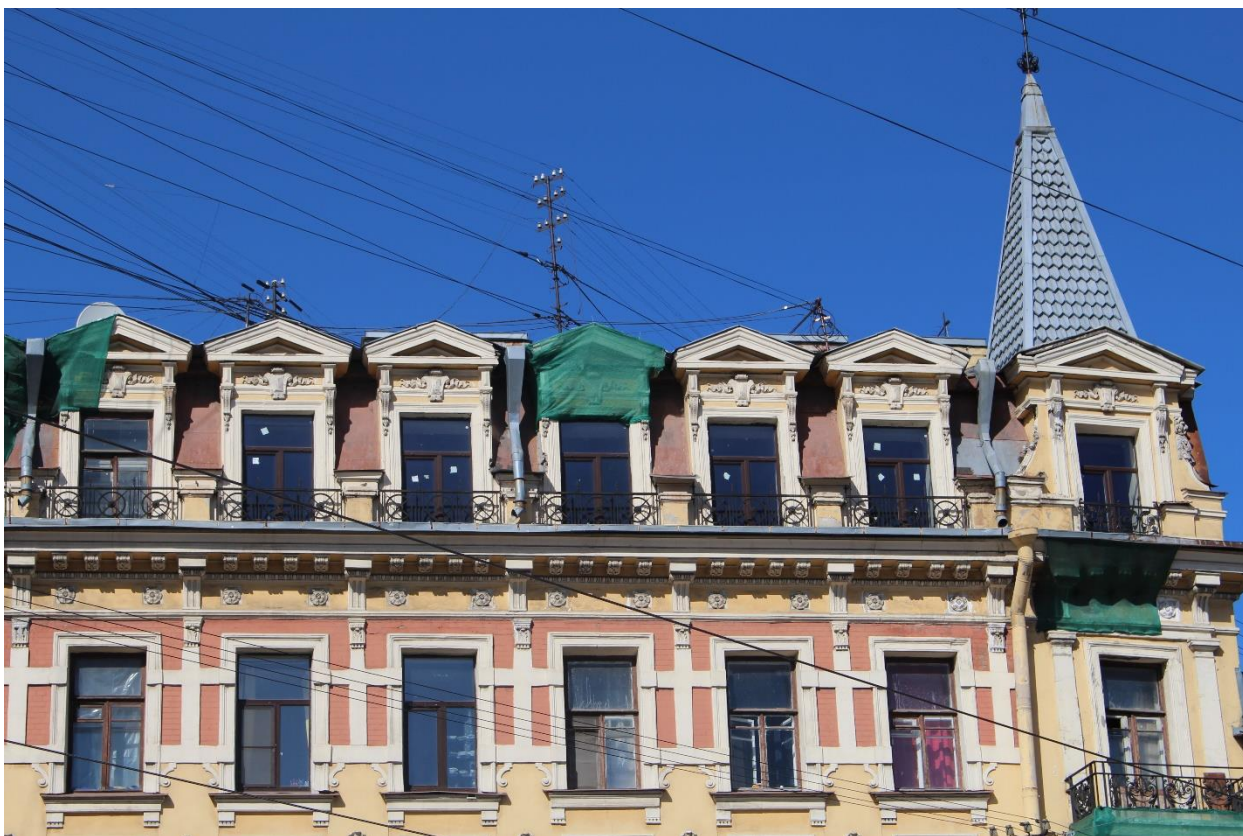
Фото 3. Вид на оконные проемы квартиры № 11 с юга.
