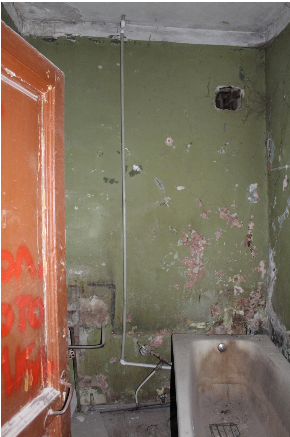
Фото 44. Вид на помещение № 9.
