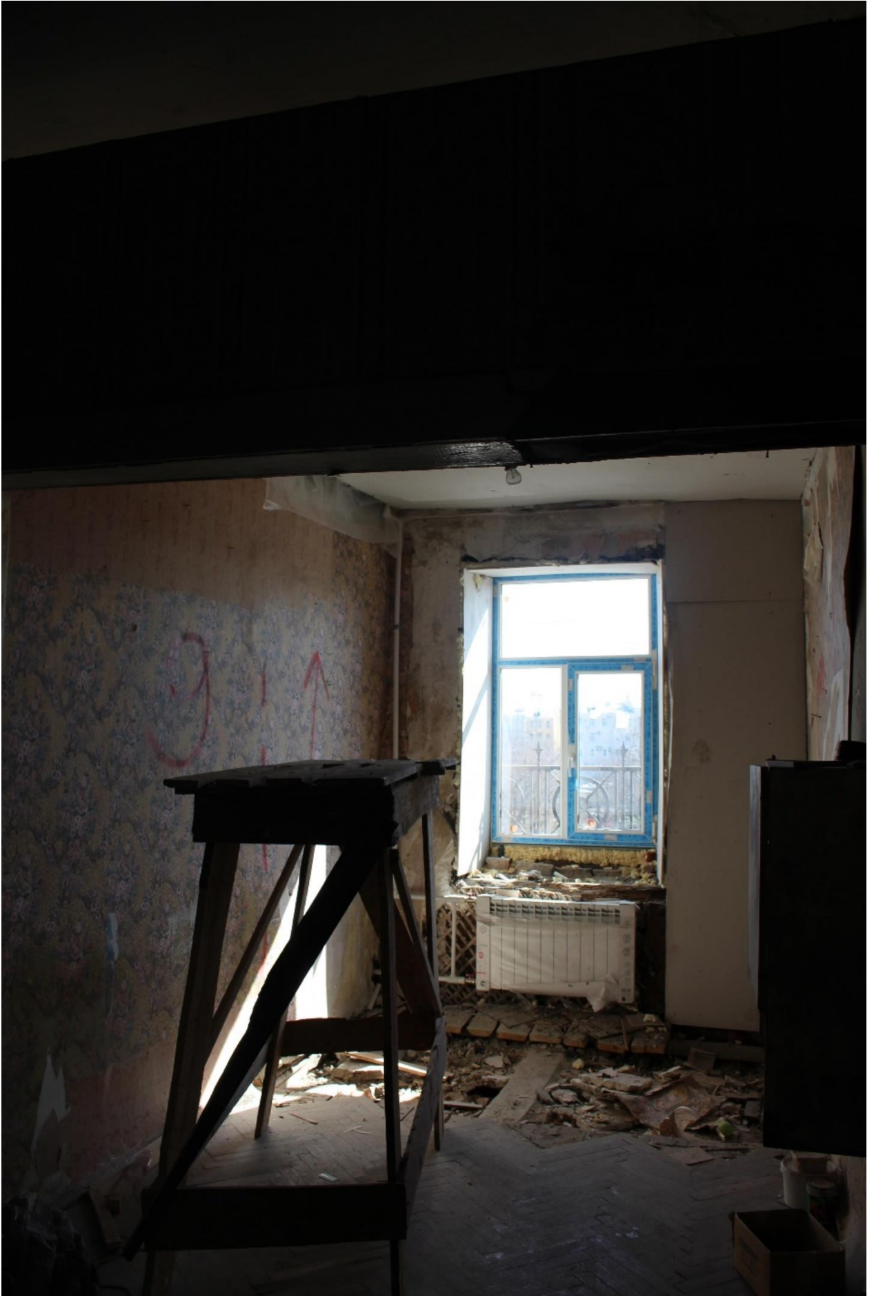
Фото 23. Вид на помещение № 16.
