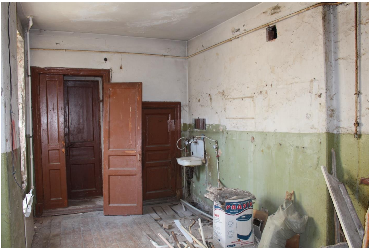
Фото 45. Вид на помещение № 8.
