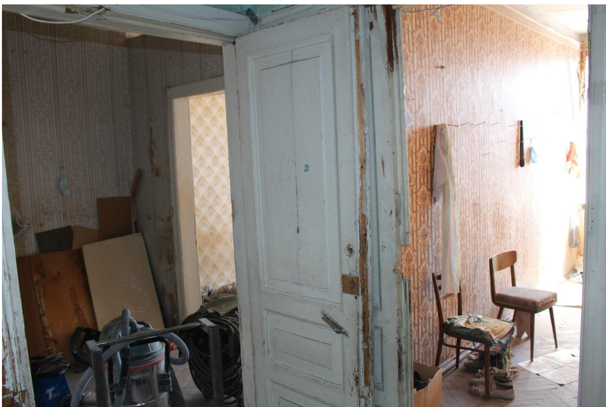
Фото 20. Вид на помещение № 18, ведущее в помещения № 16 и № 17.
