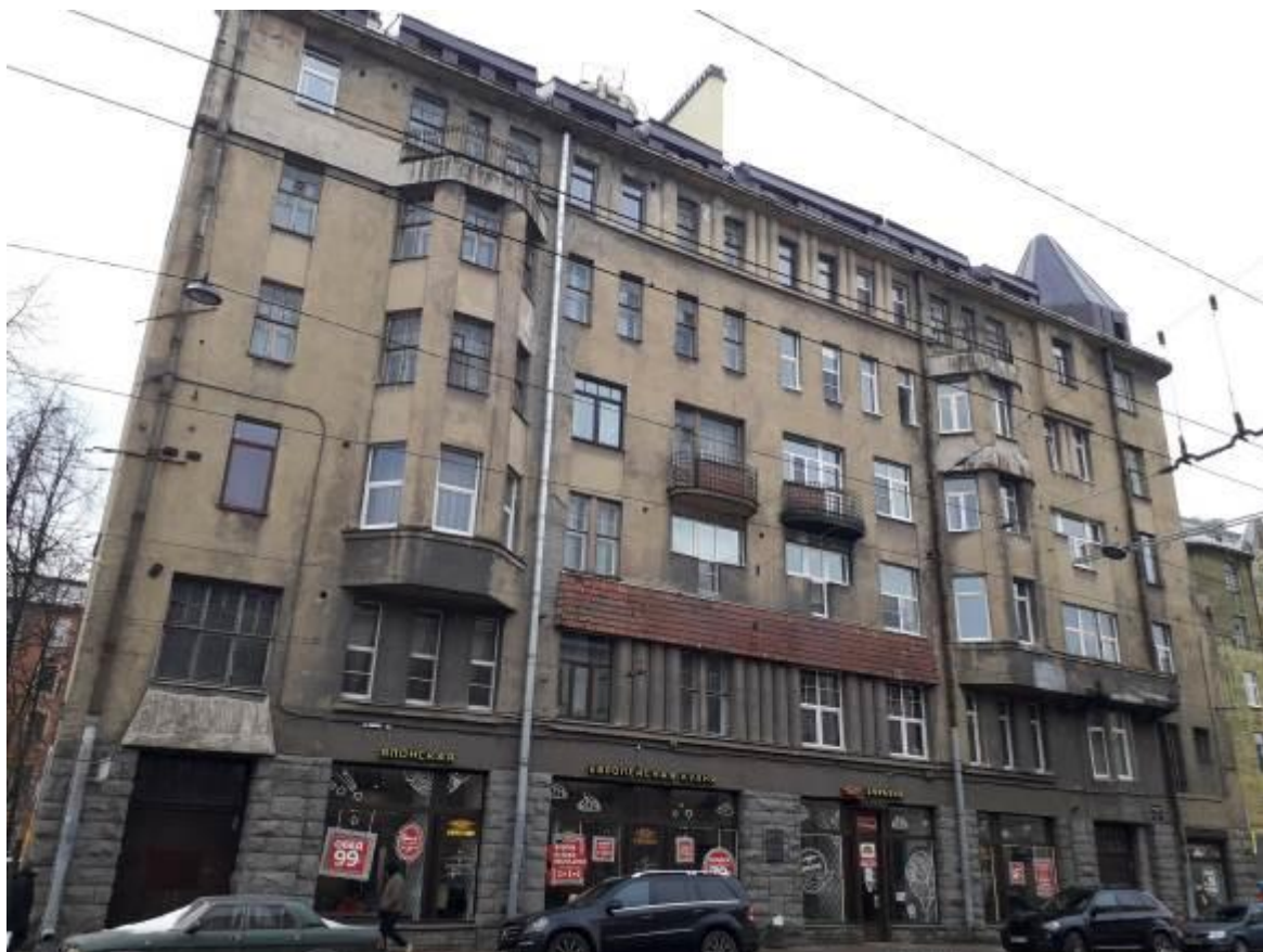
33. Доходный дом. Здания при Латышской лютеранской церкви Христа Спасителя. Загородный пр., д. 64, лит. А. Фото мест установки оборудования и кабельных трасс. Штиглиц М.С. 06.03.2022.
