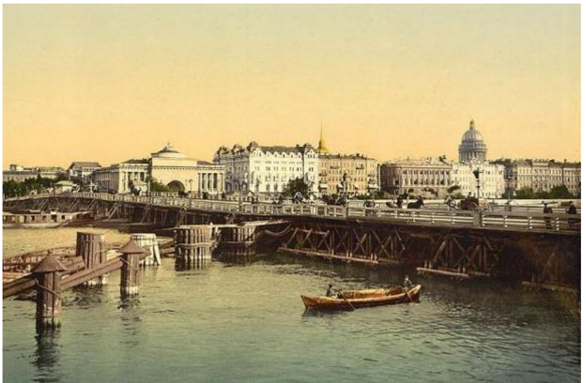
2. Здания Государственного Дворянского земельного банка. Адмиралтейская наб., д. 12-14, лит. А. Фото - начало XX в. (24).
