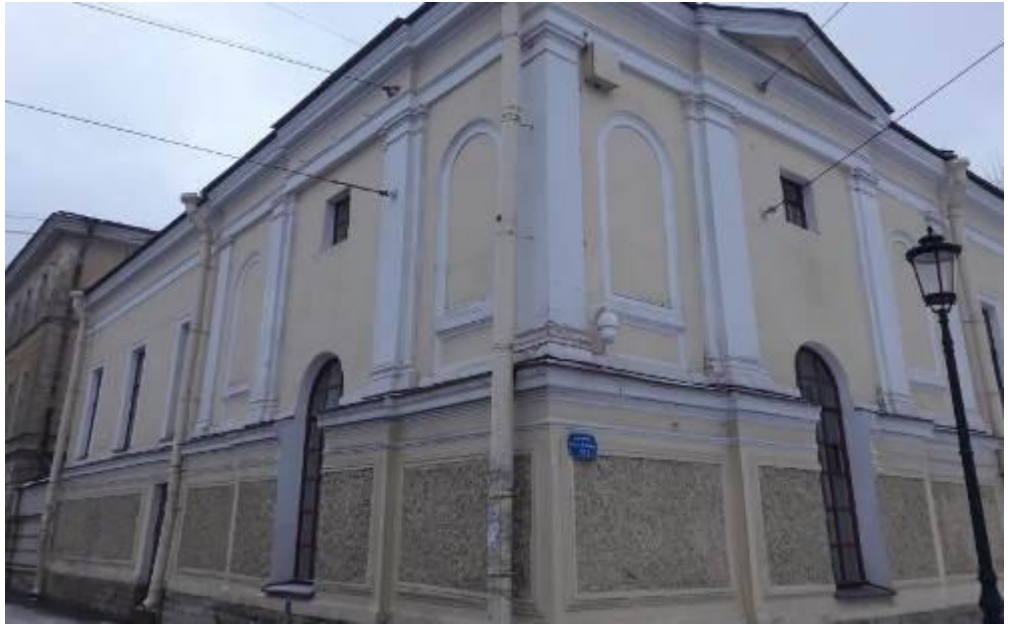
16. Часовня у Троицкого собора. Александровская больница для рабочего населения в память 19-го февраля 1861 г. Комплекс с территорией, садом, оградами и постаментом от несохранившегося бюста имп. Александра II. Фонтанки реки наб., д. 132, лит. Д. Лицевой фасад. Фото мест установки оборудования и кабельных трасс. Штиглиц М.С. 06.03.2022.
