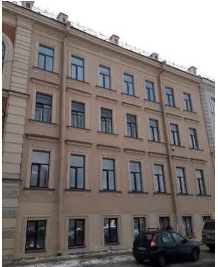
30. Демидовский дом призрения трудящихся. Мойки наб. реки, д. 108, лит. А. Фото мест установки оборудования и кабельных трасс. Штиглиц М.С. 06.03.2022.
