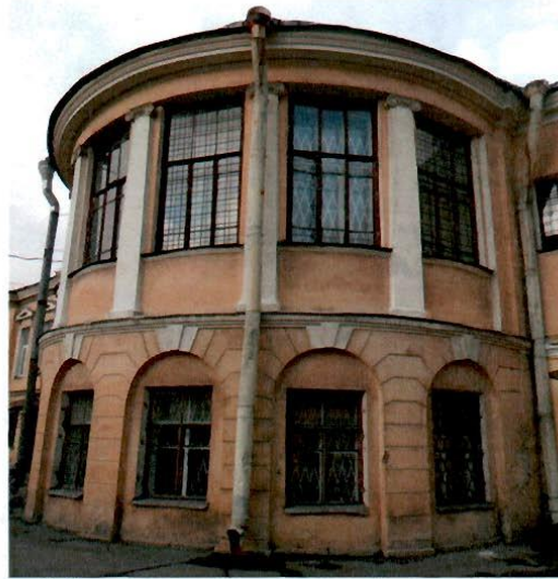
9. Фрагмент южного лицевого фасада здания.
