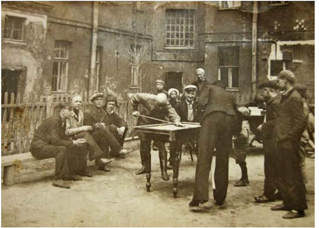
47. Доходный дом. Здания при Латышской лютеранской церкви Христа Спасителя. Загородный пр., д. 64, лит. А. Вид со двора. Фото 1940 г. (24).
