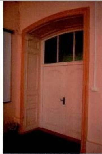
15. (Фрагмент интерьера в уровне 3-го этажа)
