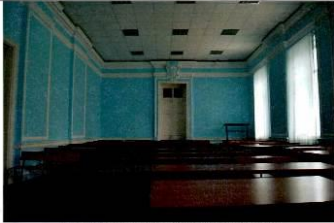
10. (Фрагмент интерьера в уровне 2-го этажа)
