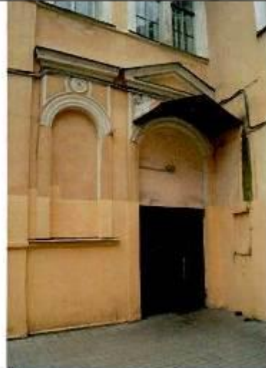
19. (Оформление входа в здание в центральной части северного фасада)
