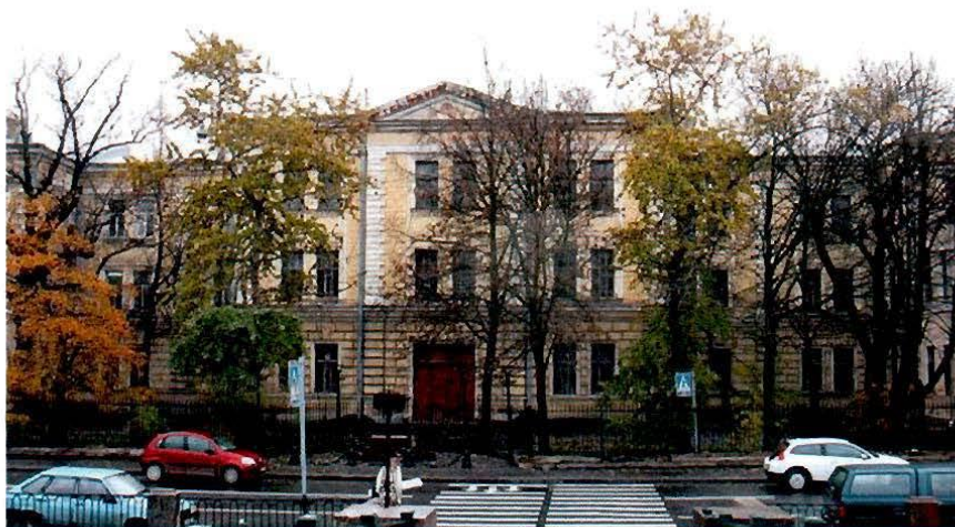
1. Фрагмент северного лицевого фасада здания со стороны наб. р. Фонтанки.
