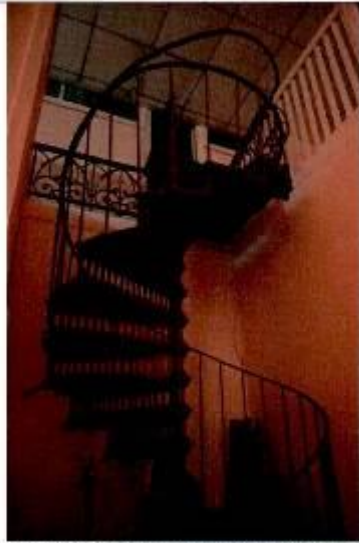
14. (Винтовая лестница в уровне 3-го этажа)
