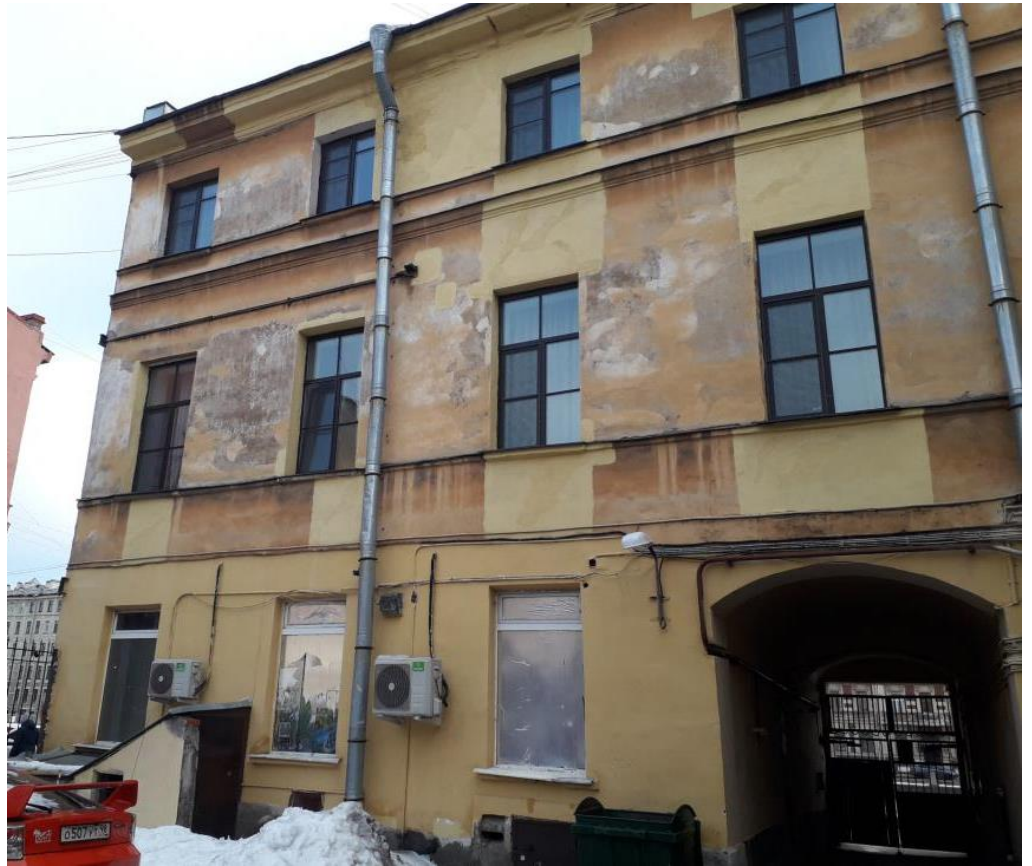
23. Дома Полторацкой С.М. (три). Фонтанки реки наб., д. 97, лит. А. Дворовый фасад. Фото мест установки оборудования и кабельных трасс. Штиглиц М.С. 06.03.2022.
