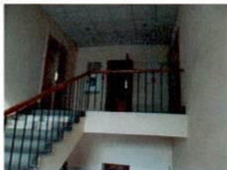
23. Лестничная клетка 4Н (36)
