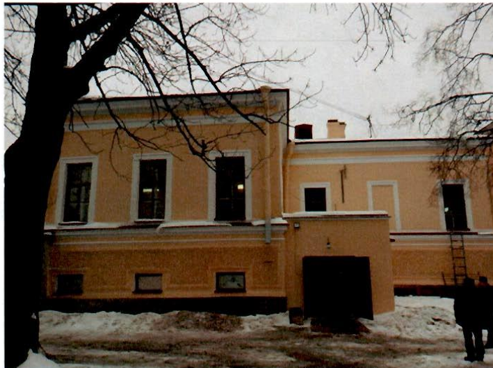
15. Северный дворовый фасад здания.
