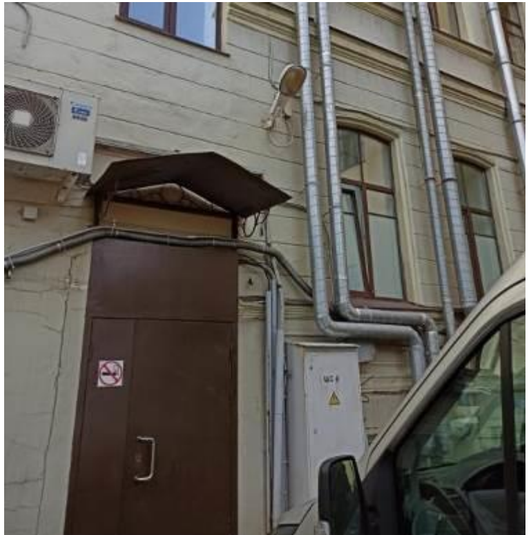
20. Главное здание по наб. р. Фонтанки. Крестовоздвиженская община сестер милосердия. Фонтанки реки наб., д. 154, лит. Г. Дворовый фасад. Фото мест установки оборудования и кабельных трасс. Штиглиц М.С. 06.03.2022.
