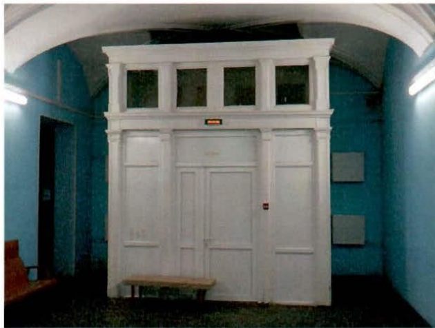
3. Тамбур парадного входа в здание.
