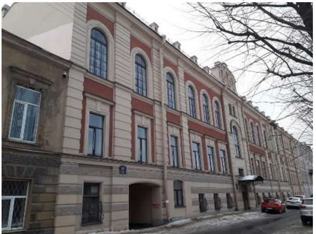
28. Демидовский дом призрения трудящихся. Мойки наб. реки, д. 108, лит. А. Фото мест установки оборудования и кабельных трасс. Штиглиц М.С. 06.03.2022.
