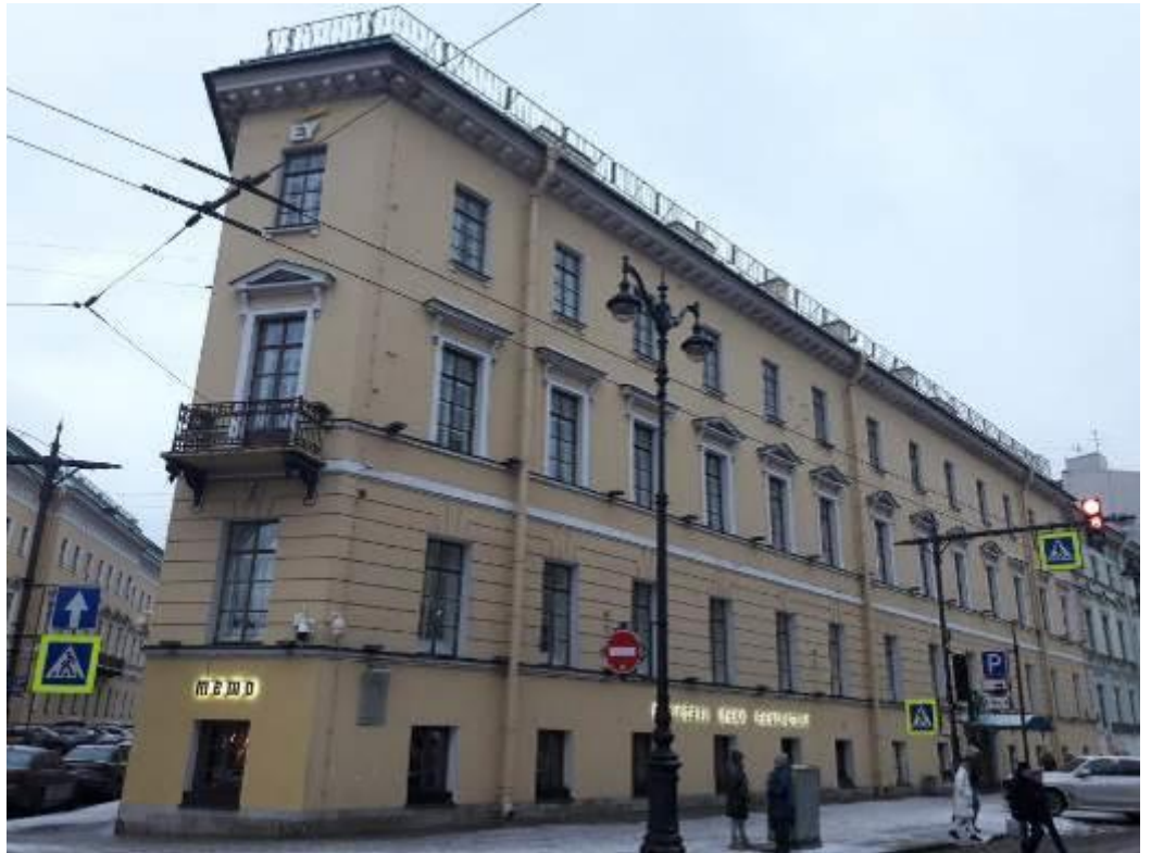
8. Дом, где в 1847-1849 гг. жил писатель Достоевский Ф.М. Малая Морская ул., д. 23, лит. А. Лицевой фасад. Фото мест установки оборудования и кабельных трасс. Штиглиц М.С. 06.03.2022.
