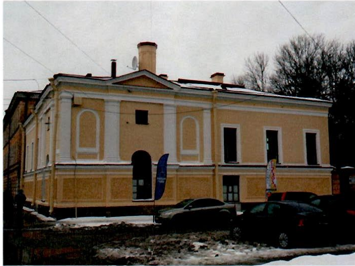
14. Восточный лицевой фасад здания.
