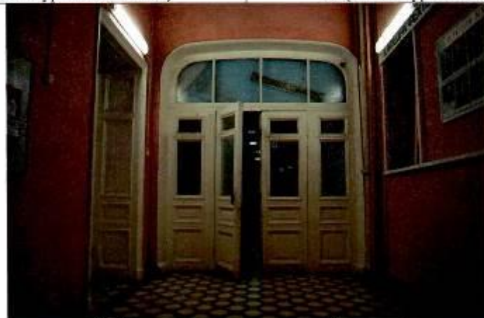
13. (Фрагмент интерьера в уровне 3-го этажа)
