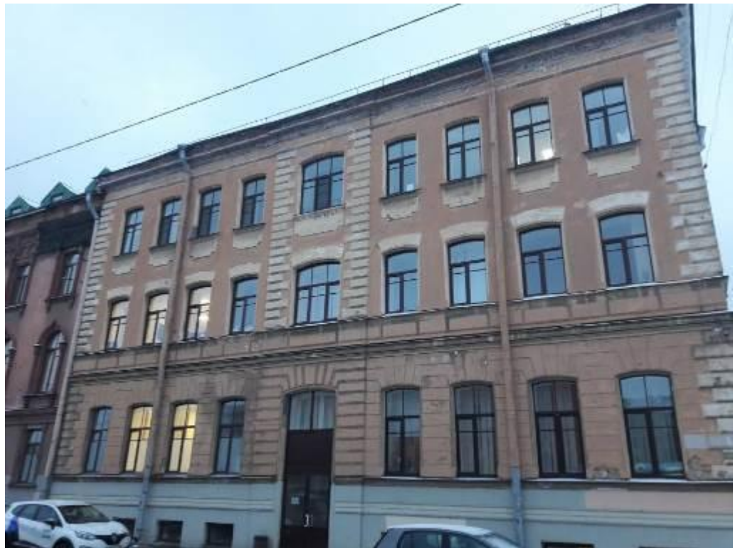
17. Главное здание по наб. р. Фонтанки. Крестовоздвиженская община сестер милосердия. Фонтанки реки наб., д. 154, лит. Г. Лицевой фасад. Фото мест установки оборудования и кабельных трасс. Штиглиц М.С. 06.03.2022.
