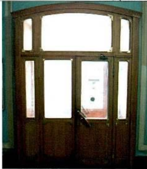
8. (Тамбур парадного входа в здание)
