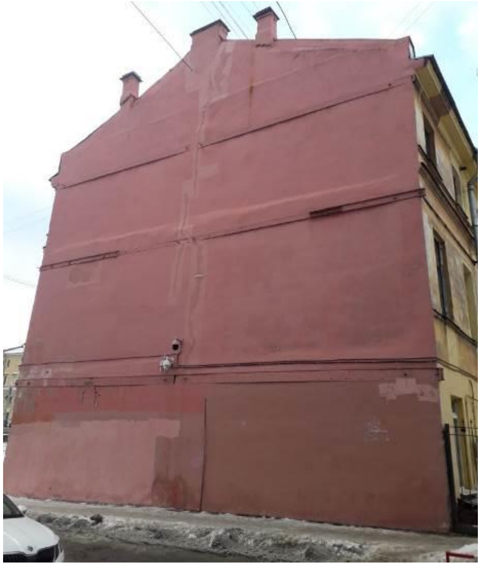
22. Дома Полторацкой С.М. (три). Фонтанки реки наб., д. 97, лит. А. Боковой фасад. Фото мест установки оборудования и кабельных трасс. Штиглиц М.С. 06.03.2022.
