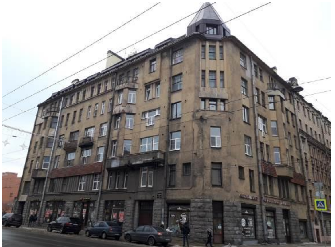
32. Доходный дом. Здания при Латышской лютеранской церкви Христа Спасителя. Загородный пр., д. 64, лит. А. Фото мест установки оборудования и кабельных трасс. Штиглиц М.С. 06.03.2022.
