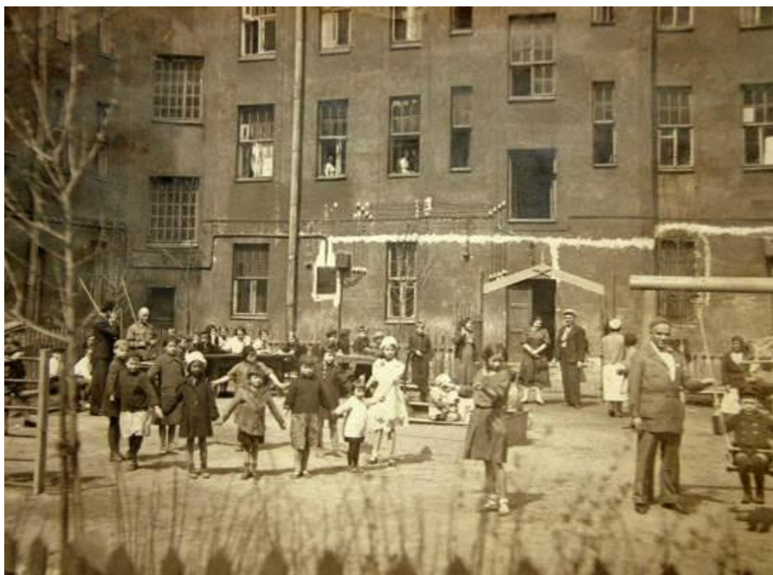
46. Доходный дом. Здания при Латышской лютеранской церкви Христа Спасителя. Загородный пр., д. 64, лит. А. Вид со двора. Фото 1940 г. (24).
