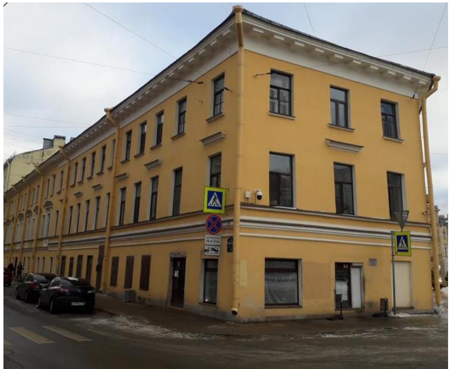
11. Дом Сутугиных. Грибоедова канала наб., д. 106, лит. А. Лицевой фасад. Фото мест установки оборудования и кабельных трасс. Штиглиц М.С. 06.03.2022.
