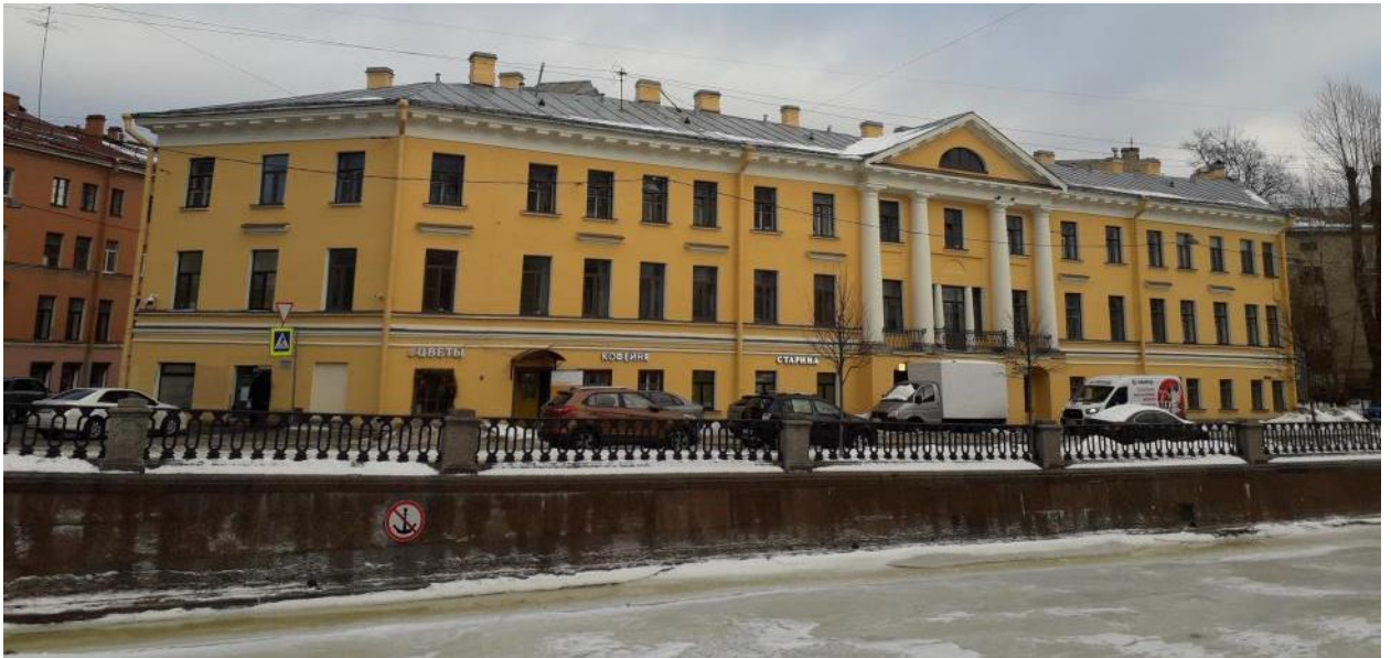
10. Дом Сутугиных. Грибоедова канала наб., д. 106, лит. А. Лицевой фасад. Фото мест установки оборудования и кабельных трасс. Штиглиц М.С. 06.03.2022.
