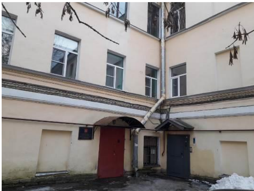
6. Дом Яковлевых (Евментьева А.Ф.). Гороховая ул., д. 57, лит. А. Дворовый фасад. Фото мест установки оборудования и кабельных трасс. Штиглиц М.С. 06.03.2022.
