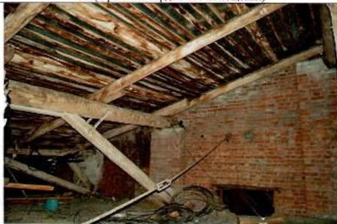
17. (Фрагмент чердачного помещения)
