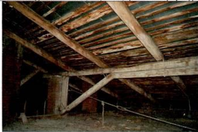
16. (Фрагмент чердачного помещения)
