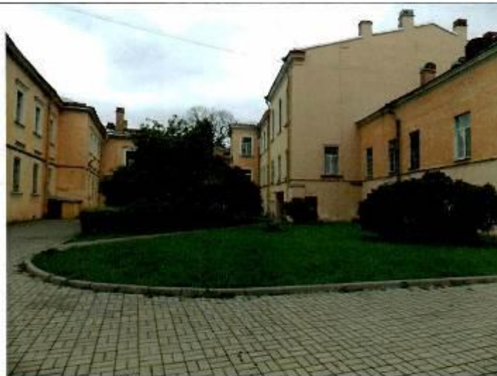
28. (Фрагмент северо-восточная часть)
