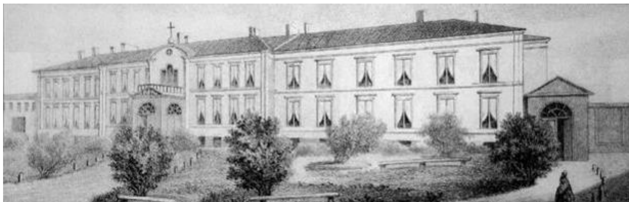
36. Демидовский дом призрения трудящихся. Мойки наб. реки, д. 108, лит. А. Главный корпус. 1833. (24).
