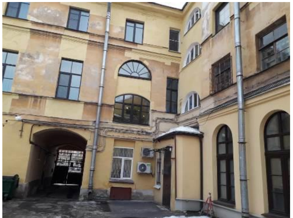
24. Дома Полторацкой С.М. (три). Фонтанки реки наб., д. 97, лит. А. Дворовый фасад. Фото мест установки оборудования и кабельных трасс. Штиглиц М.С. 06.03.2022.
