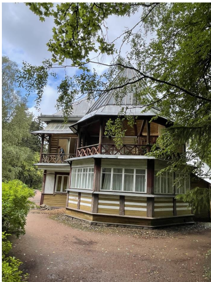
Фото №104. Вид на восточный фасад здания.
