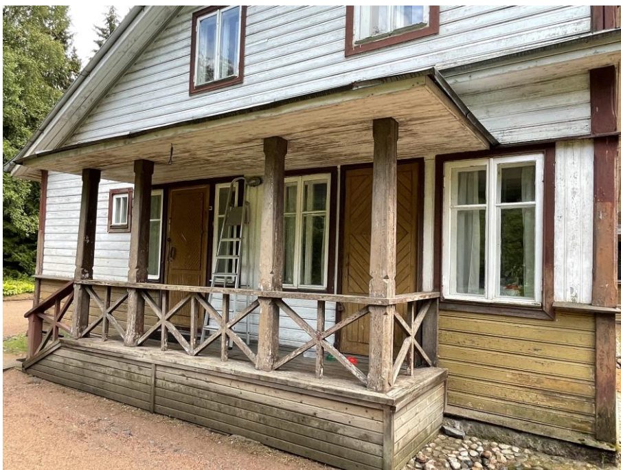
Фото №110. Крыльцо западного фасада здания.
