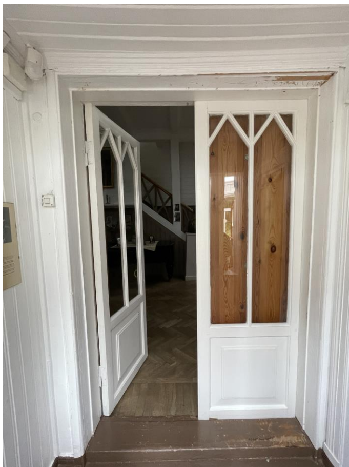
Фото №64. Дверной проем из помещения 1.16 в помещении 1.18 по плану ПИБ.
