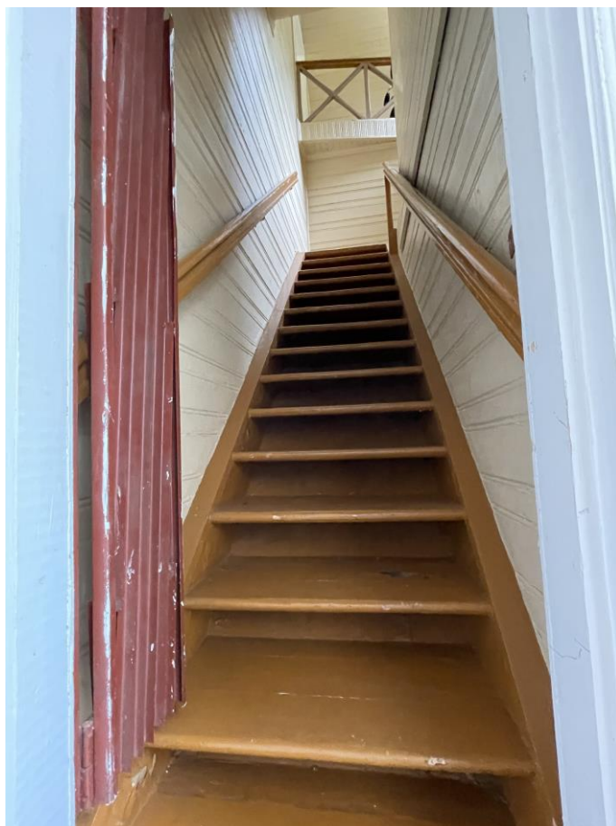
Фото №57. Лестница на 2 этаж в помещении 1.17 по плану ПИБ.
