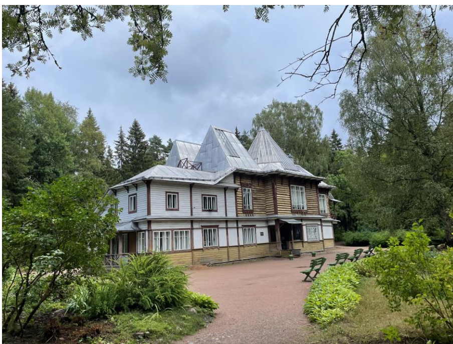
Фото №111. Общий вид здания и прилегающей территории.
