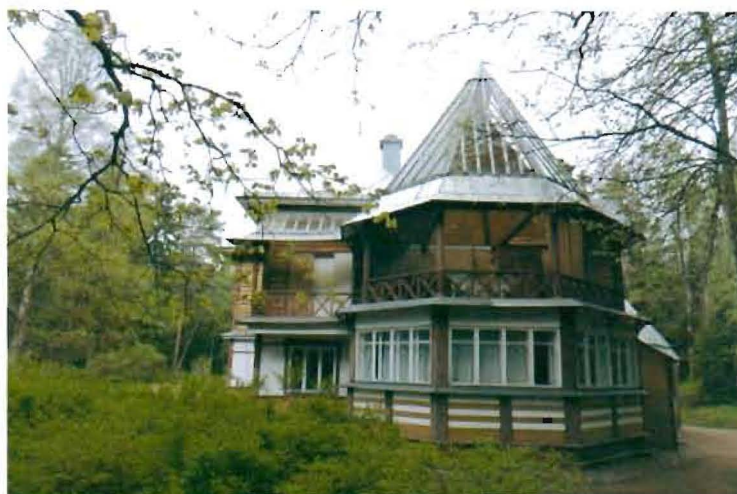
4. Южный лицевой фасад:
