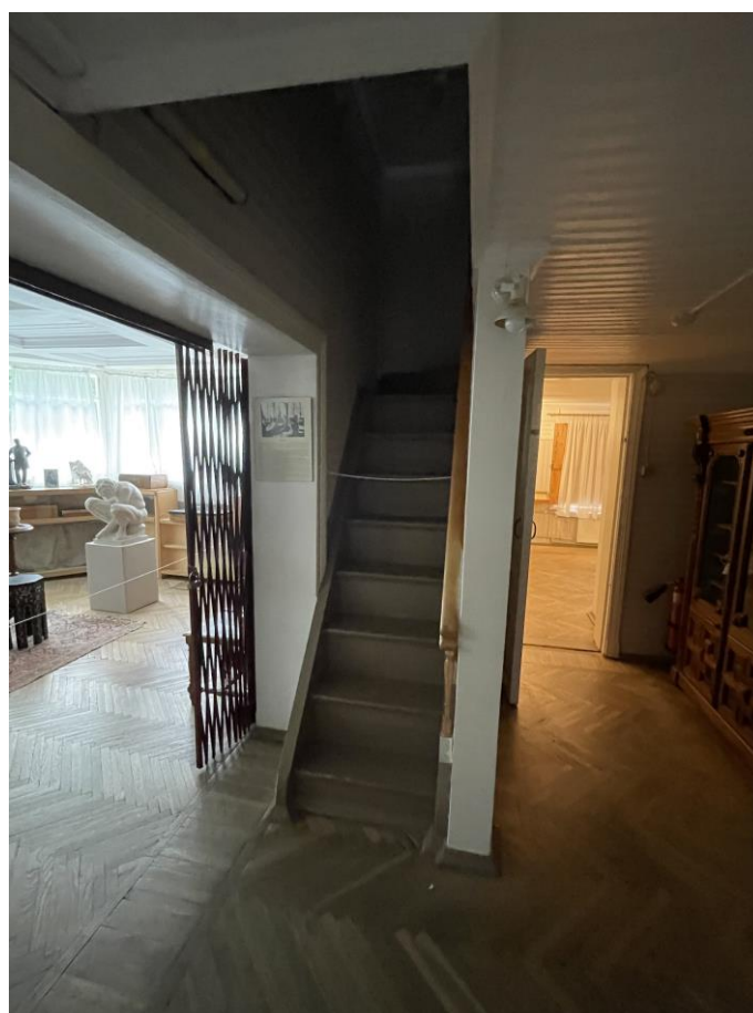
Фото №78. Помещение 1.19 по плану ПИБ, лестница на 2 этаж.
