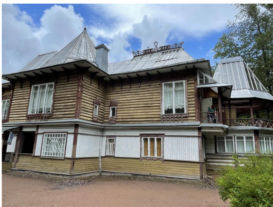
Фото №103. Южный фасад здания.
