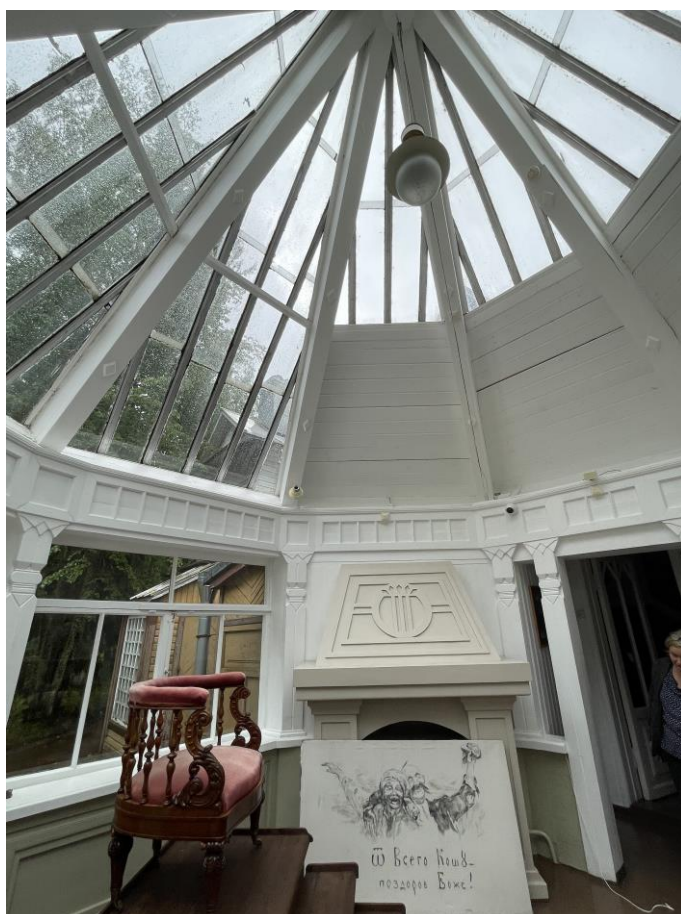
Фото №62. Стропильная система, камин в помещении 1.15.
