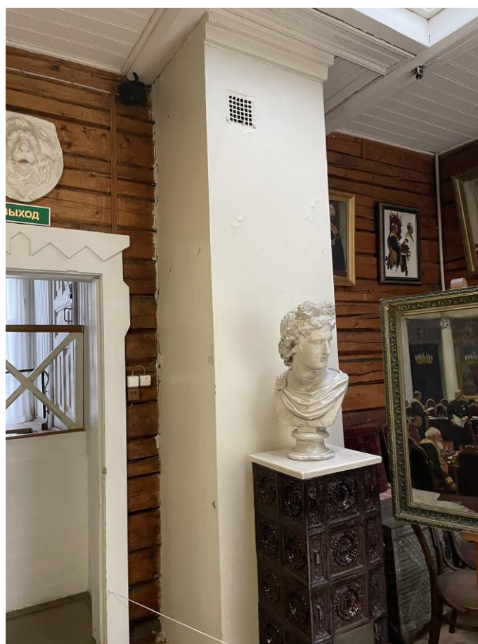
Фото №30. Дымовая труба в помещении 2.6 по плану ПИБ.
