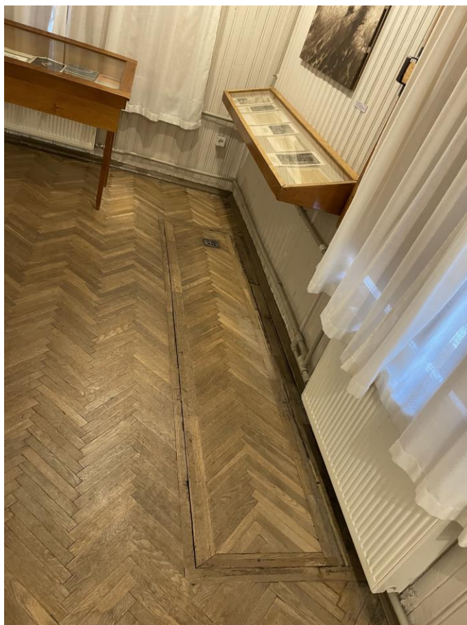
Фото №94. Люк в техподполье в помещении 1.25.
