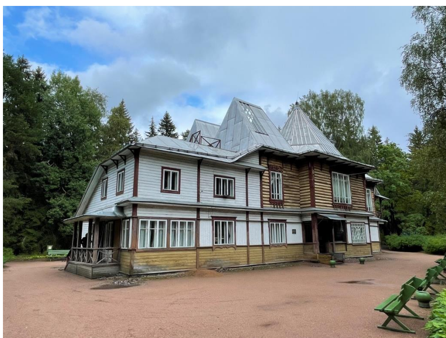
Фото №101. Общий вид объекта, западный и южный фасады здания.
