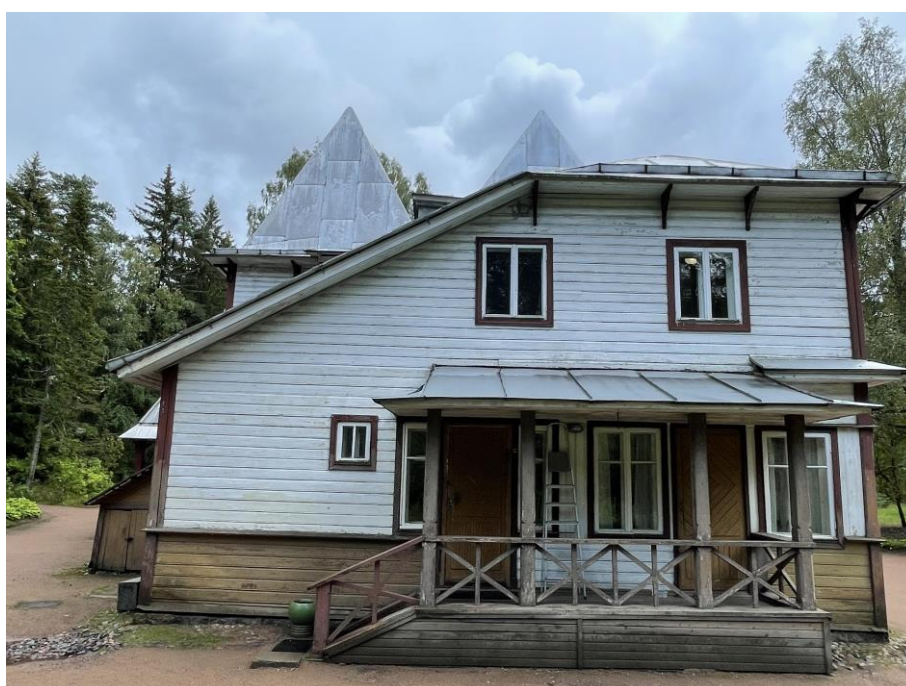
Фото №109. Западный фасад здания.
