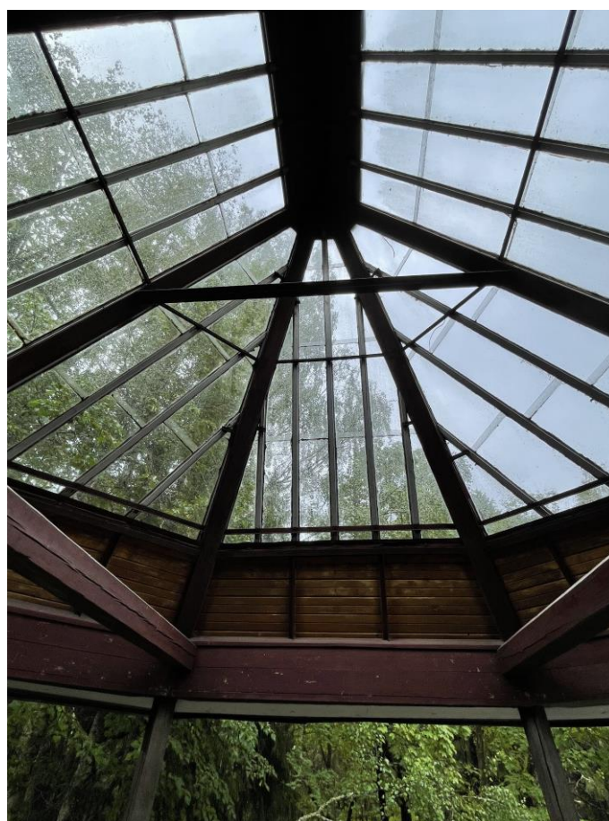
Фото №46. Стропильная система над открытой верандой.
