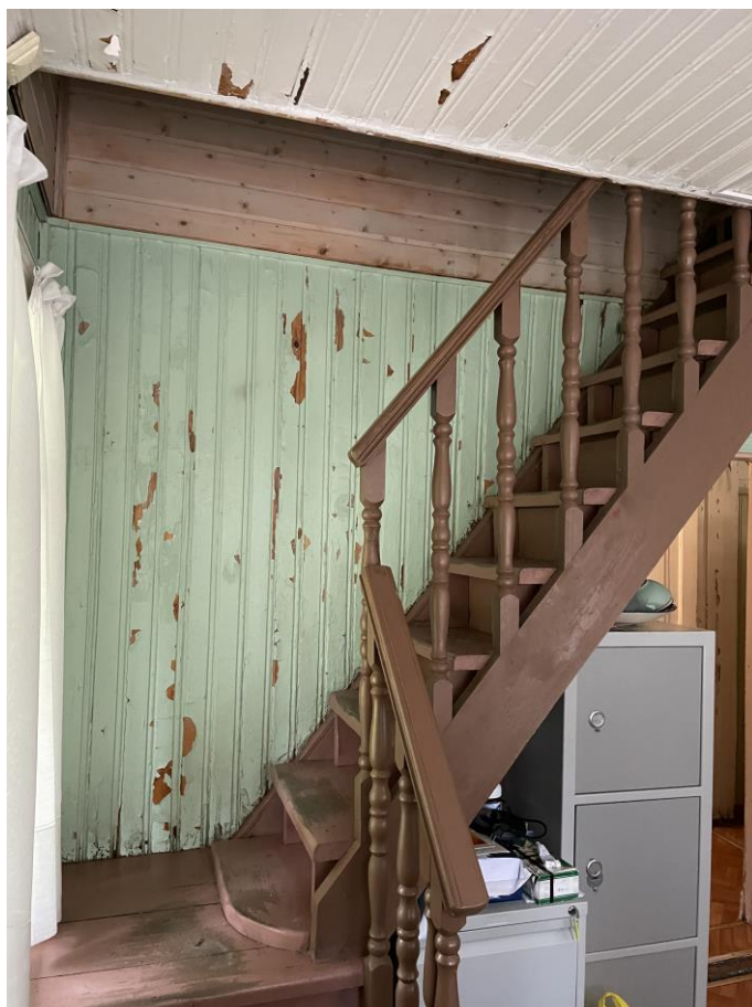
Фото №9. Лестница на второй этаж в помещении 1.1 по плану ПИБ.
