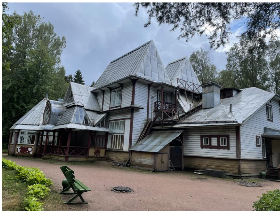
Фото №108. Вид на северный и часть западного фасада здания.
