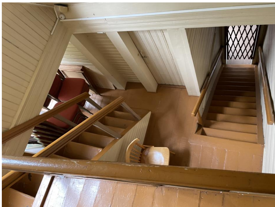
Фото №41. Помещение 1.15 по плану ПИБ, лестница на 1 этаж.
