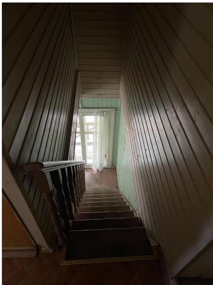
Фото №11. Лестница на 1 этаж из помещения 2.1 в помещение 1.1 по плану ПИБ.
