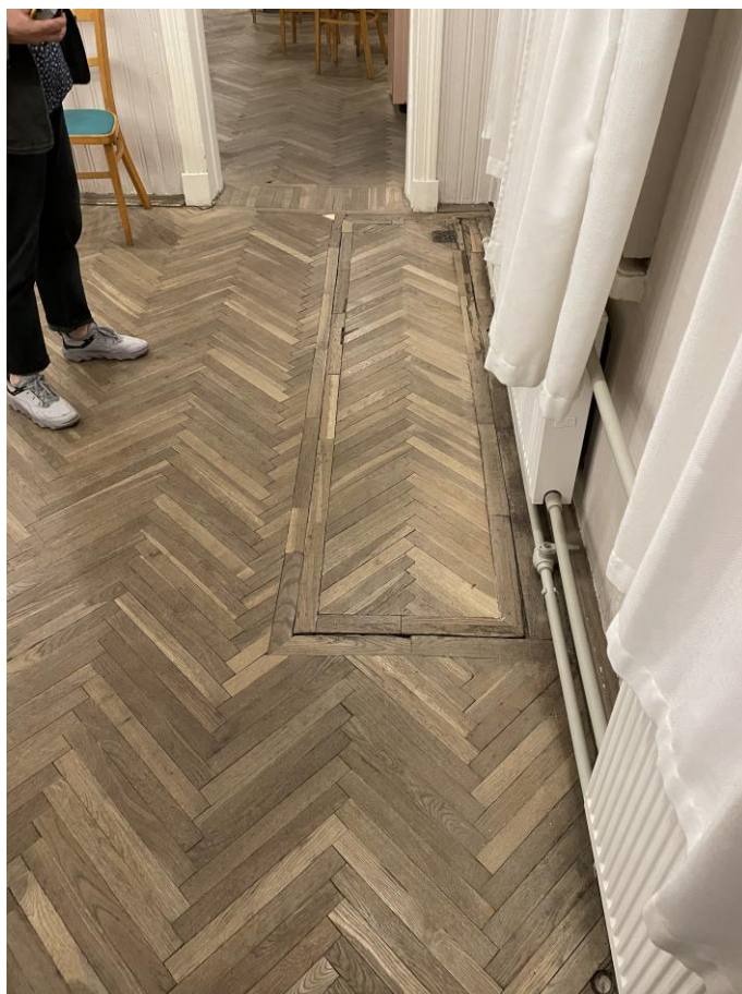
Фото №92. Люк в техподполье в помещении 1.13.
