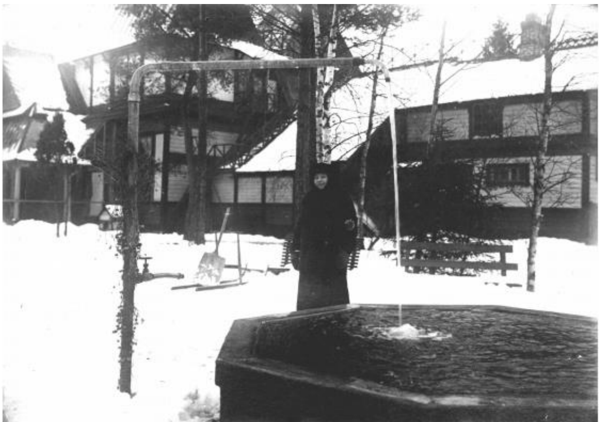
Илл. 24. Куоккала. Усадьба И.Е. Репина «Пенаты». Дом жилой. Фрагмент северного фасада. Фотография. 1910-е гг. (после 1914 г.). НИМ РАХ.
