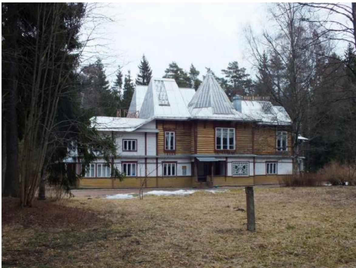
Илл. 59. Усадьба И.Е. Репина «Пенаты». Дом жилой. Главный (южный) фасад. Фотография. 2000-е гг. www.citywalls.ru .
