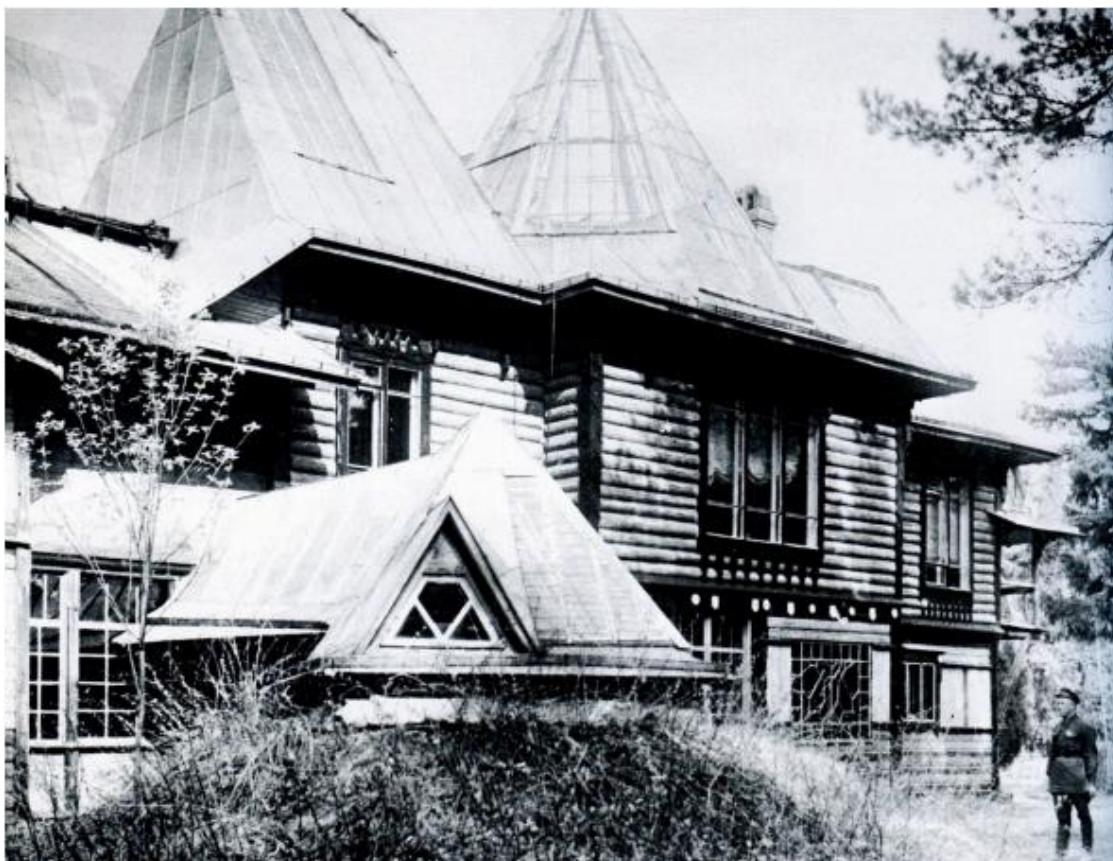
Илл. 39. Куоккала. Усадьба И.Е. Репина «Пенаты». Дом жилой. Вид на южный фасад. Фотография. 1940 г. https://terijoki.spb.ru .
