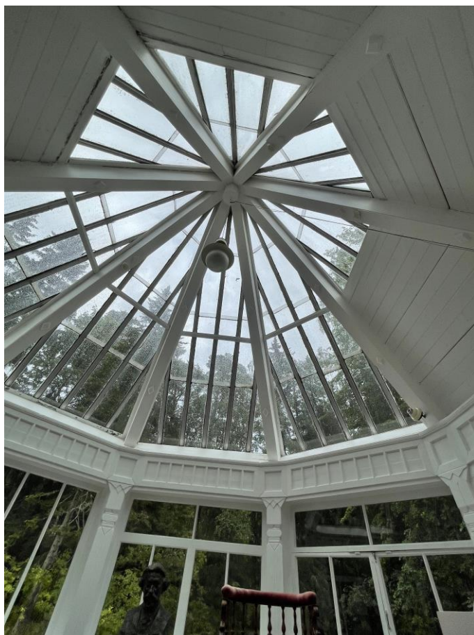
Фото №61. Стропильная система над помещением 1.15.
