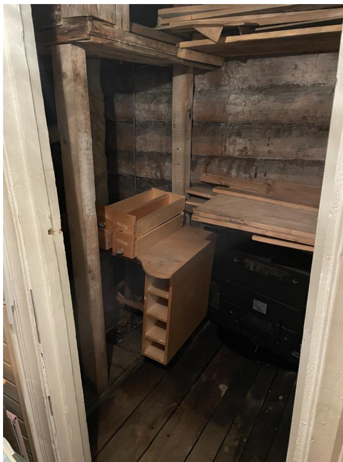
Фото №15. Кладовая в помещении 2.4 по плану ПИБ на 2 этаже.
