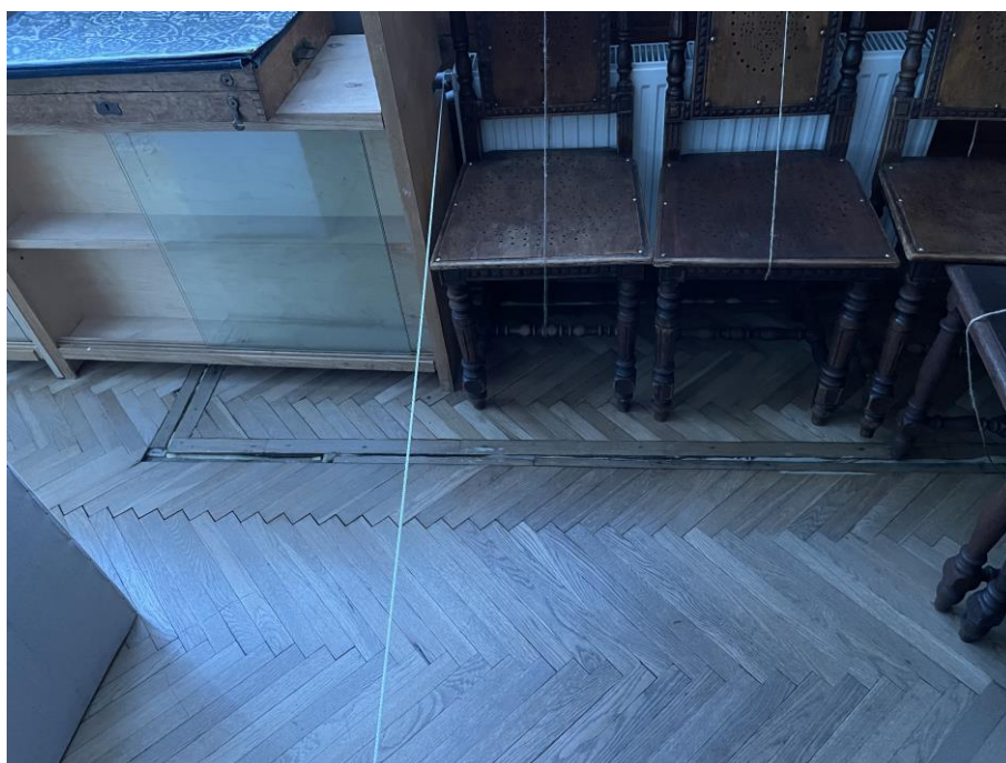
Фото №95. Люк в техподполье в помещении 1.24.
