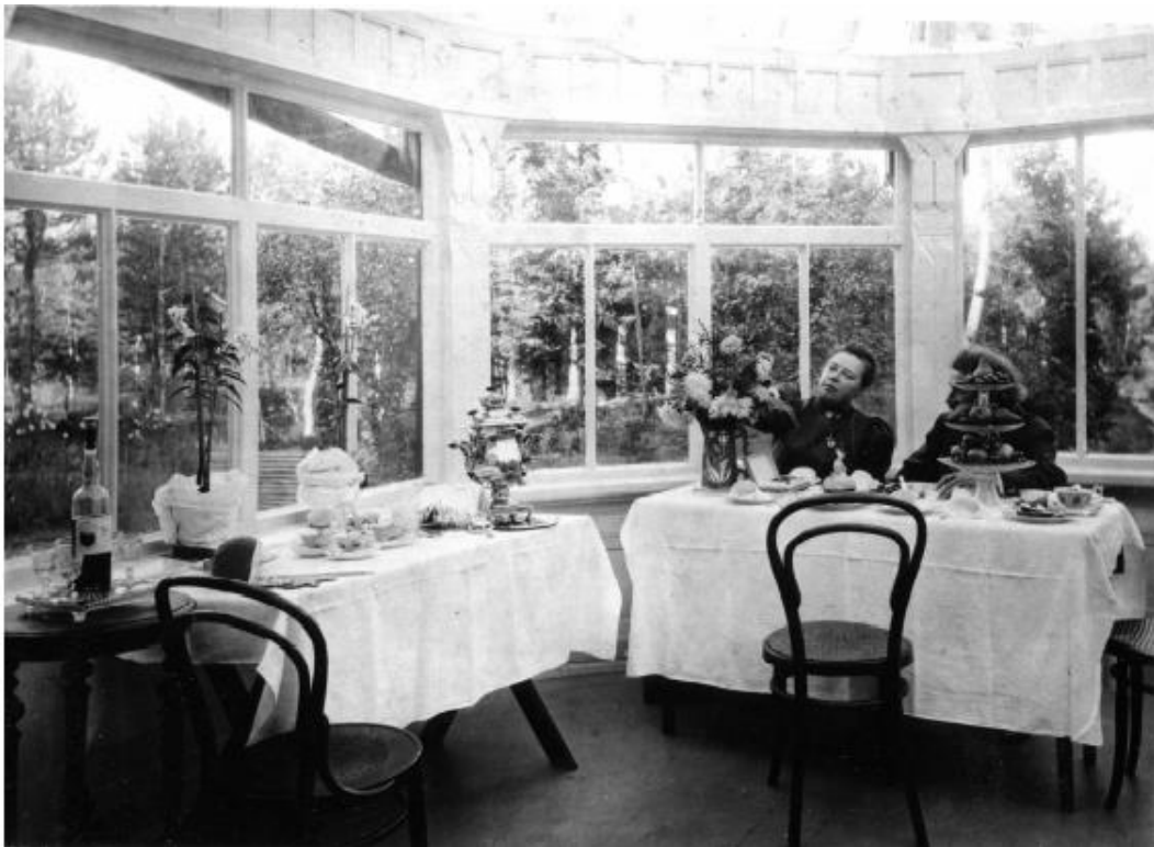
Илл. 67. Усадьба И.Е. Репина «Пенаты». Дом жилой. Зимняя веранда. 1910-е гг. (до 1914 г.). НИМ РАХ.
