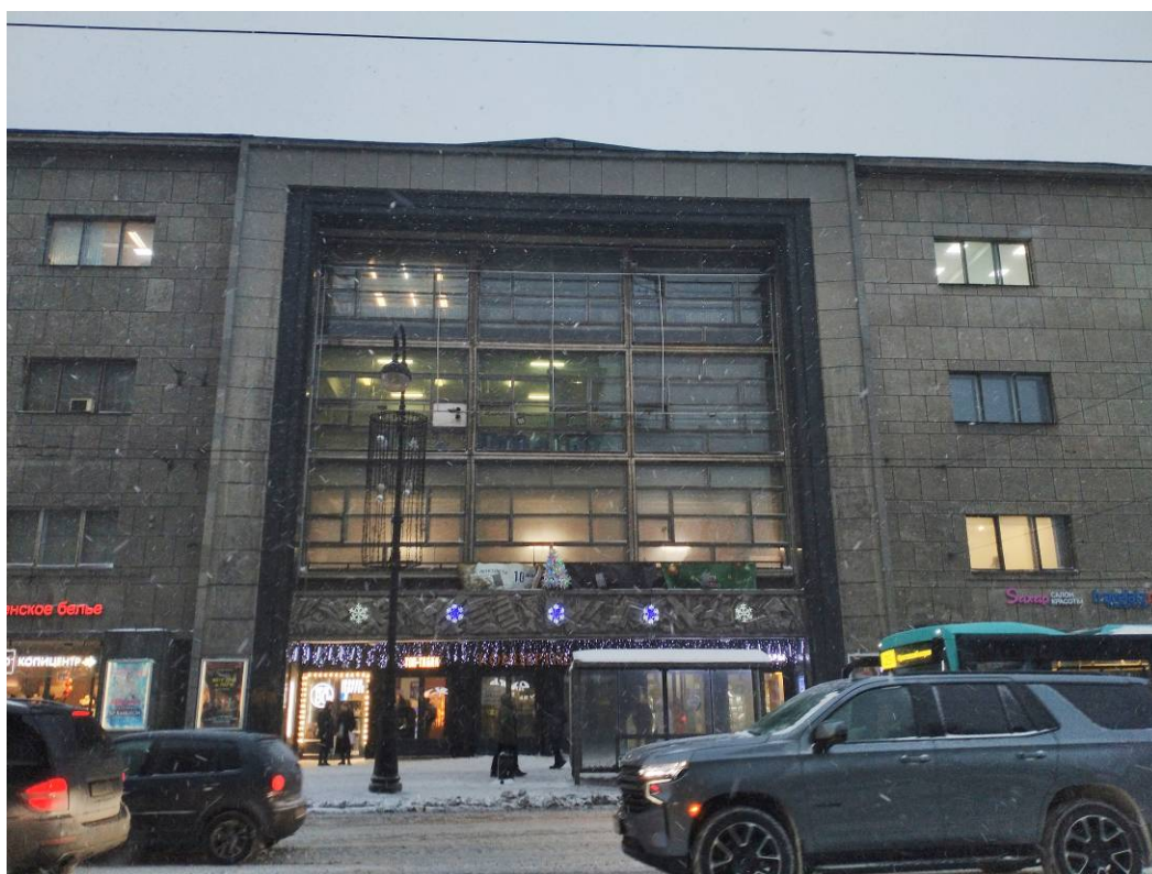
Фото 6. Фрагмент лицевого фасада объекта культурного наследия регионального значения «Дом культуры Промкооперации (быв. «Спортинг-Палас» А.И. Башкирова)» (Дворец культуры имени Ленсовета)
