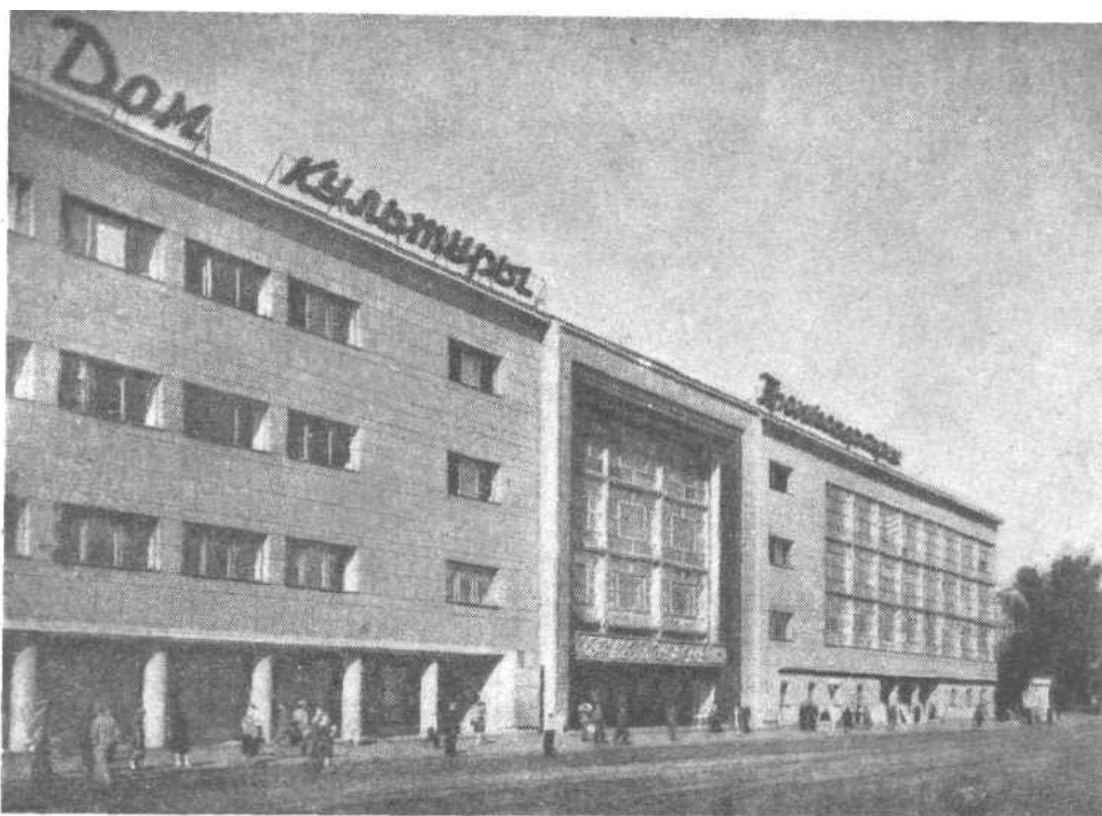
Дом культуры Промкооперации с залом на 2100 мест в Ленинграде. 1932—1935 гг. Арх. Е. А. Левинсон и В. О. Мунц. Общий вид
