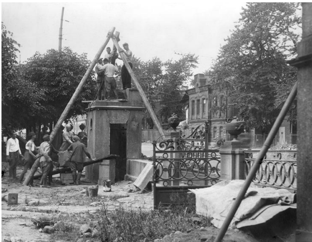
21. Восстановление ограды Таврического дворца, разрушенной фугасной бомбой. 1943 г., фотография А.К. Григорьева. КГИОП.
