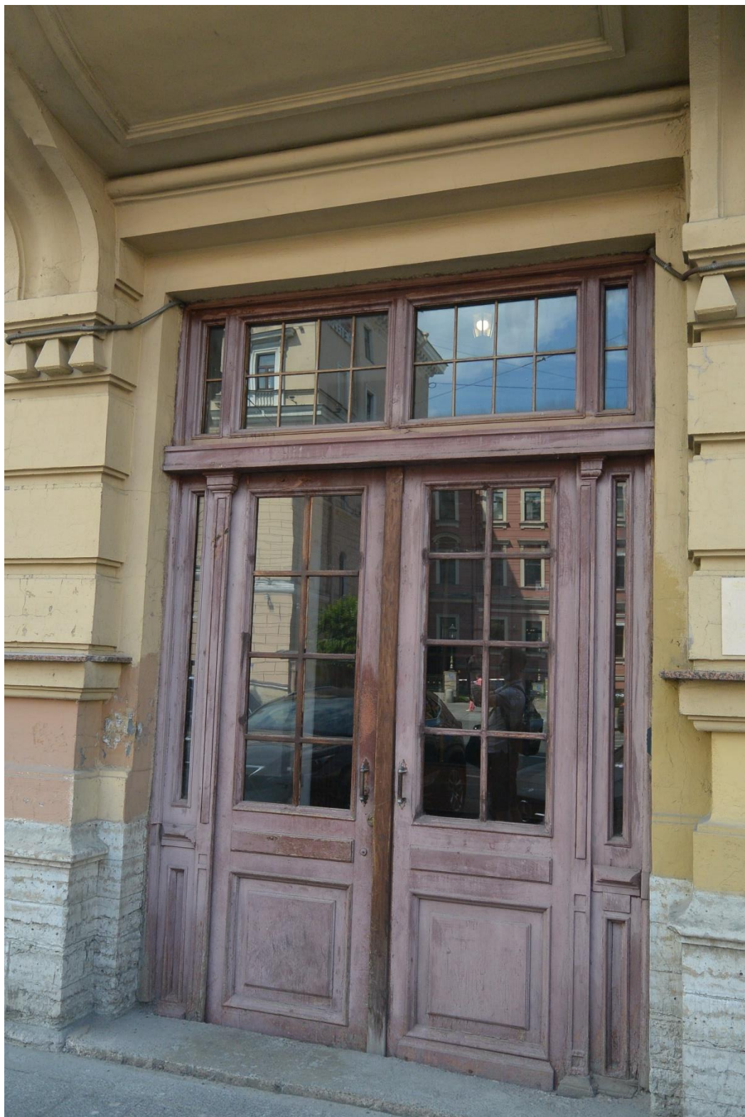
8. Вид дверного проема по 7-й световой оси лицевого фасада объекта культурного наследия регионального значения «Доходный дом Александрo-Невской Лавры», расположенного по адресу: г. Санкт-Петербург, Невский пр., д. 153, литера А.
