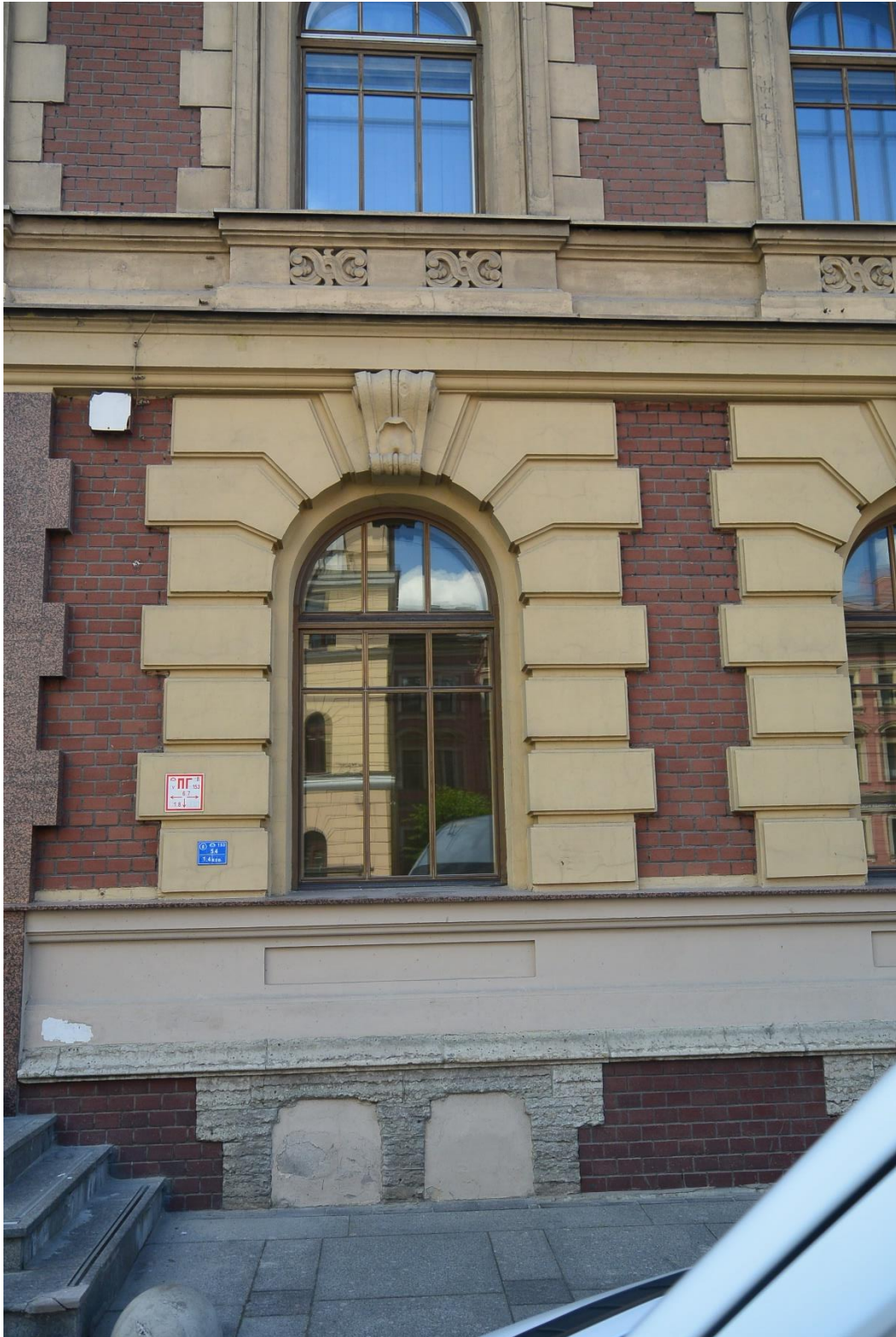
6. Вид оконного проема в уровне 1-го этажа, по 2-й световой оси лицевого фасада объекта культурного наследия регионального значения «Доходный дом Александрo-Невской Лавры», расположенного по адресу: г. Санкт-Петербург, Невский пр., д. 153, литера А.
