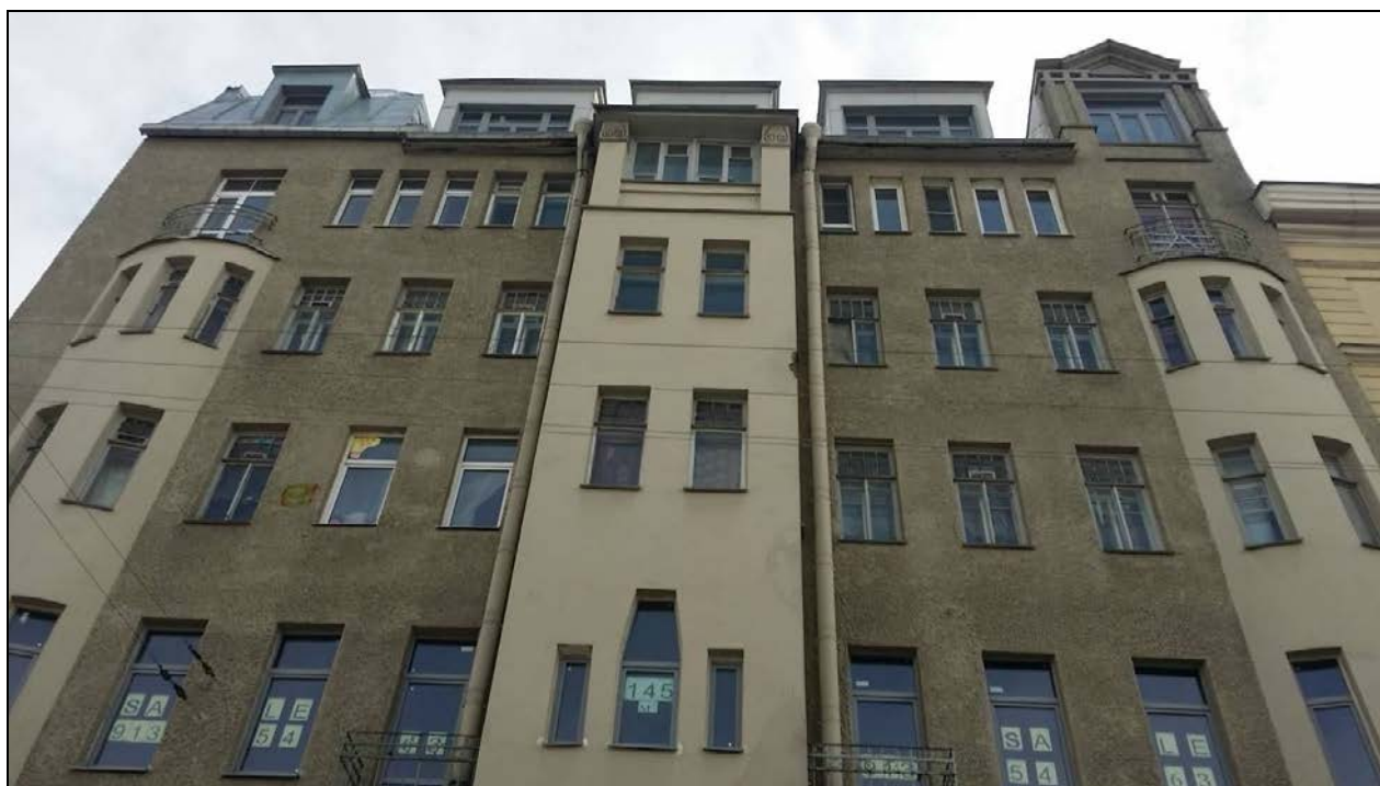
01.1. Объект культурного наследия регионального значения «Дом С.С. Трайнина». Фрагмент лицевого фасада. Окна квартиры № 15.
