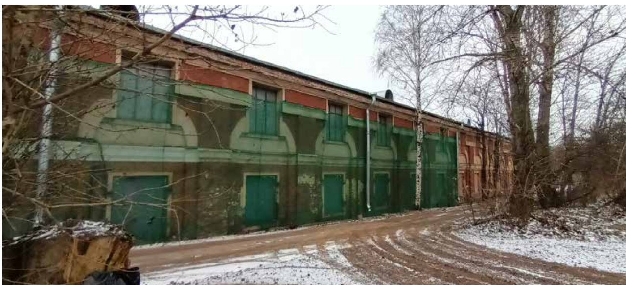
3б. Объект культурного наследия регионального значения «Хлебные амбары Александро-Невской лавры (5 корпусов)». Корпус по адресу: г. СПб, набережная Обводного канала, дом 3, литера А.Общий вид на продольный юго-восточный фасад (с юго-восточной стороны). 21 декабря 2022 г.
