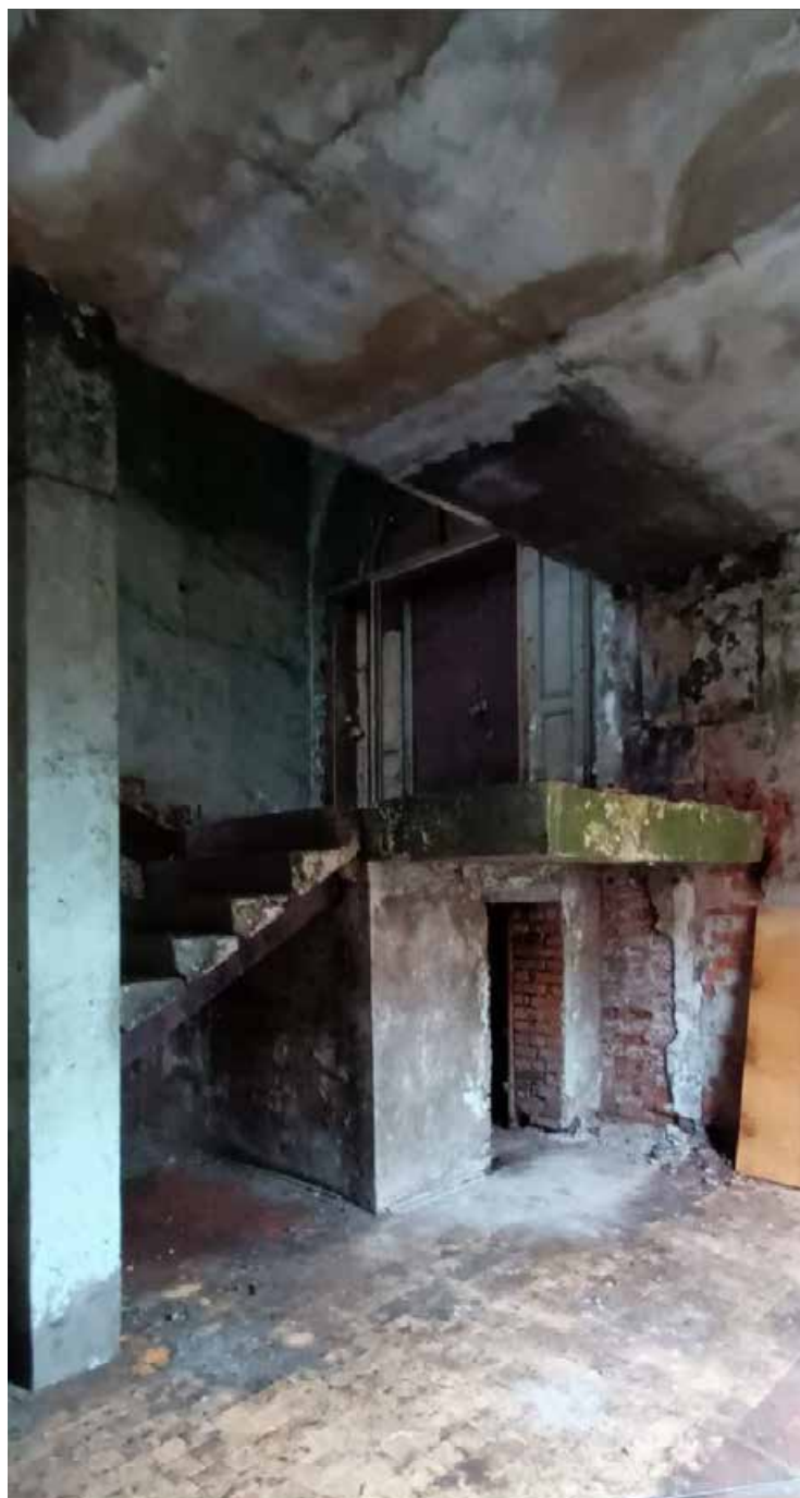
29. Объект культурного наследия регионального значения «Хлебные амбары Александро-Невской лавры (5 корпусов)». Корпус по адресу: г. СПб, набережная Обводного канала, дом 3, литера А. Интерьер. Лестничный марш у южной торцевой стены. 21 декабря 2022 г.
