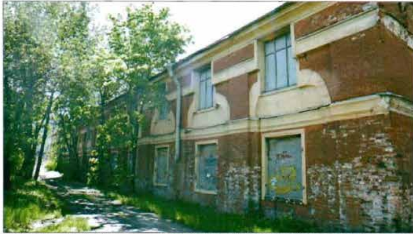
3. «Хлебный амбар» (наб. Обводного кан., 3, лит. А). Восточный фасад. Вид с северо-востока.
