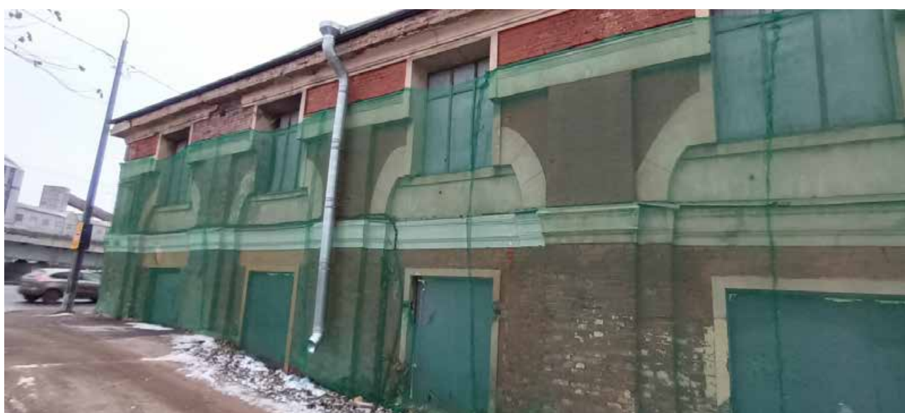
13. Объект культурного наследия регионального значения «Хлебные амбары Александро-Невской лавры (5 корпусов)». Корпус по адресу: г. СПб, набережная Обводного канала, дом 3, литера А. Фрагмент продольного юго-восточного фасада. 21 декабря 2022 г.
