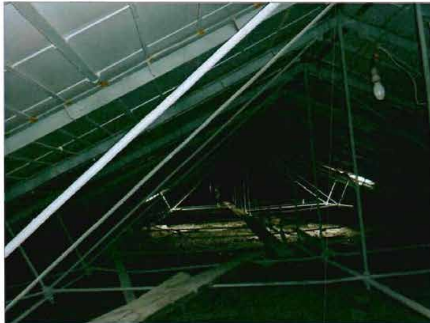
19. «Хлебный амбар» (наб. Обводного кан., 5, лит. Б). Чердак. Металлические фермы перекрытия.
