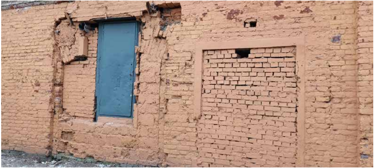
17. Объект культурного наследия регионального значения «Хлебные амбары Александро-Невской лавры (5 корпусов)». Корпус по адресу: г. СПб, набережная Обводного канала, дом 3, литера А. Фрагмент торцевого северо-восточного фасада. Входной проем. 21 декабря 2022 г.
