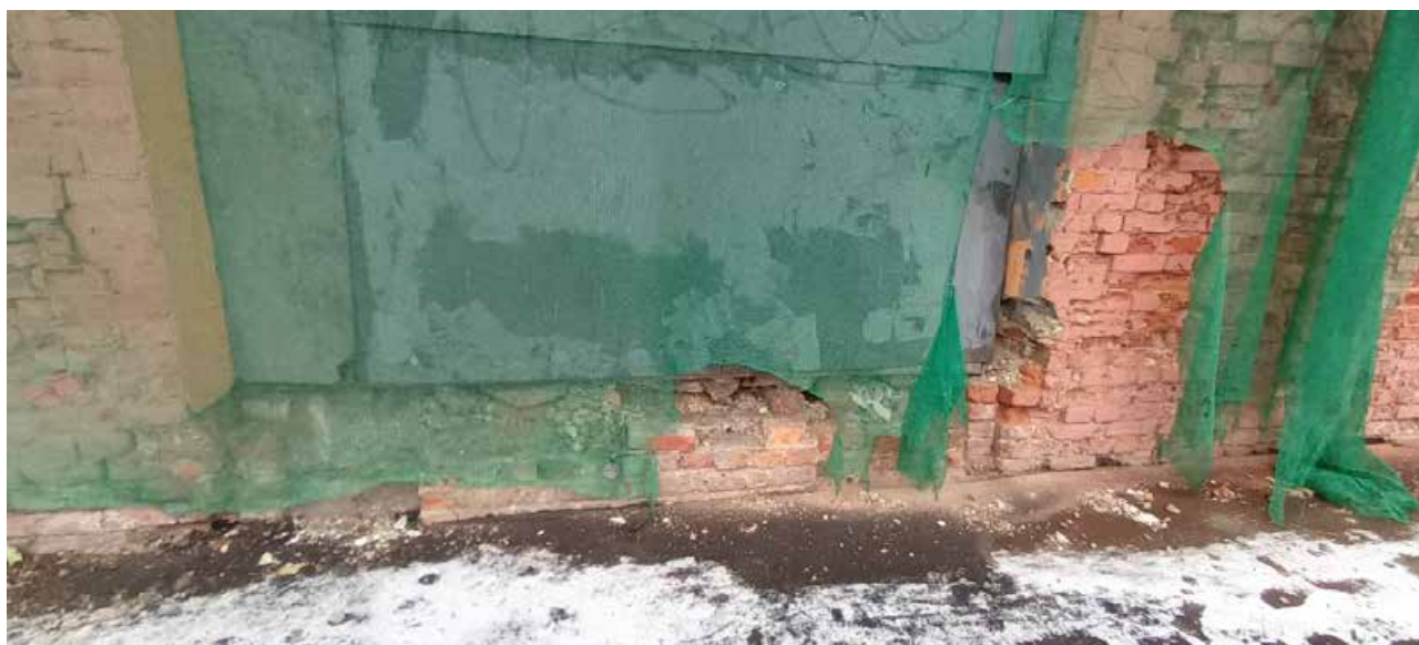
12. Объект культурного наследия регионального значения «Хлебные амбары Александро-Невской лавры (5 корпусов)». Корпус по адресу: г. СПб, набережная Обводного канала, дом 3, литера А. Фрагмент торцевого юго-западного фасада. Входной проем. 21 декабря 2022 г.
