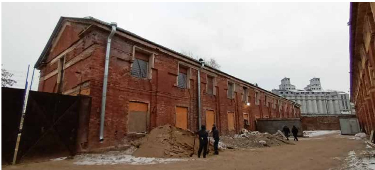
8. Объект культурного наследия регионального значения «Хлебные амбары Александровской лавры (5 корпусов)». Корпус по адресу: г. СПб, набережная Обводного канала, дом 3, литера А. Общий вид на торцевой северо-восточный фасад и продольный северо-западный фасад. (Вид с севера). 21 декабря 2022 г.
