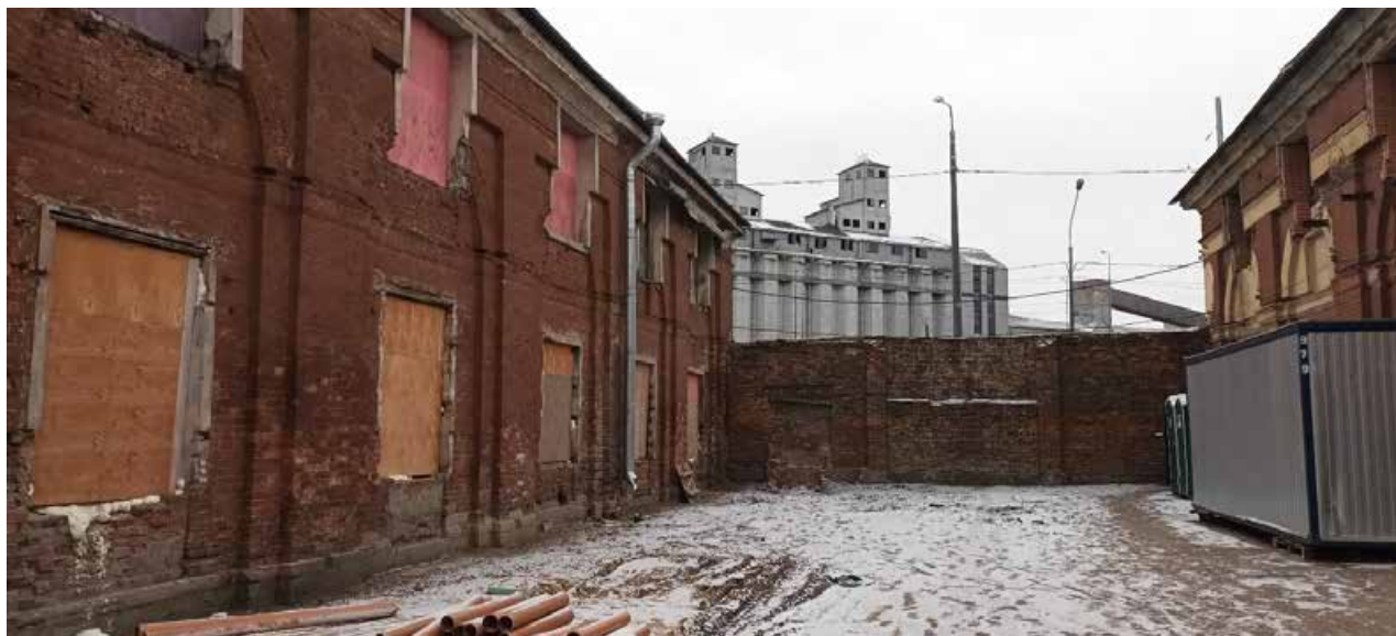
19. Объект культурного наследия регионального значения «Хлебные амбары Александро-Невской лавры (5 корпусов)». Корпус по адресу: г. СПб, набережная Обводного канала, дом 3, литера А. Фрагмент продольного северо-западного фасада. 21 декабря 2022 г.
