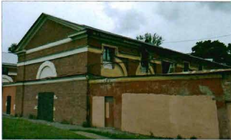
10. «Хлебный амбар» (наб. Обводного кан., 5, лит. Б). Общий вид с юго-востока.
