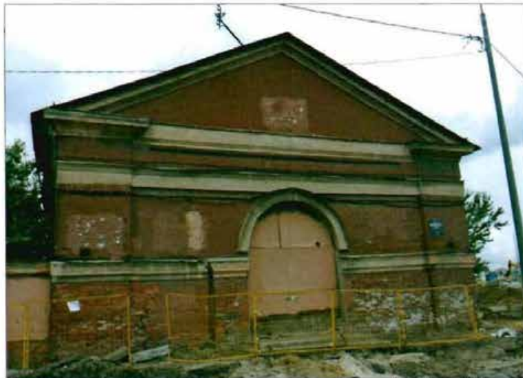
2. «Хлебный амбар» (наб. Обводного кан., 3, лит. А). Южный фасад.
