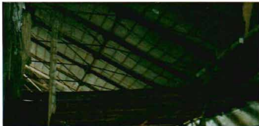
5. «Хлебный амбар» (наб. Обводного кан., 3, лит. А). Металлические фермы перекрытия.
