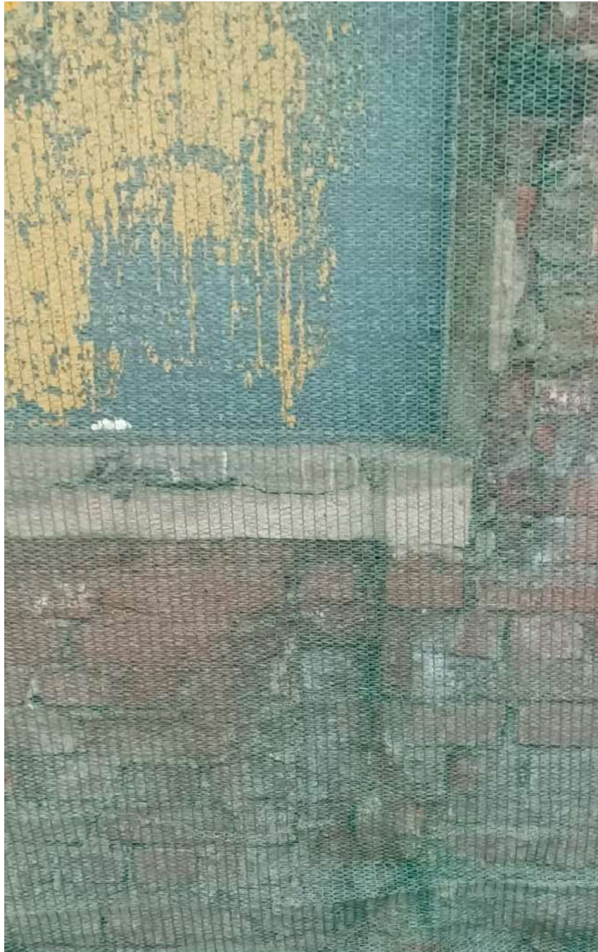
15. Объект культурного наследия регионального значения «Хлебные амбары Александро-Невской лавры (5 корпусов)». Корпус по адресу: г. СПб, набережная Обводного канала, дом 3, литера А. Фрагмент продольного юго-восточного фасада. 21 декабря 2022 г.
