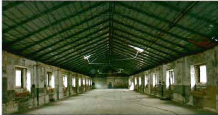
9. «Хлебный амбар» (наб. Обводного кан., 5, лит. А). Металлические фермы перекрытия.
