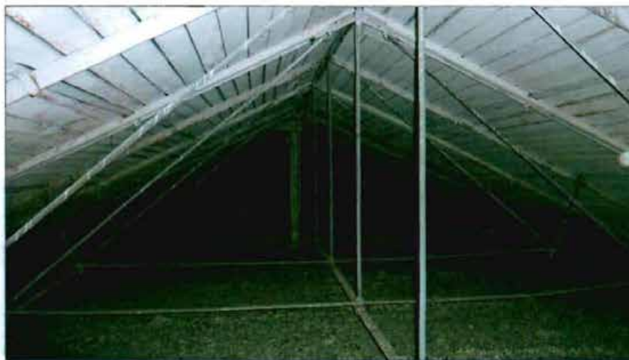
23. «Хлебный амбар» (наб. Обводного кан., 5а, лит. А). Чердак. Металлические фермы перекрытия.
