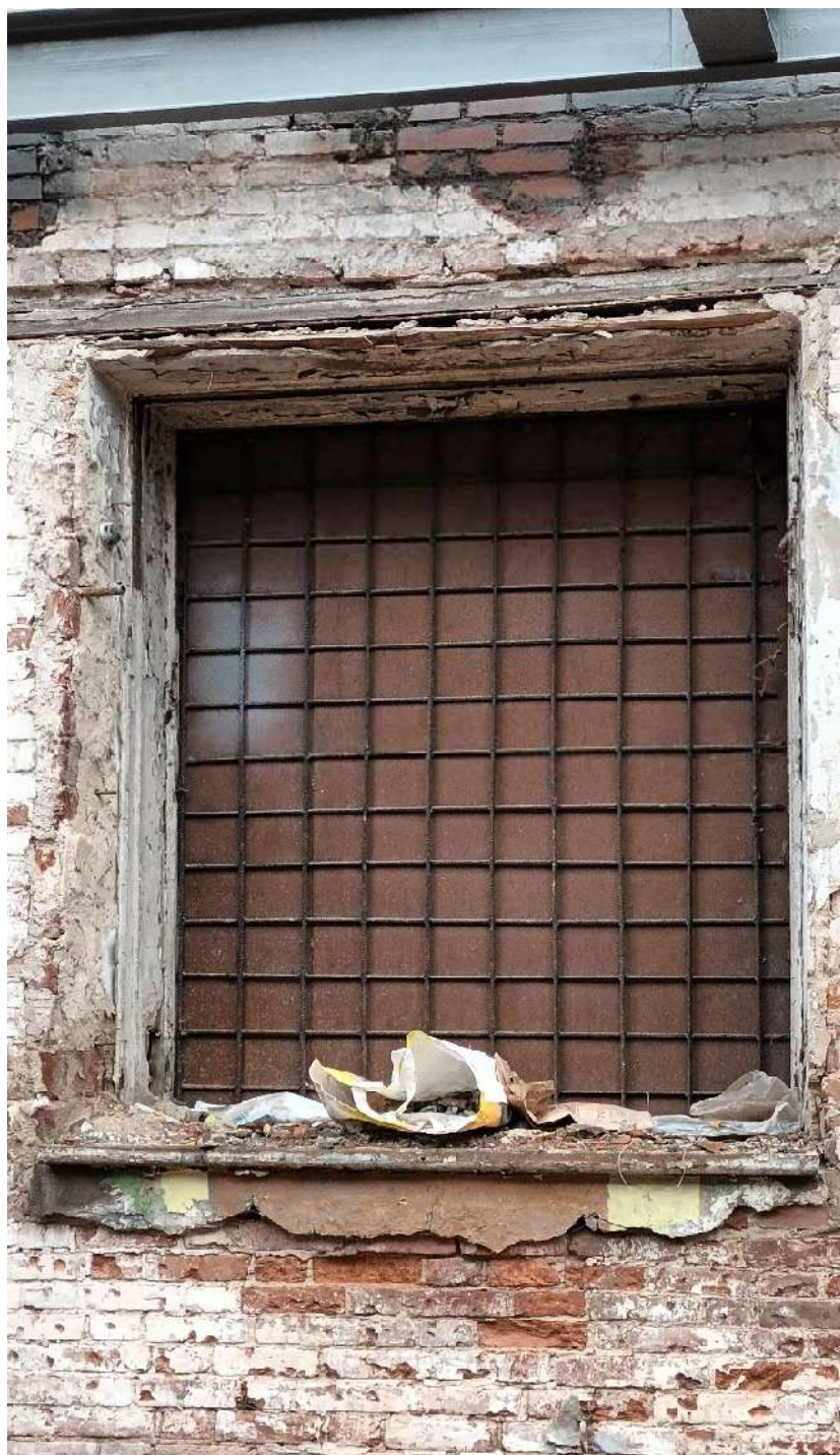
28. Объект культурного наследия регионального значения «Хлебные амбары Александроневской лавры (5 корпусов)». Корпус по адресу: г. СПб, набережная Обводного канала, дом 3, литера А. Интерьер. Фрагмент восточной стены. Оконный проем 1 этажа. 21 декабря 2022 г.
