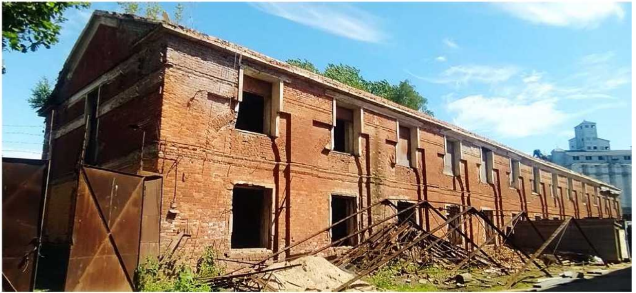
Илл. 19. Современное состояние объекта культурного наследия регионального значения «Хлебные амбары Александро-Невской лавры», расположенного по адресу: СПб, наб. Обводного канала, дом 3, лит. А. Фото июнь 2022 г. Выполнение противоаварийных работ. Из собрания Лавриновского М.С.
