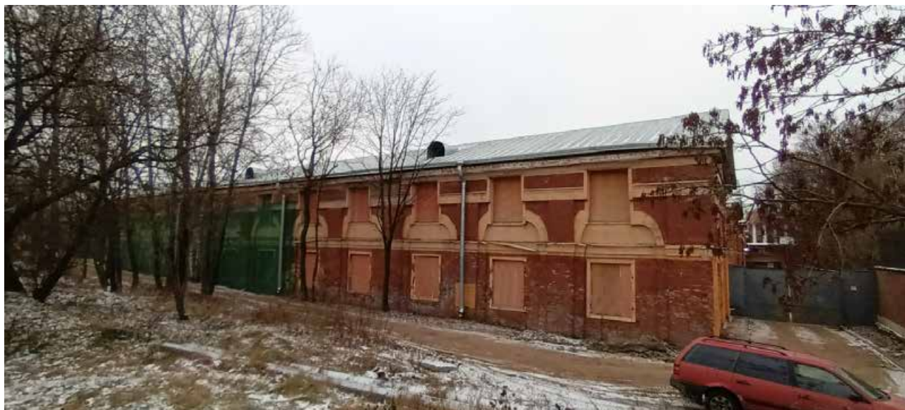
4. Объект культурного наследия регионального значения «Хлебные амбары Александро-Невской лавры (5 корпусов)». Корпус по адресу: г. СПб, набережная Обводного канала, дом 3, литера А. Общий вид на продольный юго-восточный фасад. Северное окончание фасада. 21 декабря 2022 г.
