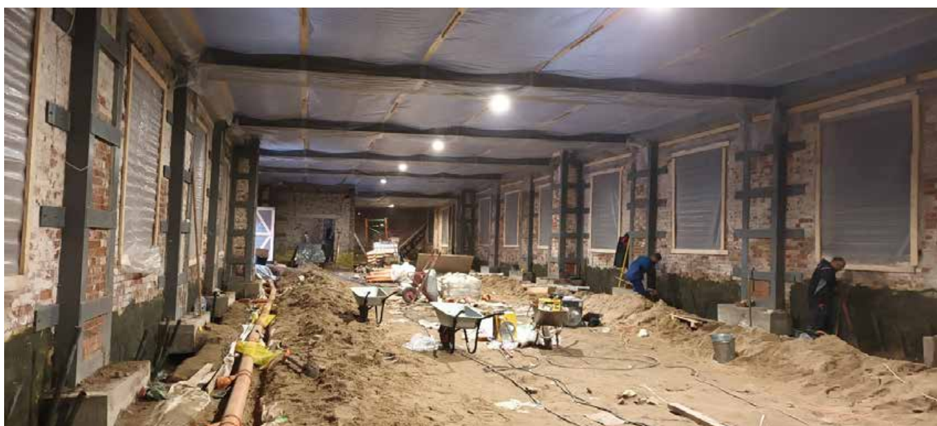
24. Объект культурного наследия регионального значения «Хлебные амбары Александро-Невской лавры (5 корпусов)». Корпус по адресу: г. СПб, набережная Обводного канала, дом 3, литера А. Интерьер. Общий вид. Северное направление. 21 декабря 2022 г.
