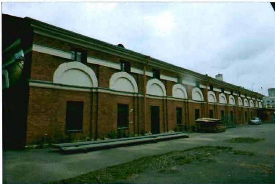
13. «Хлебный амбар» (наб. Обводного кан., 5, лит. Б). Западный фасад. Вид с северо-запада.
