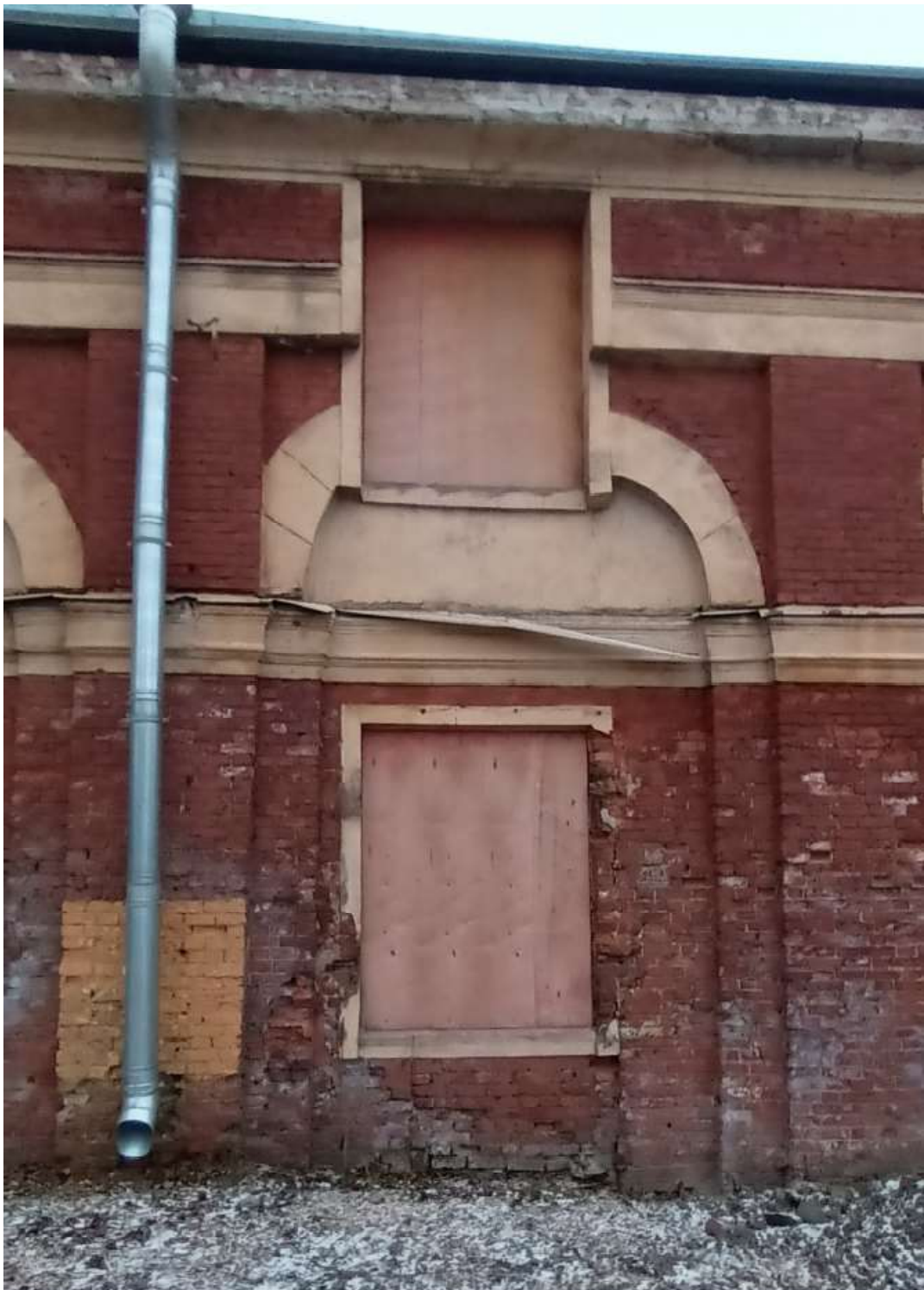
14. Объект культурного наследия регионального значения «Хлебные амбары Александроневской лавры (5 корпусов)». Корпус по адресу: г. СПб, набережная Обводного канала, дом 3, литера А. Фрагмент продольного юго-восточного фасада. 21 декабря 2022 г.
