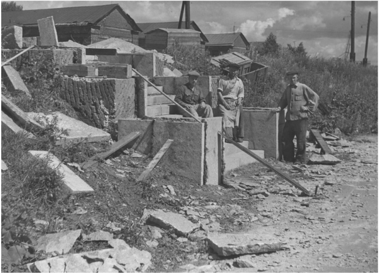
Илл. 17. Строительство спуска на набережной Обводного канала. На заднем фоне - существующие ныне амбары. 1955 г. URL: https://pastvu.com/p/136349 .
