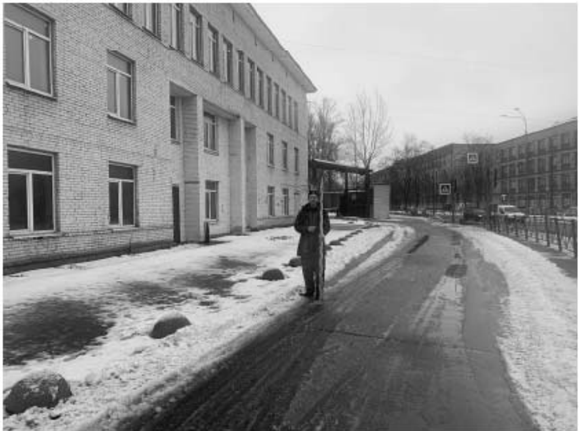
Рис. 29. СПб, Обуховской обороны пр., 51-2022. Точка фотофиксации 7, вид на северо-восток.
