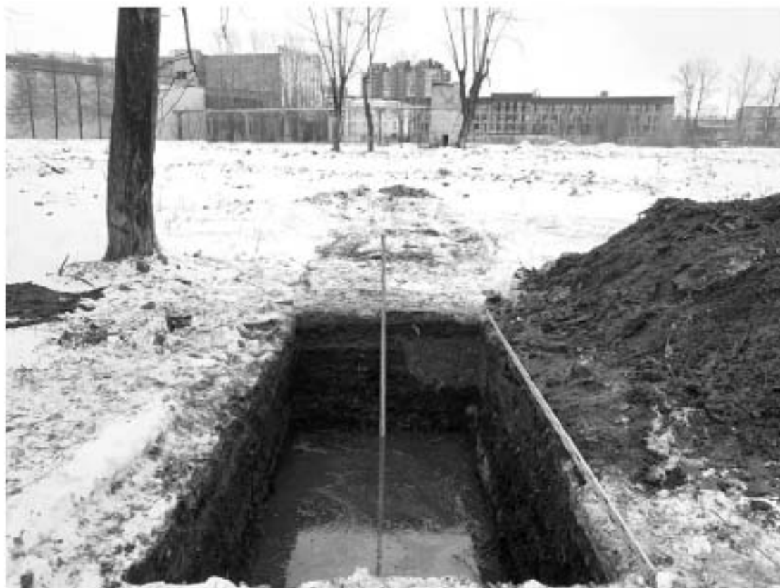
Рис. 99. СПб, Обуховской обороны пр., 51-2022. Шурф 5-6, фиксация по уровню окончания работ, восточная стенка.
