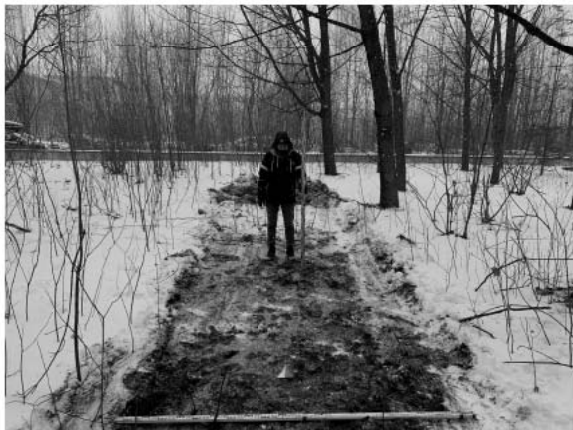
Рис. 83. СПб, Обуховской обороны пр., 51-2022. Местоположение шурфа 3-4, вид на север.
