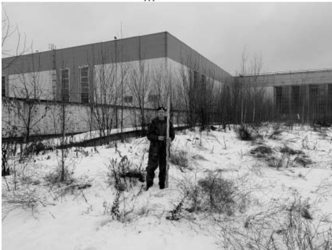
Рис. 42. СПб, Обуховской обороны пр., 51-2022. Точка фотофиксации 13, вид на северо-запад.
