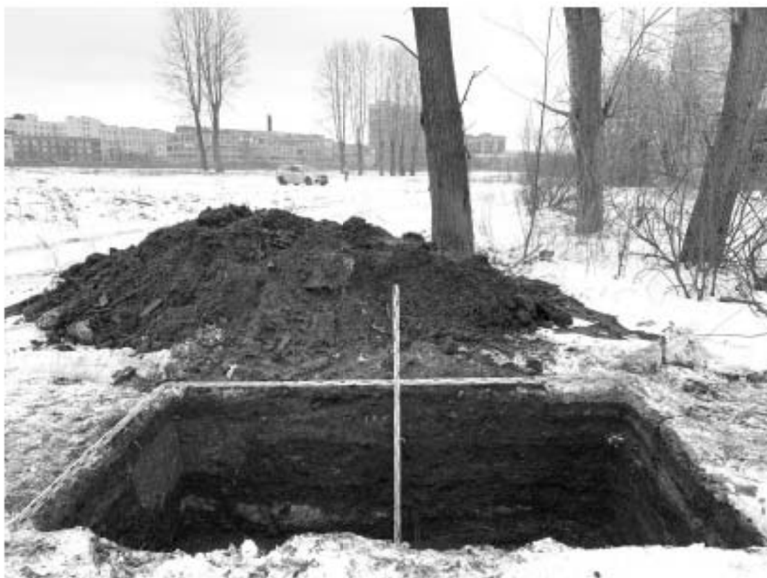
Рис. 97. СПб, Обуховской обороны пр., 51-2022. Шурф 5-6, фиксация по уровню окончания работ, южная стенка.
