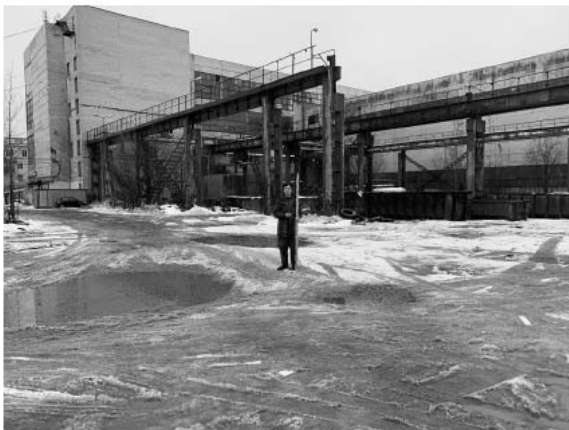
Рис. 71. СПб, Обуховской обороны пр., 51-2022. Точка фотофиксации 24, вид на северо-запад.
