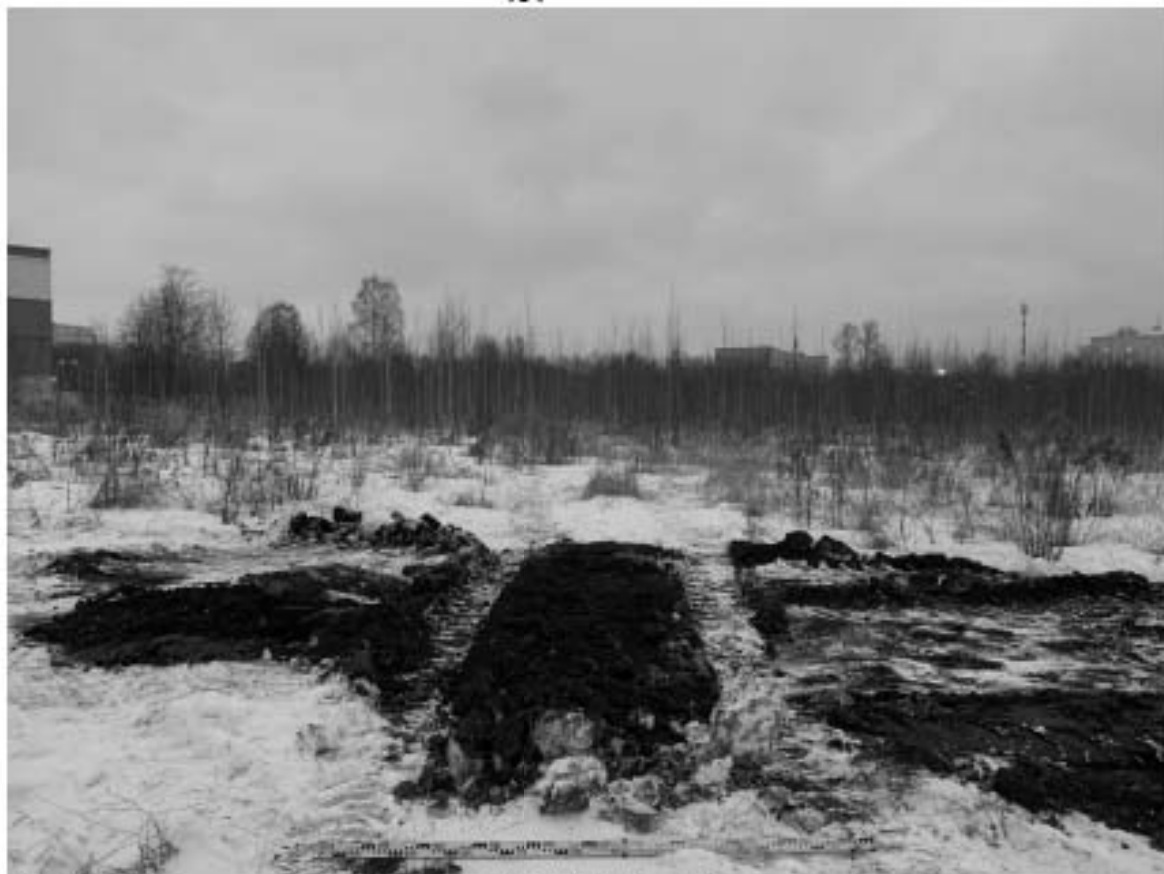
Рис. 82. СПб, Обуховской обороны пр., 51-2022. Шурф 1-2 после рекультивации, вид на север.
