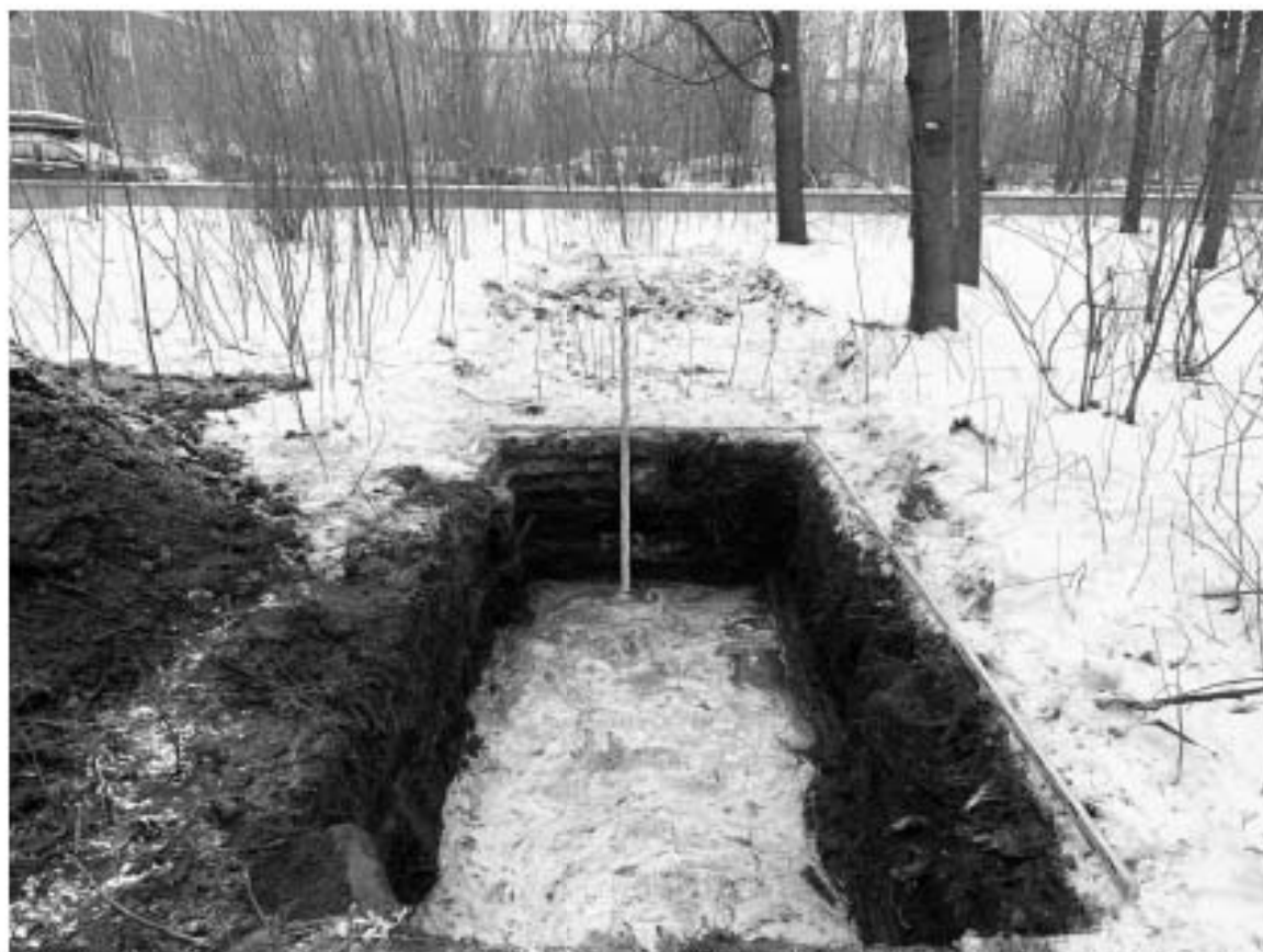
Рис. 89. СПб, Обуховской обороны пр., 51-2022. Шурф 3-4, фиксация по уровню окончания работ, северная стенка.
