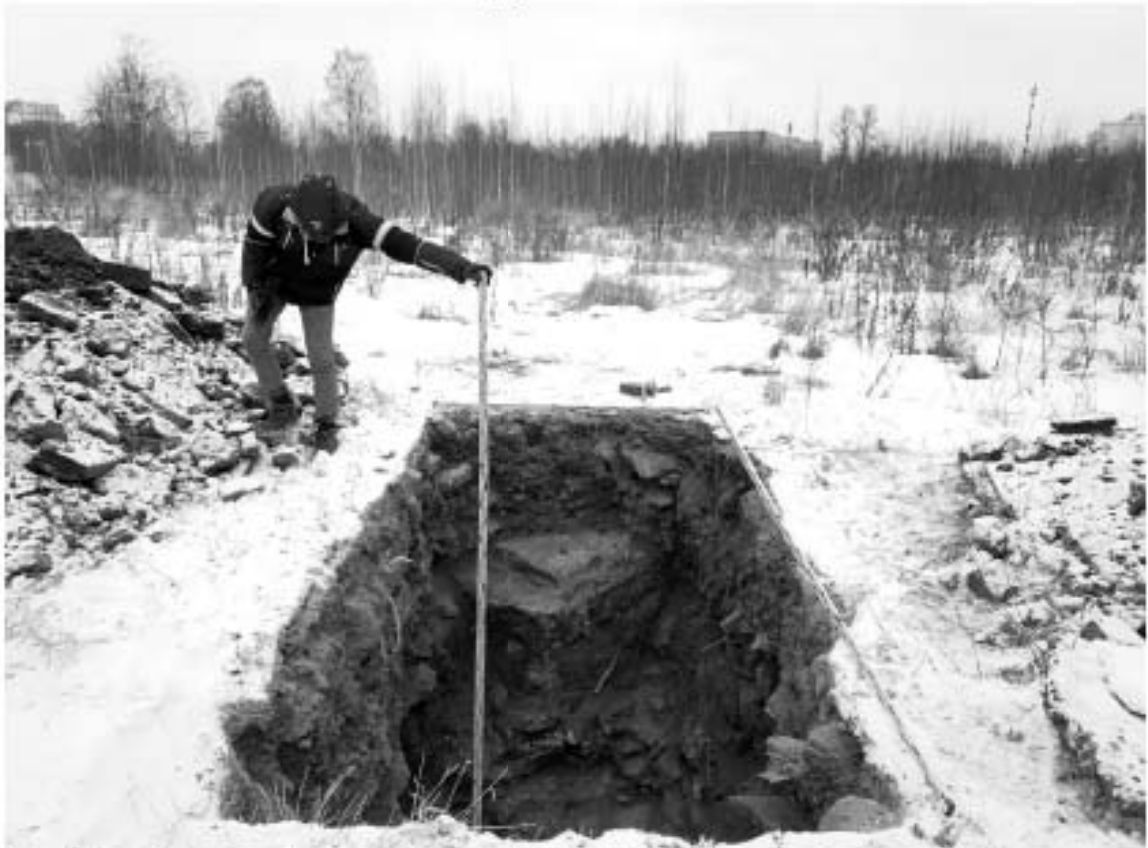
Рис. 80. СПб, Обуховской обороны пр., 51-2022. Шурф 1-2, фиксация по уровню окончания работ, северная стенка.
