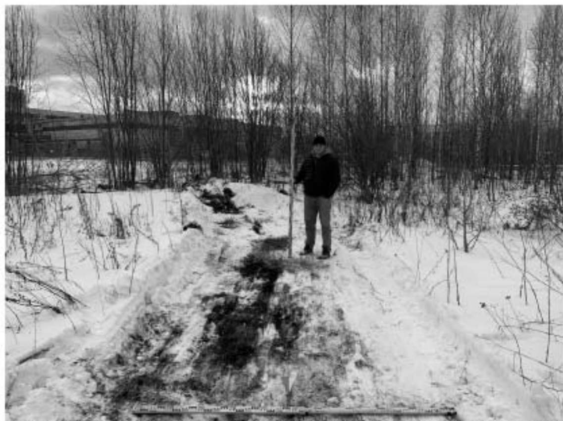
Рис. 117. СПб, Обуховской обороны пр., 51-2022. Местоположение шурфа 8-9, вид на юг.
