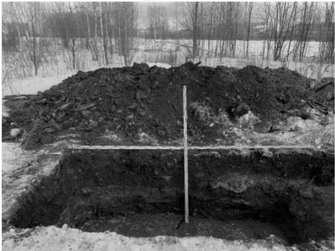
Рис. 122. СПб, Обуховской обороны пр., 51-2022. Шурф 8-9, фиксация по уровню окончания работ, восточная стенка.
