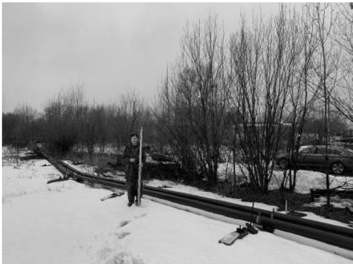
Рис. 53. СПб, Обуховской обороны пр., 51-2022. Точка фотофиксации 18, вид на север.
