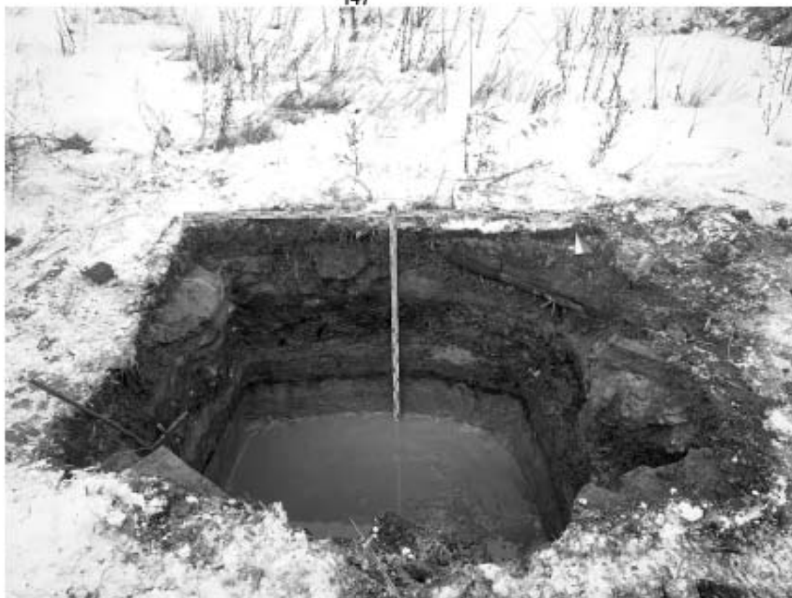
Рис. 114. СПб, Обуховской обороны пр., 51-2022. Шурф 7, фиксация по уровню окончания работ, северная стенка.
