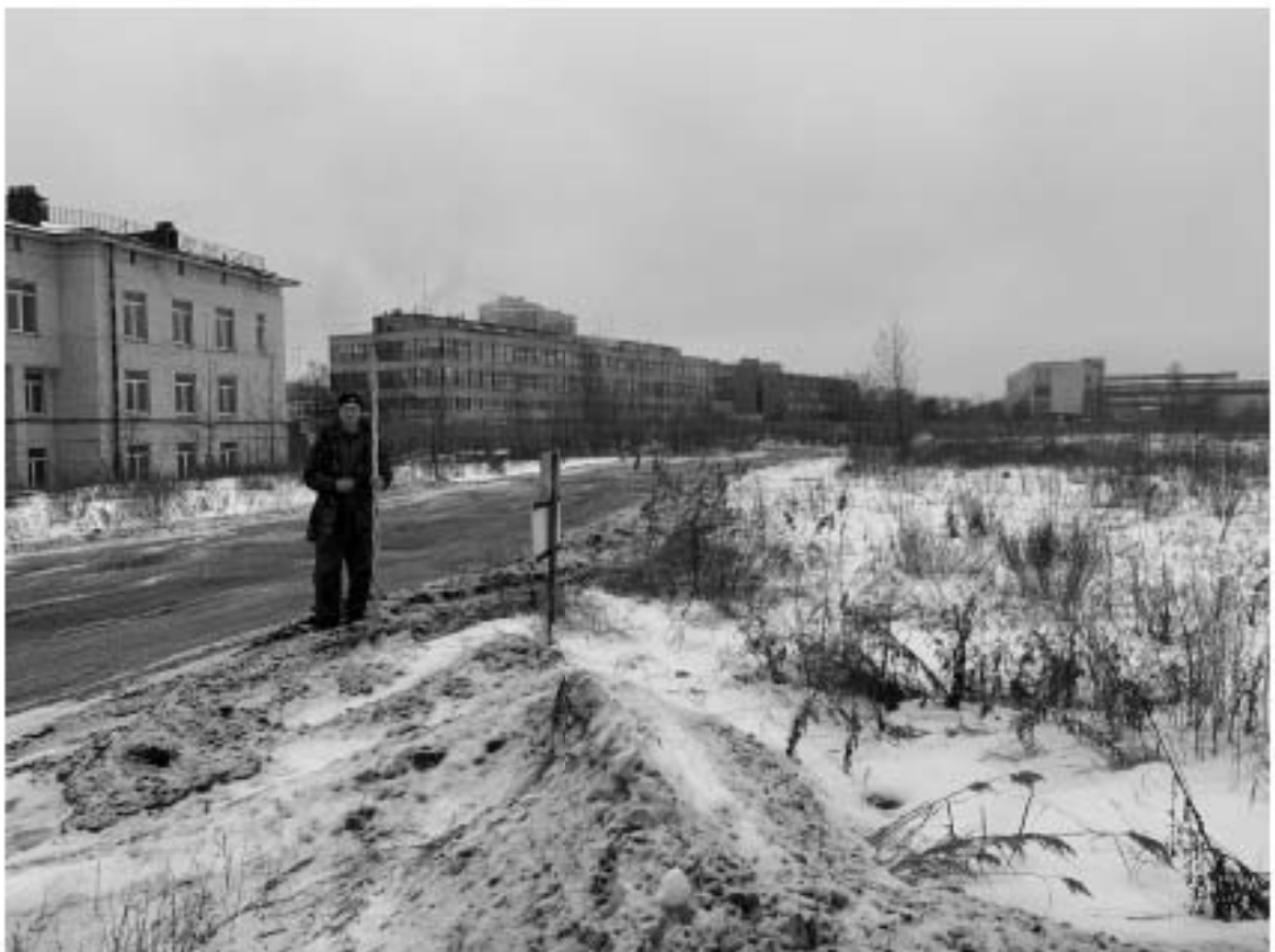
Рис. 69. СПб, Обуховской обороны пр., 51-2022. Точка фотофиксации 23, вид на запад.
