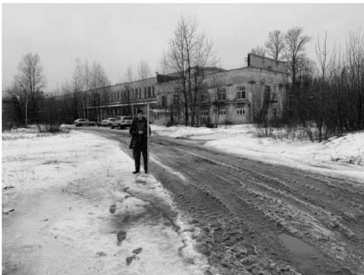
Рис. 73. СПб, Обуховской обороны пр., 51-2022. Точка фотофиксации 25, вид на запад.
