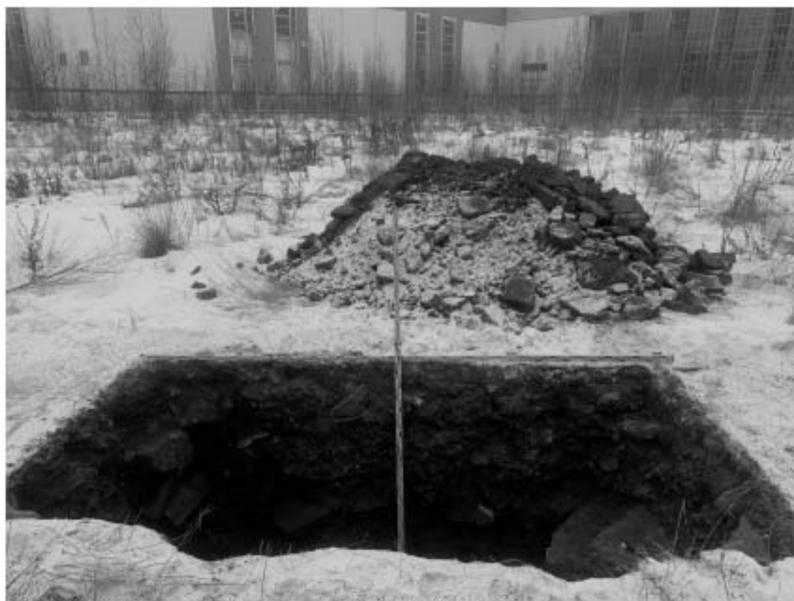
Рис. 75. СПб, Обуховской обороны пр., 51-2022. Шурф 1-2, фиксация по уровню окончания работ, западная стенка.
