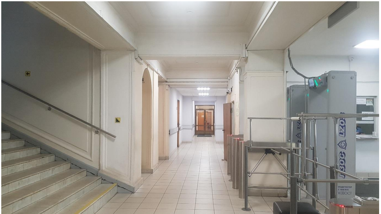
Фото 9. Коридор. Вид на правое крыло.
