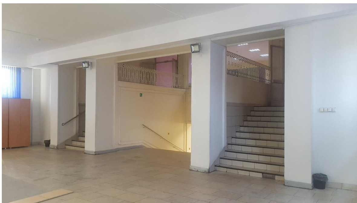
Фото 12. Помещение № 168 второго этажа. Вид на лестницу на третий этаж.
