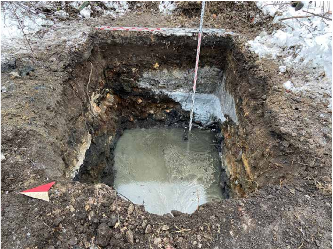
Рис. 38. Санкт-Петербург, Кировский район, ул. Калинина Общий вид шурфа №1 на этапе прекращения работ. Вид на восток.
