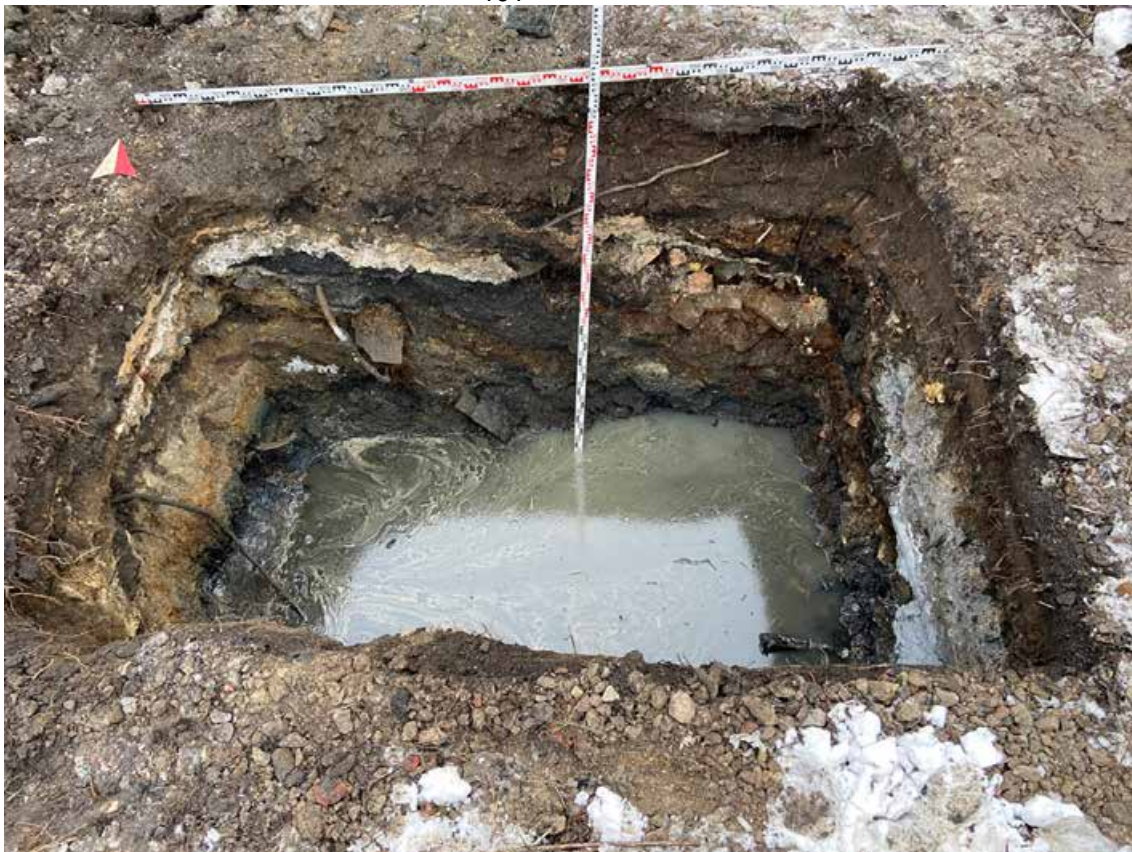
Рис. 36. Санкт-Петербург, Кировский район, ул. Калинина. Общий вид шурфа №1 на этапе прекращения работ. Вид на север.
