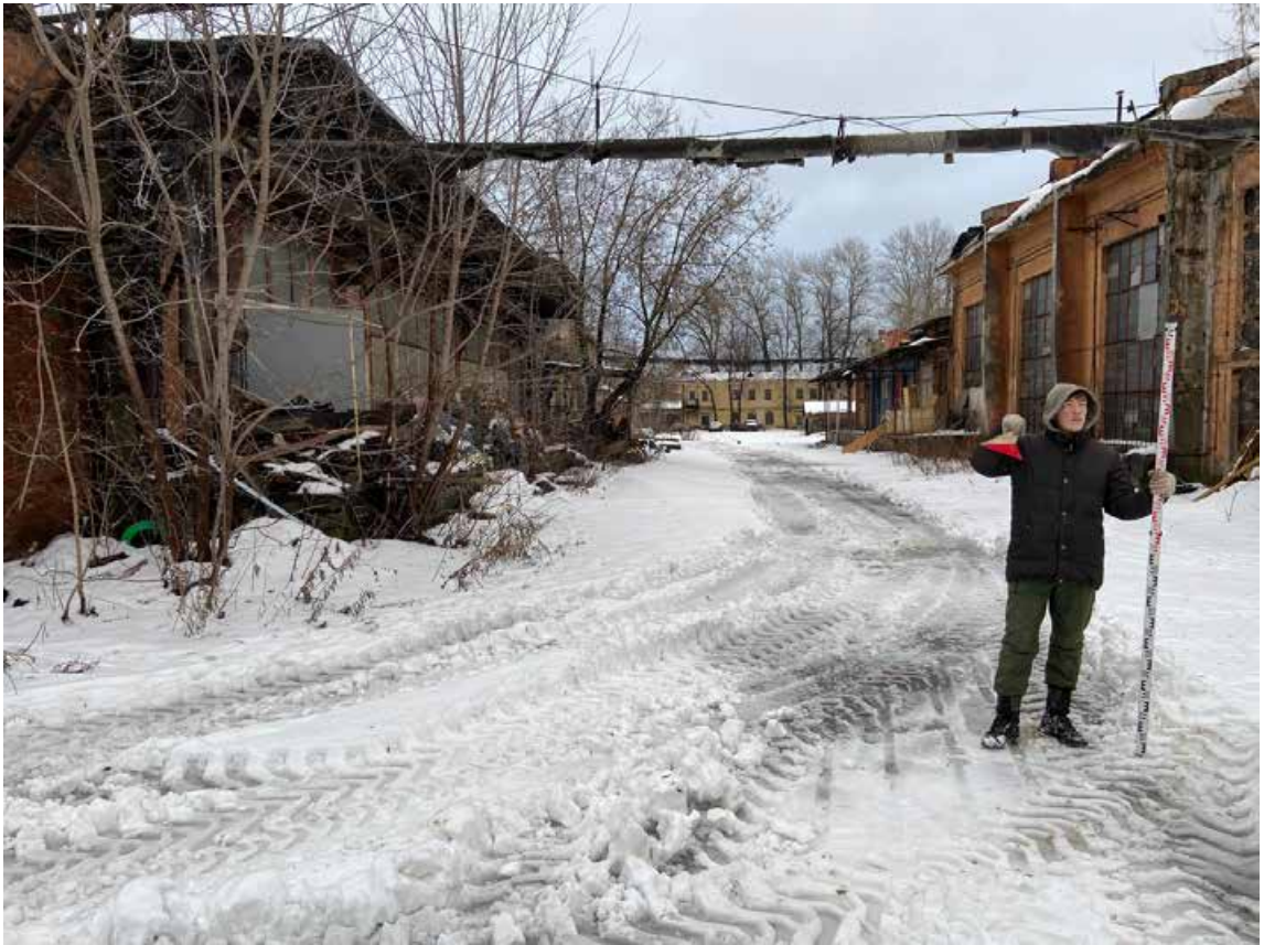
Рис. 28. Санкт-Петербург, Кировский район, ул. Калинина. Точка съемки №4. Вид на восток.
