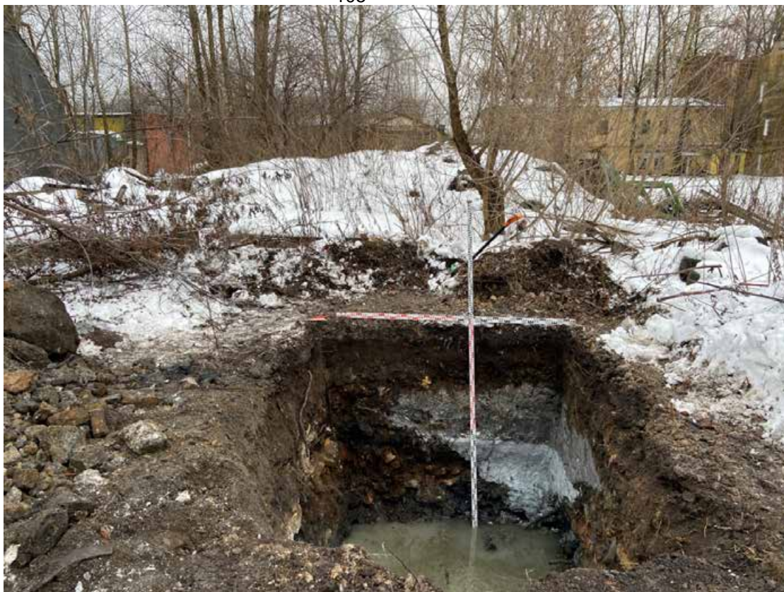
Рис. 44. Санкт-Петербург, Кировский район, ул. Калинина. Шурф №1. Местоположение шурфа №1. Вид на восток.
