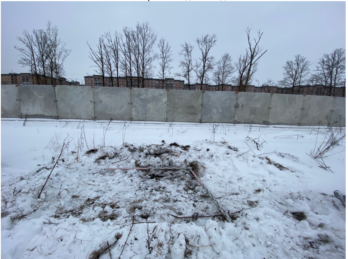
Рис. 31 Санкт-Петербург, Пушкинский район. Шурф №2. Общий вид дневной поверхности до начала работ. Вид на запад.
