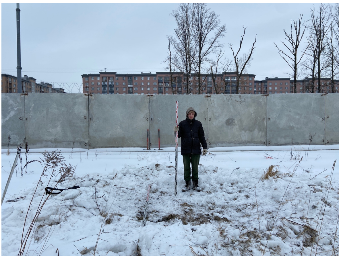
Рис. 21 Санкт-Петербург, Пушкинский район. Шурф №1. Общий вид местоположения до начала работ. Вид на запад.
