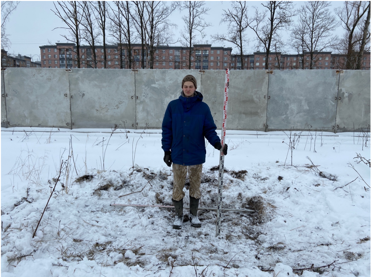
Рис. 30 Санкт-Петербург, Пушкинский район. Шурф №2. Общий вид местоположения до начала работ. Вид на запад.
