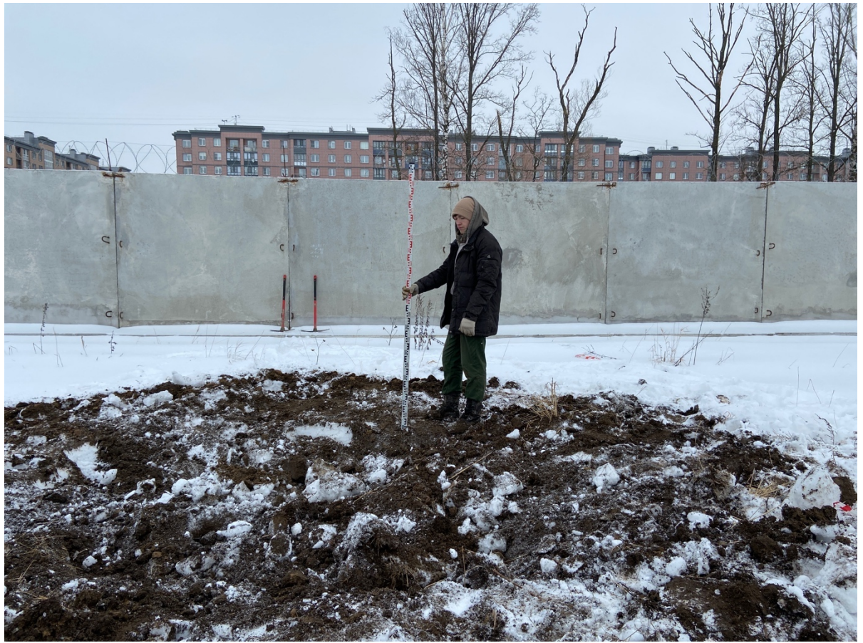
Рис. 29 Санкт-Петербург, Пушкинский район. Шурф №1. Общий вид после рекультивации. Вид на запад.
