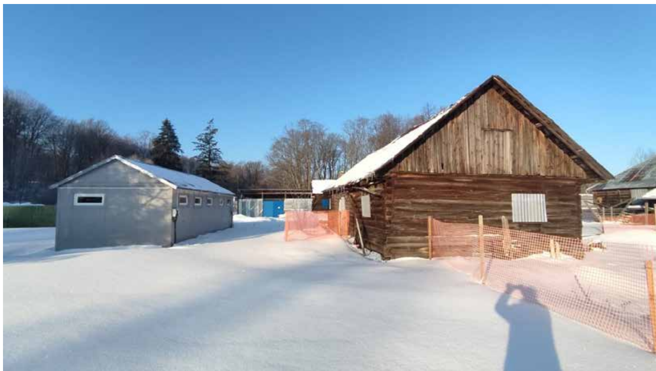
Фото 1. Вид на восточный фасад здания.
