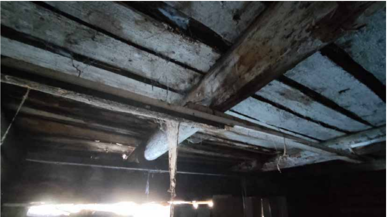
Фото 10. Состояние потолочных перекрытий.
