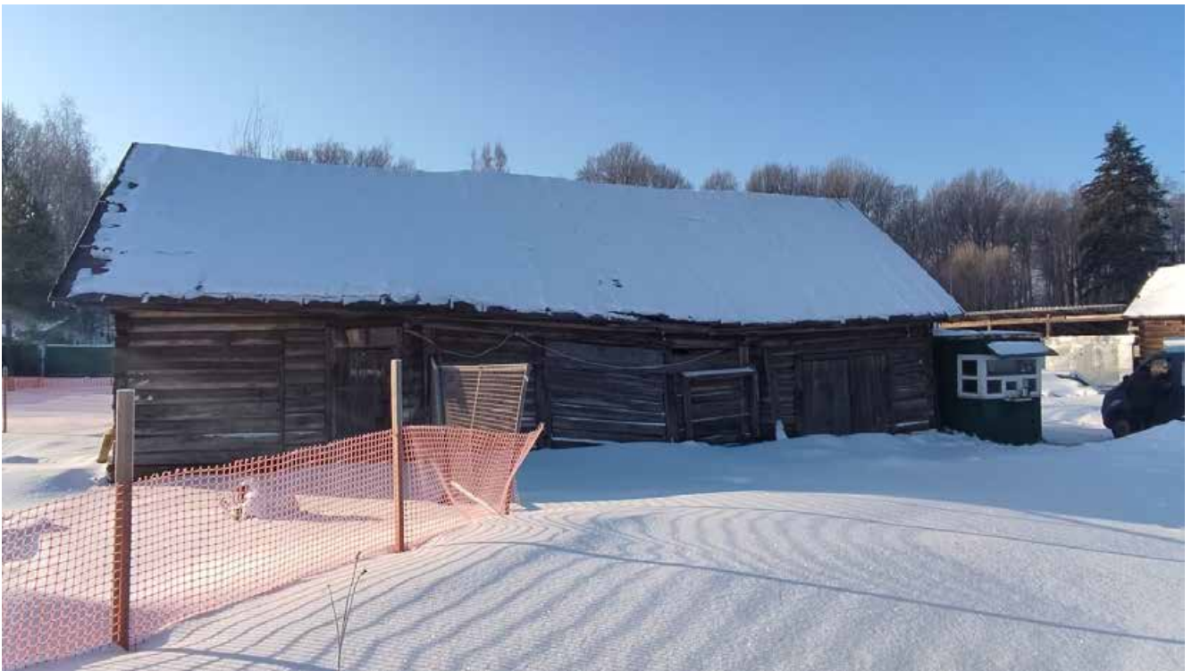
Фото 2. Общий вид северного фасада здания.
