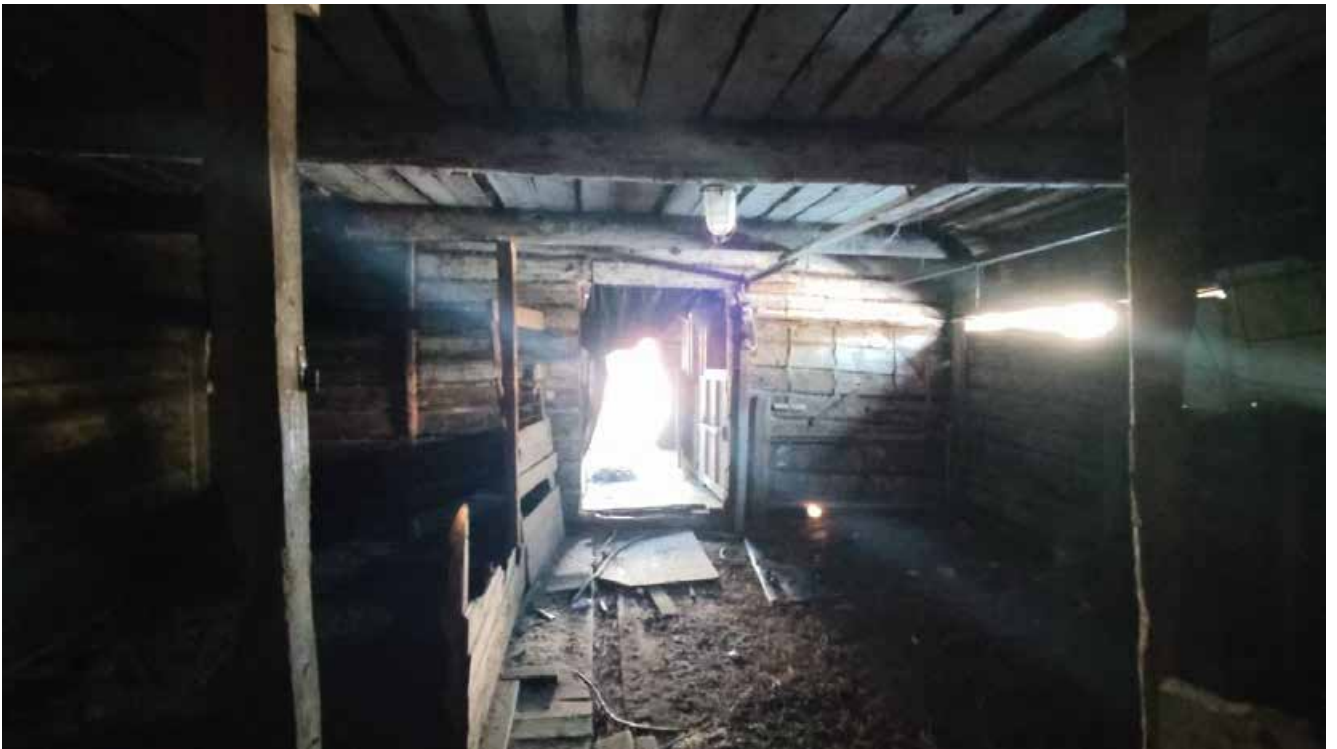
Фото 13. Внутреннее состояние помещения (вид на западный вход).
