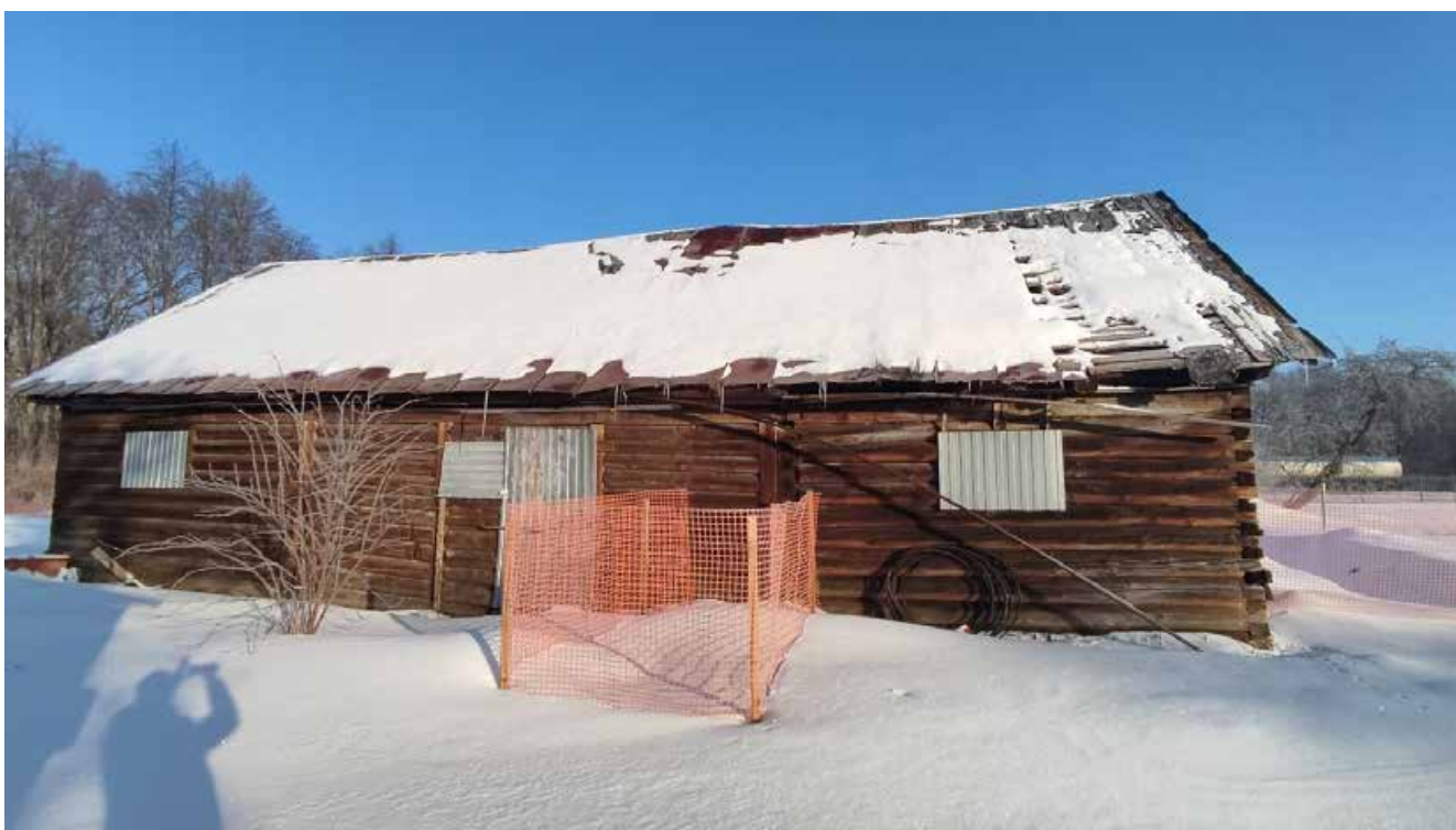
Фото 4. Общий вид южного фасада здания.
