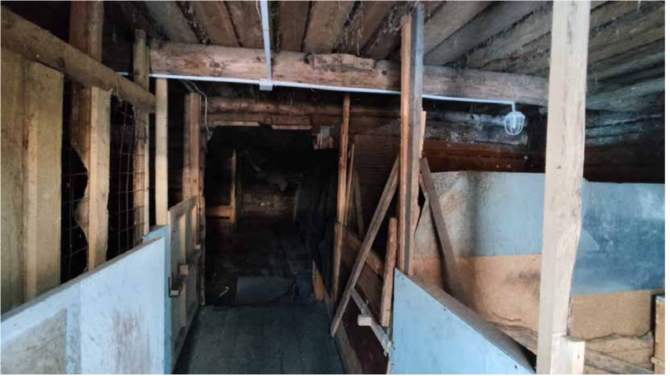
Фото 9. Внутреннее состояние помещения. Вид от западного входа.
