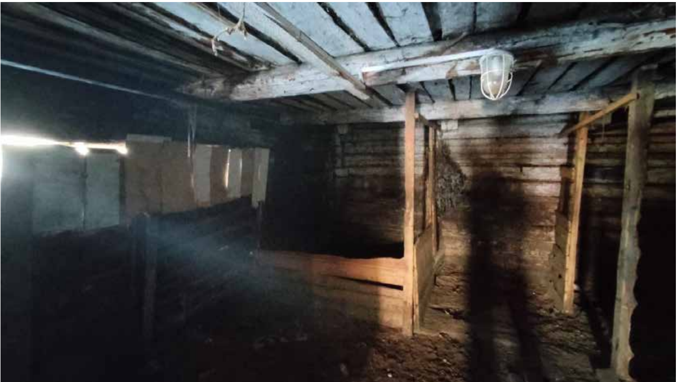
Фото 11. Внутреннее состояние помещения (северо-восточный угол)
