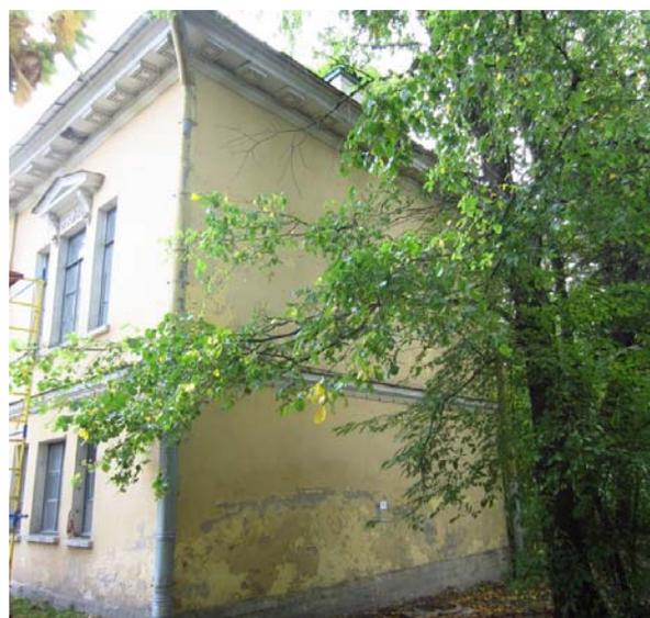
южный фасад – междуэтажная профилированная тяга; оформление оконных проемов – декоративные замковые камни над проемами первого этажа; треугольные сандрики на модульонах с лепными растительного характера композициями между ними – второго этажа;
