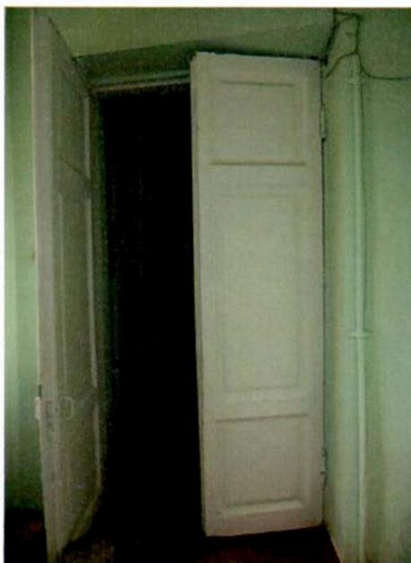
заполнение входного проема (из 34 в 35 пом.) – дверь двустворчатая, каждая створка на три разноформатные фигурейных филенки: материал (дерево), профиль, рисунок;
