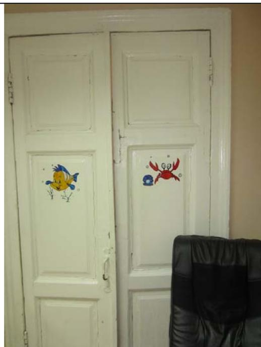
заполнение входного проема - 2эт. 1-Н (из 19 в 21 из 21 в 22, из 22 в 24 помещения; из 19 в 35) – дверь двустворчатая, каждая створка на три разноформатные фигурейных филенки: материал (дерево), профиль, рисунок;
