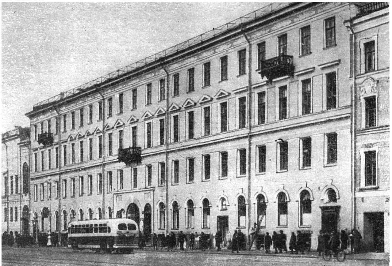
Илл.18. Невский проспект. Фасад дома №88 после реконструкции и окраски. Из журнала "Архитектура Ленинграда" №3 1950 г. Источник – pastvu.com.
