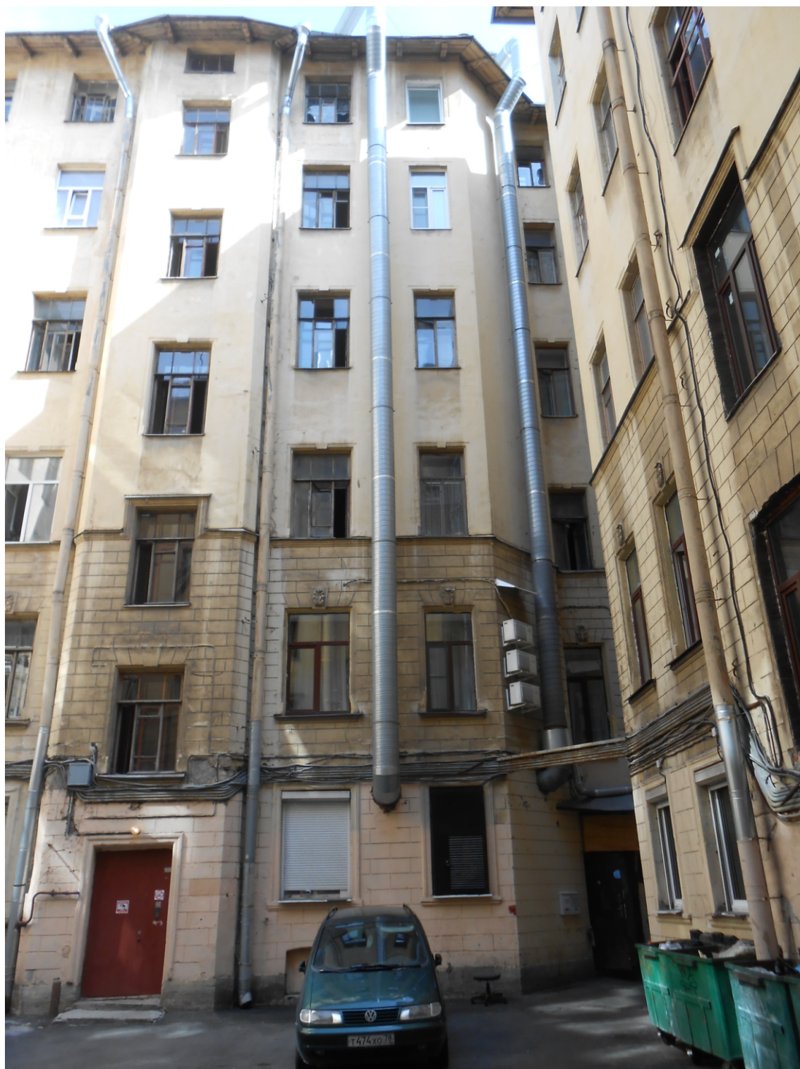
5. «Дом П.Г.Гулина». Санкт-Петербург, Средний пр., дом 11, литера А. 1-й двор. Западный дворовый фасад. Фото: 20.08.2021.
