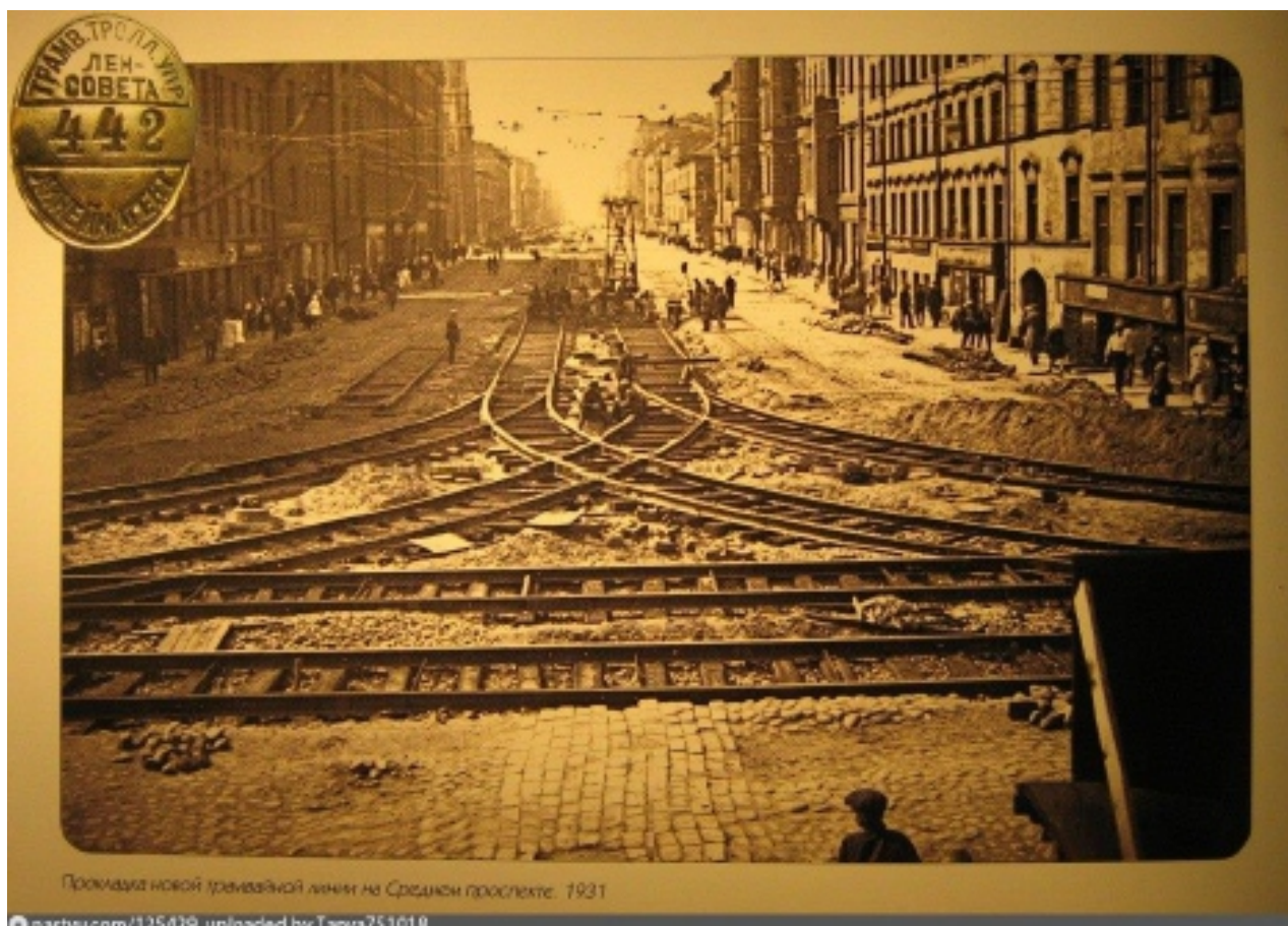
Ил.17 Прокладка трамвайных путей на Среднем проспекте. Фото 1931 г. Интернет-ресурс https://pastvu.com/p/125429 .
