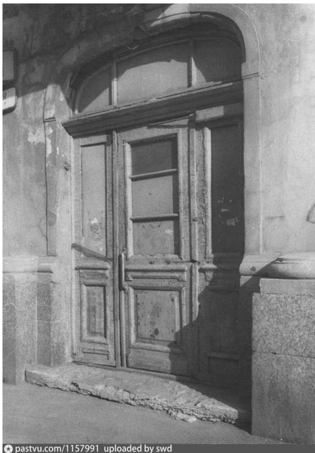
Ил.16 Входной проем.
