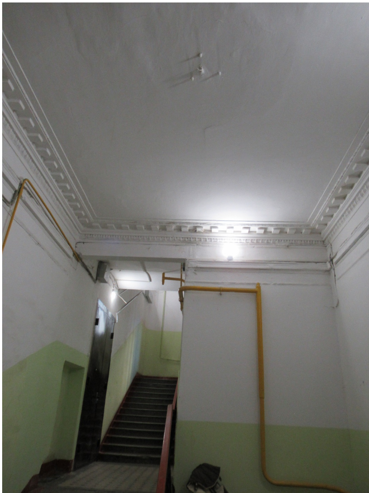
55. 12-я линия В.О., 19. Дом О.М. Фогт и Б.А. Попова. 1ЛК, вид на лестницу из вестибюля.
