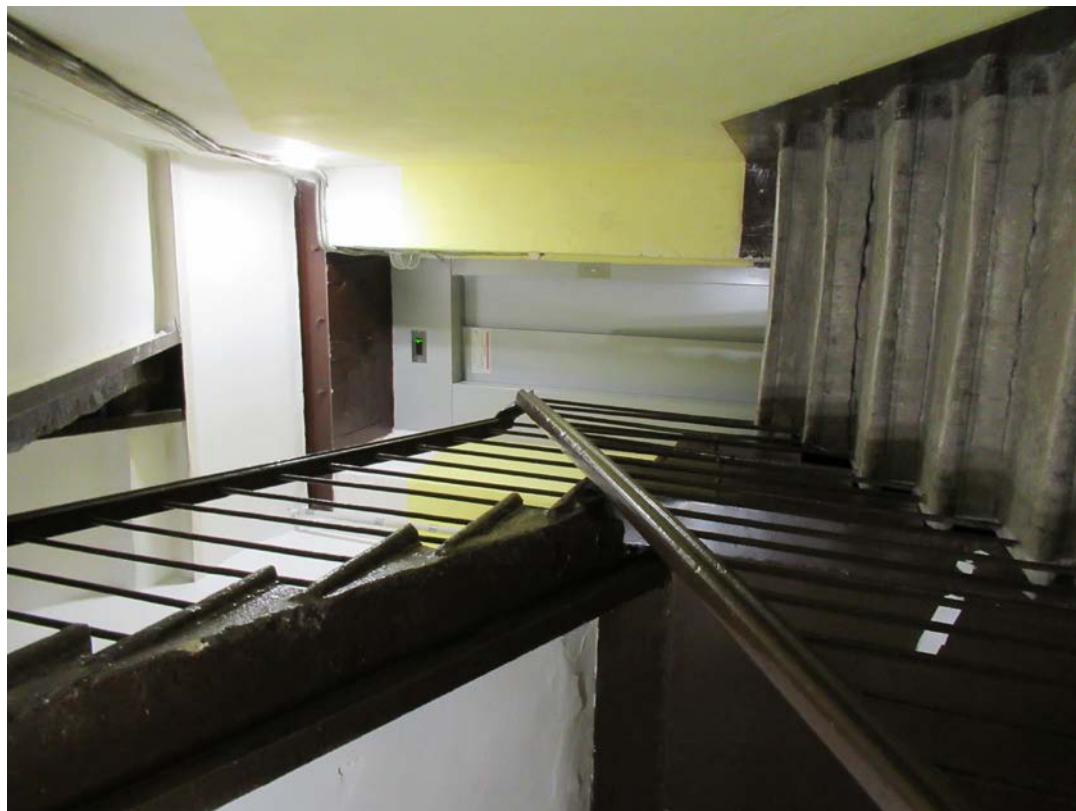
106. 12-я линия В.О., 19. Дом О.М. Фогт и Б.А. Попова. 4ЛК, вид снизу на лестничную клетку с лифтом.
