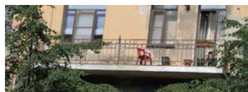
Балкон в уровне 3 этажа.
