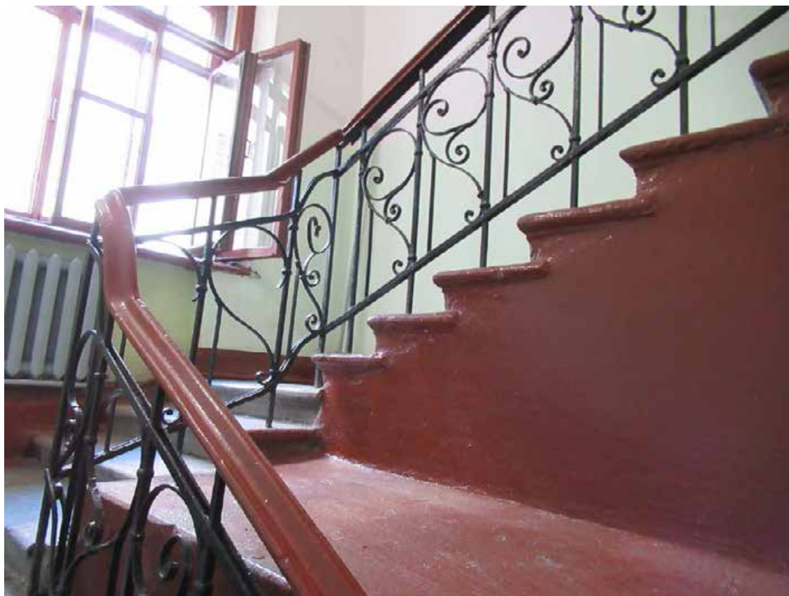
76. 12-я линия В.О., 19. Дом О.М. Фогт и Б.А. Попова. ЗЛК, фрагмент исторического металлического лестничного ограждения.
