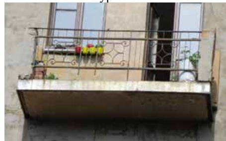
Балкон в уровне 5 этажа.
