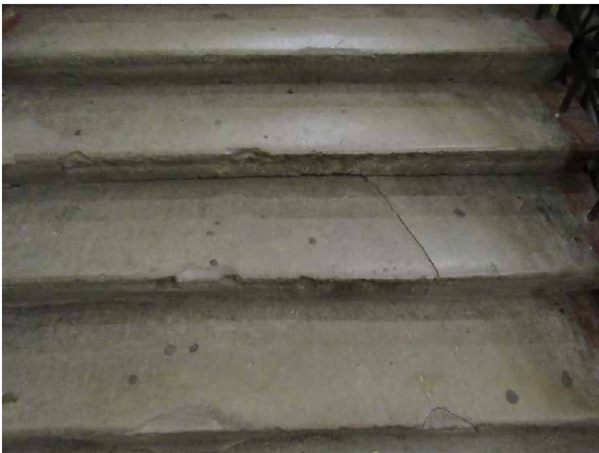
74. 12-я линия В.О., 19. Дом О.М. Фогт и Б.А. Попова. ЗЛК, ступени лещадной плиты.
