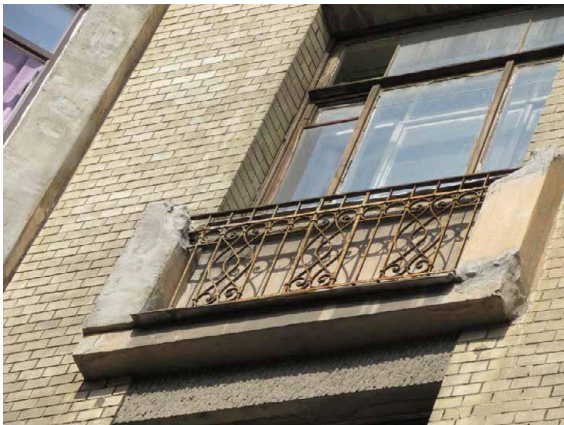
18. 12-я линия В.О., 19. Дом О.М. Фогт и Б.А. Попова. Ограждение французского балкона оконного проема в уровне 4-го этажа.
