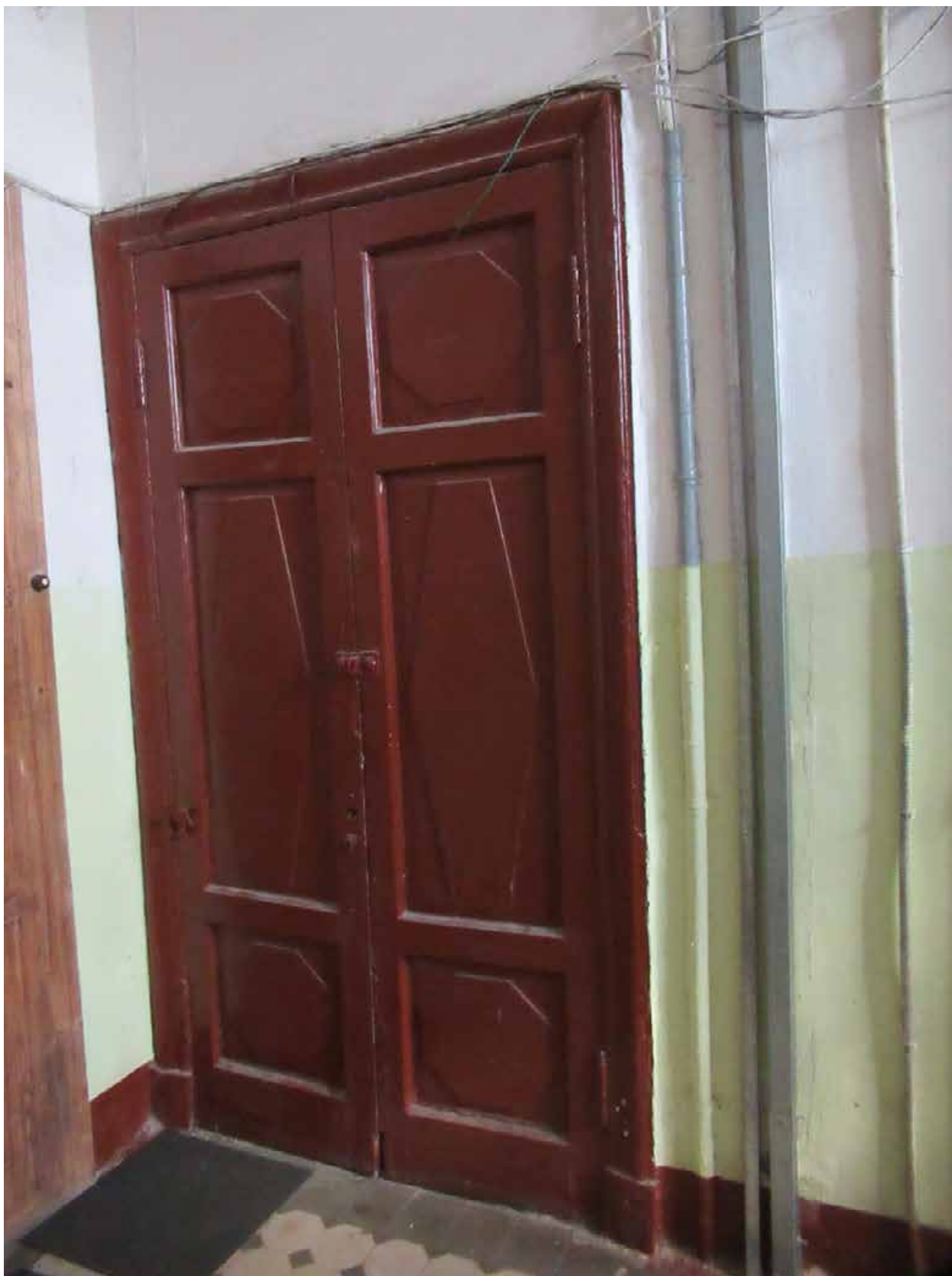
80. 12-я линия В.О., 19. Дом О.М. Фогт и Б.А. Попова. ЗЛК, дверь квартиры с историческим деревянным заполнением.
