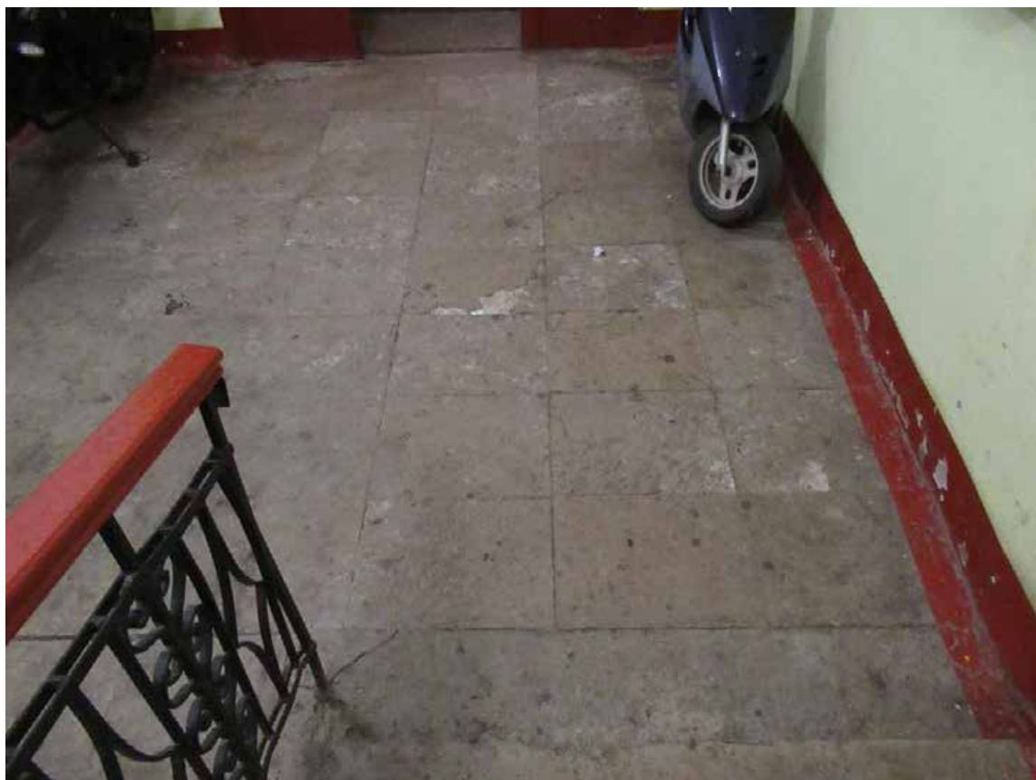
56. 12-я линия В.О., 19. Дом О.М. Фогт и Б.А. Попова. 1ЛК, пол вестибюля, облицованный лещадной плитой.
