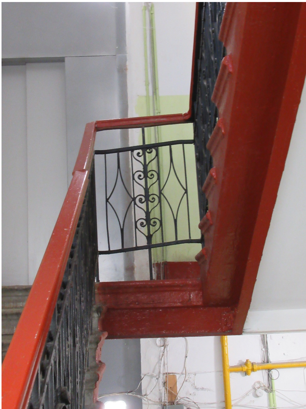
69. 12-я линия В.О., 19. Дом О.М. Фогт и Б.А. Попова. 1ЛК, фрагмент исторического металлического ограждения лестничной клетки.
