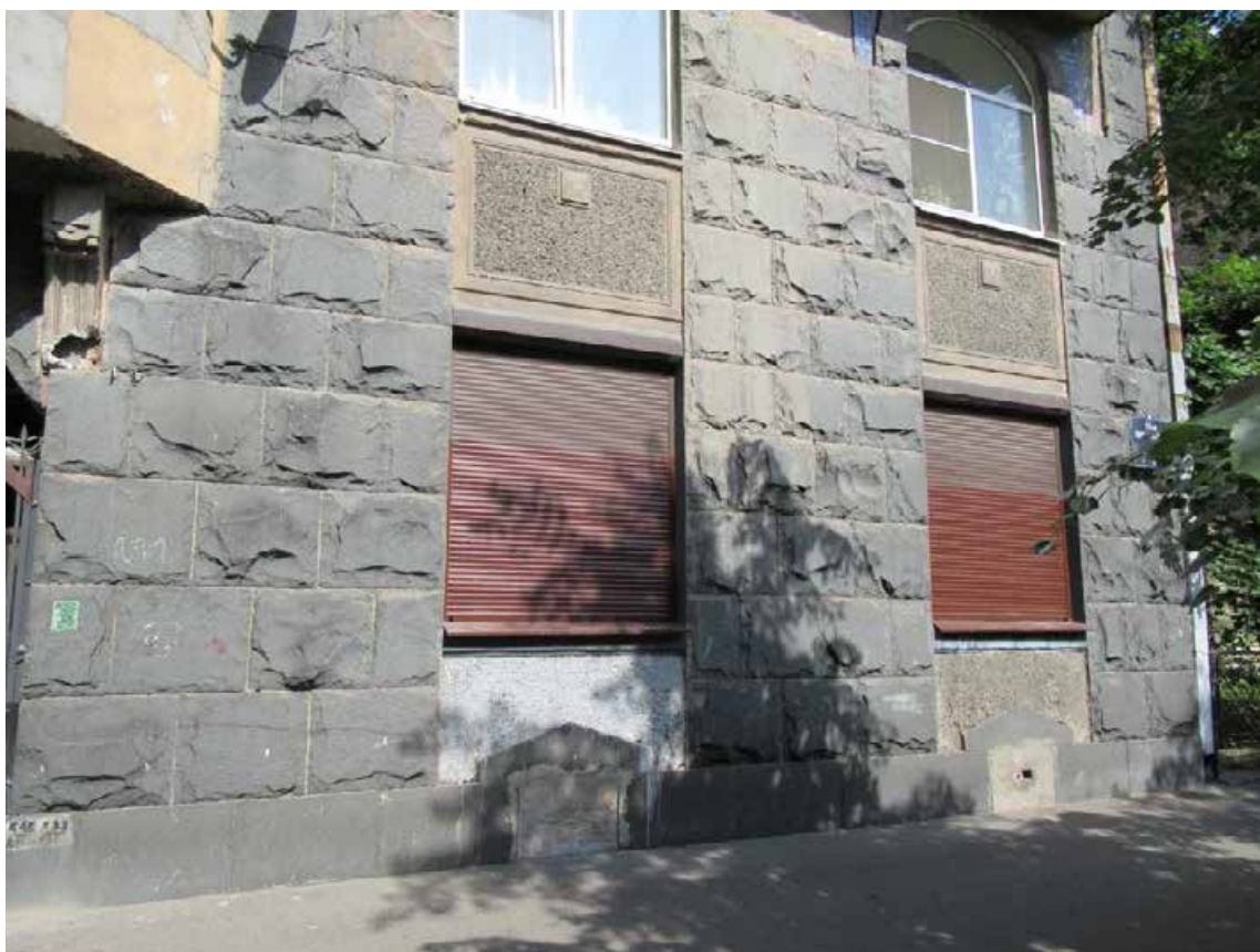
8. 12-я линия В.О., 19. Дом О.М. Фогт и Б.А. Попова. Южная часть лицевого фасада в уровне 1-2 этажей.
