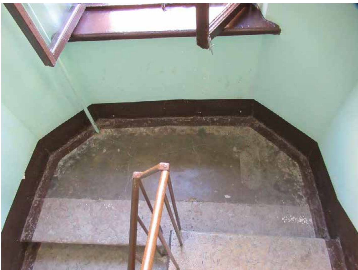
99. 12-я линия В.О., 19. Дом О.М. Фогт и Б.А. Попова. 5ЛК, вид сверху на лестничную клетку с окном во двор.
