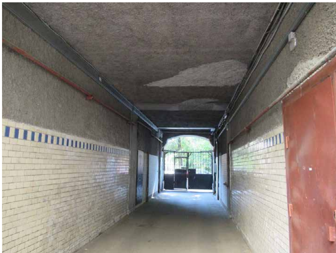
32. 12-я линия В.О., 19. Дом О.М. Фогт и Б.А. Попова. Воротный проезд лицевого корпуса, вид со стороны двора.
