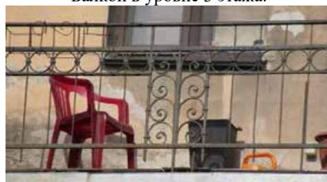
Ограждение балкона в уровне 3-го этажа.
