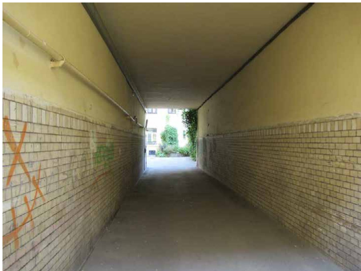
40. 12-я линия В.О., 19. Дом О.М. Фогт и Б.А. Попова. Воротный проезд поперечного корпуса, вид со стороны западного двора.
