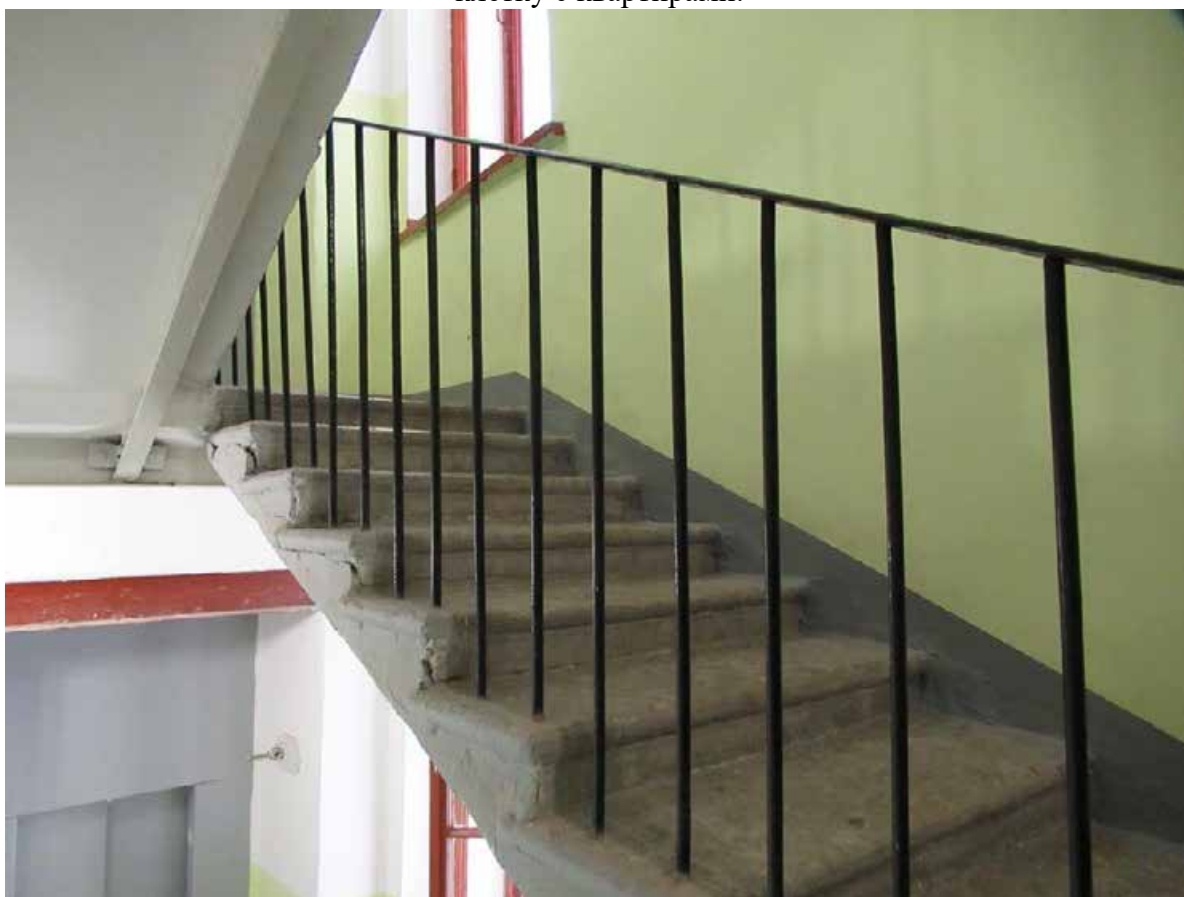
94. 12-я линия В.О., 19. Дом О.М. Фогт и Б.А. Попова. 2ЛК, металлическое лестничное ограждение.
