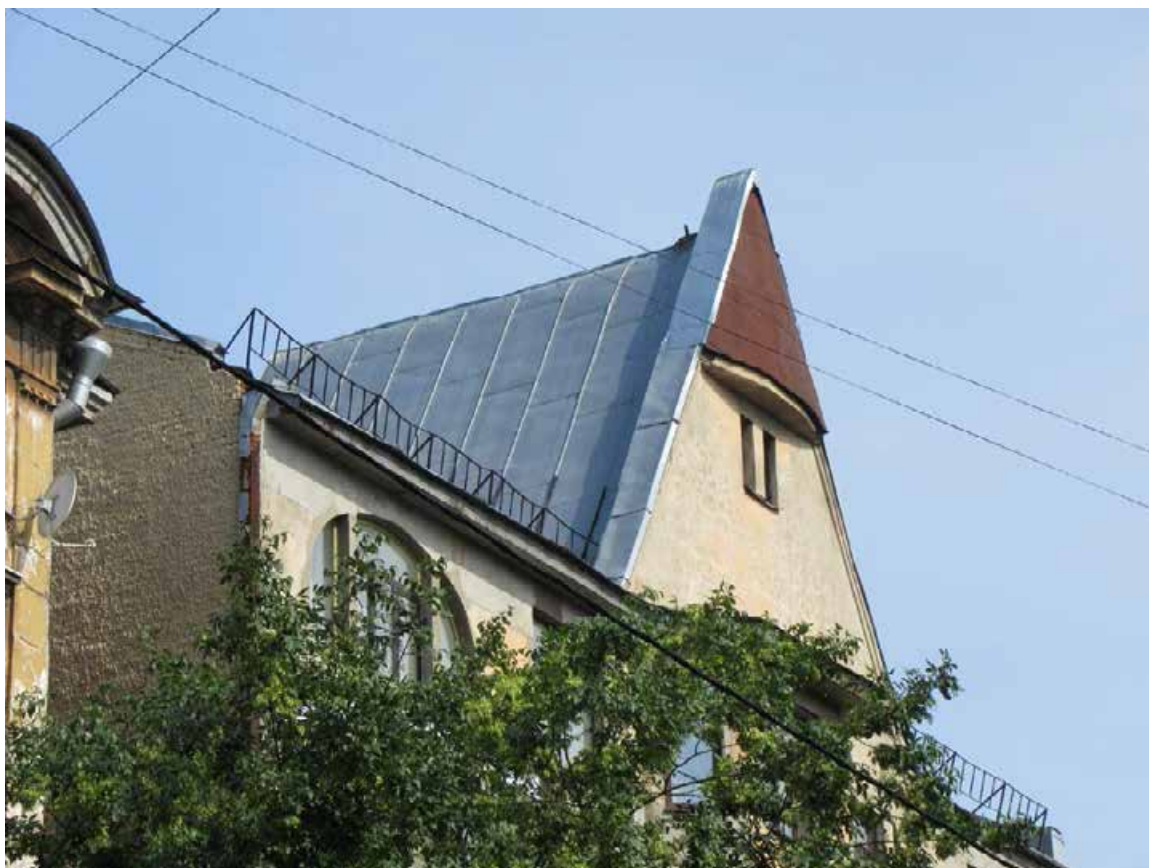
15. 12-я линия В.О., 19. Дом О.М. Фогт и Б.А. Попова. Щипец центральной части лицевого фасада, вид с северо-запада.
