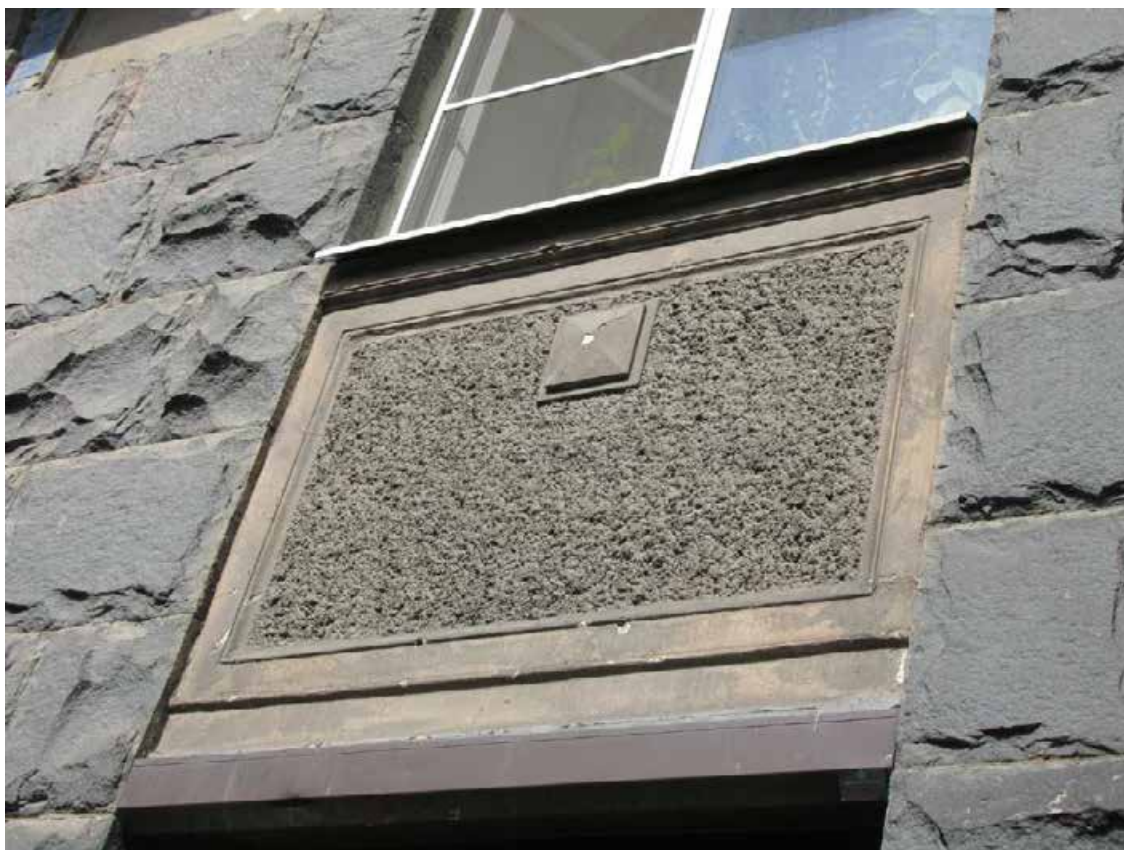
14. 12-я линия В.О., 19. Дом О.М. Фогт и Б.А. Попова. Штукатурный декоративный элемент южной части лицевого фасада между оконными проемами 1-го и 2-го этажей.
