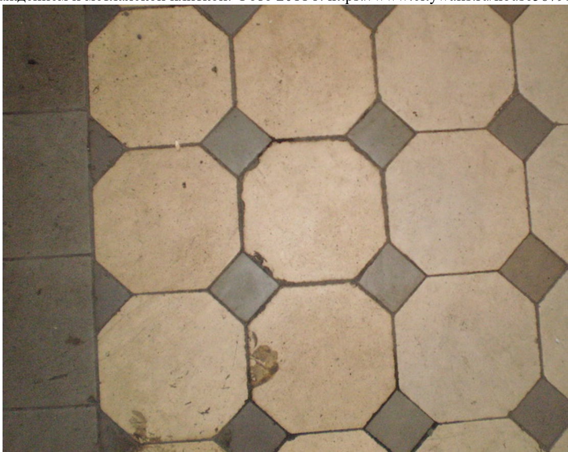
41. Парадная лестница (1ЛК). Фрагмент покрытия пола лестничной площадки метлахской плиткой. Фото 2011 г. https://www.citywalls.ru/house5879.html
