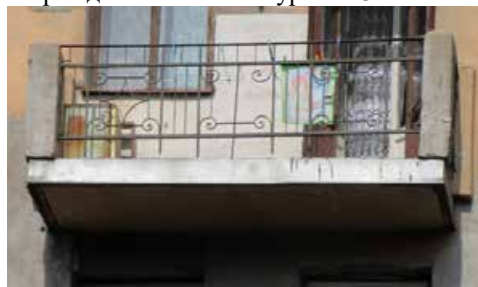
Балкон в уровне 4 этажа.
