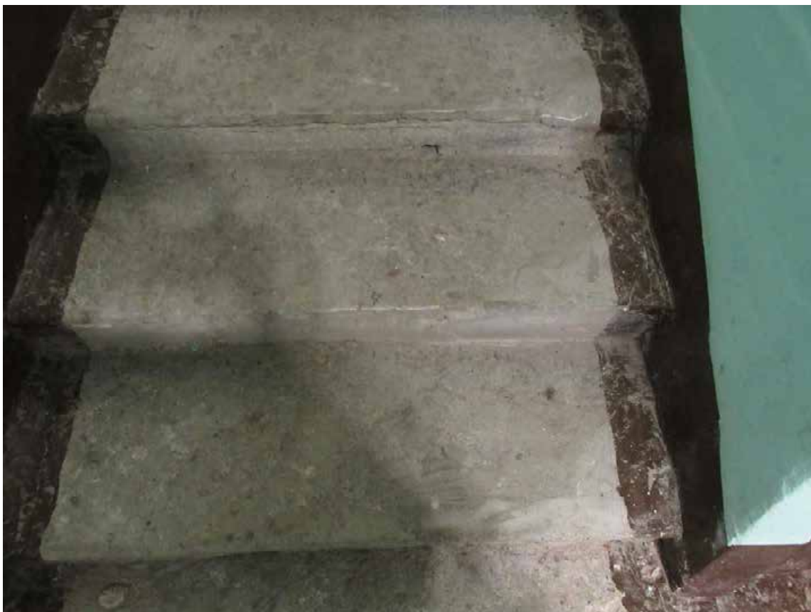
98. 12-я линия В.О., 19. Дом О.М. Фогт и Б.А. Попова. 5ЛК, ступени лещадной плиты.
