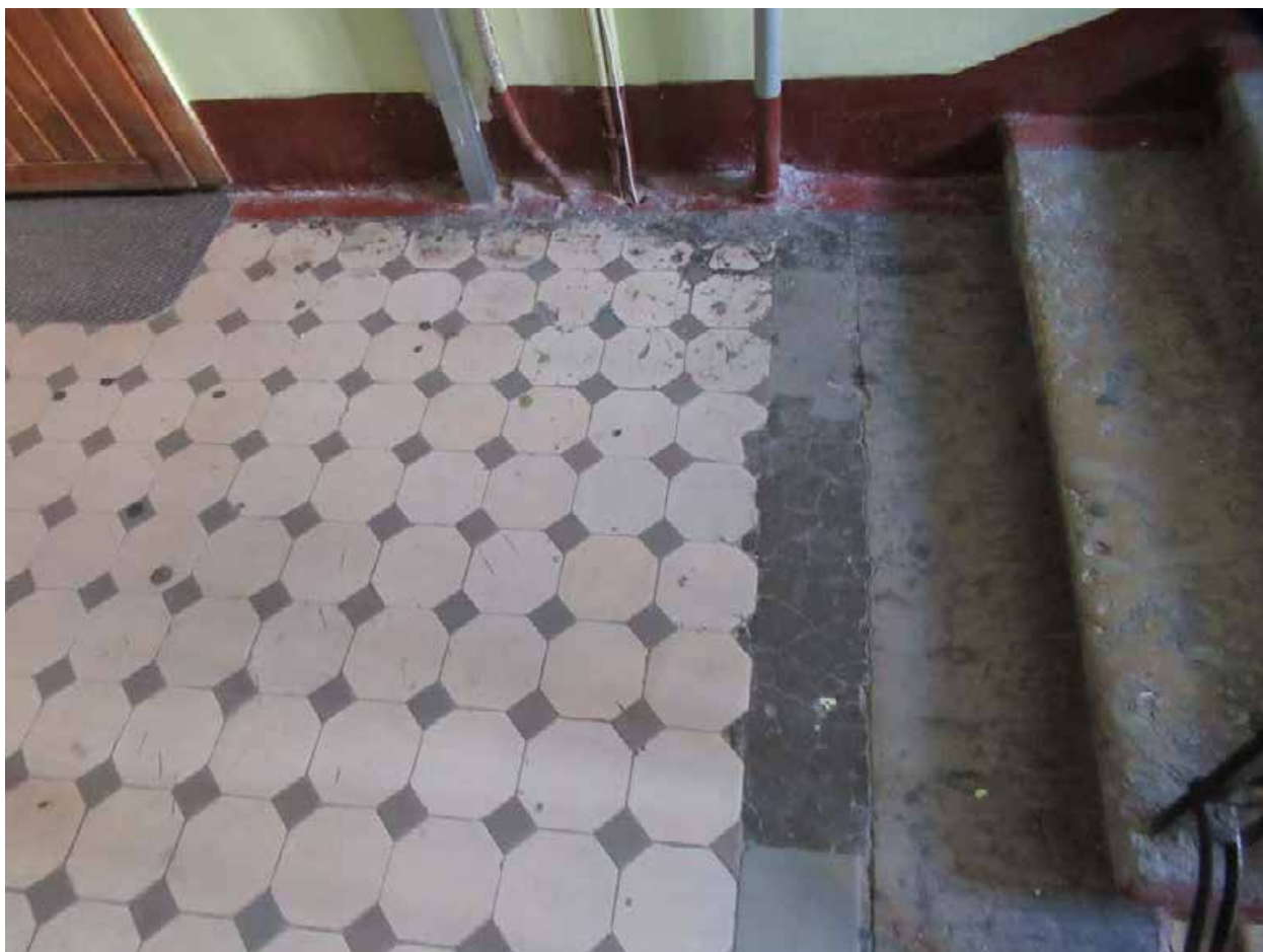
81. 12-я линия В.О., 19. Дом О.М. Фогт и Б.А. Попова. ЗЛК, фрагмент покрытия пола лестничной клетки метлахской плиткой.
