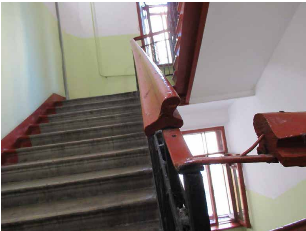
68. 12-я линия В.О., 19. Дом О.М. Фогт и Б.А. Попова. 1ЛК, профиль исторических деревянных перил лестничного ограждения.
