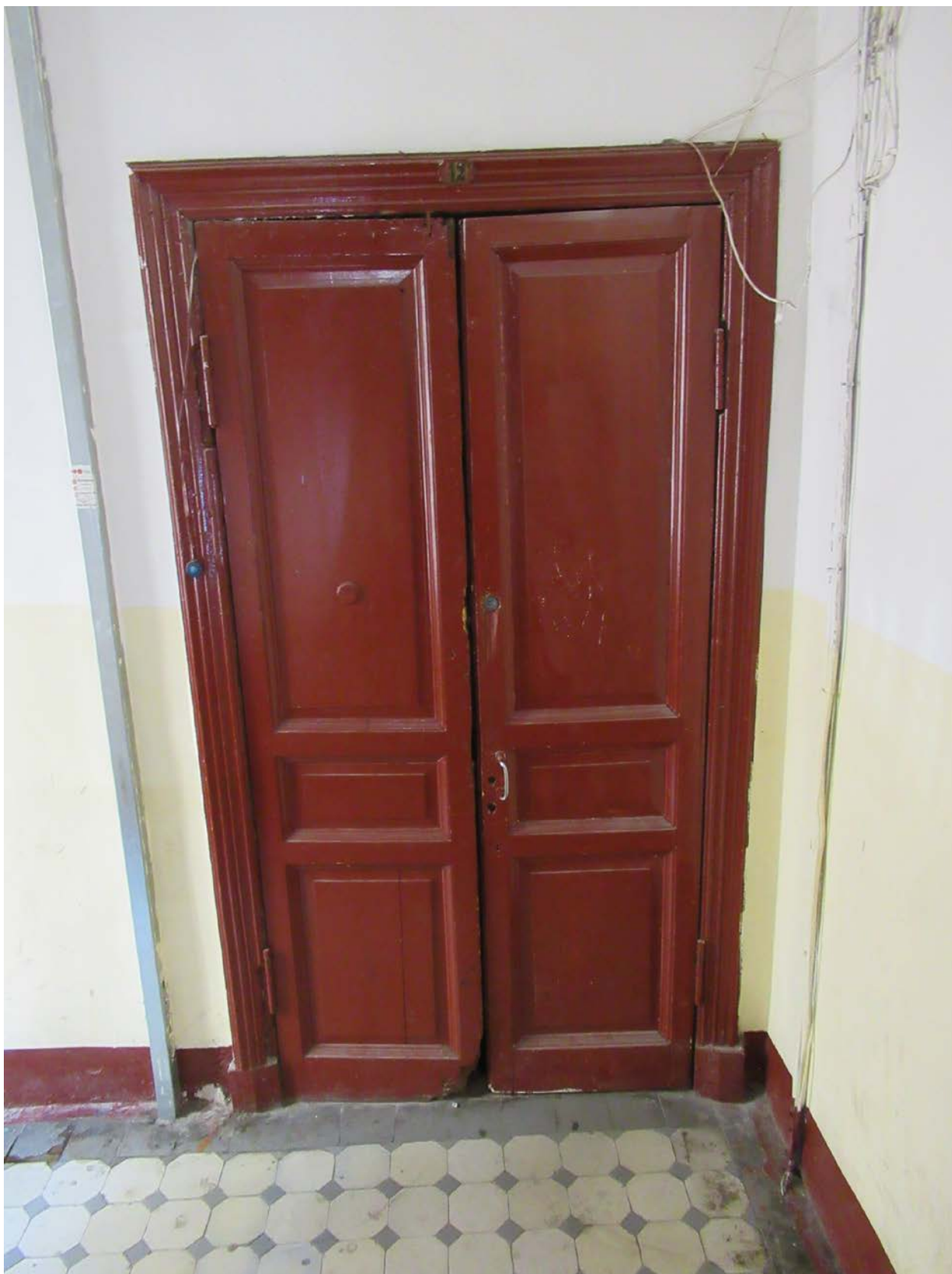
53. 12-я линия В.О., 15, лит. А. Доходный дом Н.В. Смирнова, входящий в состав ОКН «Доходный дом и особняк Н.В. Смирнова». ЗЛК, дверной проем квартиры с историческим деревянным заполнением.
