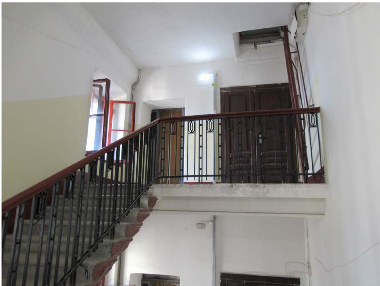
55. 12-я линия В.О., 15, лит. А. Доходный дом Н.В. Смирнова, входящий в состав ОКН «Доходный дом и особняк Н.В. Смирнова». ЗЛК, вид снизу на площадку 7-го этажа.
