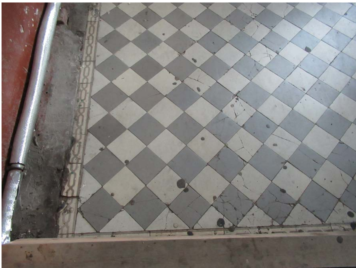
37. 12-я линия В.О., 15, лит. А. Доходный дом Н.В. Смирнова, входящий в состав ОКН «Доходный дом и особняк Н.В. Смирнова». Парадная лестница (4ЛК).
