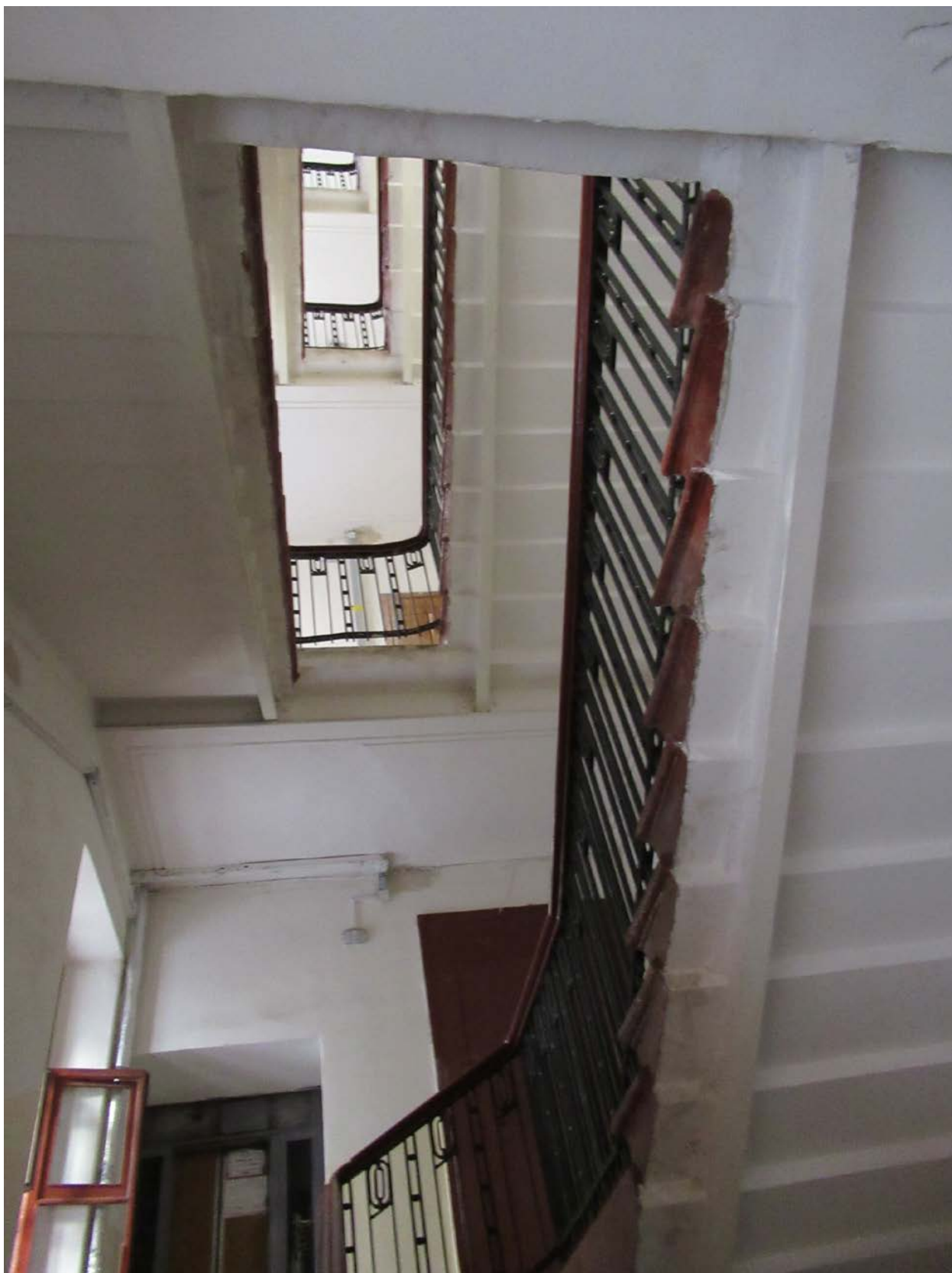
48. 12-я линия В.О., 15, лит. А. Доходный дом Н.В. Смирнова, входящий в состав ОКН «Доходный дом и особняк Н.В. Смирнова». ЗЛК, вид на лестничные марши снизу.
