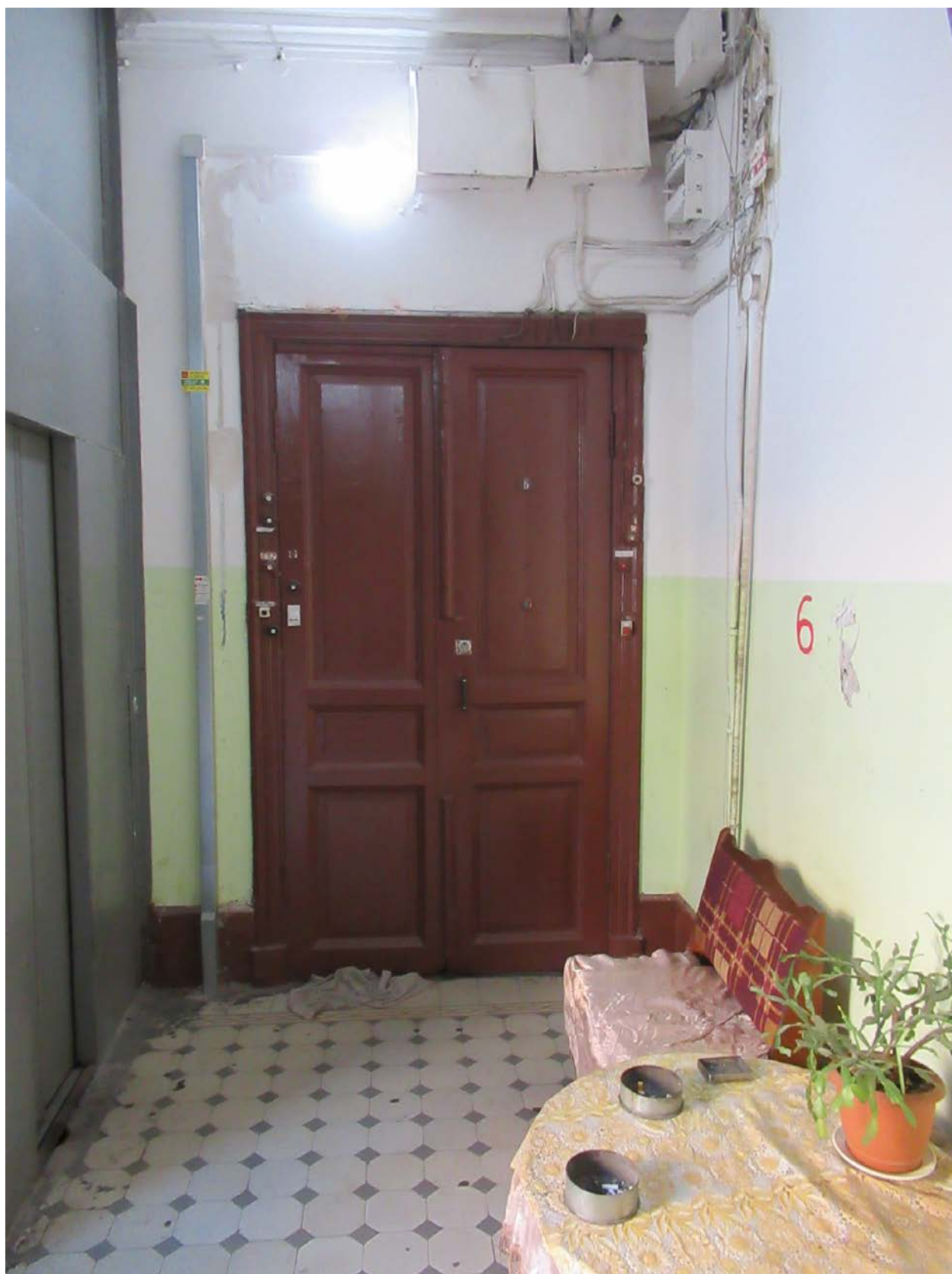
46. 12-я линия В.О., 15, лит. А. Доходный дом Н.В. Смирнова, входящий в состав ОКН «Доходный дом и особняк Н.В. Смирнова». Парадная лестница (4ЛК). Дверной проем квартиры с историческим деревянным заполнением на площадке 6-го этажа.
