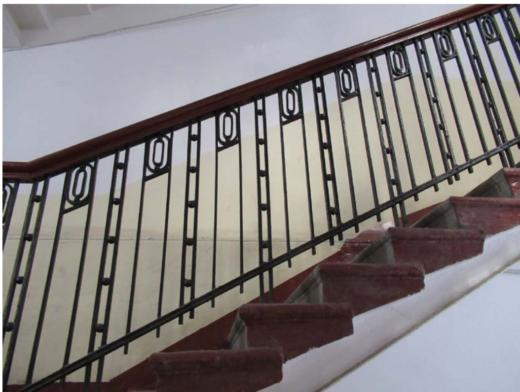
50. 12-я линия В.О., 15, лит. А. Доходный дом Н.В. Смирнова, входящий в состав ОКН «Доходный дом и особняк Н.В. Смирнова». ЗЛК, фрагмент исторического металлического ограждения с деревянными перилами.
