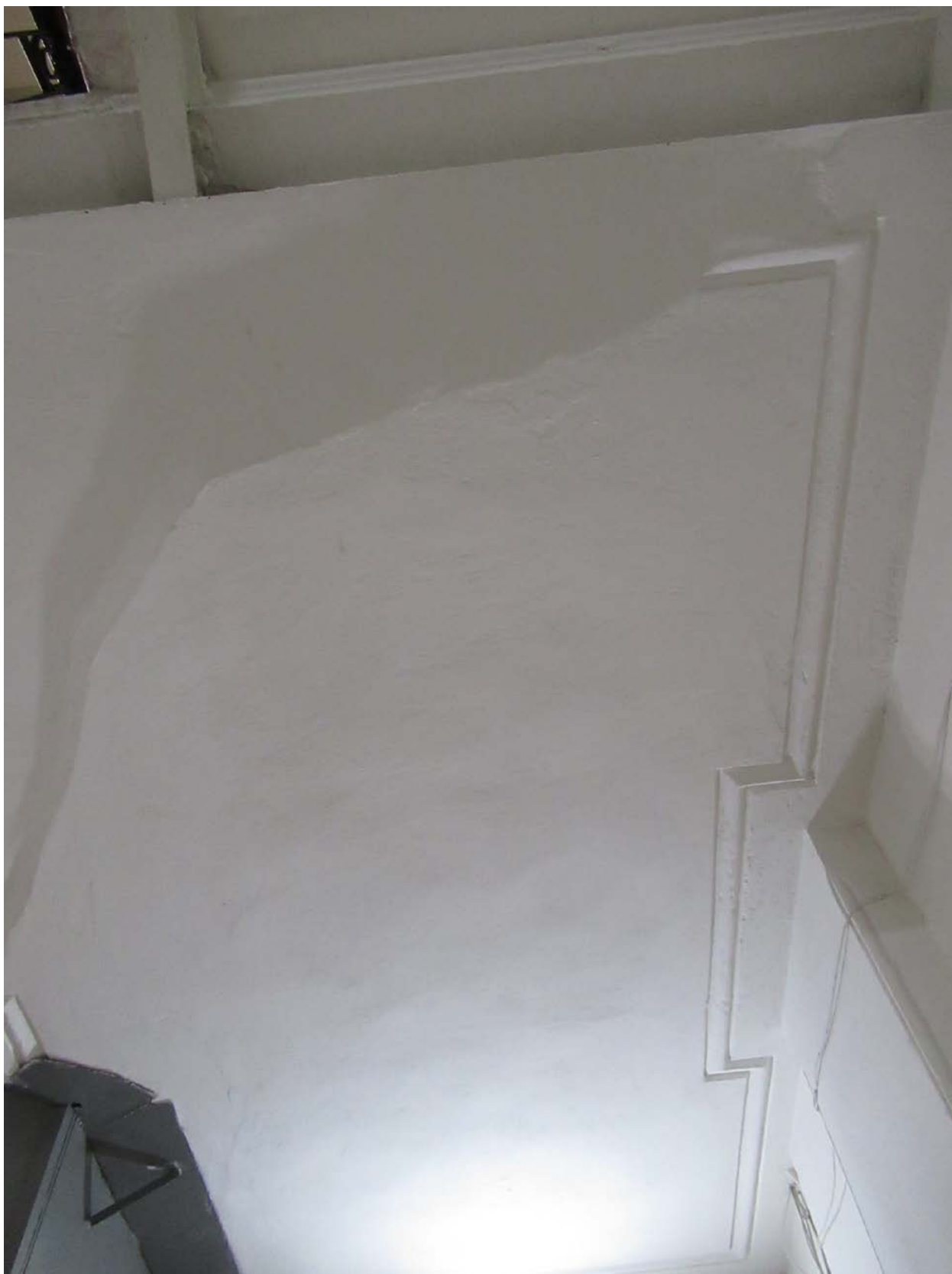
43. 12-я линия В.О., 15, лит. А. Доходный дом Н.В. Смирнова, входящий в состав ОКН «Доходный дом и особняк Н.В. Смирнова». Парадная лестница (4ЛК). Потолок лестничной площадки.
