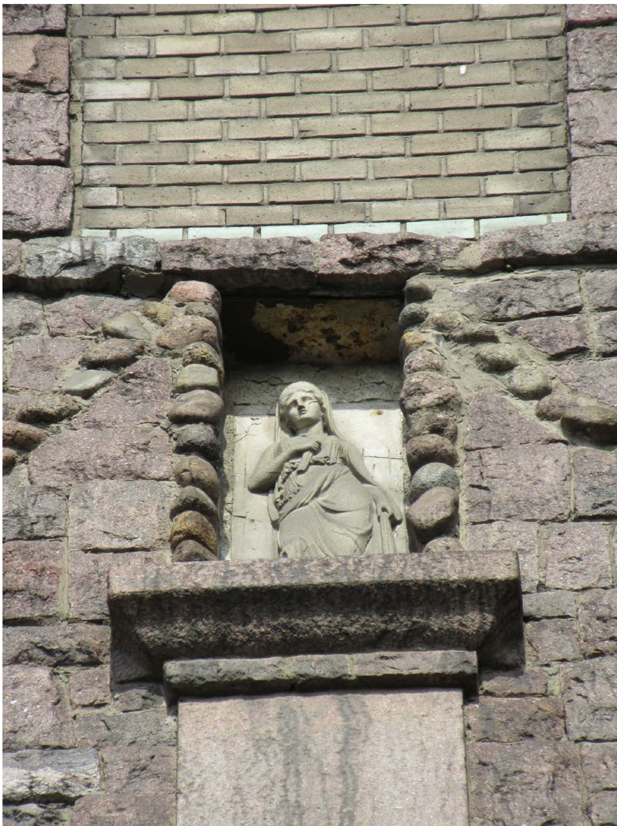
12. 12-я линия В.О., 15, лит. А. Доходный дом Н.В. Смирнова, входящий в состав ОКН «Доходный дом и особняк Н.В. Смирнова». Скульптура в нише над пилястром в центральной части лицевого фасада.
