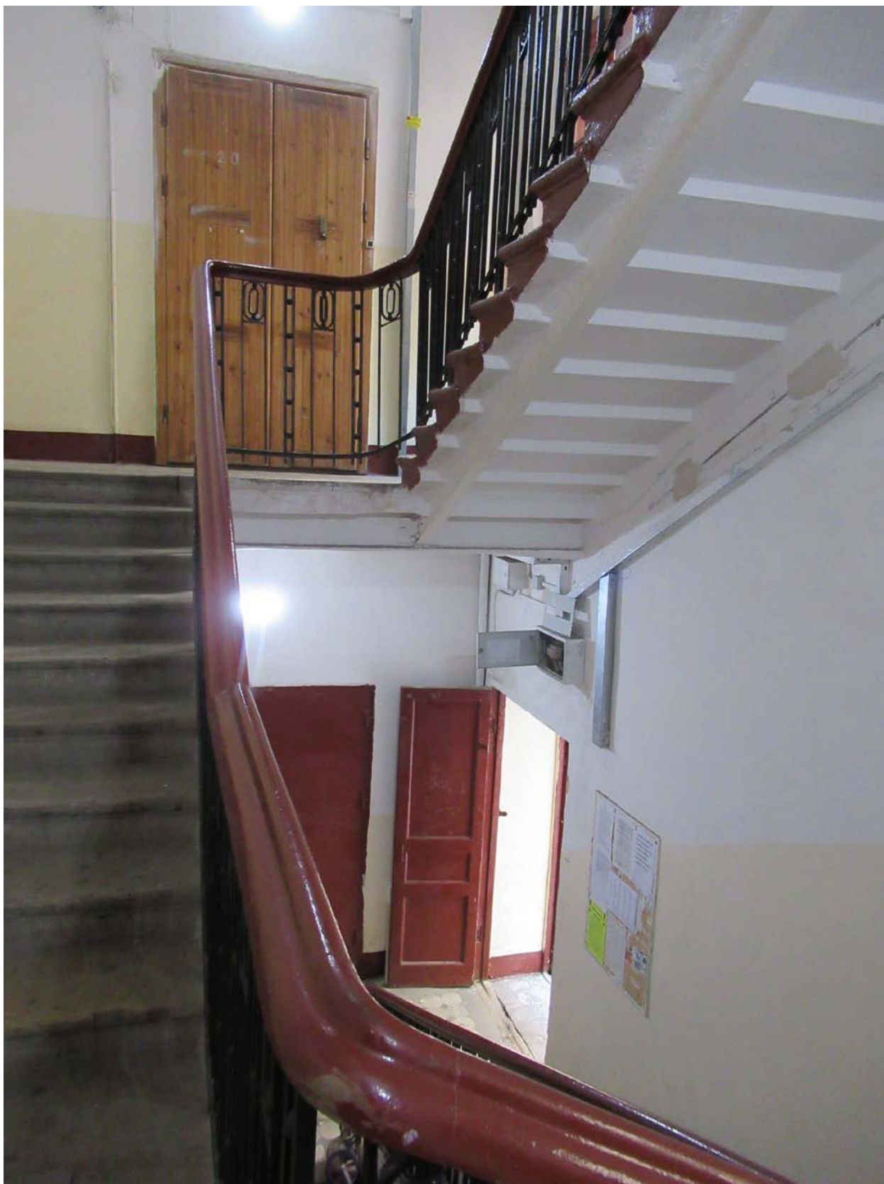
49. 12-я линия В.О., 15, лит. А. Доходный дом Н.В. Смирнова, входящий в состав ОКН «Доходный дом и особняк Н.В. Смирнова». ЗЛК, вид сверху на вестибюль.
