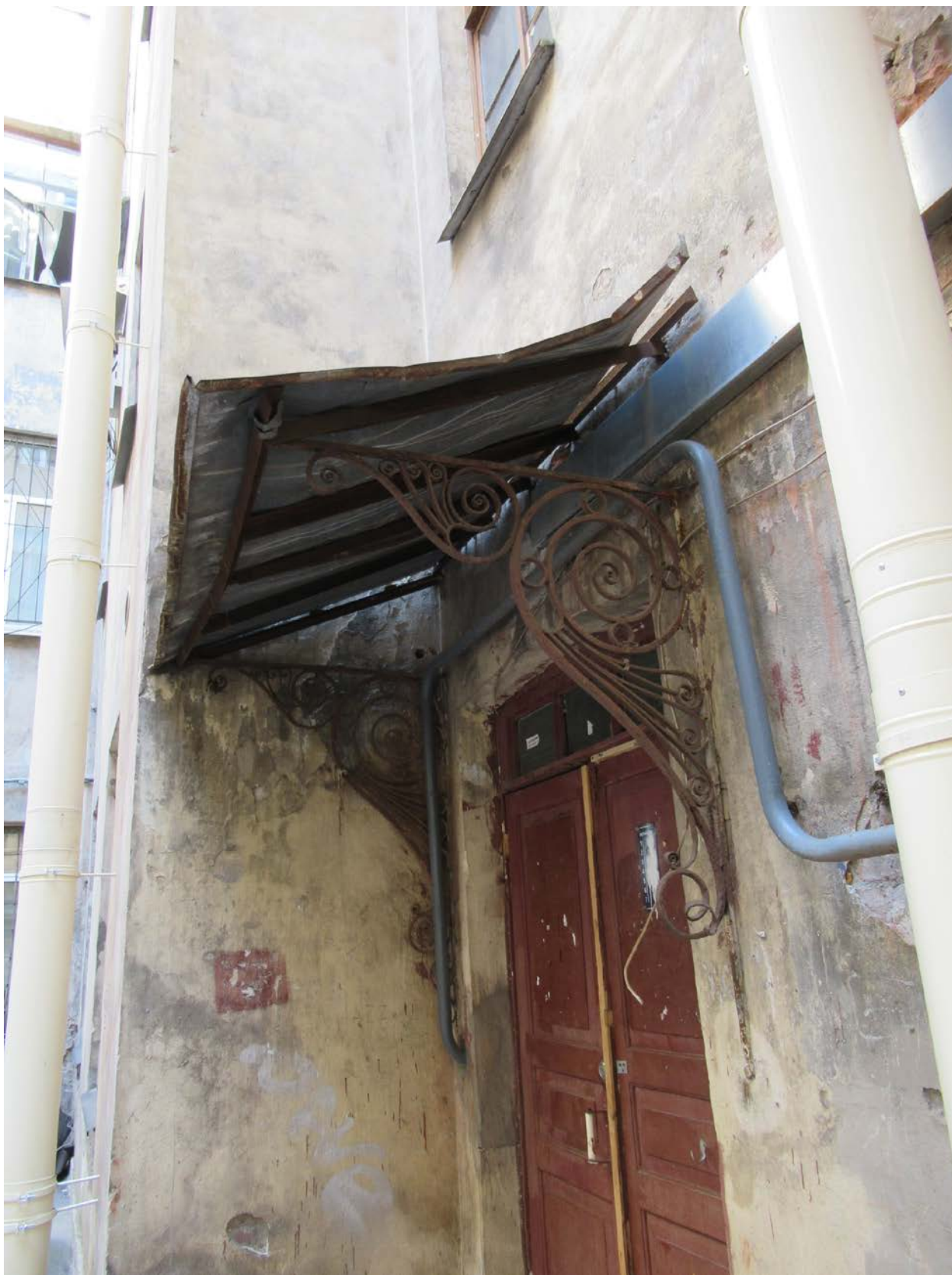
26. 12-я линия В.О., 15, лит. А. Доходный дом Н.В. Смирнова, входящий в состав ОКН «Доходный дом и особняк Н.В. Смирнова». Входной проем на лестницу 2ЛК с историческим деревянным заполнением и металлическими кронштейнами козырька.
