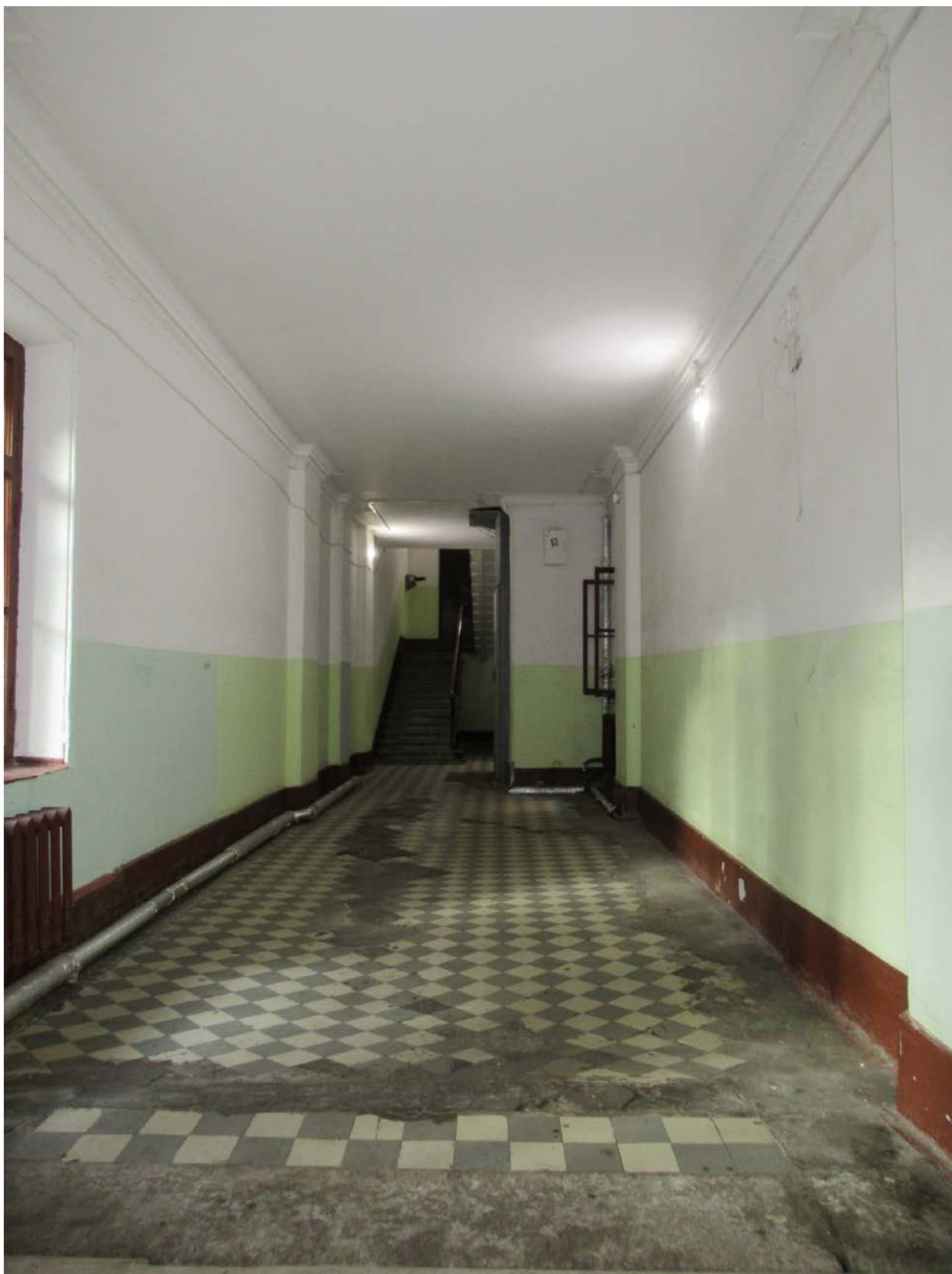
36. 12-я линия В.О., 15, лит. А. Доходный дом Н.В. Смирнова, входящий в состав ОКН «Доходный дом и особняк Н.В. Смирнова». Парадная лестница (4ЛК). Вид из вестибюля на лестницу.
