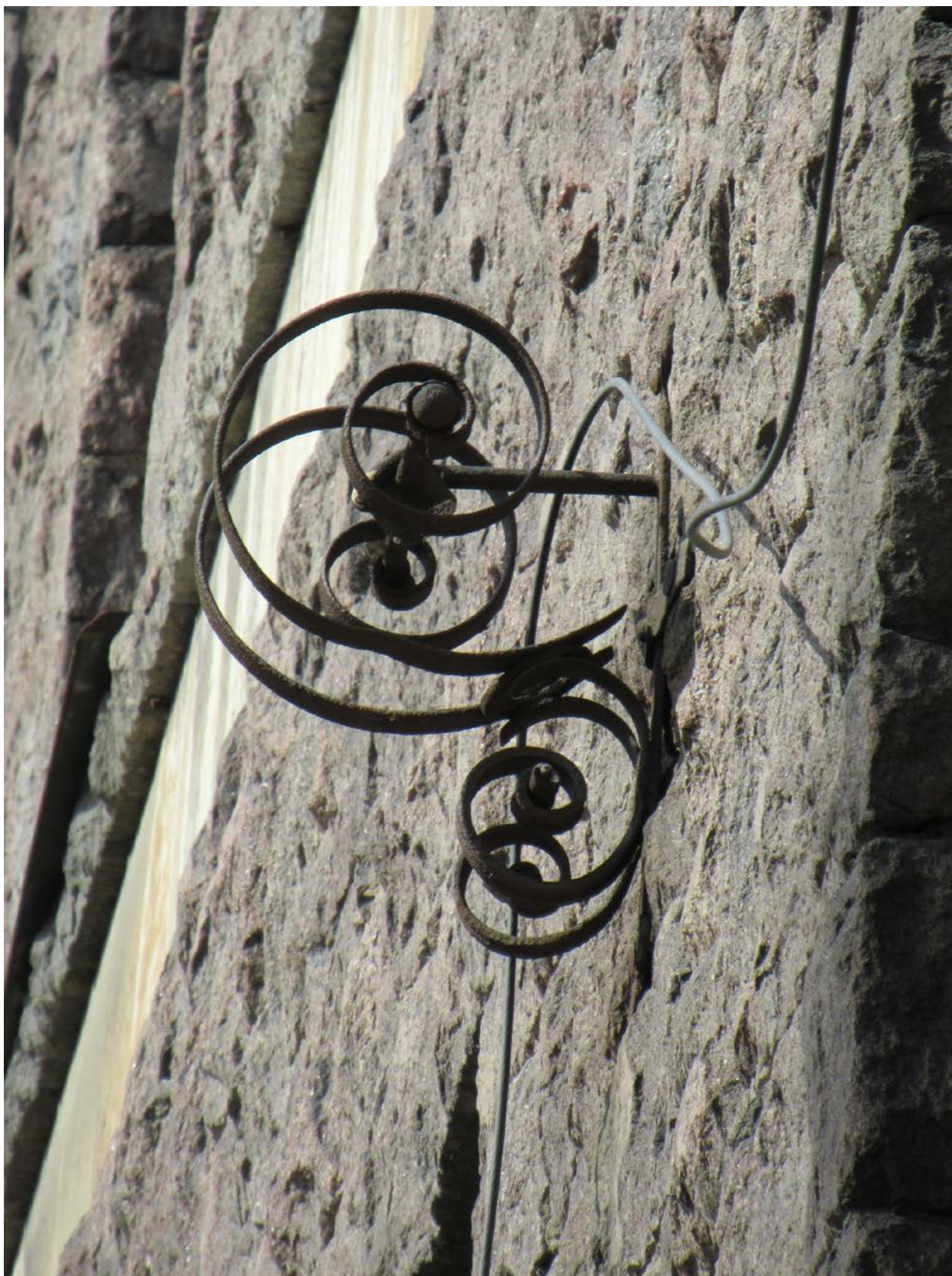
8. 12-я линия В.О., 15, лит. А. Доходный дом Н.В. Смирнова, входящий в состав ОКН «Доходный дом и особняк Н.В. Смирнова». Лицевой фасад, флагодержатель в уровне 2-го этажа.
