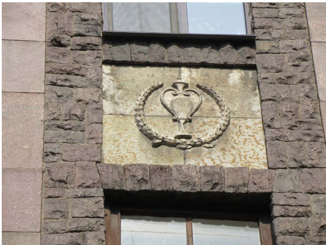
10. 12-я линия В.О., 15, лит. А. Доходный дом Н.В. Смирнова, входящий в состав ОКН «Доходный дом и особняк Н.В. Смирнова». Декоративное панно из известняка в простенке между 3 и 4 этажами в центральной части лицевого фасада.
