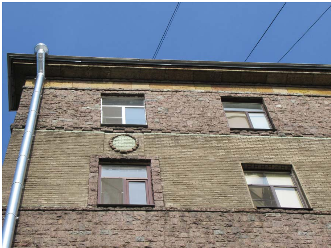
15. 12-я линия В.О., 15, лит. А. Доходный дом Н.В. Смирнова, входящий в состав ОКН «Доходный дом и особняк Н.В. Смирнова». Боковая часть лицевого фасада в уровне 5-6 этажей.
