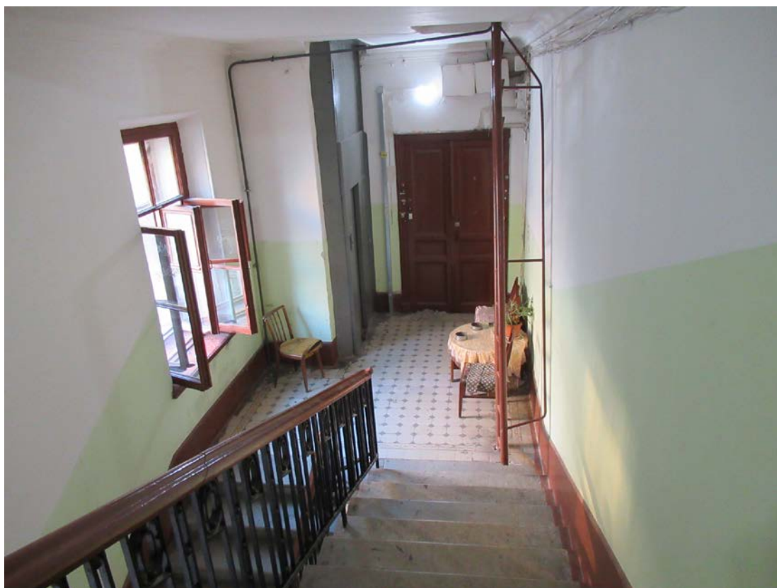
45. 12-я линия В.О., 15, лит. А. Доходный дом Н.В. Смирнова, входящий в состав ОКН «Доходный дом и особняк Н.В. Смирнова». Парадная лестница (4ЛК). Вид сверху на площадку 6-го этажа.
