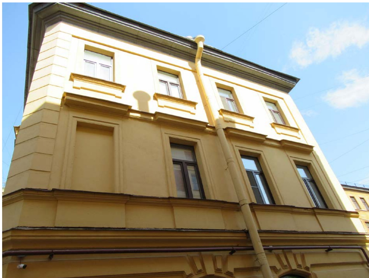
26. 12-я линия В.О., 25; Средний пр. В.О., 48, лит.Б. Флигель, входящий в состав ОКН «Дома В.Н. фон Дервиз». Юго-западный фасад в уровне 2-3 этажей.
