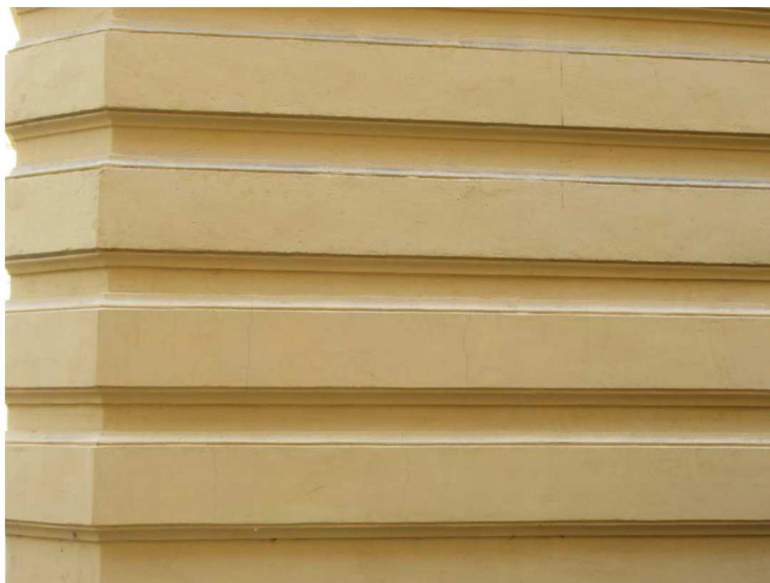
25. 12-я линия В.О., 25; Средний пр. В.О., 48, лит.Б. Флигель, входящий в состав ОКН «Дома В.Н. фон Дервиз». Фрагмент штукатурной отделки юго-западного фасада в уровне 1-го этажа.
