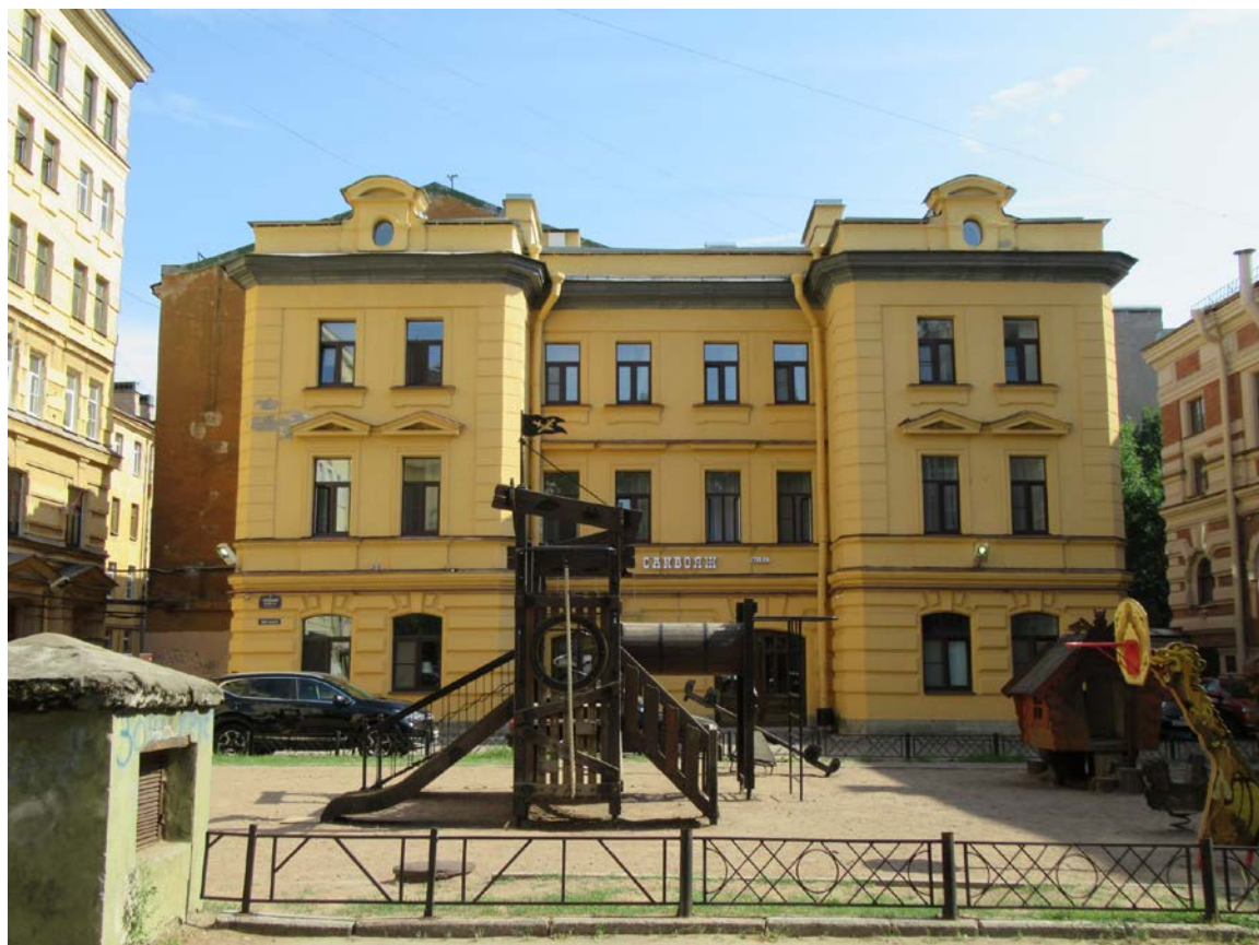
3. 12-я линия В.О., 25; Средний пр. В.О., 48, лит.Б. Флигель, входящий в состав ОКН «Дома В.Н. фон Дервиз». Вид на северо-западный (лицевой) фасад.
