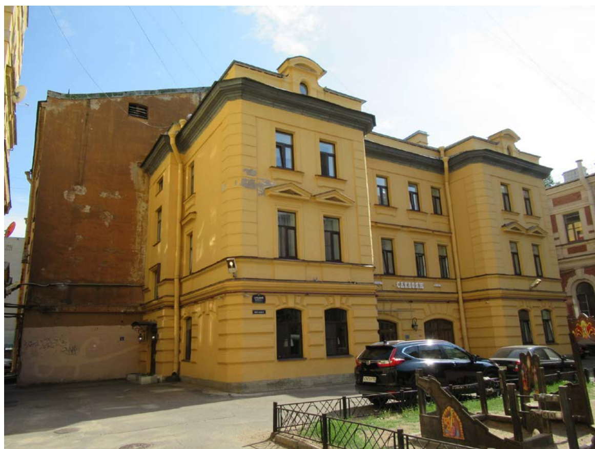
4. 12-я линия В.О., 25; Средний пр. В.О., 48, лит.Б. Флигель, входящий в состав ОКН «Дома В.Н. фон Дервиз». Общий вид на здание с северо-востока.
