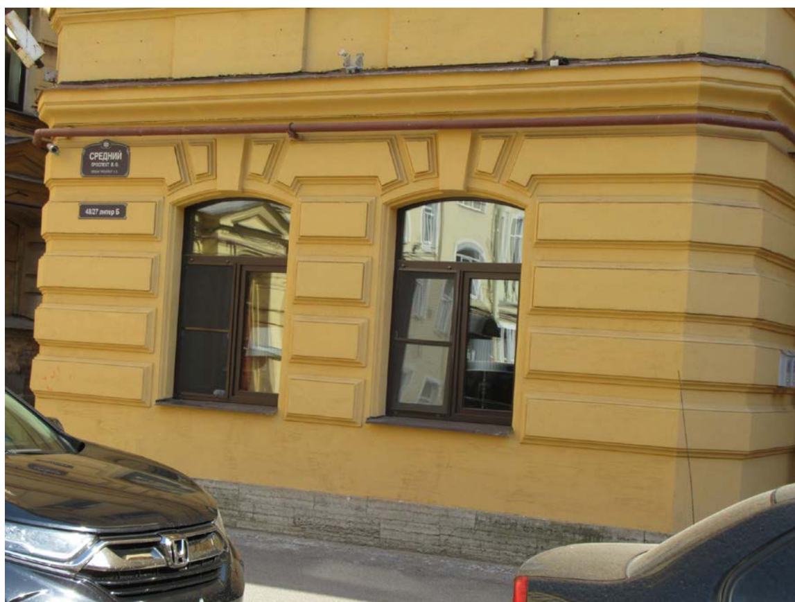
12. 12-я линия В.О., 25; Средний пр. В.О., 48, лит.Б. Флигель, входящий в состав ОКН «Дома В.Н. фон Дервиз». Восточный ризалит лицевого фасада в уровне 1-го этажа.
