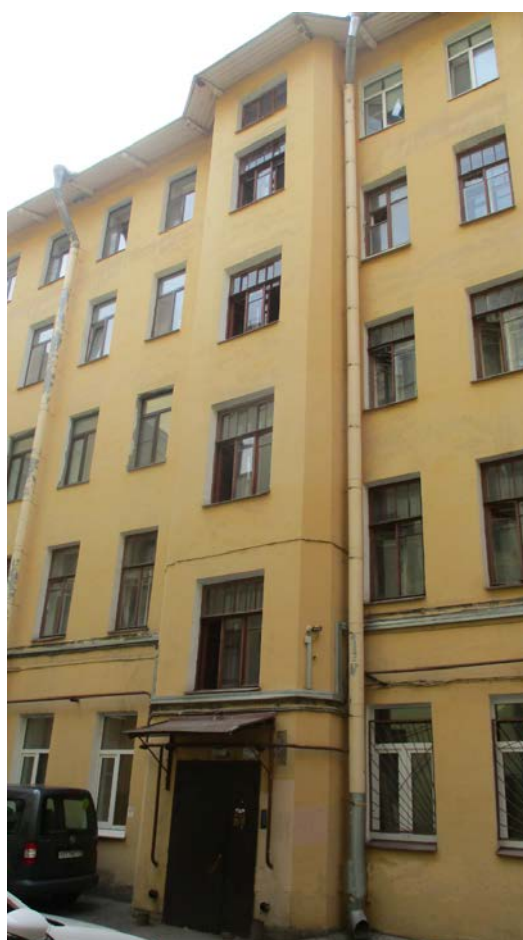
18. Санкт-Петербург. 11 линия, д.48. Фрагмент фасада северного флигеля.
