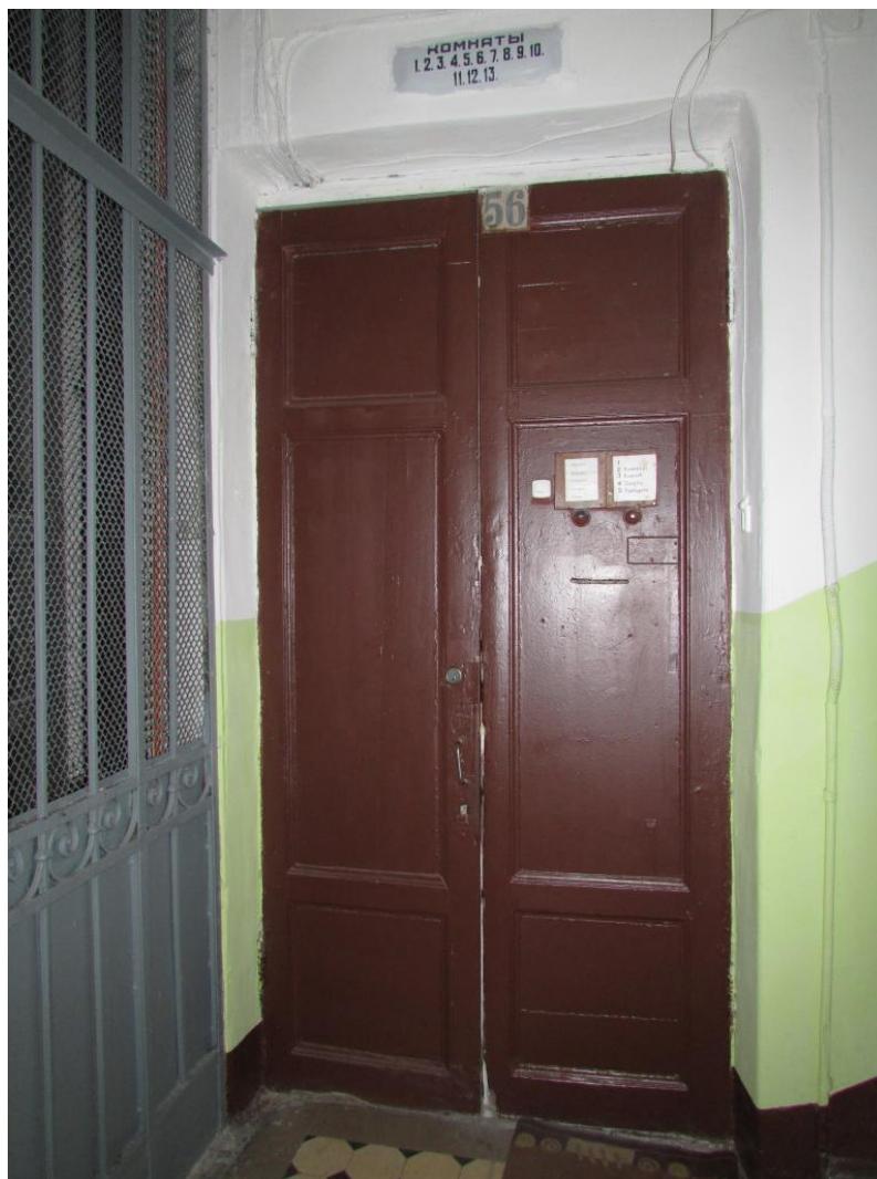
6. г. Санкт-Петербург, 11-я линия, В.О.д.48. Лестница Лк-1
