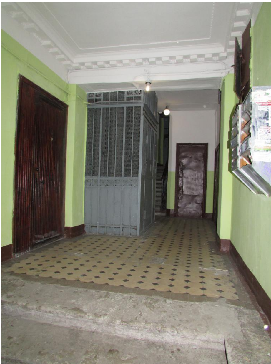
3. г. Санкт-Петербург, 11-я линия, В.О.д.48 Вестибюль лестницы Лк-1
