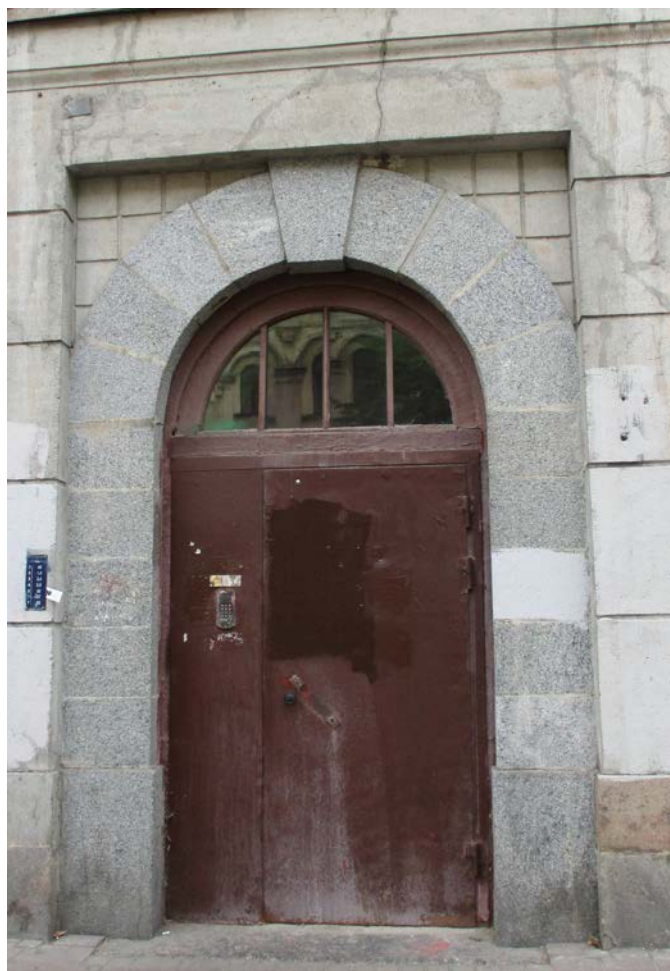
11. Санкт-Петербург. 11 линия, д.48. Фрагмент лицевого фасада. Портал дверного проема лестничной клетки Лк-1...
