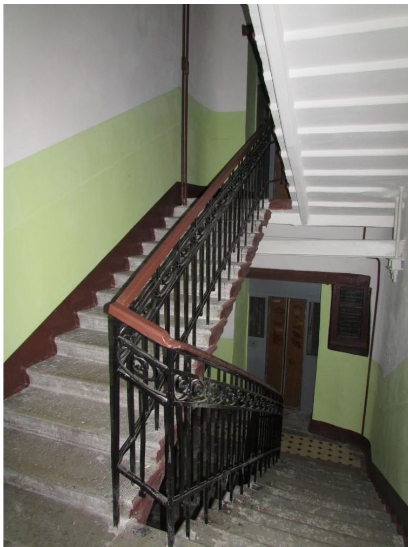
5. г. Санкт-Петербург, 11-я линия, В.О.д.48. Лестница Лк-1
