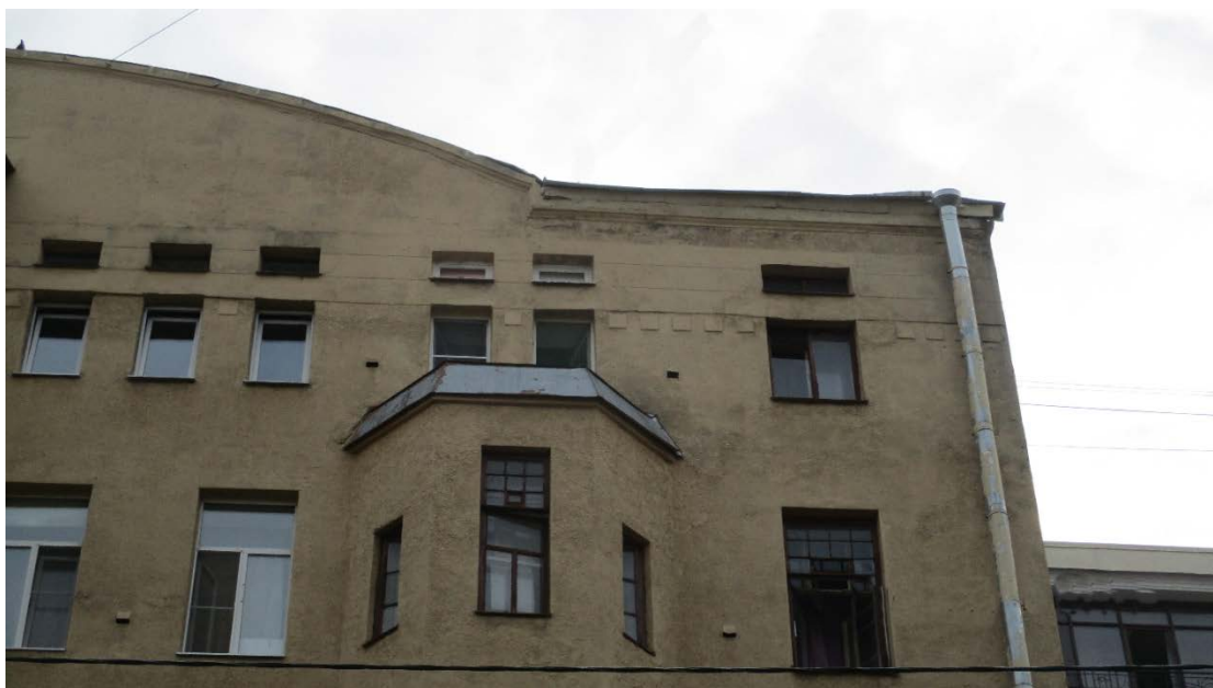
5. Санкт-Петербург. 11 линия, д.48. Фрагмент лицевого фасада.
