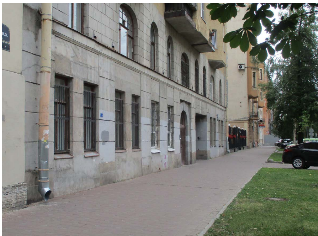
4. Санкт-Петербург. 11 линия, д.48. Фрагмент лицевого фасада.
