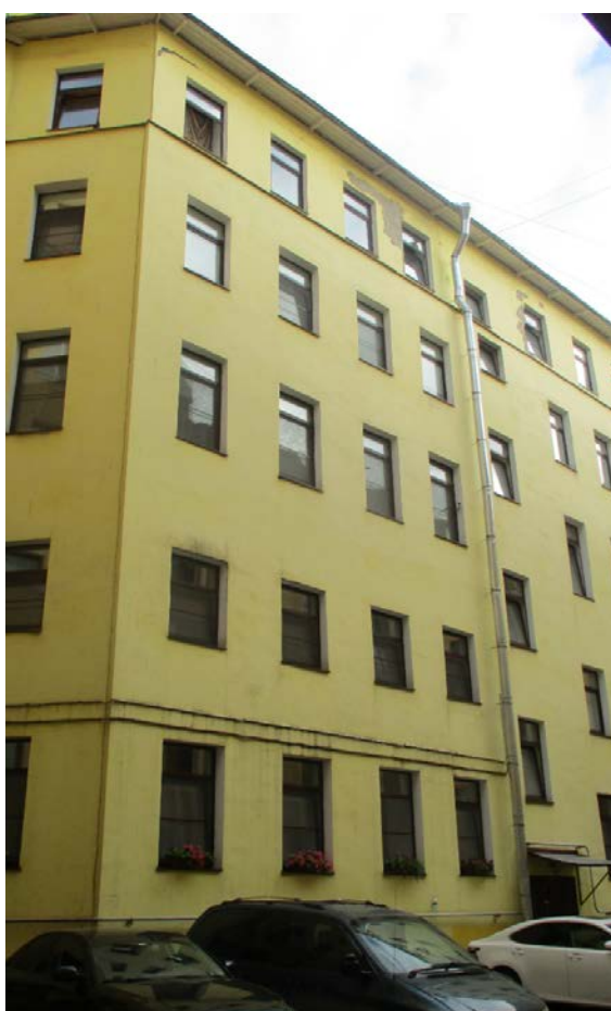
16. Санкт-Петербург. 11 линия, д.48. Фрагмент фасада южного флигеля.
