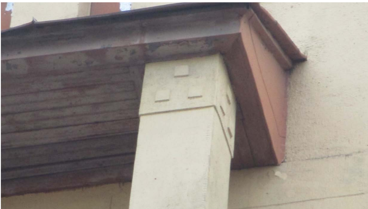
7. Санкт-Петербург. 11 линия, д.48. Фрагмент лицевого фасада.
