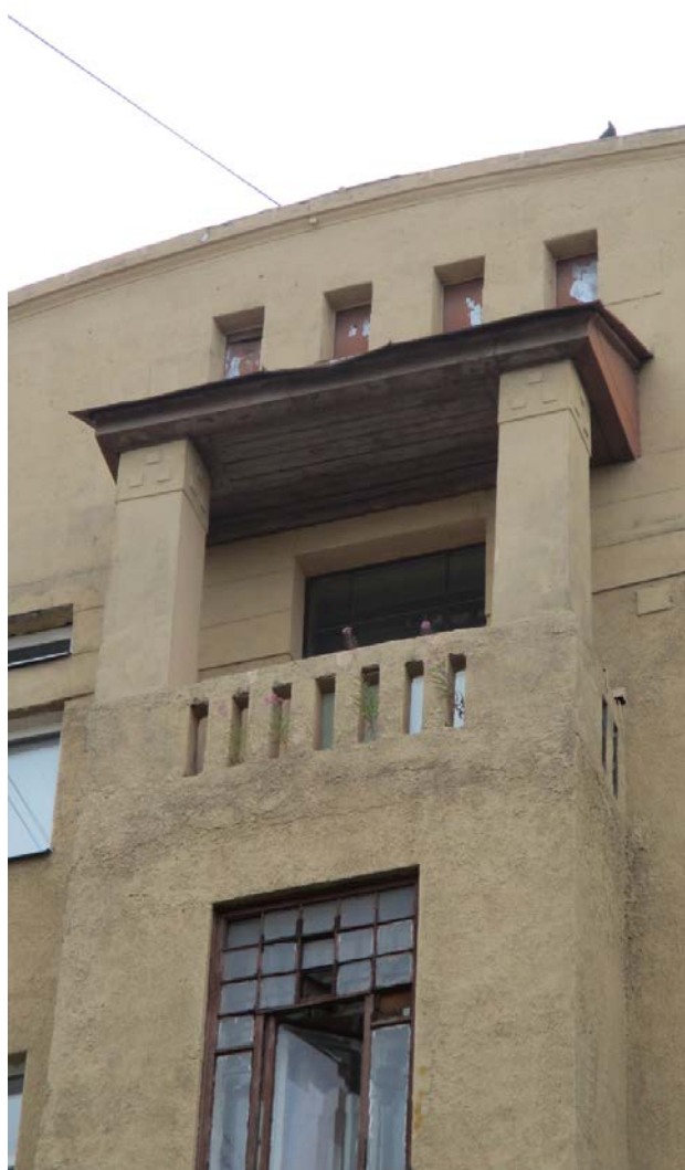
6. Санкт-Петербург. 11 линия, д.48. Фрагмент лицевого фасада.
