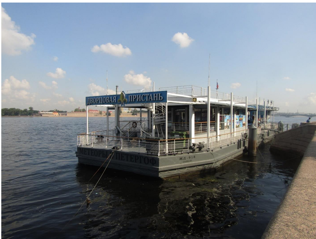
Фото 4. Вид на юго-западную часть дебаркадера.
