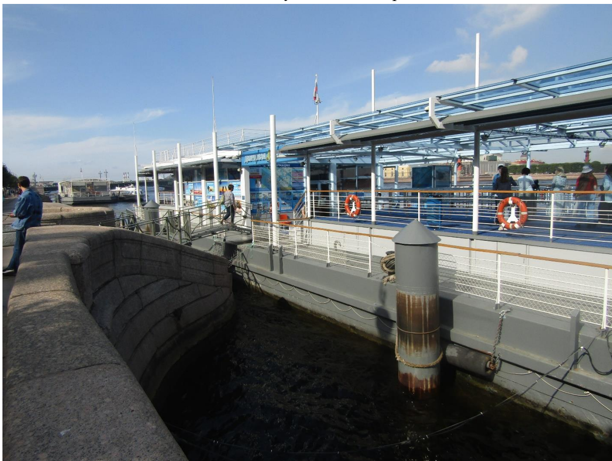
Фото 15. Вид на северо-восточный швартовно-отбойный бал.
