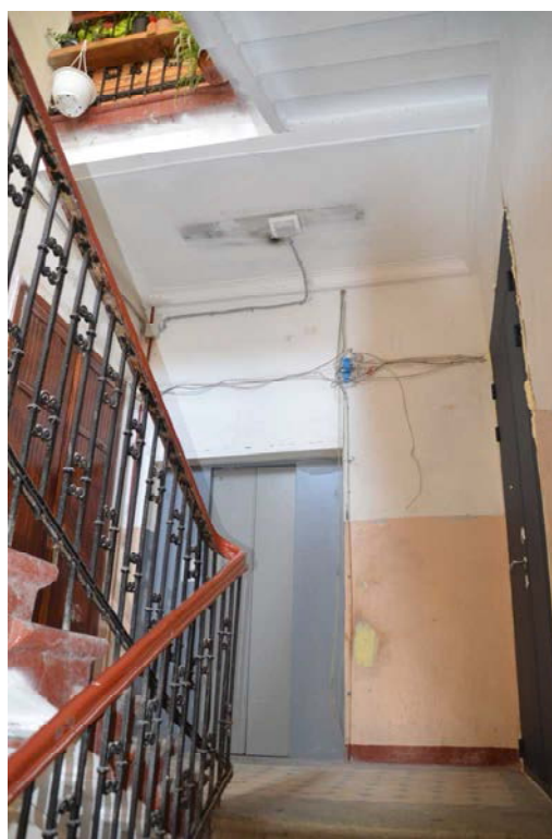
Фото 32. Выявленный объект культурного наследия «Дом Сидоровых», расположенный по адресу Санкт-Петербург, Съезжинская ул., д. 22, литера А. Вид лестницы дворового корпуса. Съемка 26.04.2021. Егорова Т. Г.
