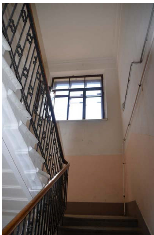
Фото 21. Выявленный объект культурного наследия «Дом Сидоровых», расположенный по адресу Санкт-Петербург, Сызжинская ул., д. 22, литера А. Вид парадной лестницы лицевого корпуса. Съемка 26.04.2021. Егорова Т. Г.
