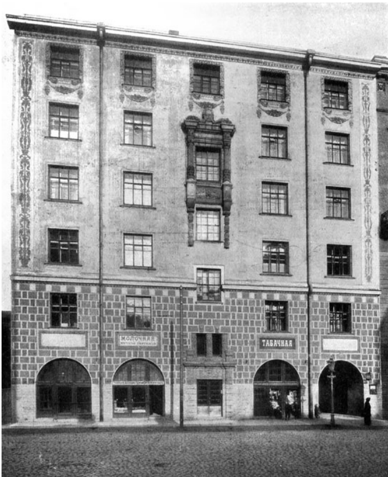
Илл. 28. Лицевой фасад дома Сидоровых, после 1913 г. Источник: Ежегодник Императорского общества архитекторов-художников. 1915. Вып. 10. С. 102.
