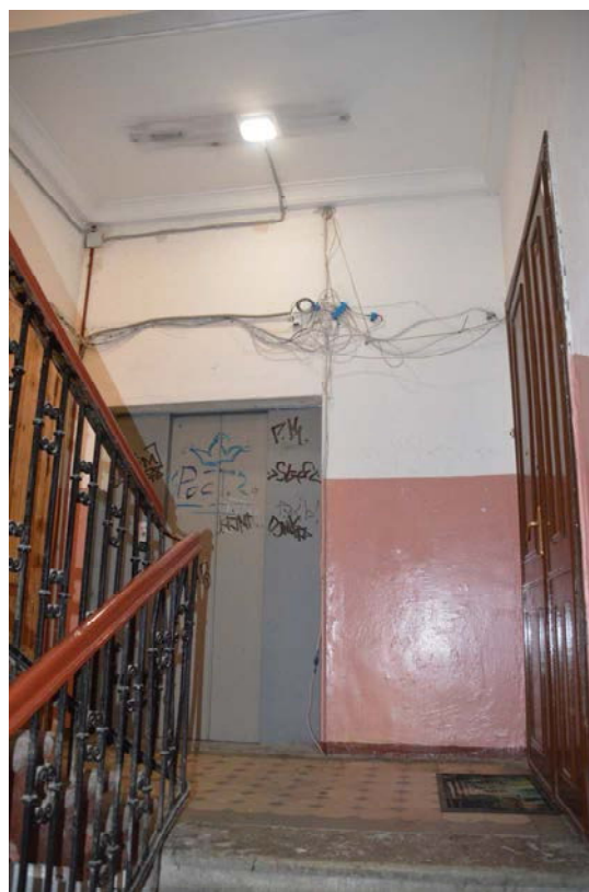
Фото 26. Выявленный объект культурного наследия «Дом Сидоровых», расположенный по адресу Санкт-Петербург, Съезжинская ул., д. 22, литера А. Вид лестницы дворового корпуса. Съемка 26.04.2021. Егорова Т. Г.
