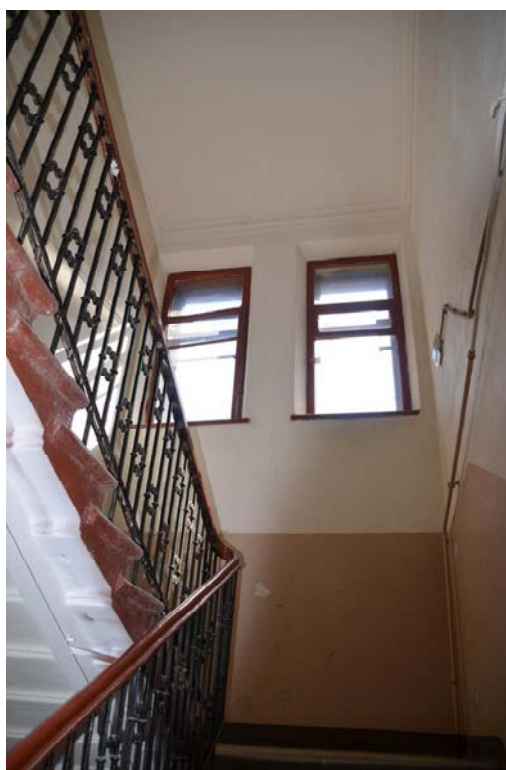
Фото 33. Выявленный объект культурного наследия «Дом Сидоровых», расположенный по адресу Санкт-Петербург, Съезжинская ул., д. 22, литера А. Вид лестницы дворового корпуса. Съемка 26.04.2021. Егорова Т. Г.
