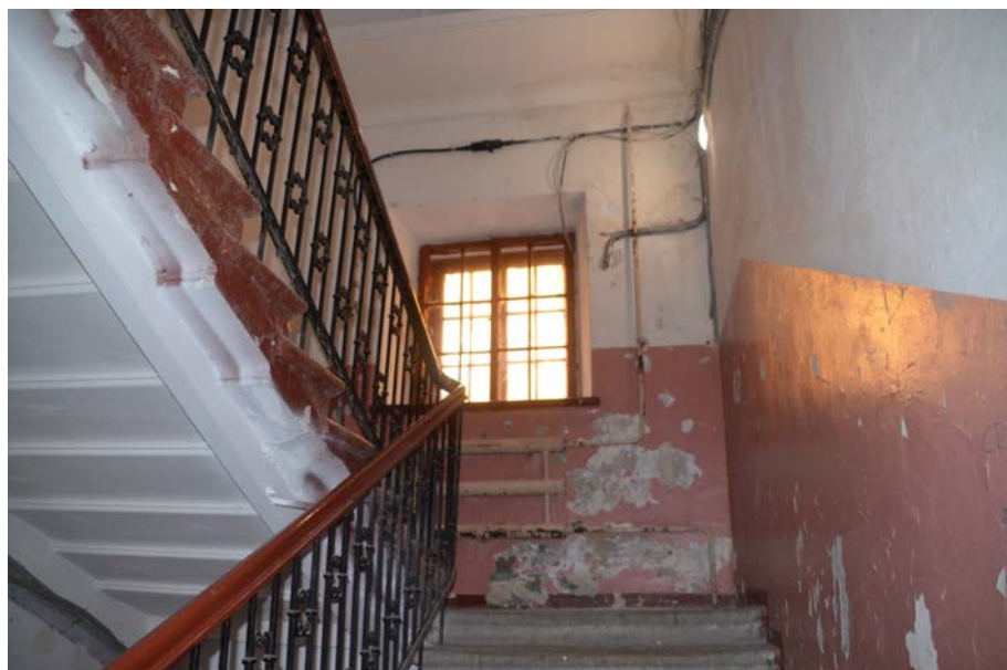
Фото 25. Выявленный объект культурного наследия «Дом Сидоровых», расположенный по адресу Санкт-Петербург, Съезжинская ул., д. 22, литера А. Вид лестницы дворового корпуса. Съемка 26.04.2021. Егорова Т. Г.
