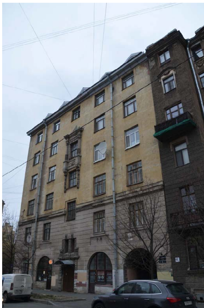
Фото 03. Выявленный объект культурного наследия «Дом Сидоровых», расположенный по адресу Санкт-Петербург, Съезжинская ул., д. 22, литера А. Общий вид южного фасада. Съемка 26.04.2021. Егорова Т. Г.
