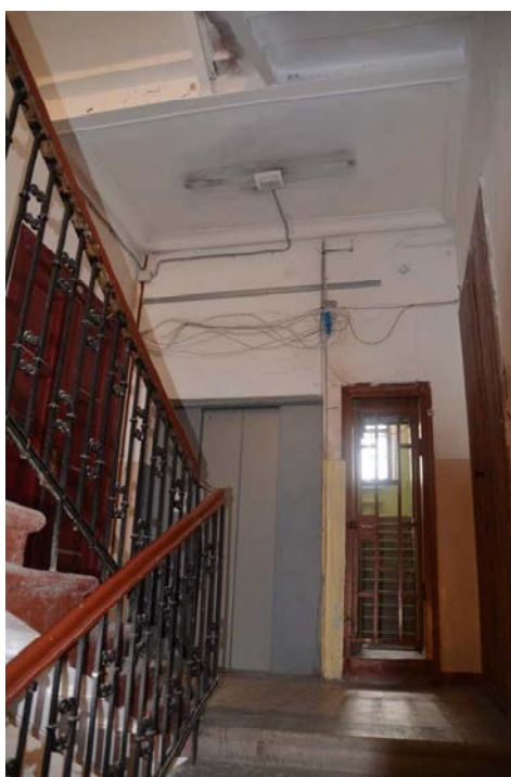
Фото 30. Выявленный объект культурного наследия «Дом Сидоровых», расположенный по адресу Санкт-Петербург, Съезжинская ул., д. 22, литера А. Вид лестницы дворового корпуса. Съемка 26.04.2021. Егорова Т. Г.
