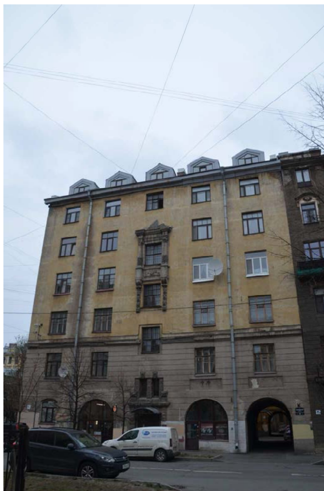
Фото 01. Выявленный объект культурного наследия «Дом Сидоровых», расположенный по адресу Санкт-Петербург, Съезжинская ул., д. 22, литера А. Общий вид южного фасада. Съемка 26.04.2021. Егорова Т. Г.
