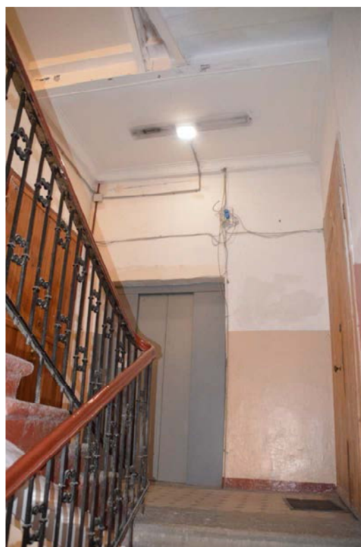
Фото 28. Выявленный объект культурного наследия «Дом Сидоровых», расположенный по адресу Санкт-Петербург, Съезжинская ул., д. 22, литера А. Вид лестницы дворового корпуса. Съемка 26.04.2021. Егорова Т. Г.
