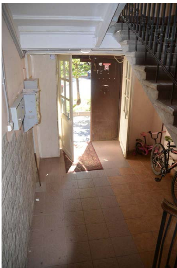
Фото 12. Выявленный объект культурного наследия «Дом Сидоровых», расположенный по адресу Санкт-Петербург, Сызжинская ул., д. 22, литера А. Вестибюль парадной лестницы лицевого корпуса. Съемка 26.04.2021. Егорова Т. Г.
