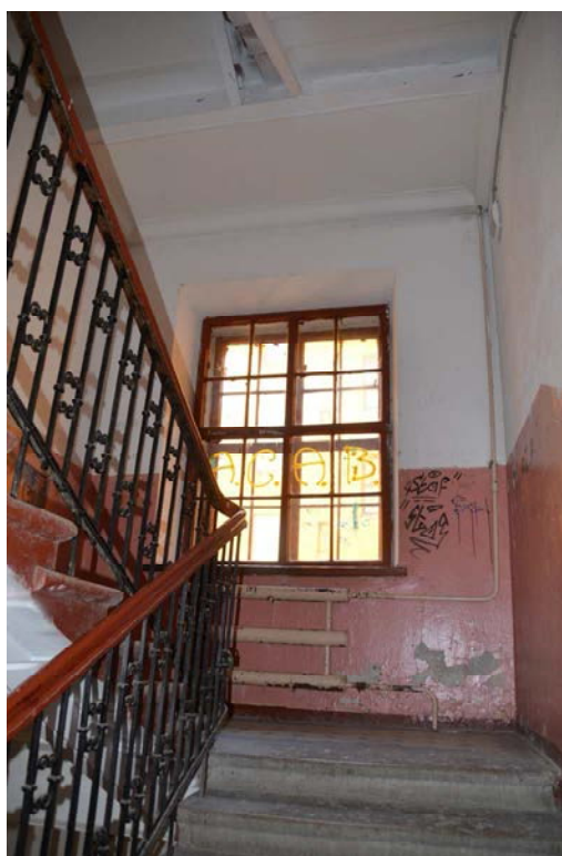
Фото 27. Выявленный объект культурного наследия «Дом Сидоровых», расположенный по адресу Санкт-Петербург, Съезжинская ул., д. 22, литера А. Вид лестницы дворового корпуса. Съемка 26.04.2021. Егорова Т. Г.
