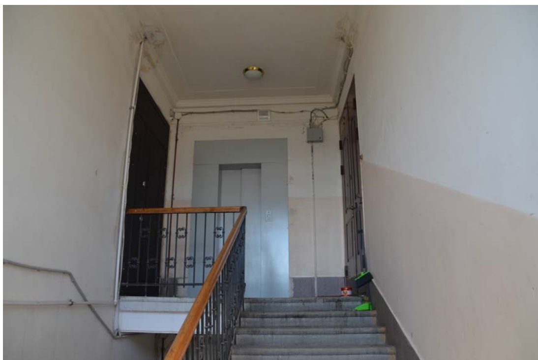
Фото 22. Выявленный объект культурного наследия «Дом Сидоровых», расположенный по адресу Санкт-Петербург, Съезжинская ул., д. 22, литера А. Вид парадной лестницы лицевого корпуса. Съемка 26.04.2021. Егорова Т. Г.
