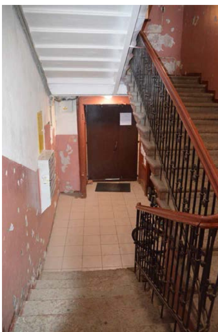
Фото 24. Выявленный объект культурного наследия «Дом Сидоровых», расположенный по адресу Санкт-Петербург, Съезжинская ул., д. 22, литера А. Вид вестибюля лестницы дворового корпуса. Съемка 26.04.2021. Егорова Т. Г.
