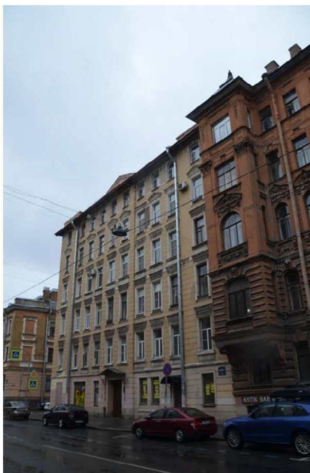
Фото 02. Выявленный объект культурного наследия «Дом И. С. Мальцева», расположенный по адресу Санкт-Петербург, Басков пер., 41/29, литера А (Басков пер., 41, ул. Радищева, 29). Общий вид западного фасада. Съемка 26.04.2021. Егорова Т. Г.
