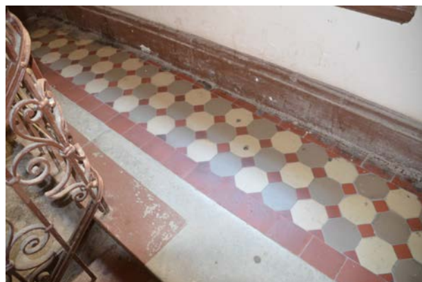
Фото 10. Выявленный объект культурного наследия «Дом И. С. Мальцева», расположенный по адресу Санкт-Петербург, Басков пер., 41/29, литера А (Басков пер., 41, ул. Радищева, 29). Напольное покрытие части вестибюля и лестничных площадок парадной лестницы по Баскову переулку. Съемка 26.04.2021. Егорова Т. Г.
