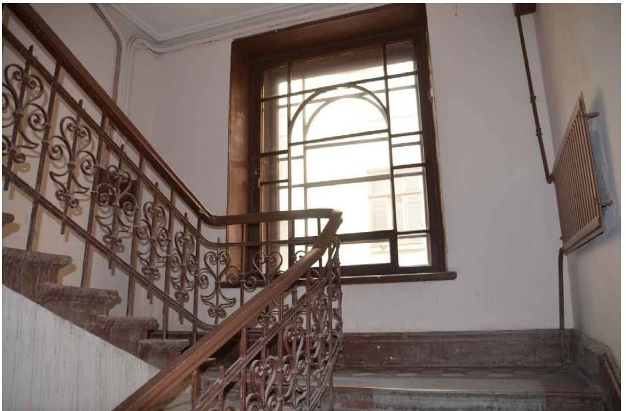
Фото 12. Выявленный объект культурного наследия «Дом И. С. Мальцева», расположенный по адресу Санкт-Петербург, Басков пер., 41/29, литера А (Басков пер., 41, ул. Радищева, 29). Вид парадной лестницы по Баскову переулку. Съемка 26.04.2021. Егорова Т. Г.
