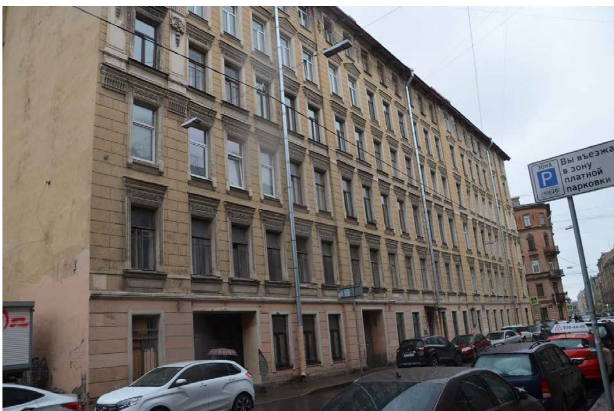
Фото 03. Выявленный объект культурного наследия «Дом И. С. Малышева», расположенный по адресу Санкт-Петербург, Басков пер., 41/29, литера А (Басков пер., 41, ул. Радищева, 29). Общий вид северного фасада. Съемка 26.04.2021. Егорова Т. Г.
