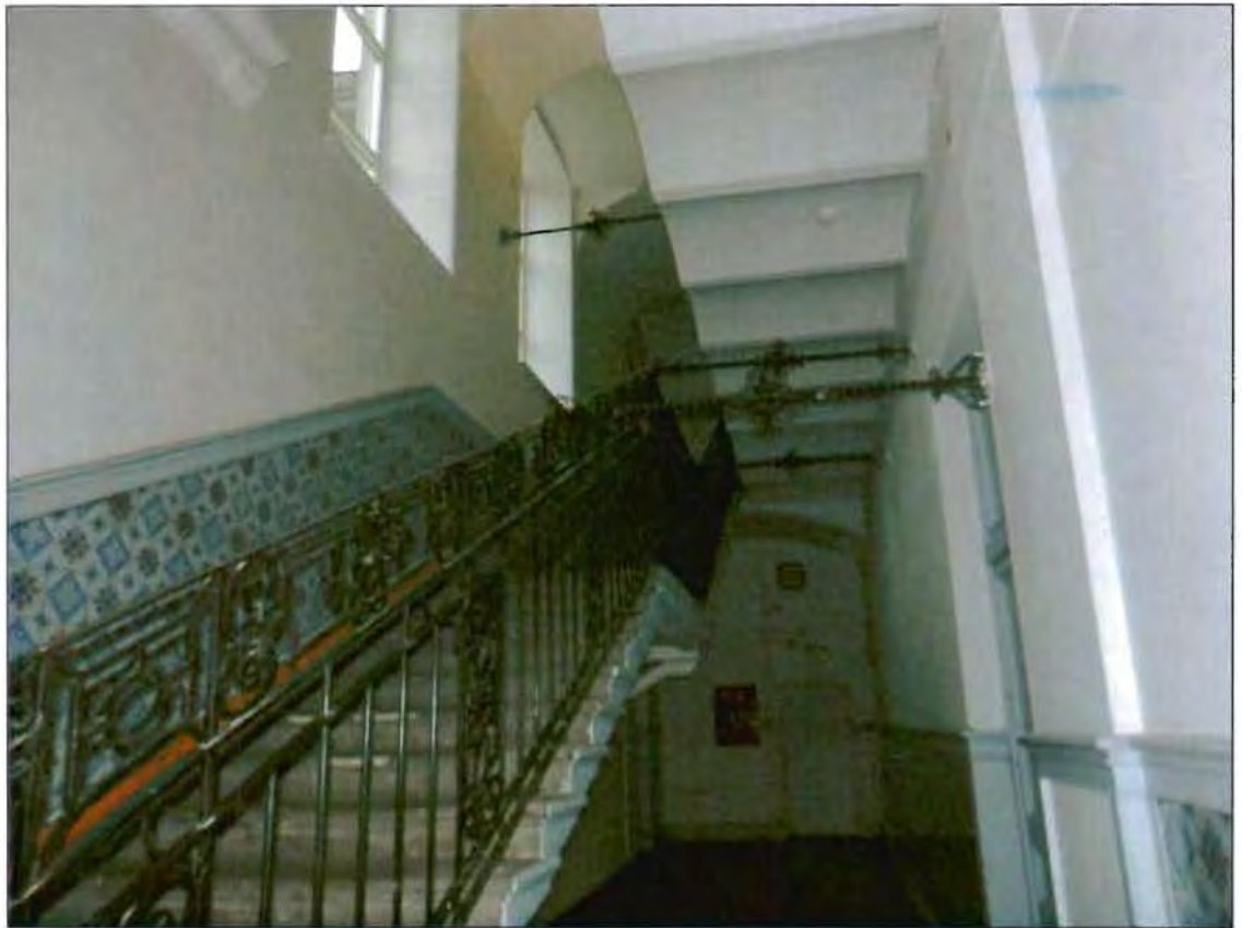
38. Лестница помещения № 1-Н (155). Общий вид.
