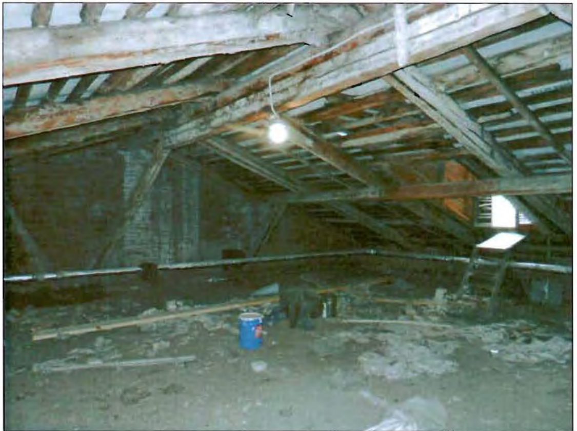
35. Стропильная система. Общий вид.
