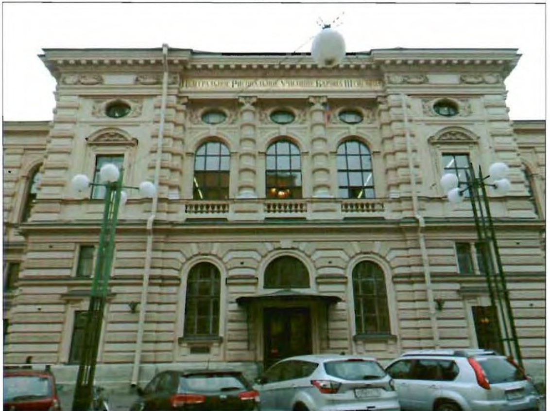
29. Лицевой фасад. Центральный ризалит.
