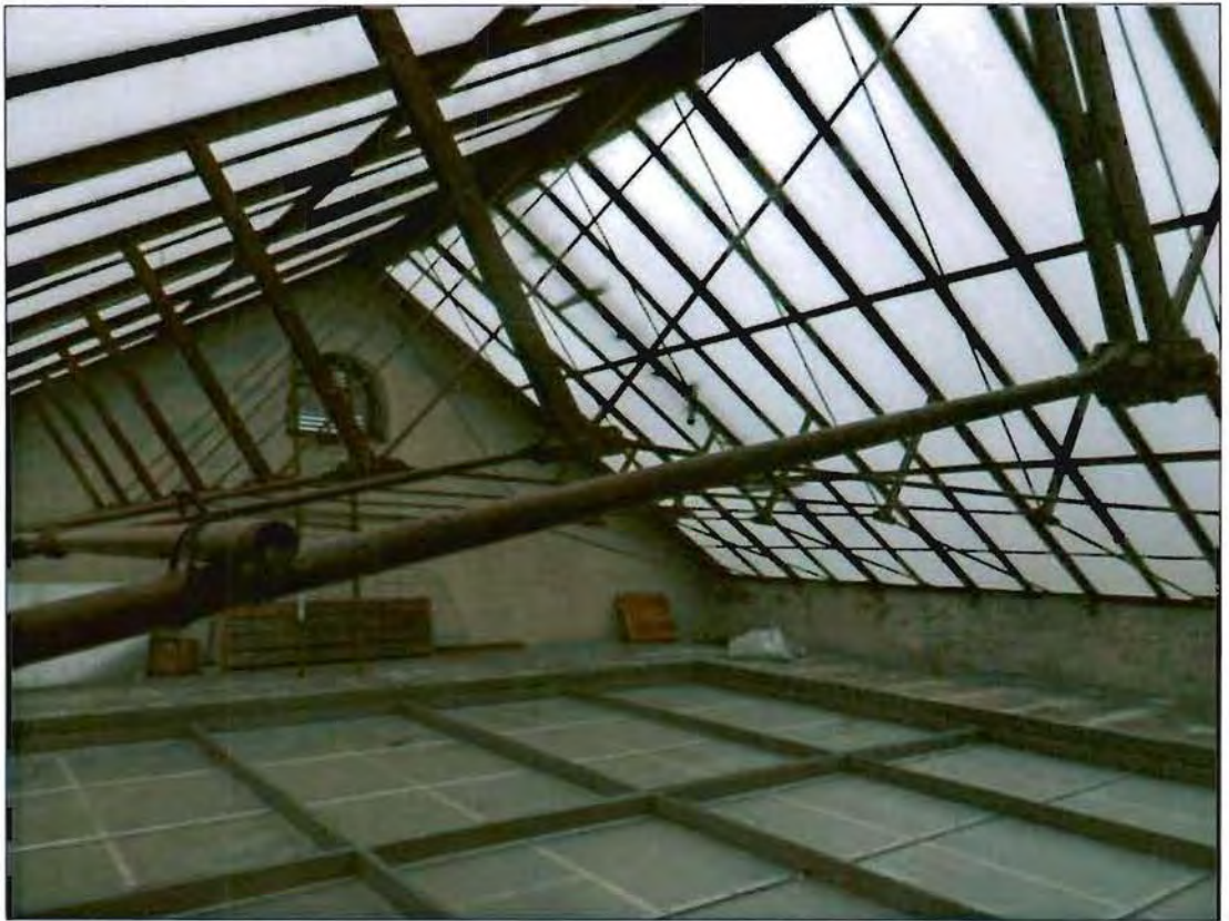
36. Металлические фермы над световым фонарем парадной лестницы.
