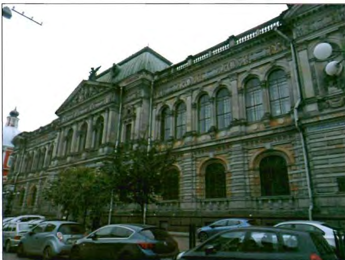
1. Общий вид с северо-востока.
