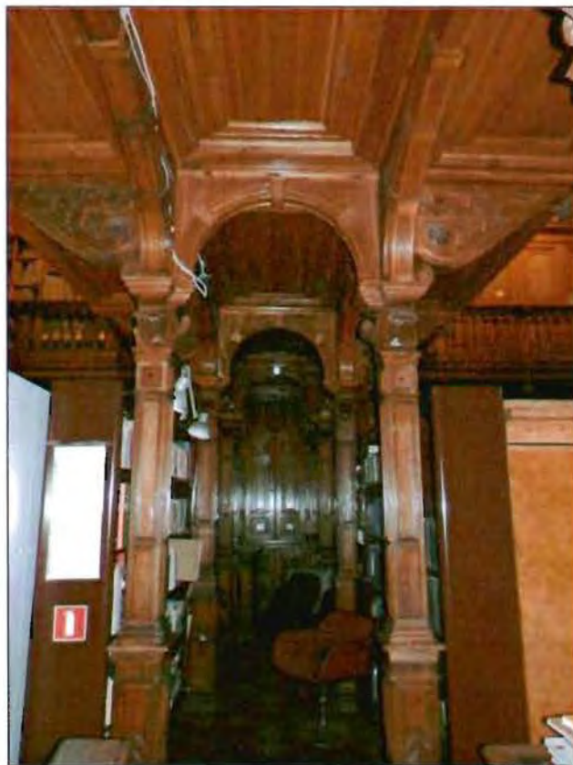
39. Помещение № 1-Н (271). Деревянные колонны.
