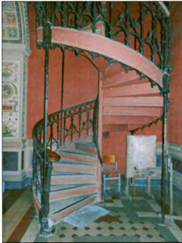
18. Помещение № 1-Н (285). Лестница.
