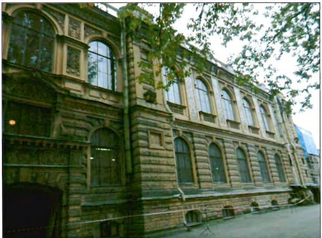
7. Северный дворовый фасад. Общий вид.
