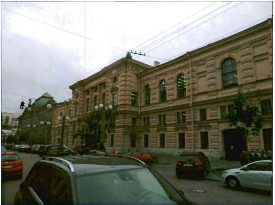
28. Лицевой фасад. Общий вид.
