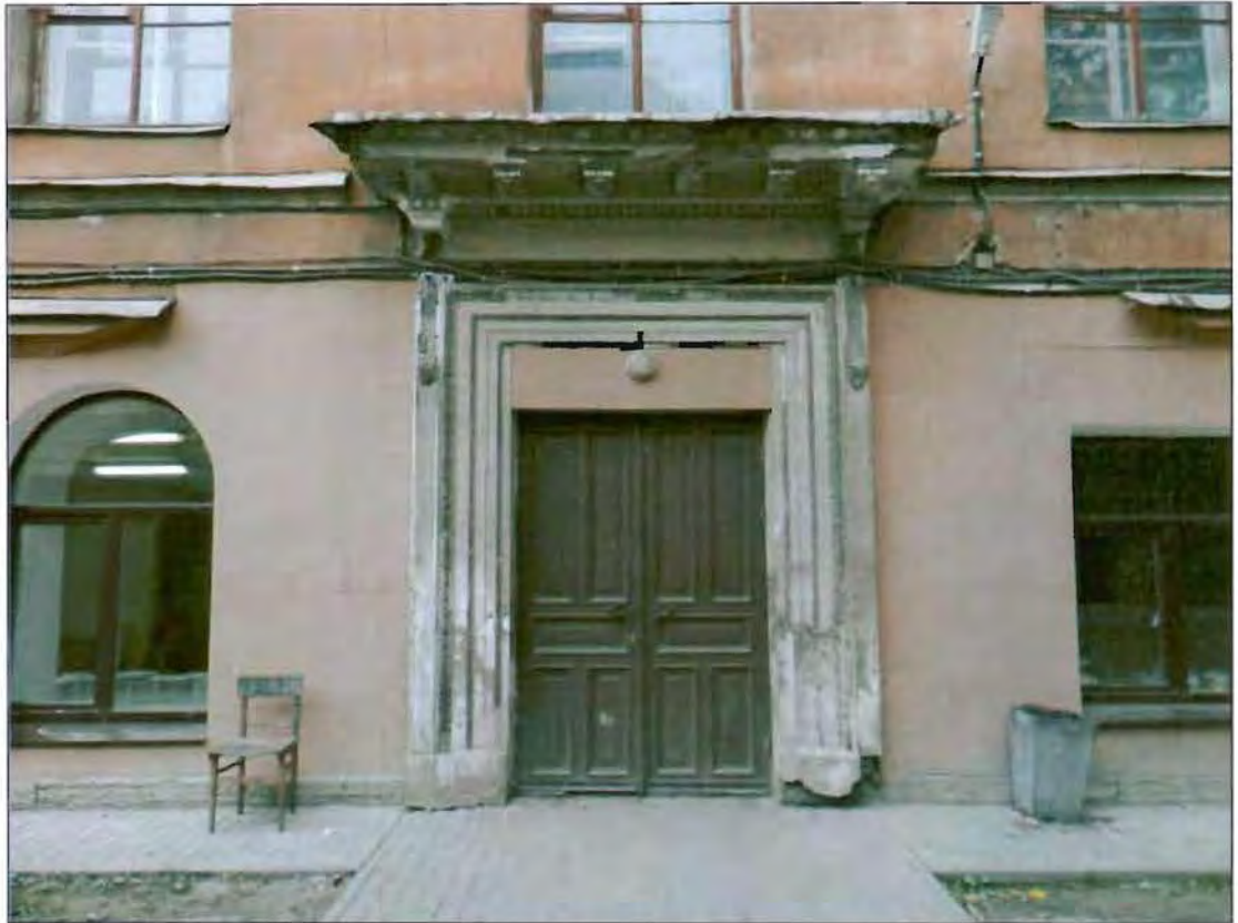
32. Южный дворовый фасад. Фрагмент.
