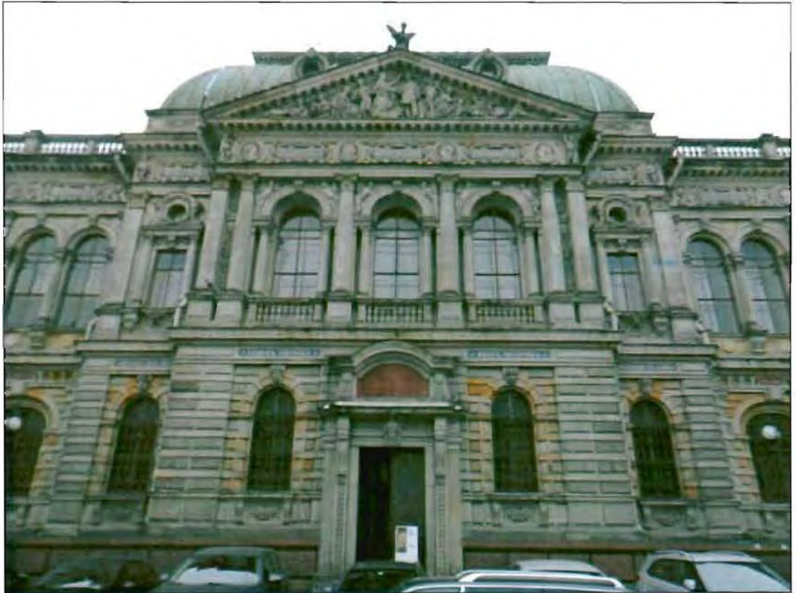
2. Лицевой фасад. Центральный ризалит.
