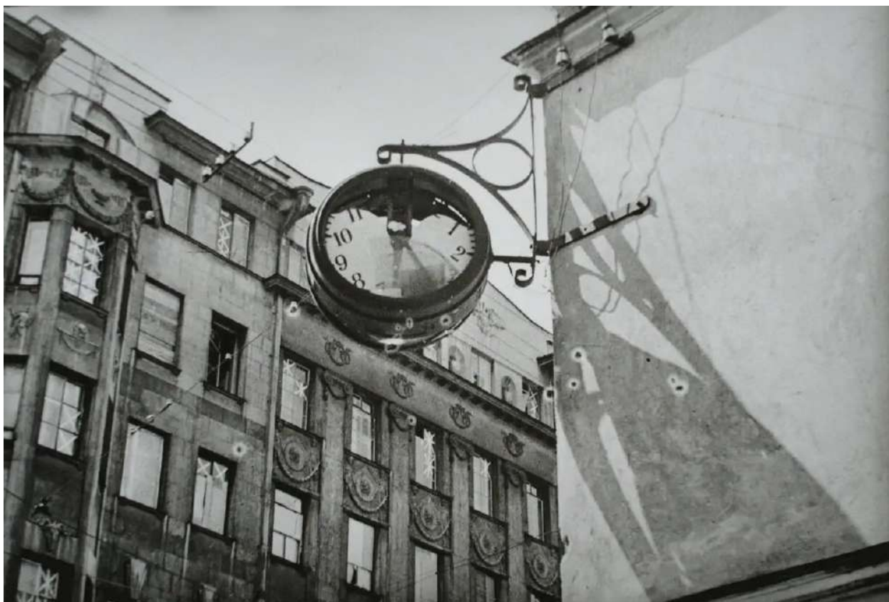
Илл. 37. Вид на часть северного фасада дома Ш. 3. Иофа со стороны Литейного пр., 1941–1944 гг. Источник: www.pastvu.com
