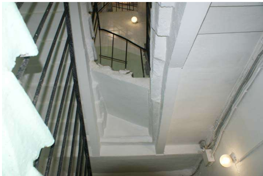
Фото 92. Выявленный объект культурного наследия «Дом Ш. З. Иофа», расположенный по адресу Санкт-Петербург, ул. Белинского, д. 13, Литейный пр., д. 47. Вид конструкции лестницы № 3 (со стороны двора). Съемка 26.04.2021. Егорова Т. Г.
