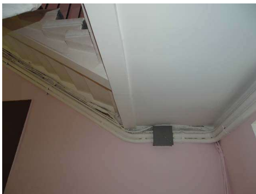
Фото 72. Выявленный объект культурного наследия «Дом Ш. З. Иофа», расположенный по адресу Санкт-Петербург, ул. Белинского, д. 13, Литейный пр., д. 47. Вид конструкции лестницы № 4 (со стороны двора). Съемка 26.04.2021. Егорова Т. Г.
