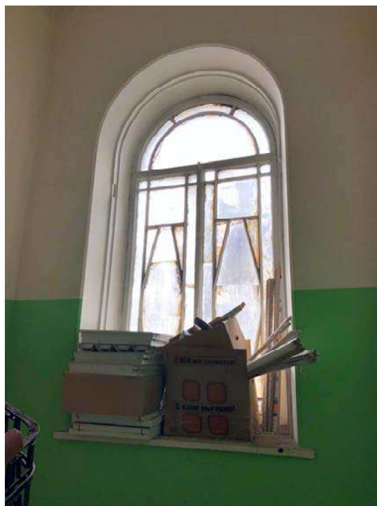
Фото 26. Выявленный объект культурного наследия «Дом Ш. З. Иофа», расположенный по адресу Санкт-Петербург, ул. Белинского, д. 13, Литейный пр., д. 47. Историческое оконное заполнение окон черной лестницы. Съемка 26.04.2021. Егорова Т. Г
