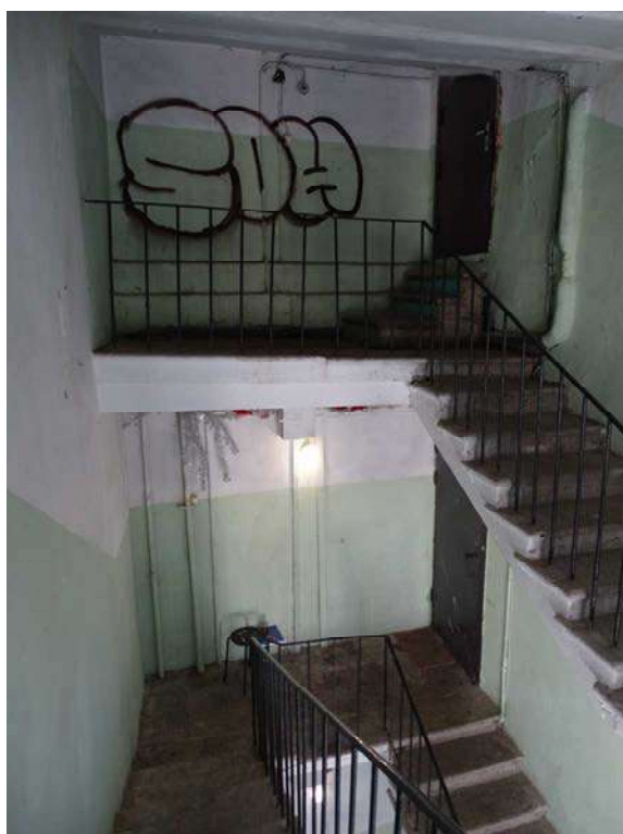
Фото 88. Выявленный объект культурного наследия «Дом Ш. З. Иофа», расположенный по адресу Санкт-Петербург, ул. Белинского, д. 13, Литейный пр., д. 47. Вид лестницы № 3 (со стороны двора). Съемка 26.04.2021. Егорова Т. Г.
