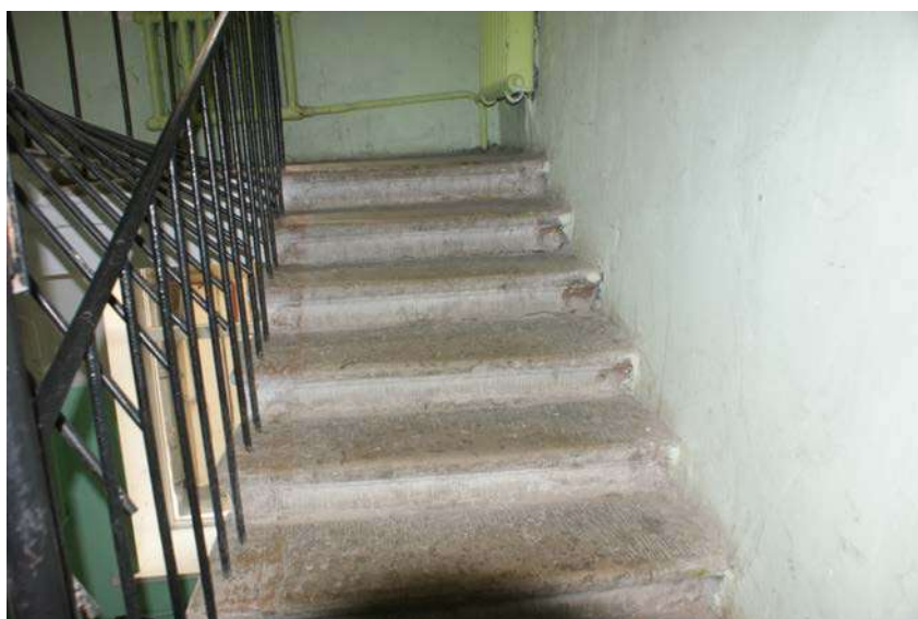
Фото 80. Выявленный объект культурного наследия «Дом Ш. З. Иофа», расположенный по адресу Санкт-Петербург, ул. Белинского, д. 13, Литейный пр., д. 47. Вид лестницы № 3 (со стороны двора). Съемка 26.04.2021. Егорова Т. Г.
