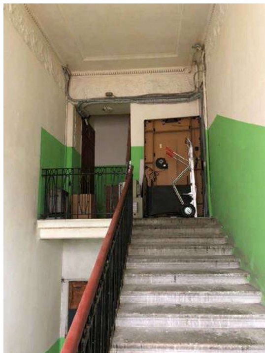
Фото 24. Выявленный объект культурного наследия «Дом Ш. З. Иофа», расположенный по адресу Санкт-Петербург, ул. Белинского, д. 13, Литейный пр., д. 47. Вид черной лестницы. Съемка 26.04.2021. Егорова Т. Г.
