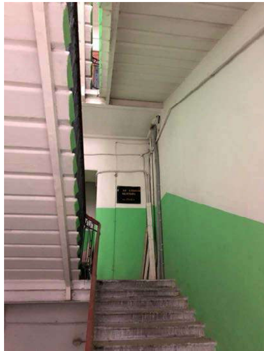
Фото 21. Выявленный объект культурного наследия «Дом Ш. З. Иофа», расположенный по адресу Санкт-Петербург, ул. Белинского, д. 13, Литейный пр., д. 47. Вид черной лестницы. Съемка 26.04.2021. Егорова Т. Г.
