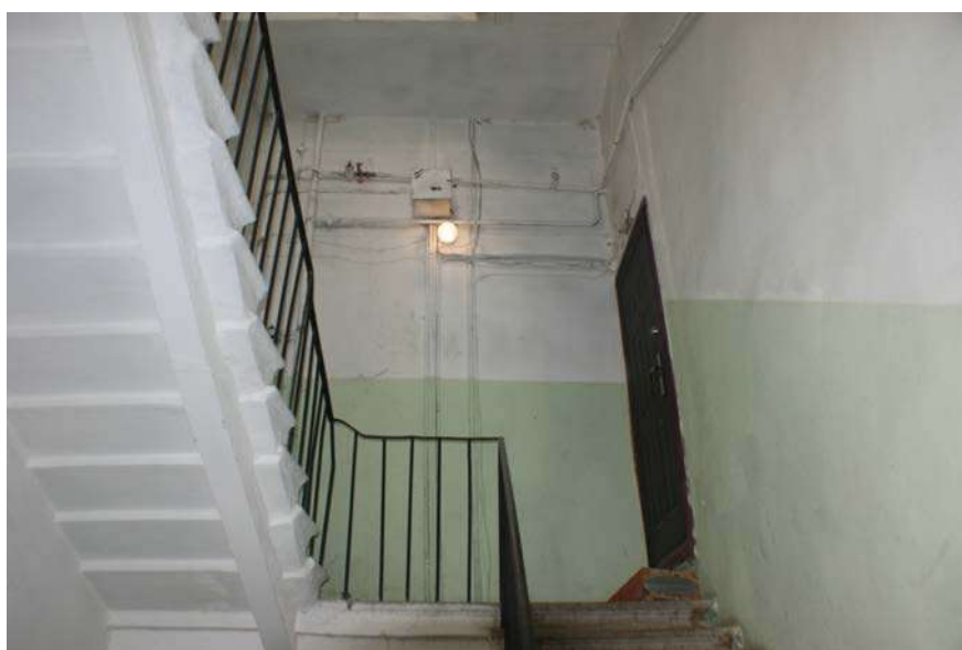
Фото 87. Выявленный объект культурного наследия «Дом Ш. З. Иофа», расположенный по адресу Санкт-Петербург, ул. Белинского, д. 13, Литейный пр., д. 47. Вид лестницы № 3 (со стороны двора). Съемка 26.04.2021. Егорова Т. Г.
