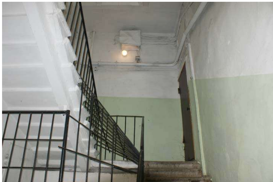
Фото 83. Выявленный объект культурного наследия «Дом Ш. З. Иофа», расположенный по адресу Санкт-Петербург, ул. Белинского, д. 13, Литейный пр., д. 47. Вид лестницы № 3 (со стороны двора). Съемка 26.04.2021. Егорова Т. Г.
