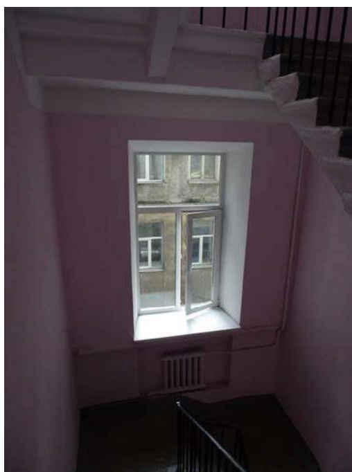
Фото 68. Выявленный объект культурного наследия «Дом Ш. З. Иофа», расположенный по адресу Санкт-Петербург, ул. Белинского, д. 13, Литейный пр., д. 47. Вид лестницы № 4 (со стороны двора). Съемка 26.04.2021. Егорова Т. Г.
