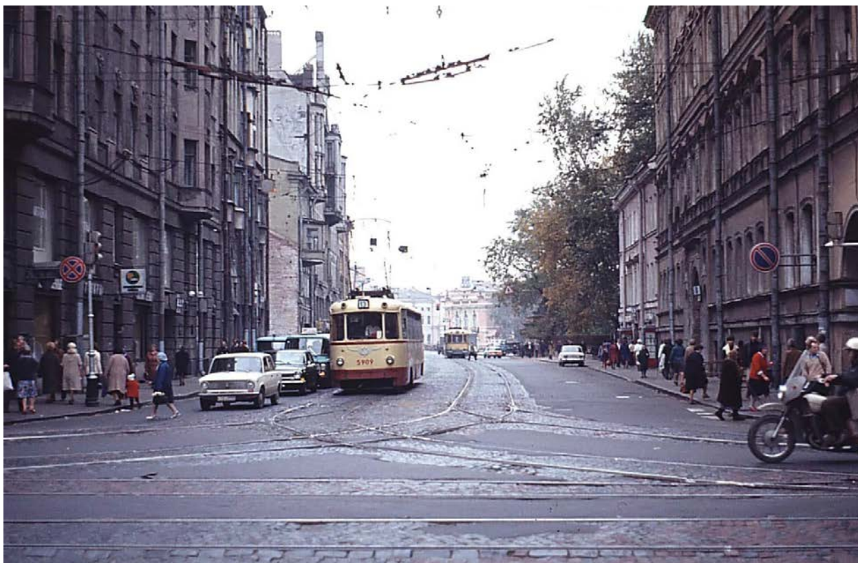
Илл. 38. Вид на часть северного фасада дома Ш. З. Иофа со стороны Литейного пр., 1982 г. Источник: www.pastvu.com
