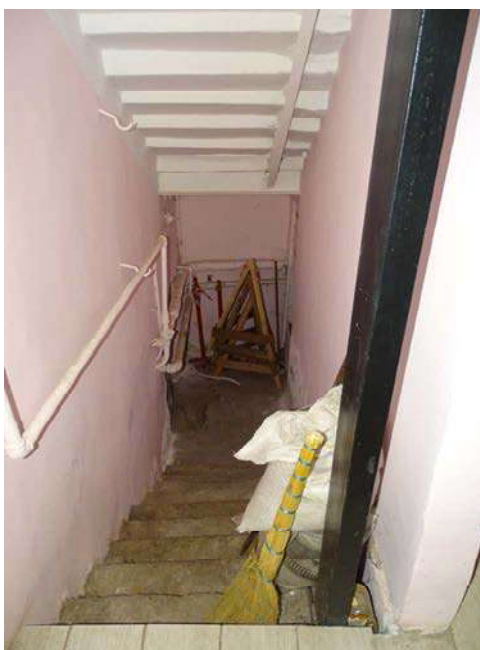
Фото 59. Выявленный объект культурного наследия «Дом Ш. З. Иофа», расположенный по адресу Санкт-Петербург, ул. Белинского, д. 13, Литейный пр., д. 47. Вид лестницы № 4 (со стороны двора). Съемка 26.04.2021. Егорова Т. Г.
