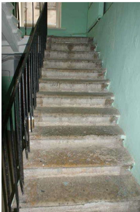
Фото 75. Выявленный объект культурного наследия «Дом Ш. З. Иофа», расположенный по адресу Санкт-Петербург, ул. Белинского, д. 13, Литейный пр., д. 47. Вид лестницы № 3 (со стороны двора). Съемка 26.04.2021. Егорова Т. Г.
