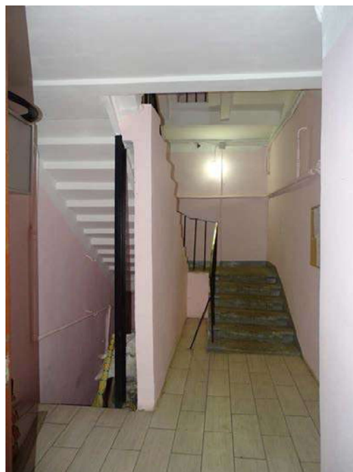
Фото 58. Выявленный объект культурного наследия «Дом Ш. З. Иофа», расположенный по адресу Санкт-Петербург, ул. Белинского, д. 13, Литейный пр., д. 47. Вид лестницы № 4 (со стороны двора). Съемка 26.04.2021. Егорова Т. Г.
