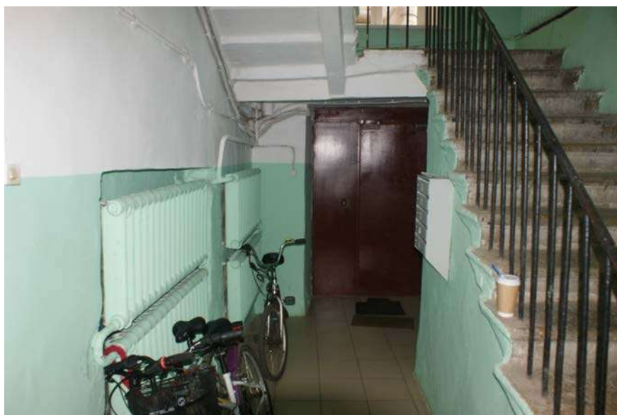
Фото 74. Выявленный объект культурного наследия «Дом Ш. З. Иофа», расположенный по адресу Санкт-Петербург, ул. Белинского, д. 13, Литейный пр., д. 47. Вид лестницы № 3 (со стороны двора). Съемка 26.04.2021. Егорова Т. Г.
