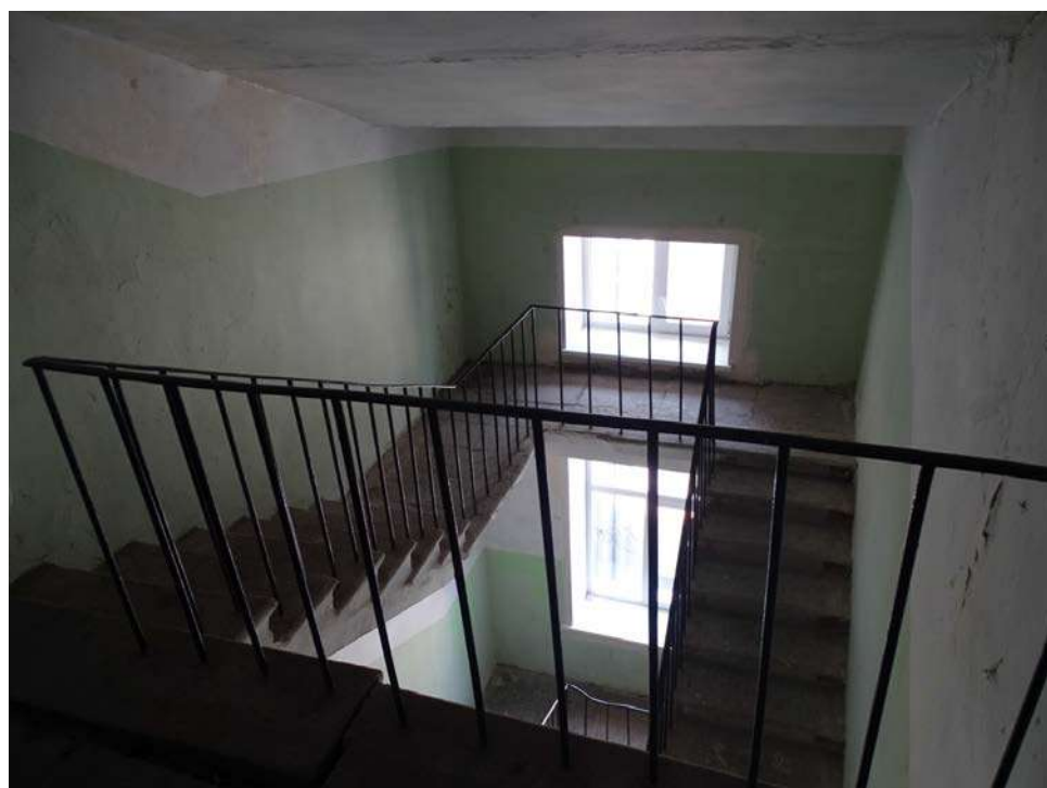
Фото 91. Выявленный объект культурного наследия «Дом Ш. З. Иофа», расположенный по адресу Санкт-Петербург, ул. Белинского, д. 13, Литейный пр., д. 47. Вид лестницы № 3 (со стороны двора). Съемка 26.04.2021. Егорова Т. Г.
