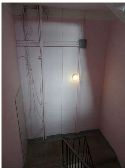
Фото 66. Выявленный объект культурного наследия «Дом Ш. З. Иофа», расположенный по адресу Санкт-Петербург, ул. Белинского, д. 13, Литейный пр., д. 47. Вид лестницы № 4 (со стороны двора). Съемка 26.04.2021. Егорова Т. Г.
