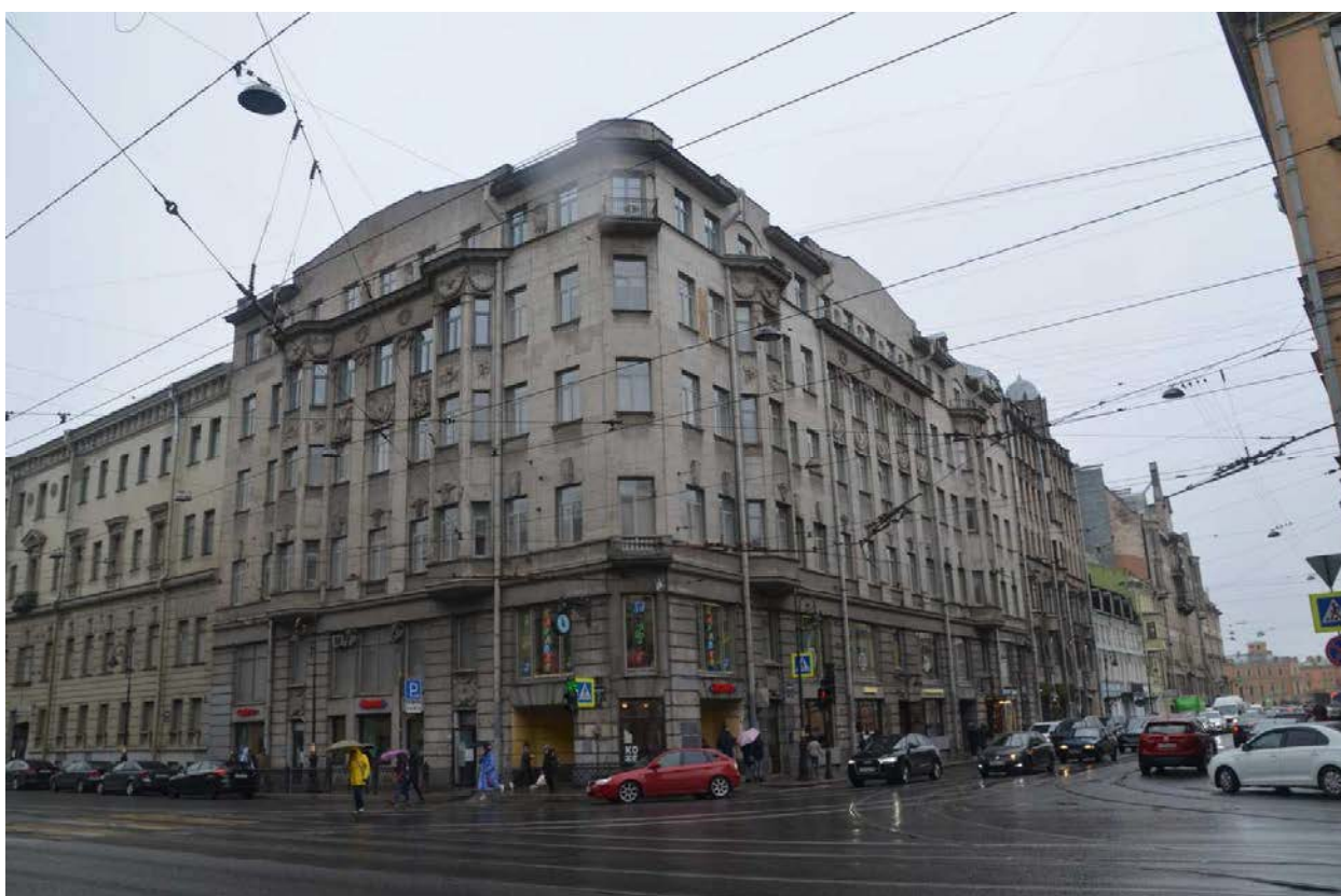
Фото 01. Выявленный объект культурного наследия «Дом Ш. З. Иофа», расположенный по адресу Санкт-Петербург, ул. Белинского, д. 13, Литейный пр., д. 47. Общий вид. Съемка 26.04.2021. Егорова Т. Г.
