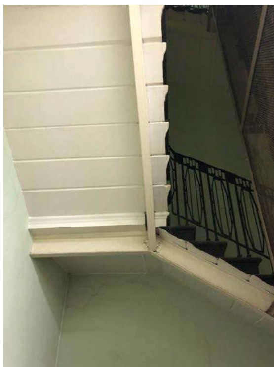
Фото 17 Выявленный объект культурного наследия «Дом Ш. З. Иофа», расположенный по адресу Санкт-Петербург, ул. Белинского, д. 13, Литейный пр., д. 47. Вид конструкции парадной лестницы. Съемка 26.04.2021. Егорова Т. Г.
