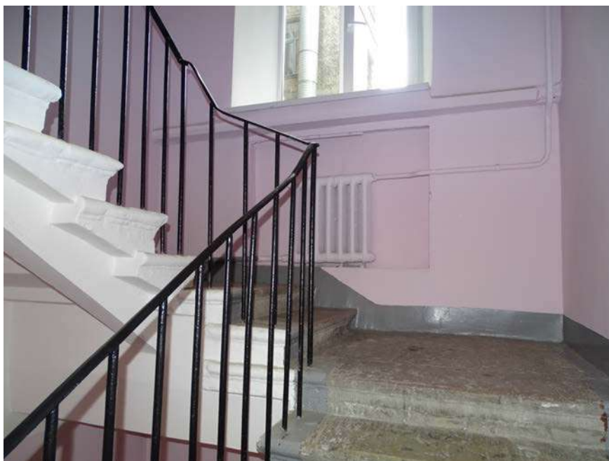
Фото 67. Выявленный объект культурного наследия «Дом Ш. З. Иофа», расположенный по адресу Санкт-Петербург, ул. Белинского, д. 13, Литейный пр., д. 47. Вид лестницы № 4 (со стороны двора). Съемка 26.04.2021. Егорова Т. Г.
