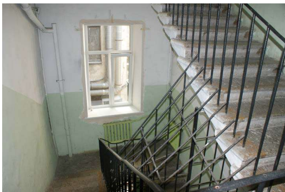
Фото 85. Выявленный объект культурного наследия «Дом Ш. З. Иофа», расположенный по адресу Санкт-Петербург, ул. Белинского, д. 13, Литейный пр., д. 47. Вид лестницы № 3 (со стороны двора). Съемка 26.04.2021. Егорова Т. Г.
