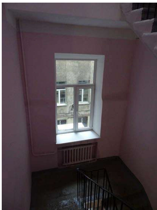
Фото 65. Выявленный объект культурного наследия «Дом Ш. З. Иофа», расположенный по адресу Санкт-Петербург, ул. Белинского, д. 13, Литейный пр., д. 47. Вид лестницы № 4 (со стороны двора). Съемка 26.04.2021. Егорова Т. Г.
