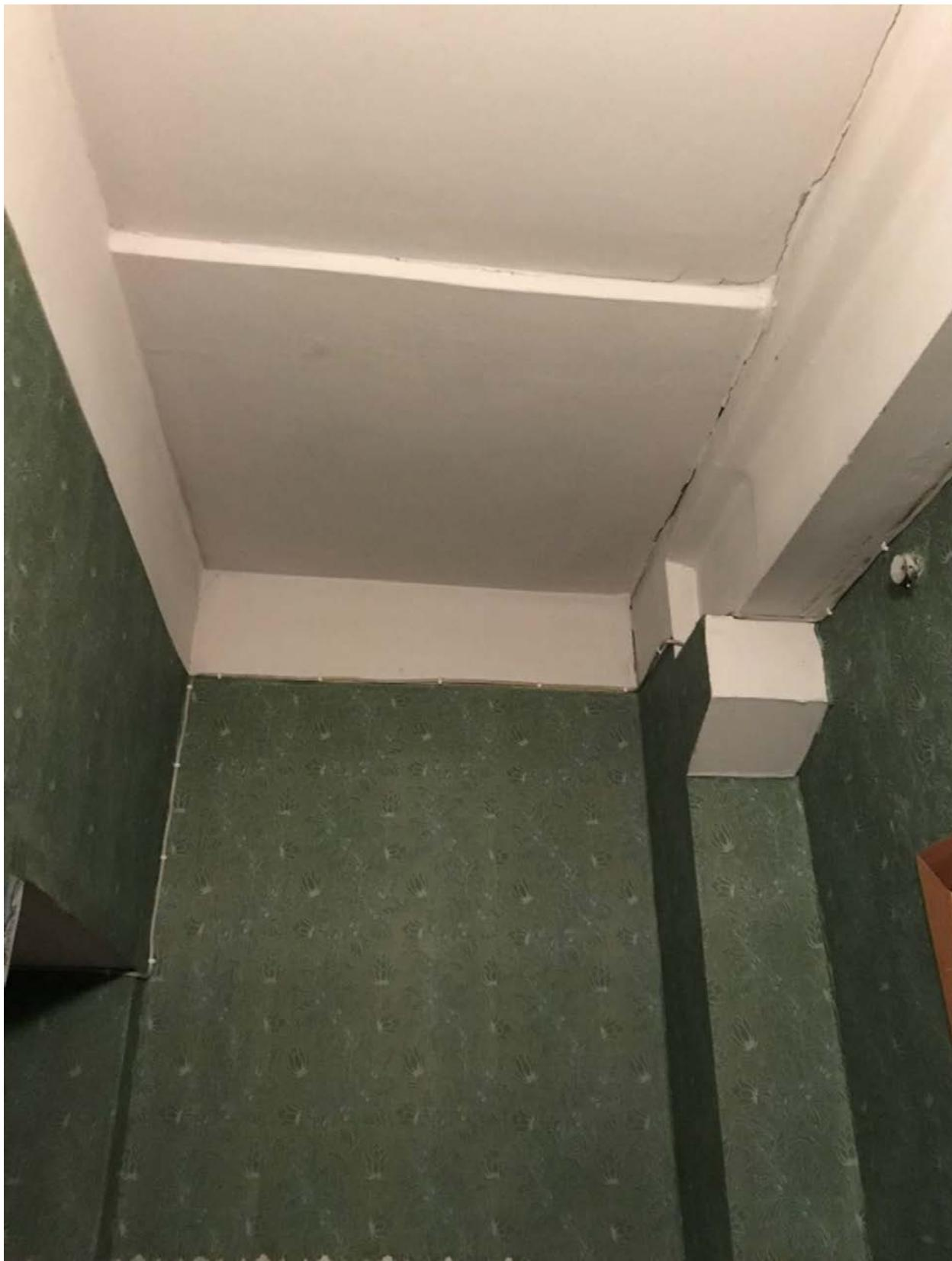
Фотография 12. Трещина на потолке в коридоре
