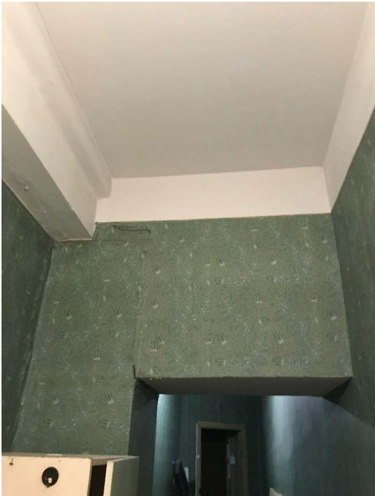
Фотография 11. Перемычка в коридоре
