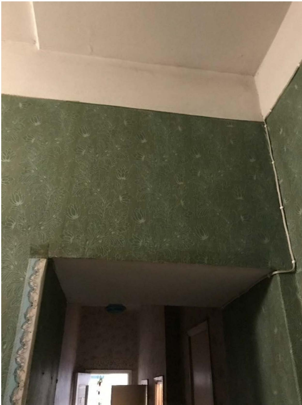
Фотография 14. Перемычка в коридоре
