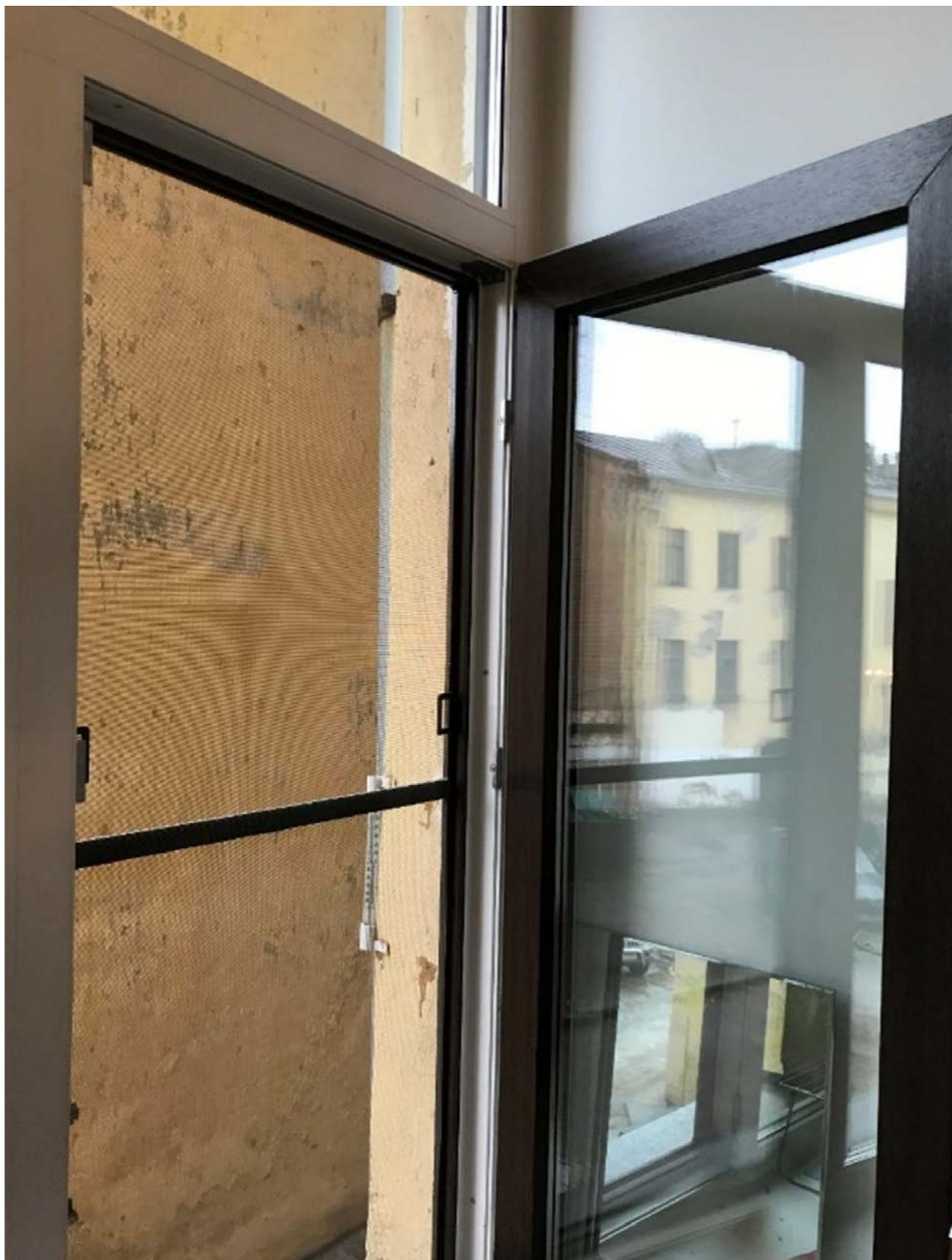
Фотография 27. Заполнение оконных проемов (металлопластик)
