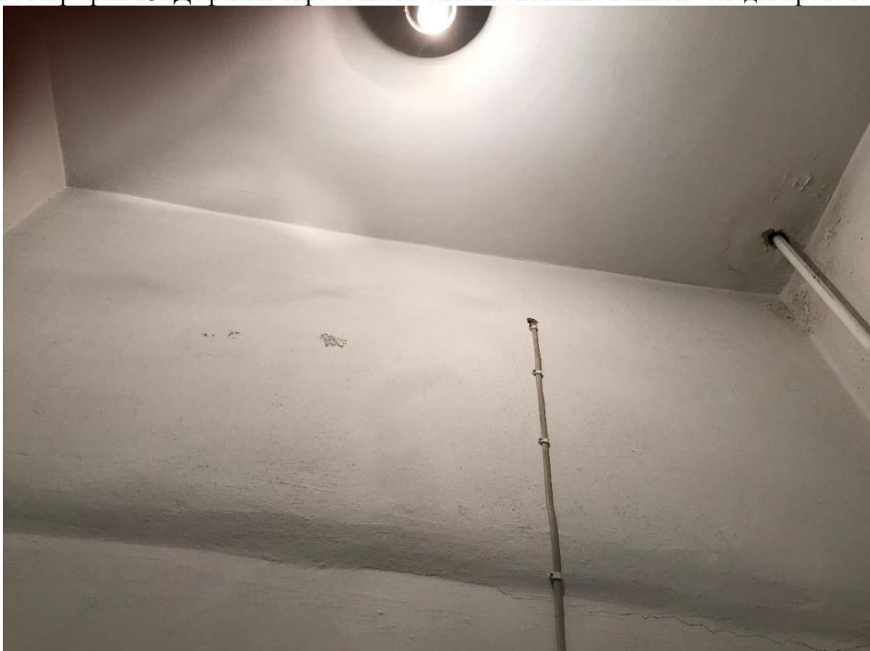
Фотография 24. Дефекты окрасочного слоя. Следы протечек.
