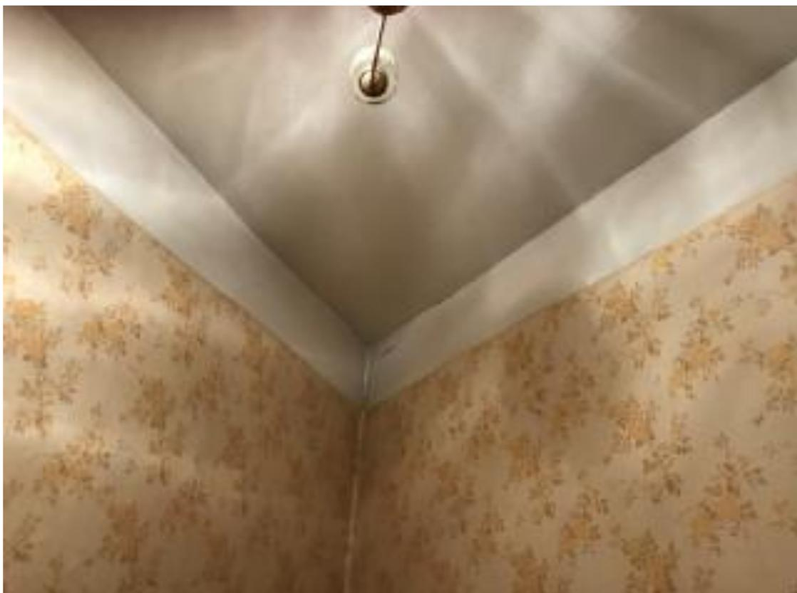
Фотография 44. Фрагмент комнаты (помещение №2). Трещина на потолке.
