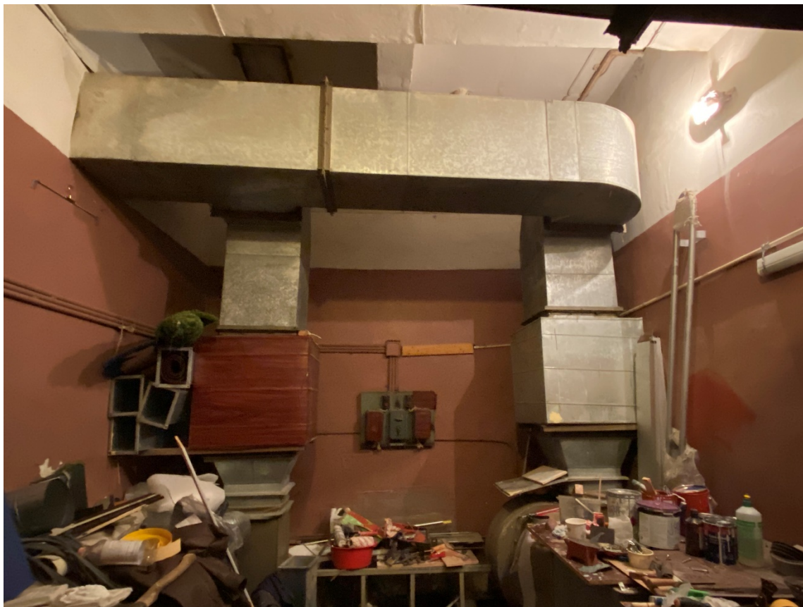
Фото 11. Объект культурного наследия регионального значения «Дом Санкт-Петербургского губернского кредитного общества», по адресу: Санкт-Петербург, наб. реки Фонтанки, дом 15, литера А. Помещение 1-Н, 3-Н в уровне подвала. Помещение венткамеры. Воздуховоды системы вытяжной вентиляции. Дата фотофиксации: 06 февраля 2023 г.
