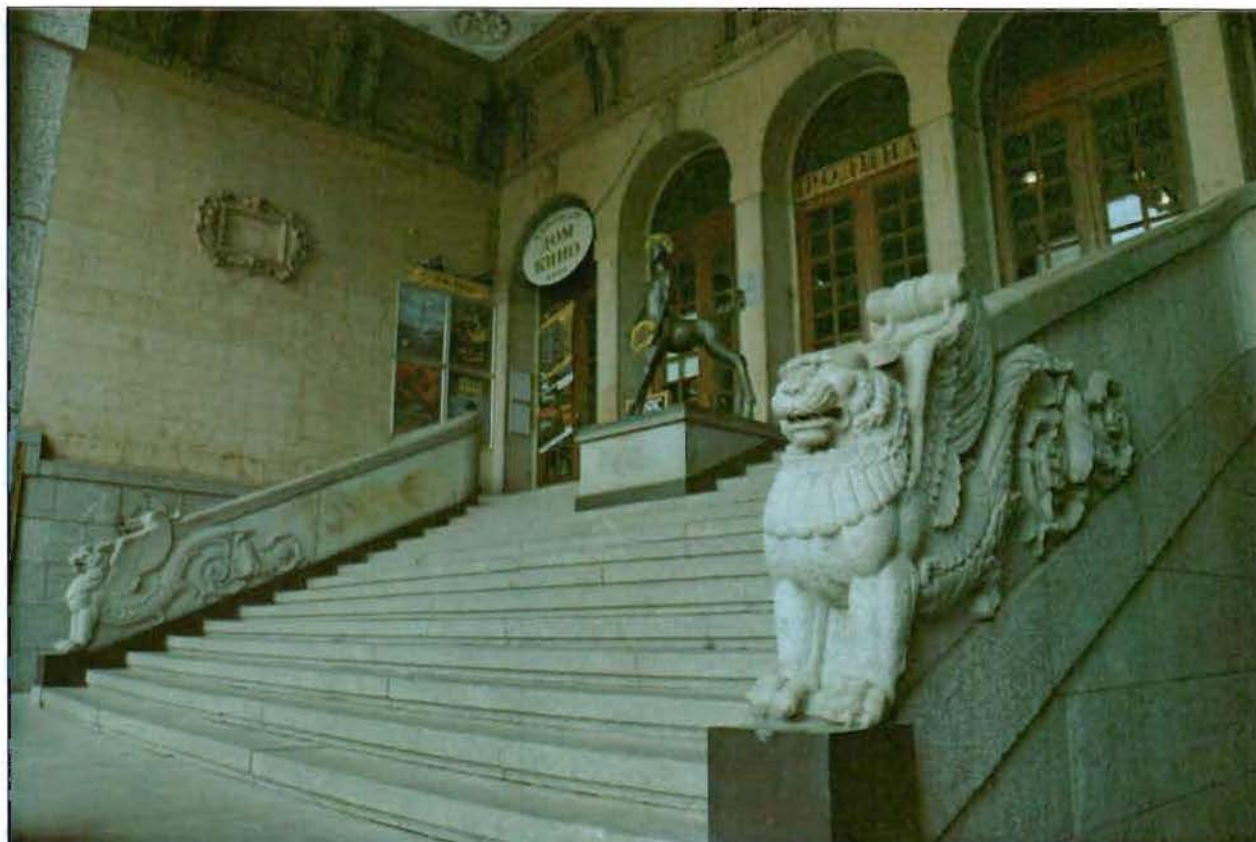
2. Лестница в лоджии (западный фасад).
