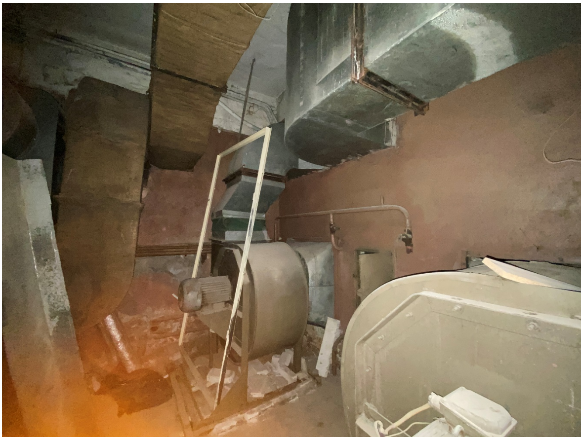
Фото 13. Объект культурного наследия регионального значения «Дом Санкт-Петербургского губернского кредитного общества», по адресу: Санкт-Петербург, наб. реки Фонтанки, дом 15, литера А. Помещение 1-Н, 3-Н в уровне подвала. Помещение венткамеры. Воздуховоды системы вытяжной вентиляции. Дата фотофиксации: 06 февраля 2023 г.
