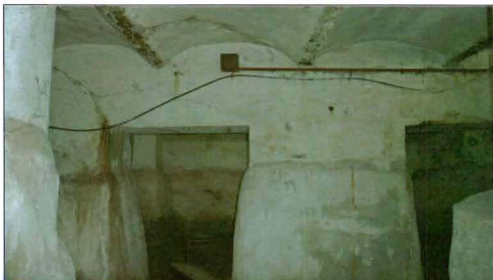
8. Прусские своды. Подвал.
