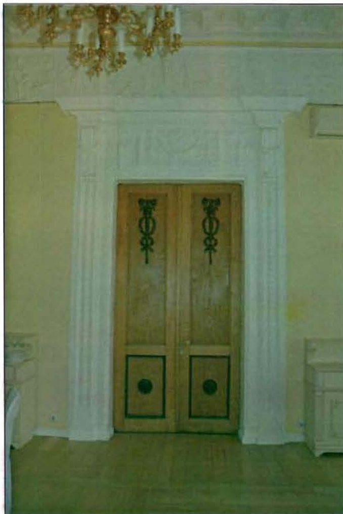
28. Оформление дверного проема (помещение 29-Н (ч. п. 3)).
