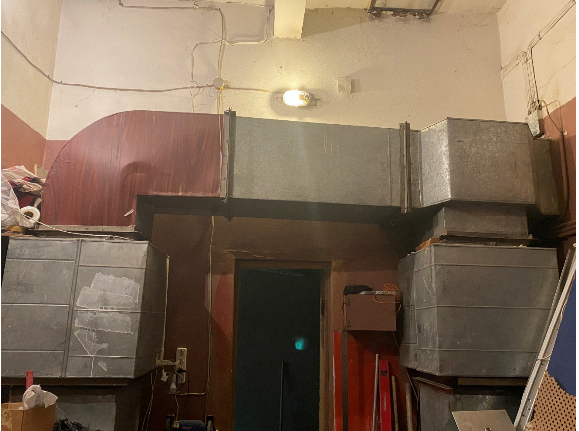
Фото 12. Объект культурного наследия регионального значения «Дом Санкт-Петербургского губернского кредитного общества», по адресу: Санкт-Петербург, наб. реки Фонтанки, дом 15, литера А. Помещение 1-Н, 3-Н в уровне подвала. Помещение венткамеры. Воздуховоды системы вытяжной вентиляции. Дата фотофиксации: 06 февраля 2023 г.
