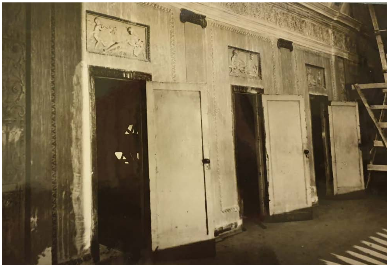
Илл. 44. Вход в ложи во время ремонта. Фото XX в.
