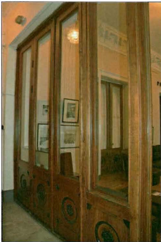
23. Историческое дверное заполнение (лестничная площадка в южной части здания).
