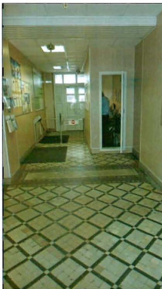
33. Метлахская плитка вестибюля (восточный корпус по наб. р. Фонтанки).
