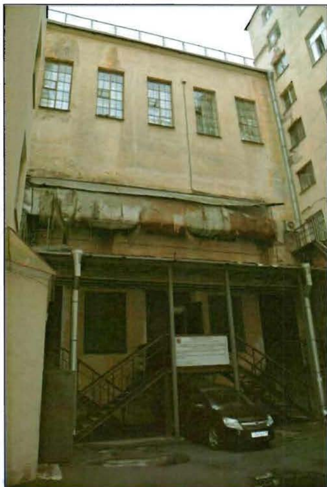
4. Западный дворовый фасад.
