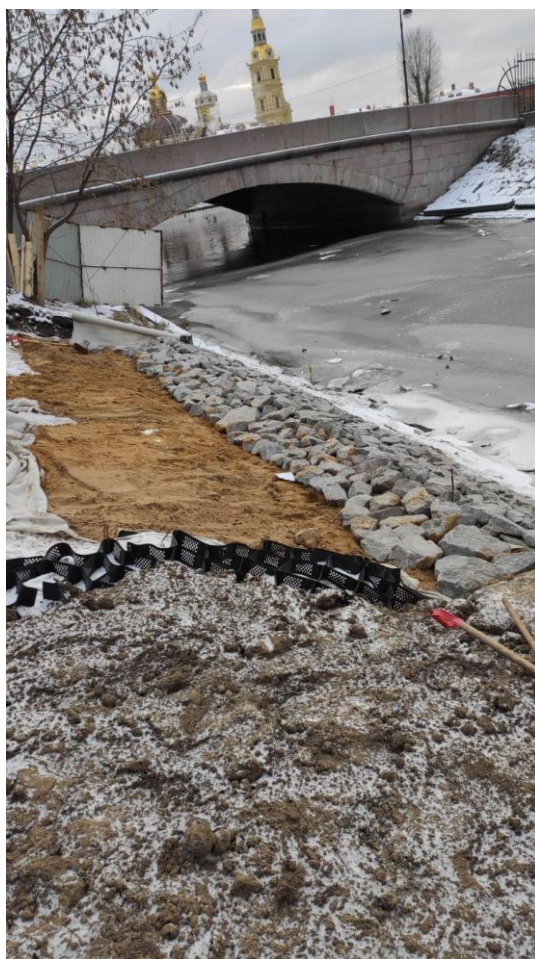
Фото 2. Восточная часть объекта культурного наследия федерального значения «Гласис, ров и вал», входящего в состав объекта культурного наследия федерального значения «Кронверк Петропавловской крепости»
