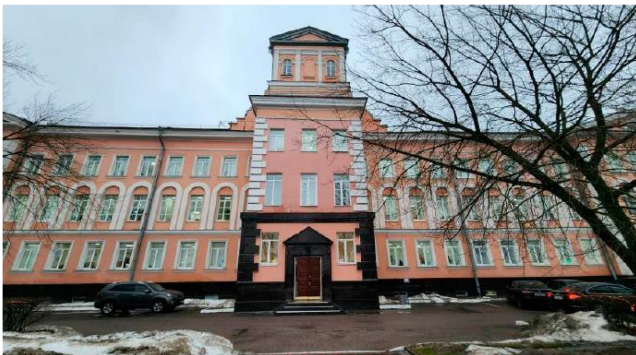
1. Вид на лицевой фасад выявленного объекта культурного наследия «Комплекс построек «Невского железодельного, механического и корабельного завода» («Невского железопрокатного завода» П.Ф. Семянникова и В.А. Полетики). Заводоуправление», расположенного по адресу: г. Санкт-Петербург, пр. Обуховской Обороны, д. 51, литеры АФ. 07.03.2023
