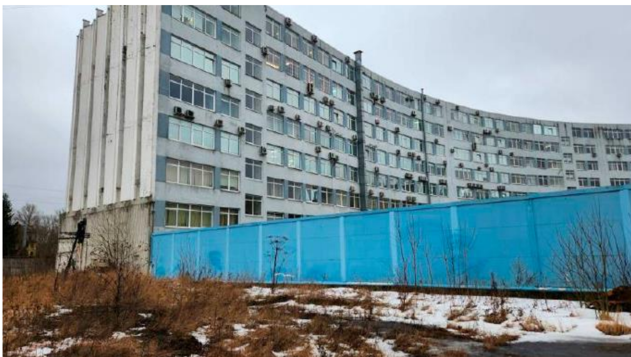
11. Вид в сторону выявленного объекта культурного наследия «Особняк», расположенного по адресу: г. Санкт-Петербург, пр. Обуховской Обороны, д. 59, лит. А, от зоны производства работ. 07.03.2023
