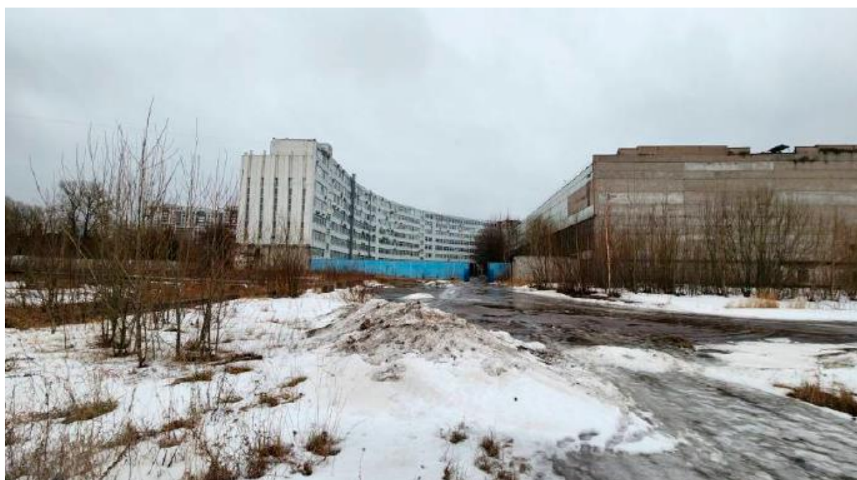
3. Вид от выявленного объекта культурного наследия «Комплекс построек «Невского железоделательного, механического и корабельного завода» («Невского железопрокатного завода» П.Ф. Семянникова и В.А. Полетики). Заводоуправление», расположенного по адресу: г. Санкт-Петербург, пр. Обуховской Обороны, д. 51, литеры АФ, в сторону зоны производства работ. 07.03.2023
