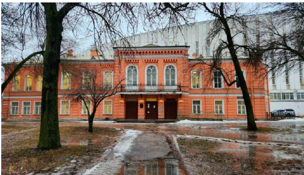
10. Лицевой фасад выявленного объекта культурного наследия «Особняк», расположенного по адресу: г. Санкт-Петербург, пр. Обуховской Обороны, д. 59, лит. А, в сторону зоны производства работ. 07.03.2023
