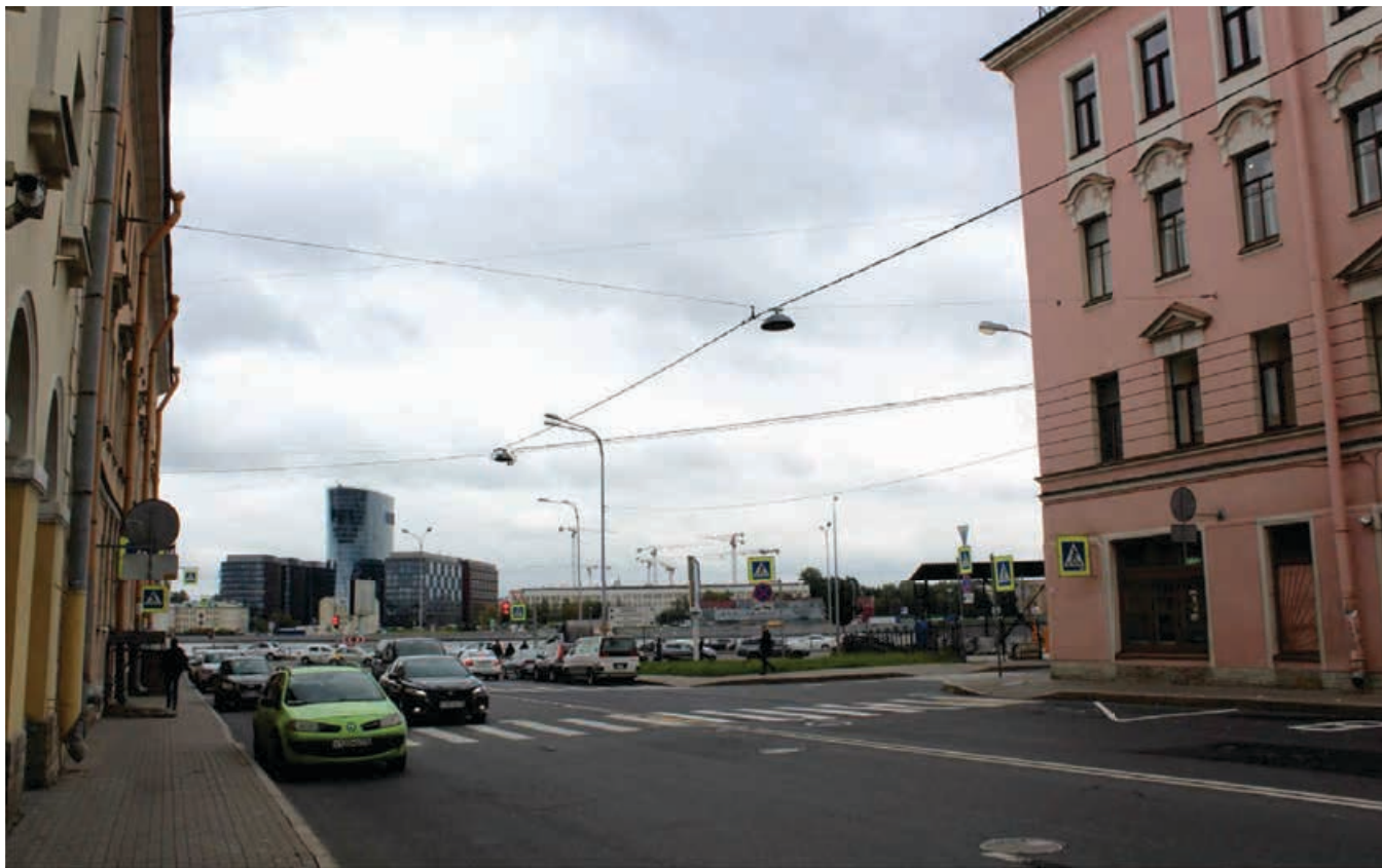
9. Вид на исследуемый участок с пр. Бакунина. Дата съемки: 23.09.2021.
