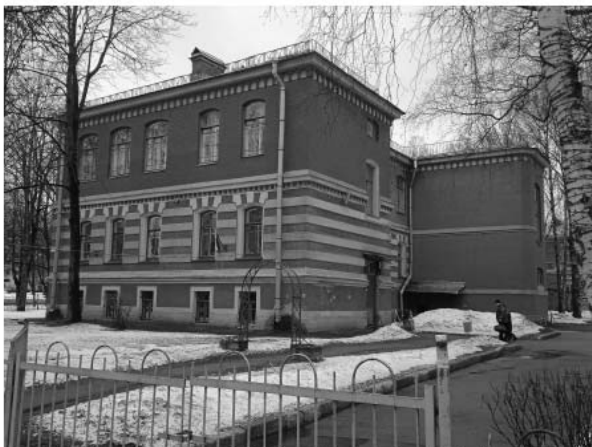
Фото 10. Общий вид здания со стороны Оранжерейной ул.
