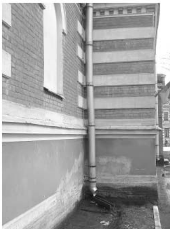
Фото 39. Фрагмент вида лицевого фасада
