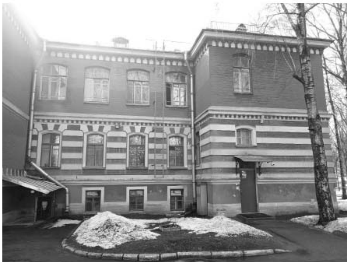
Фото 22. Вид дворового фасада
