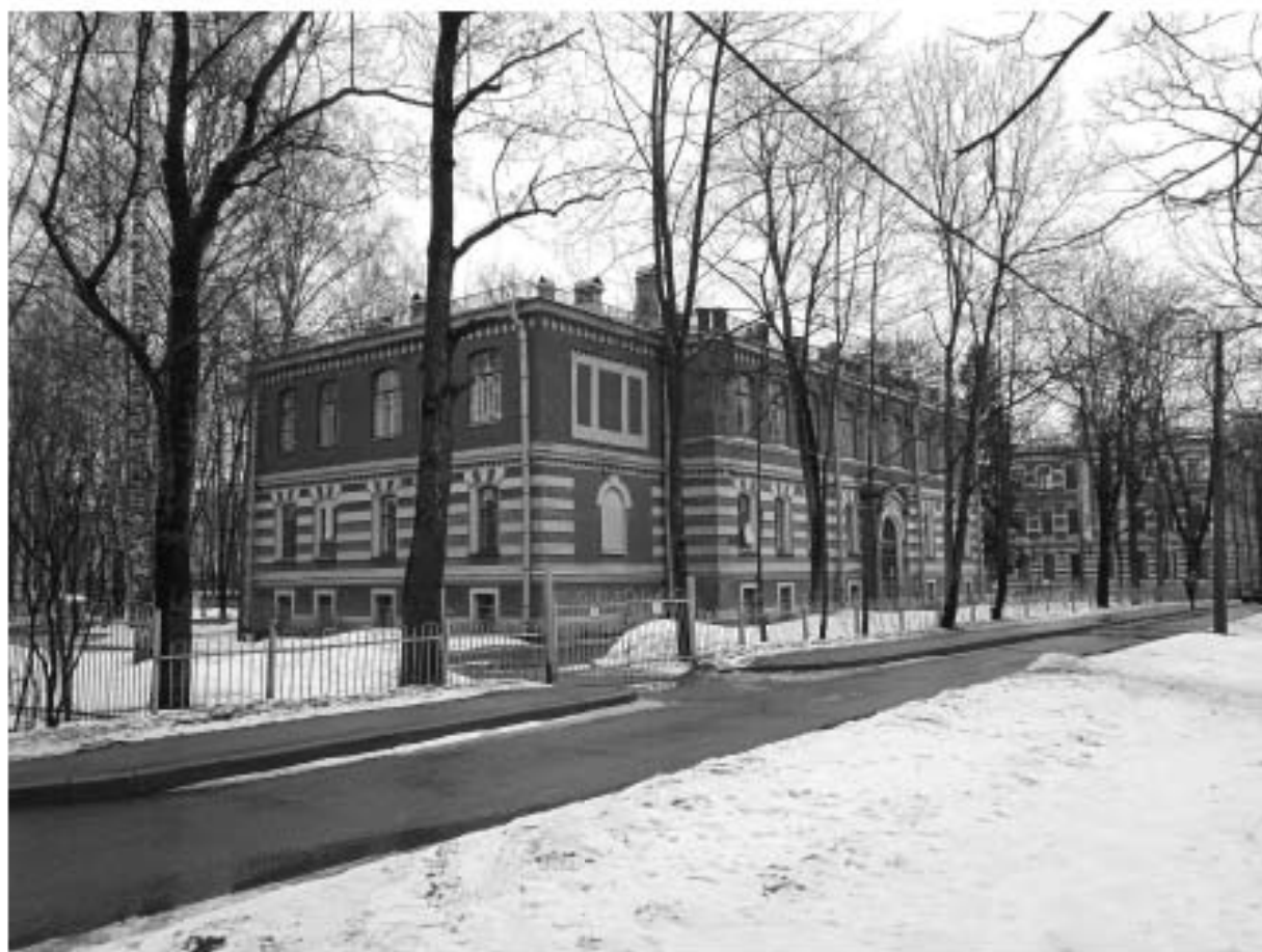
Фото 1. Общий вид здания со стороны Октябрьского бульвара
