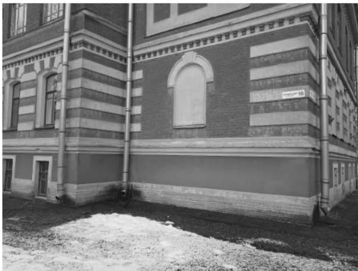
Фото 52. Фрагмент вида лицевого фасада
