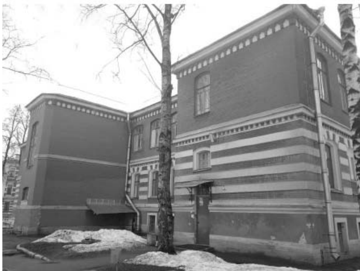
Фото 25. Общий вид дворового фасада
