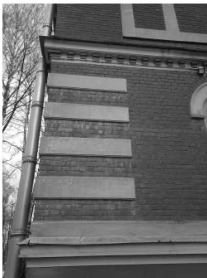
Фото 35. Фрагмент вида лицевого фасада
