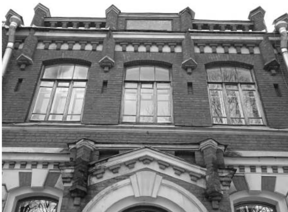
Фото 44. Фрагмент вида лицевого фасада
