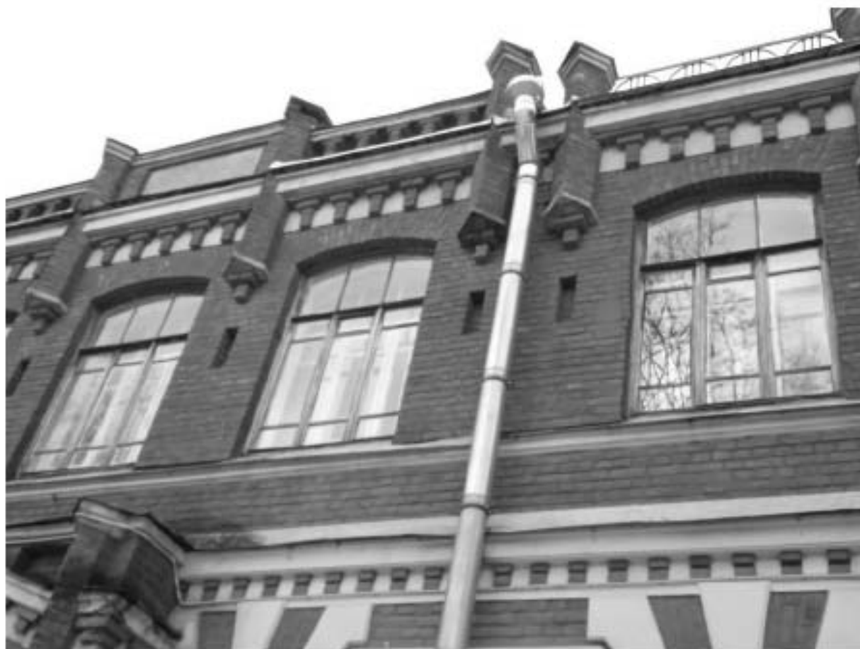
Фото 48. Фрагмент вида лицевого фасада
