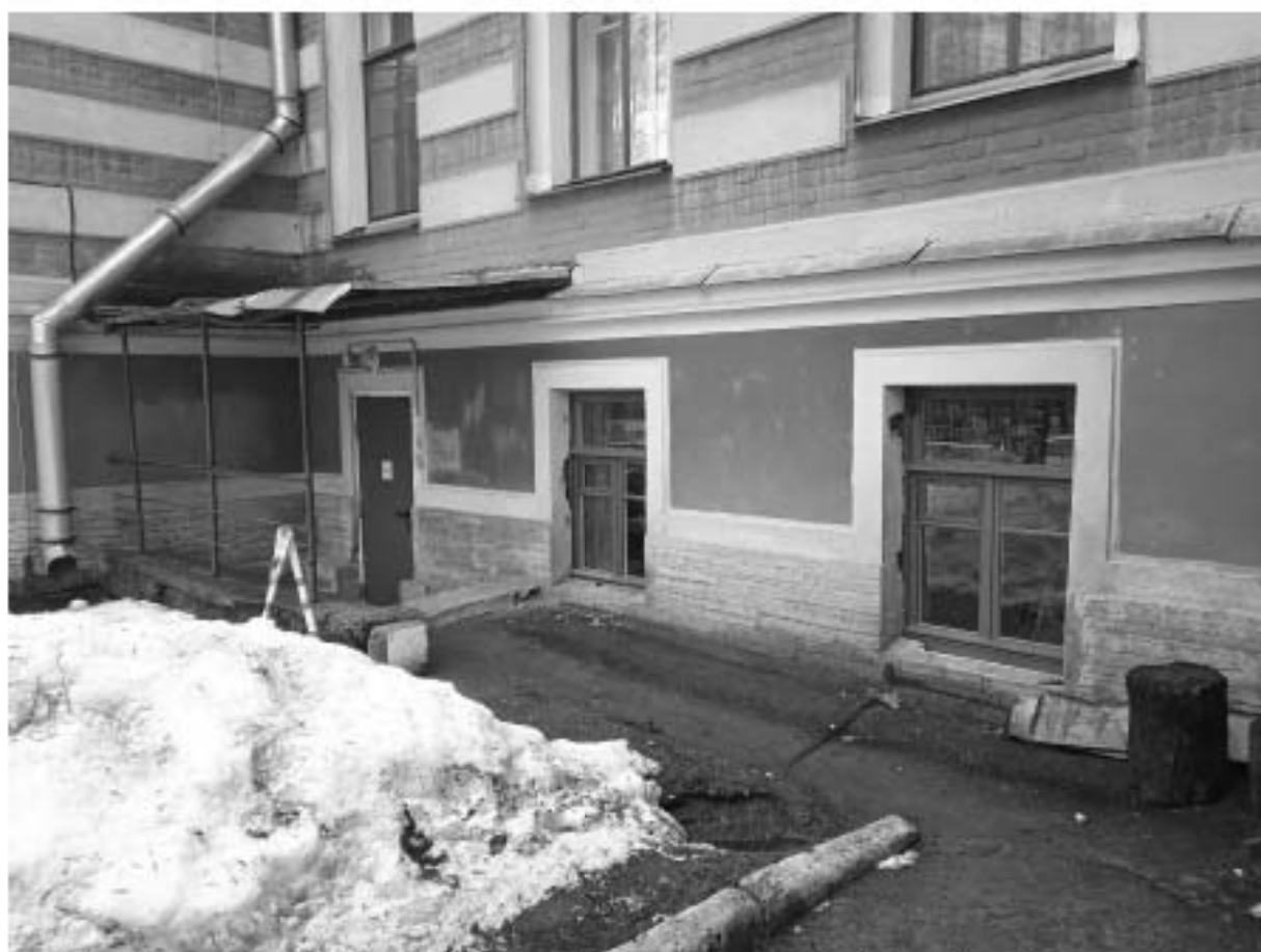
Фото 16. Вид приямка со стороны дворового фасада
