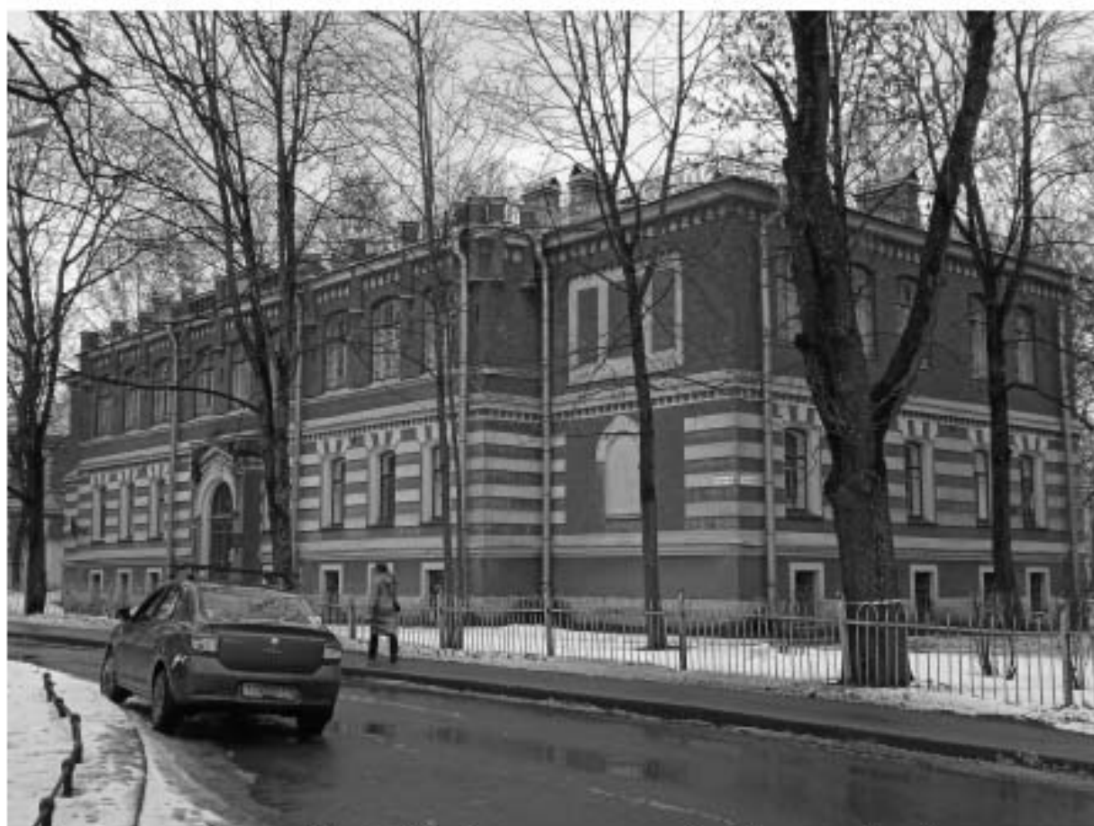
Фото 6. Общий вид здания со стороны Октябрьского бульвара
