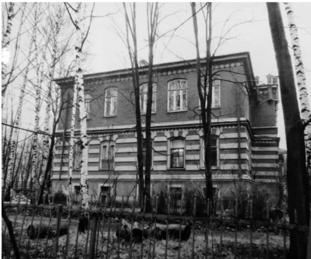
10. Северо-западный (торцевой) фасад здания, фото без даты (предположительно 1960-е–1980-е гг.) Коллекция фотографий архива КГИОП.
