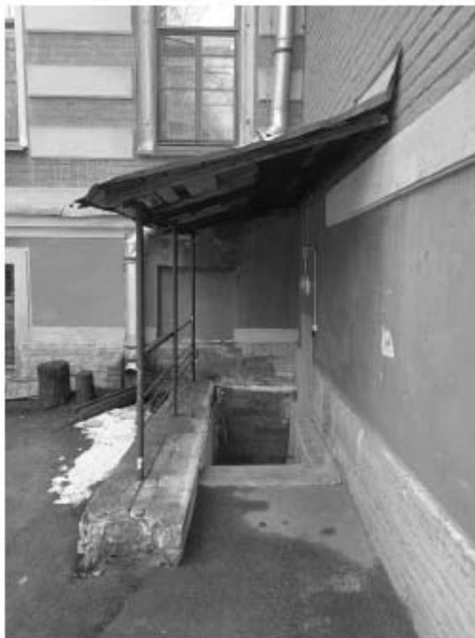
Фото 17. Вид приямка со стороны дворового фасада
