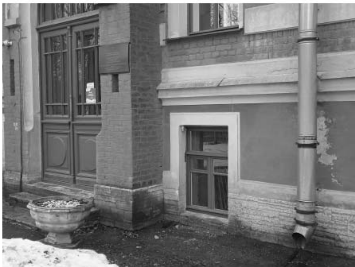
Фото 46. Фрагмент вида лицевого фасада
