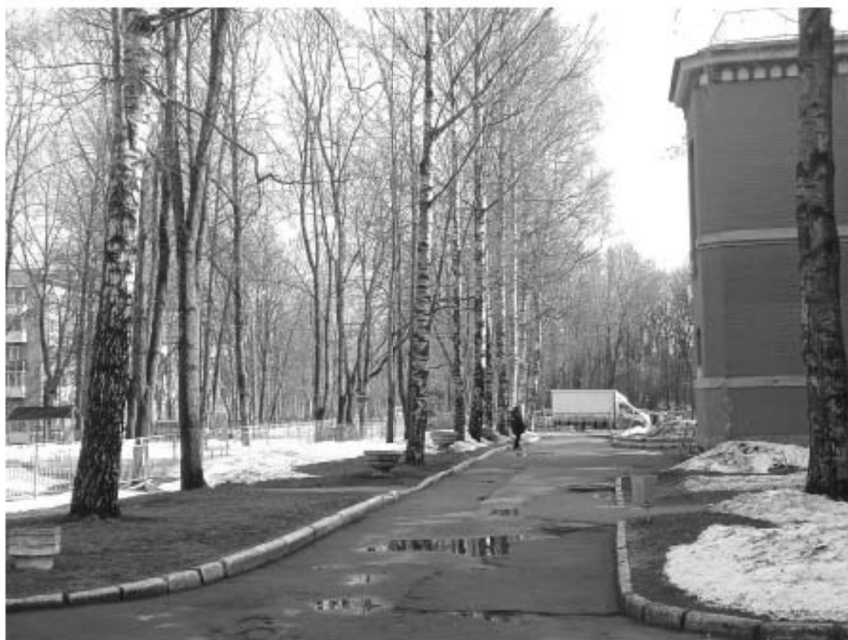
Фото 26. Вид оборонного фасада
