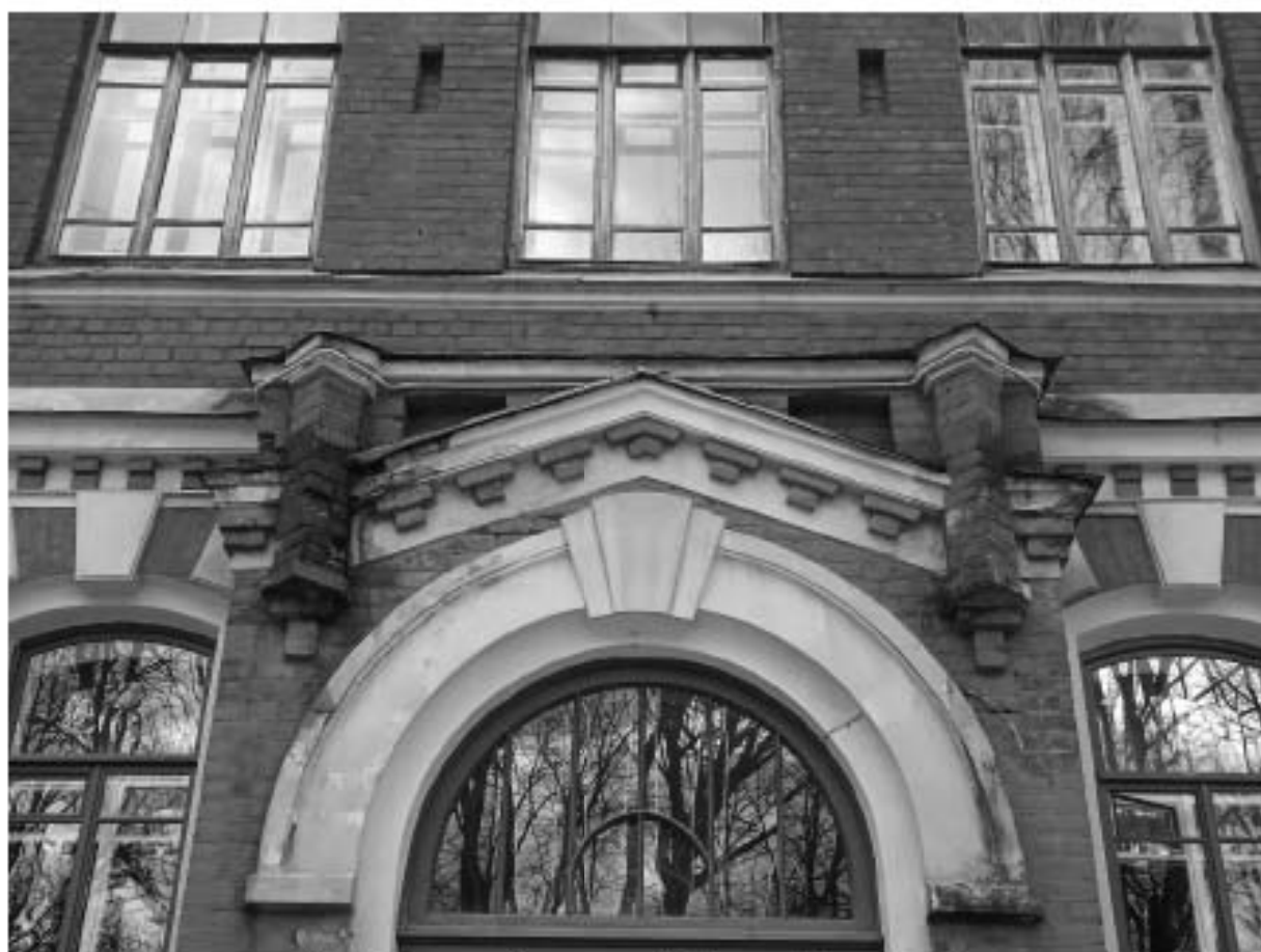
Фото 45. Фрагмент вида лицевого фасада
