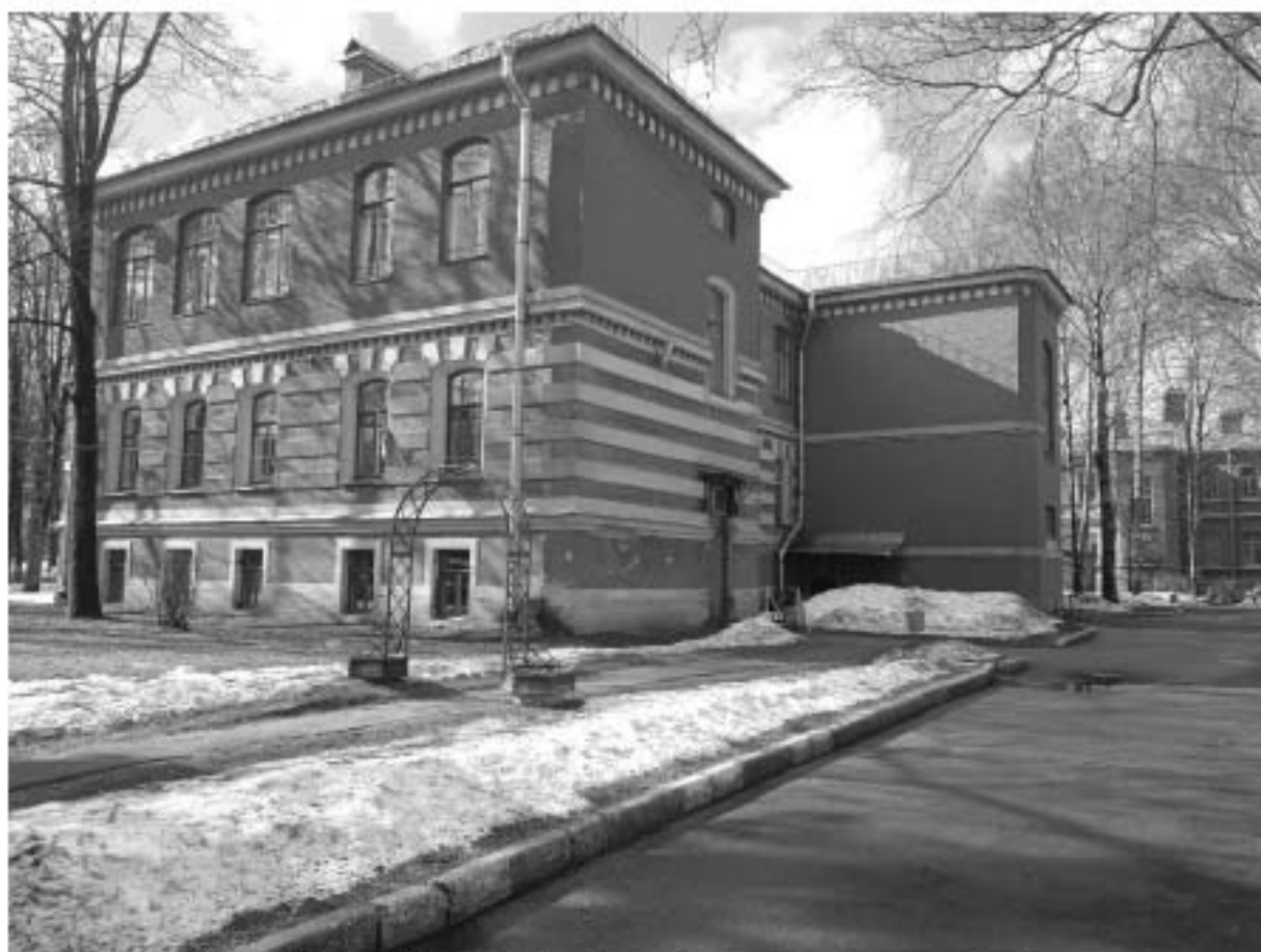
Фото 59. Общий вид здания со стороны Оранжерейной ул.
