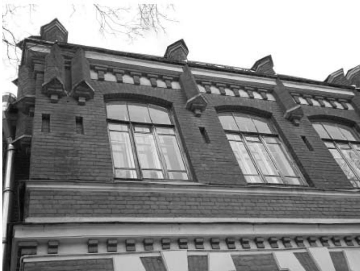
Фото 41. Фрагмент вида лицевого фасада
