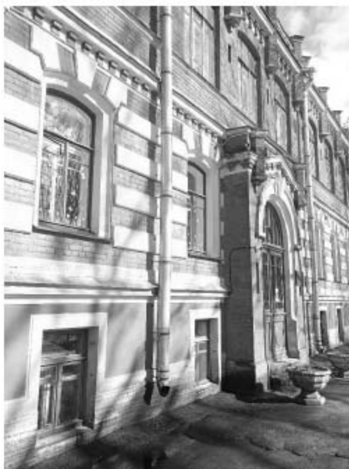
Фото 33. Фрагмент вида лицевого фасада
