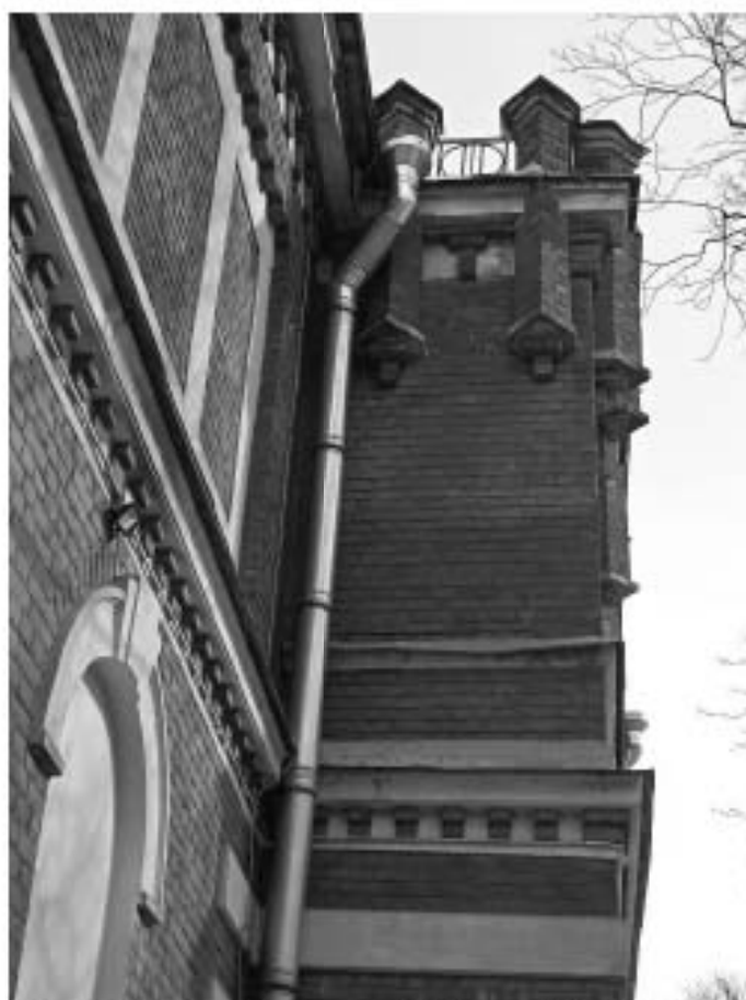
Фото 37. Фрагмент вида лицевого фасада
