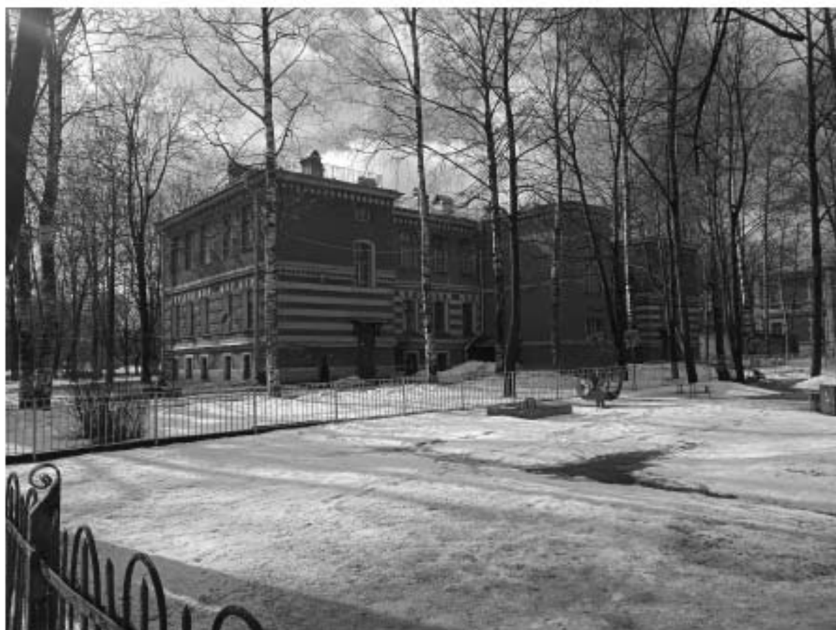
Фото 60. Общий вид здания со стороны Оранжерейной ул.
