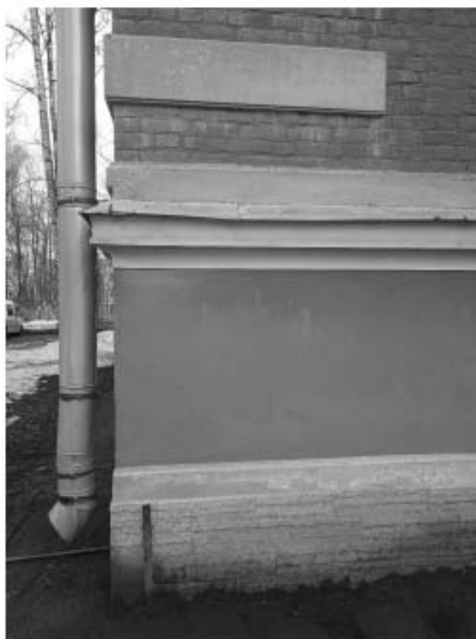
Фото 34. Фрагмент вида лицевого фасада
