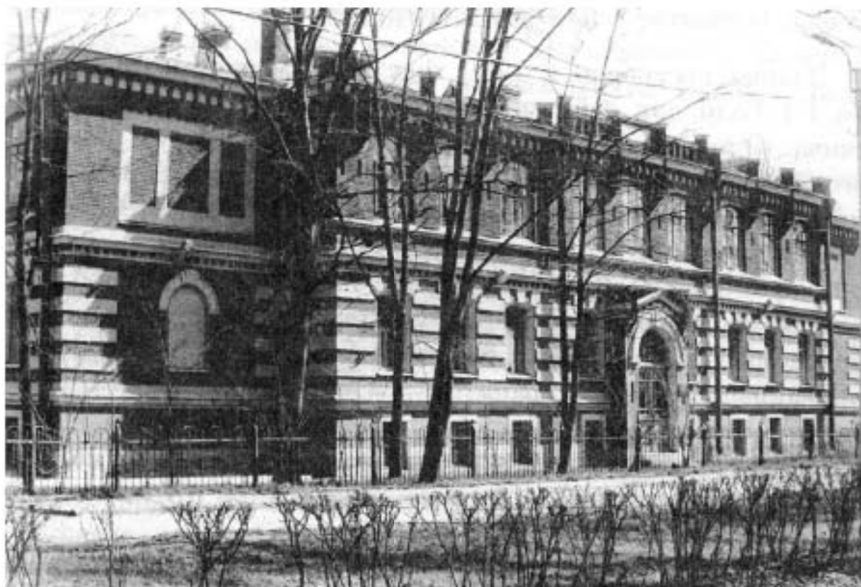
13. Вид на лицевой фасад здания с юго-запада, фото 1997-1998 гг. https://pastvu.com/
