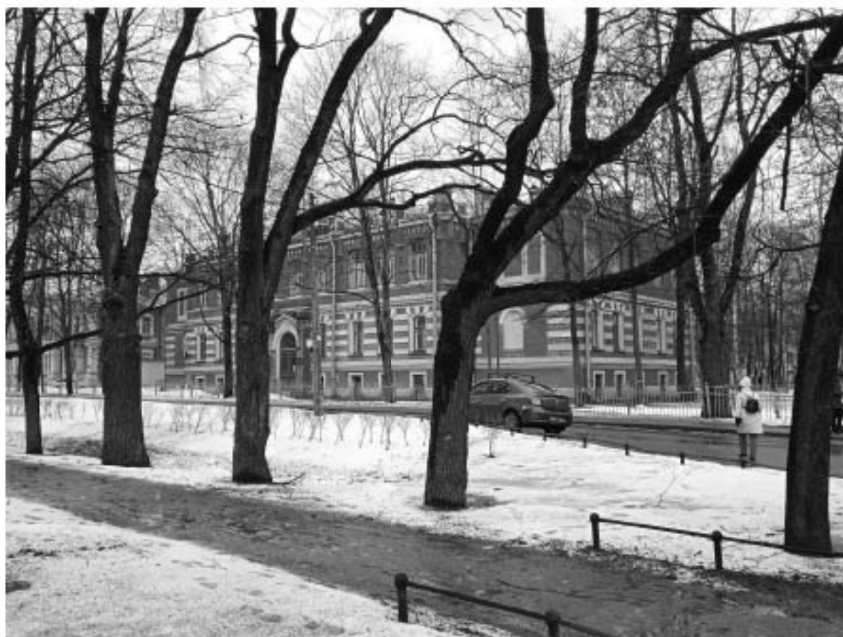
Фото 5. Общий вид здания со стороны Октябрьского бульвара
