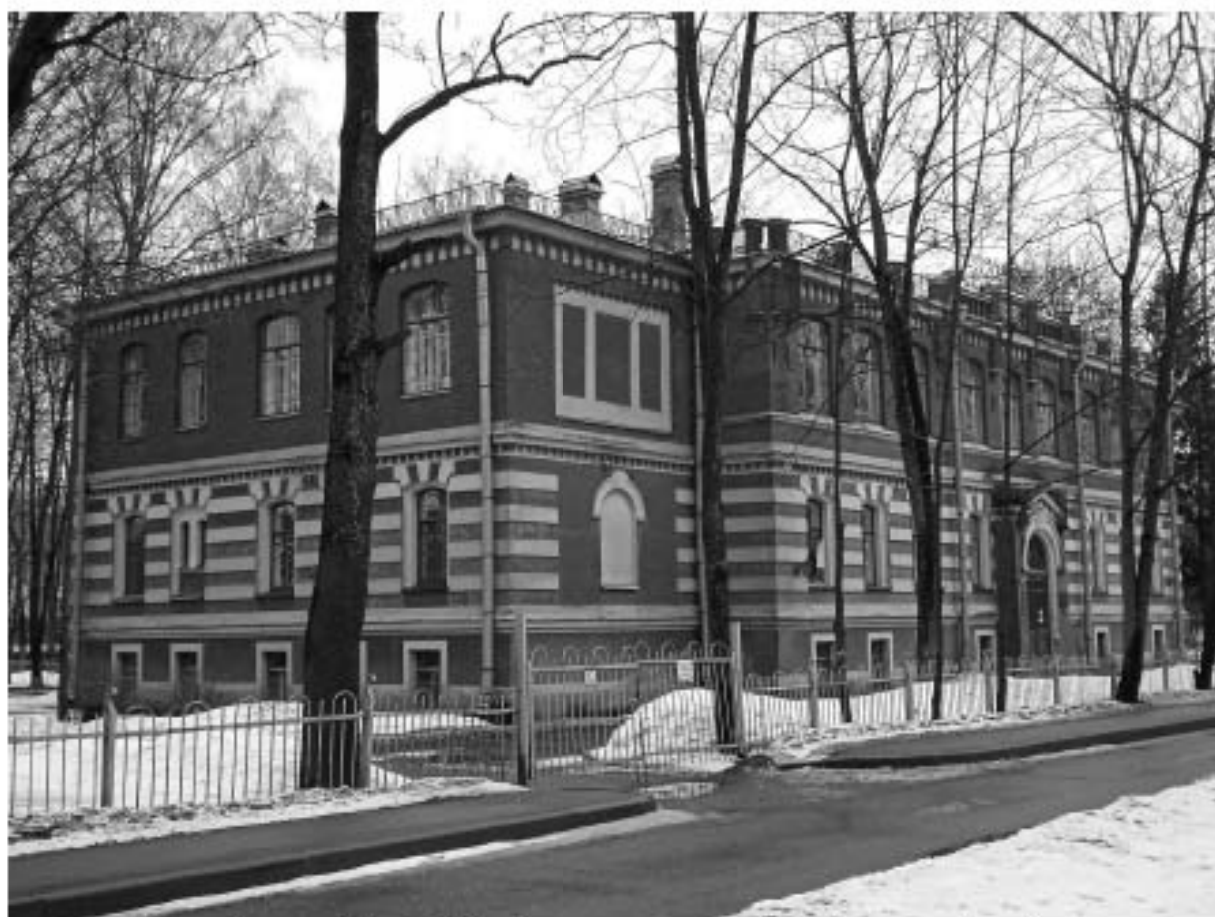
Фото 2. Общий вид здания со стороны Октябрьского бульвара
