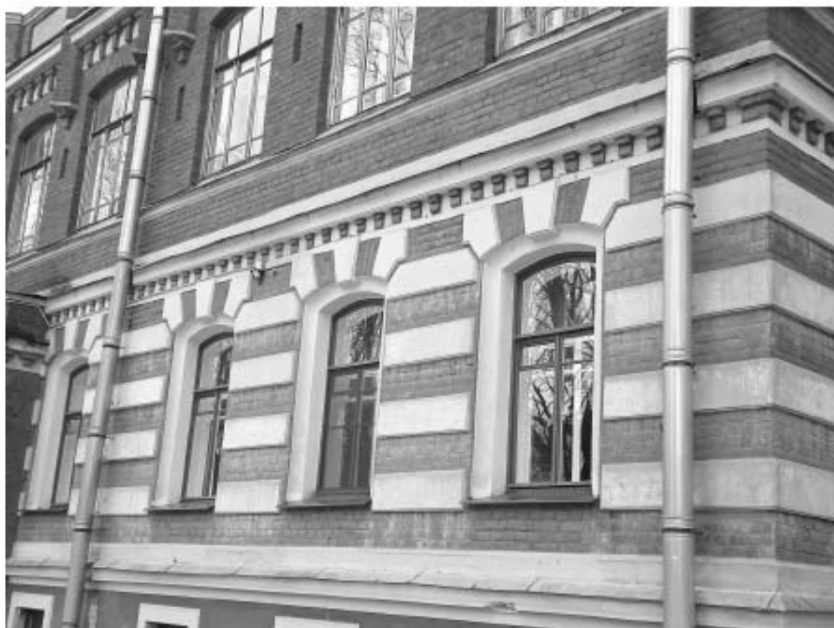
Фото 49. Фрагмент вида лицевого фасада
