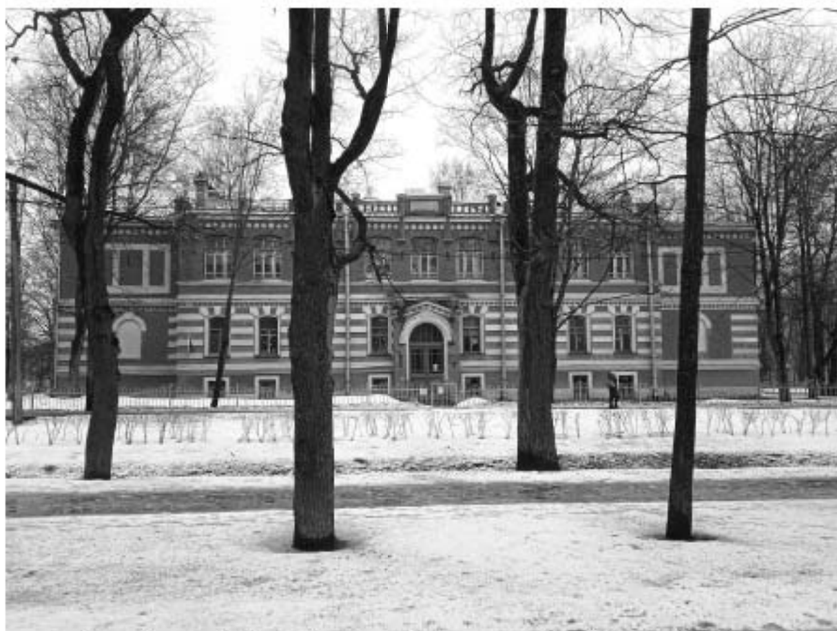
Фото 4. Вид лицевого фасада со стороны Октябрьского бульвара
