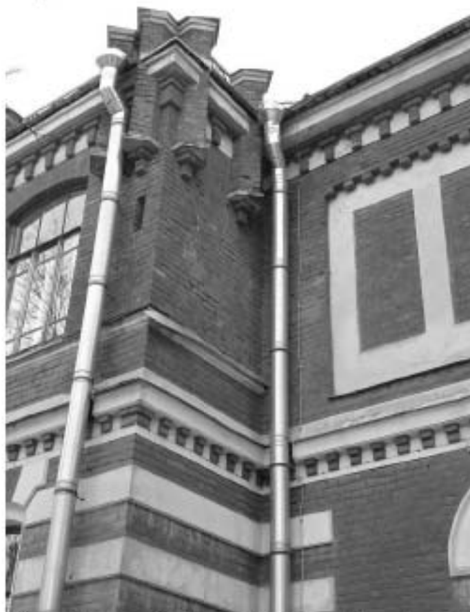
Фото 51. Фрагмент вида лицевого фасада
