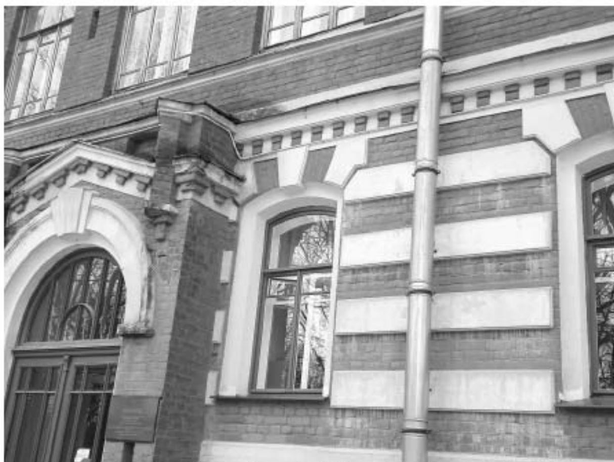
Фото 47. Фрагмент вида лицевого фасада
