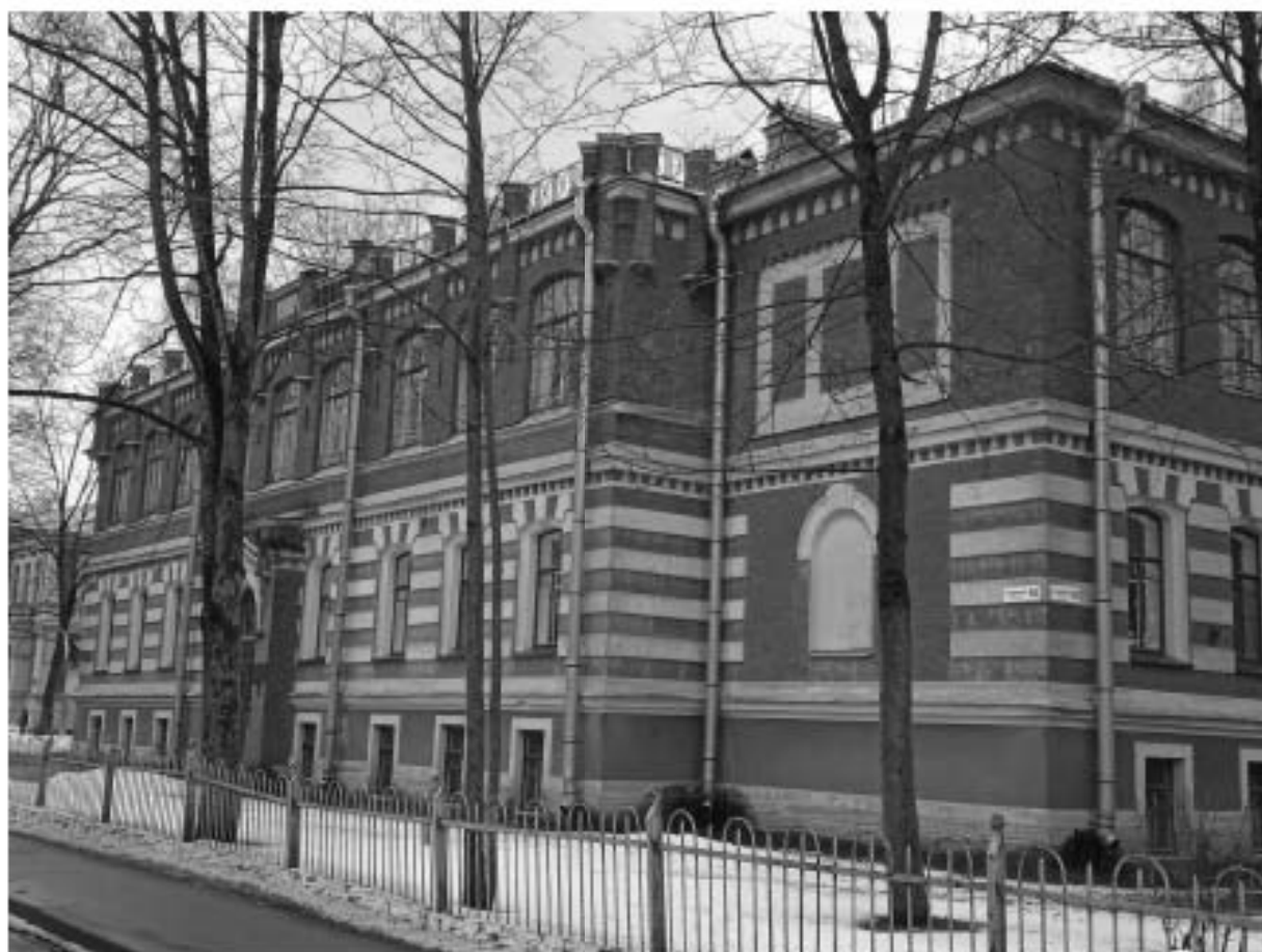
Фото 7. Вид лицевого фасада со стороны Октябрьского бульвара
