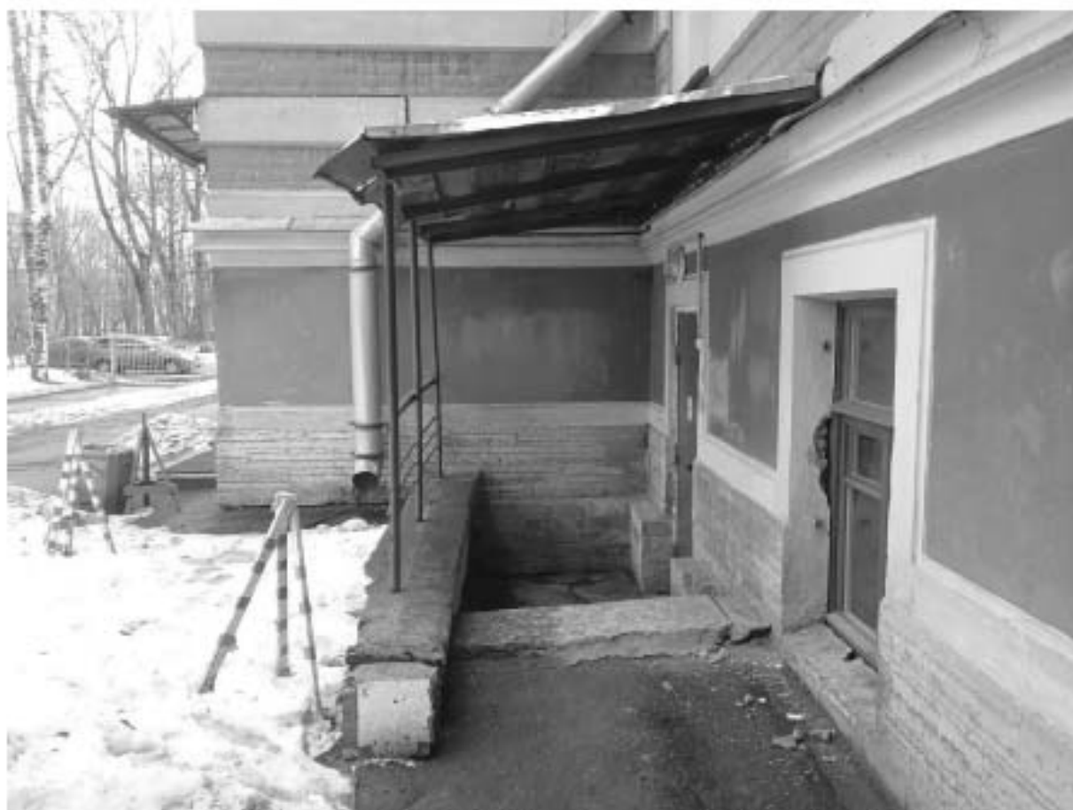
Фото 14. Вид приямка со стороны дворового фасада
