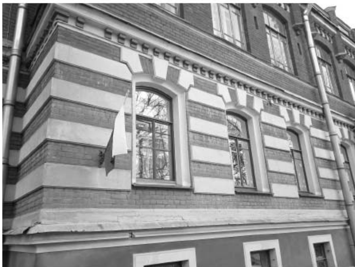
Фото 40. Фрагмент вида лицевого фасада
