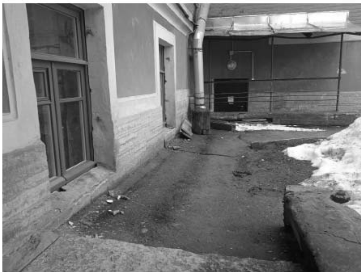
Фото 15. Вид приямка со стороны дворового фасада
