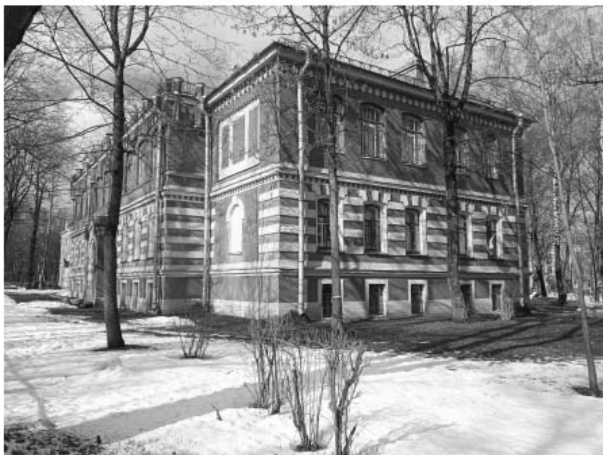
Фото 58. Общий вид здания со стороны Оранжерейной ул.
