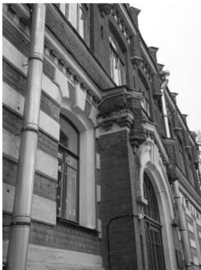
Фото 42. Фрагмент вида лицевого фасада
