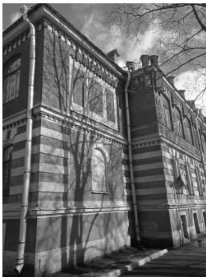
Фото 32. Вид лицевого фасада
