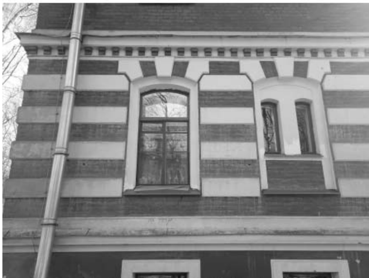
Фото 29. Фрагмент вида бокового фасада
