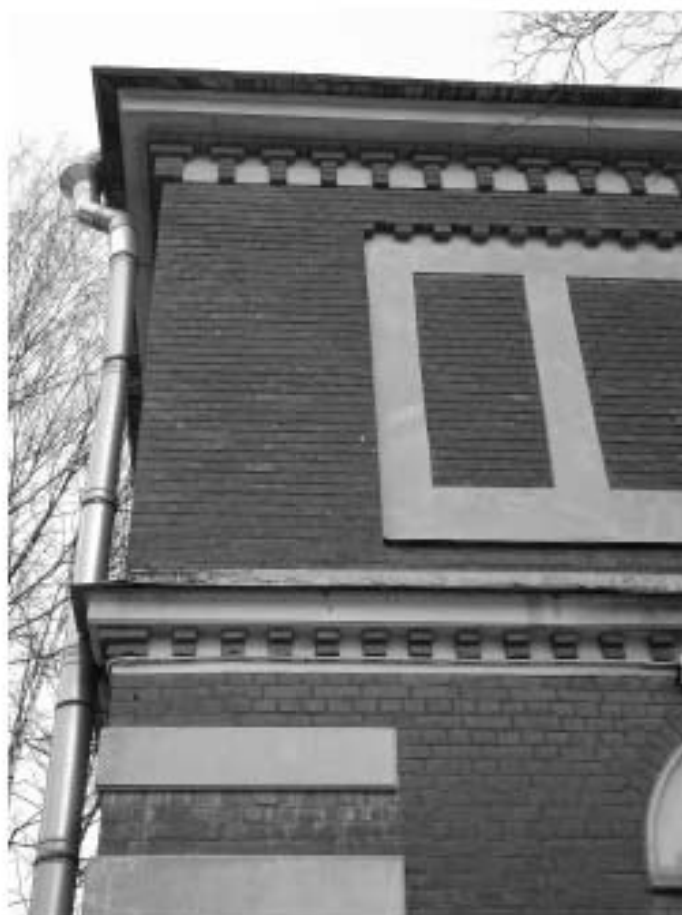
Фото 36. Фрагмент вида лицевого фасада
