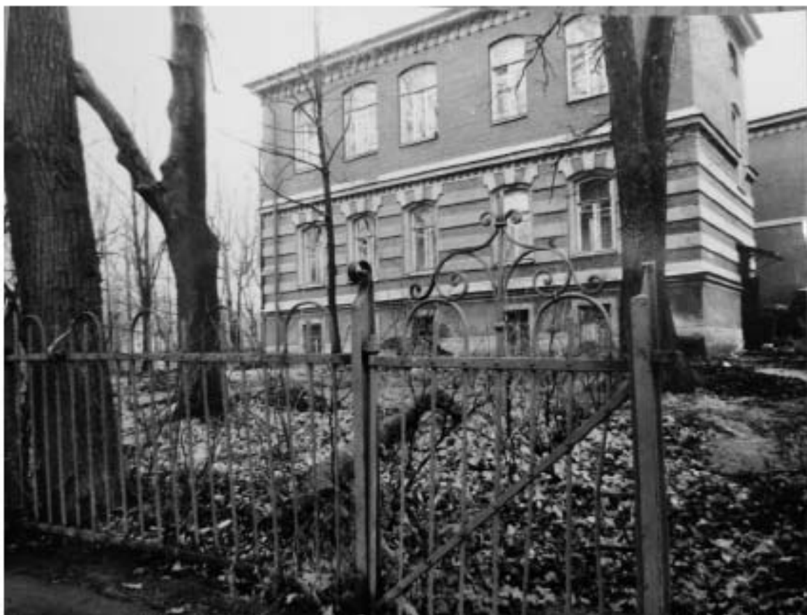
11. Юго-восточный (торцевой) фасад здания, фото без даты (предположительно) 1960-е–1980-е гг. Коллекция фотографий архива КГИОП.
