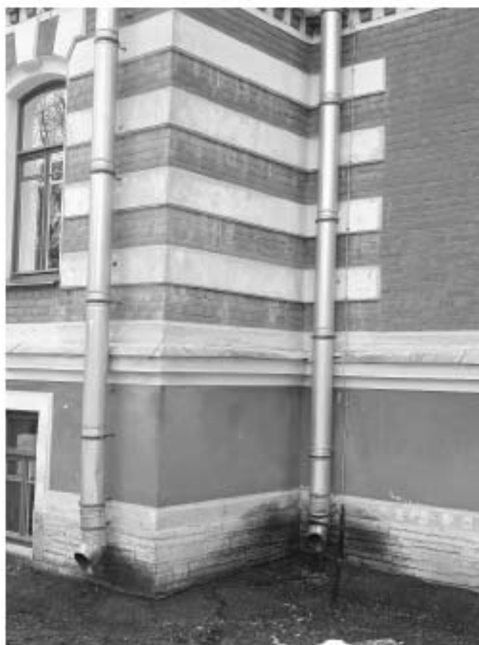
Фото 50. Фрагмент вида лицевого фасада
