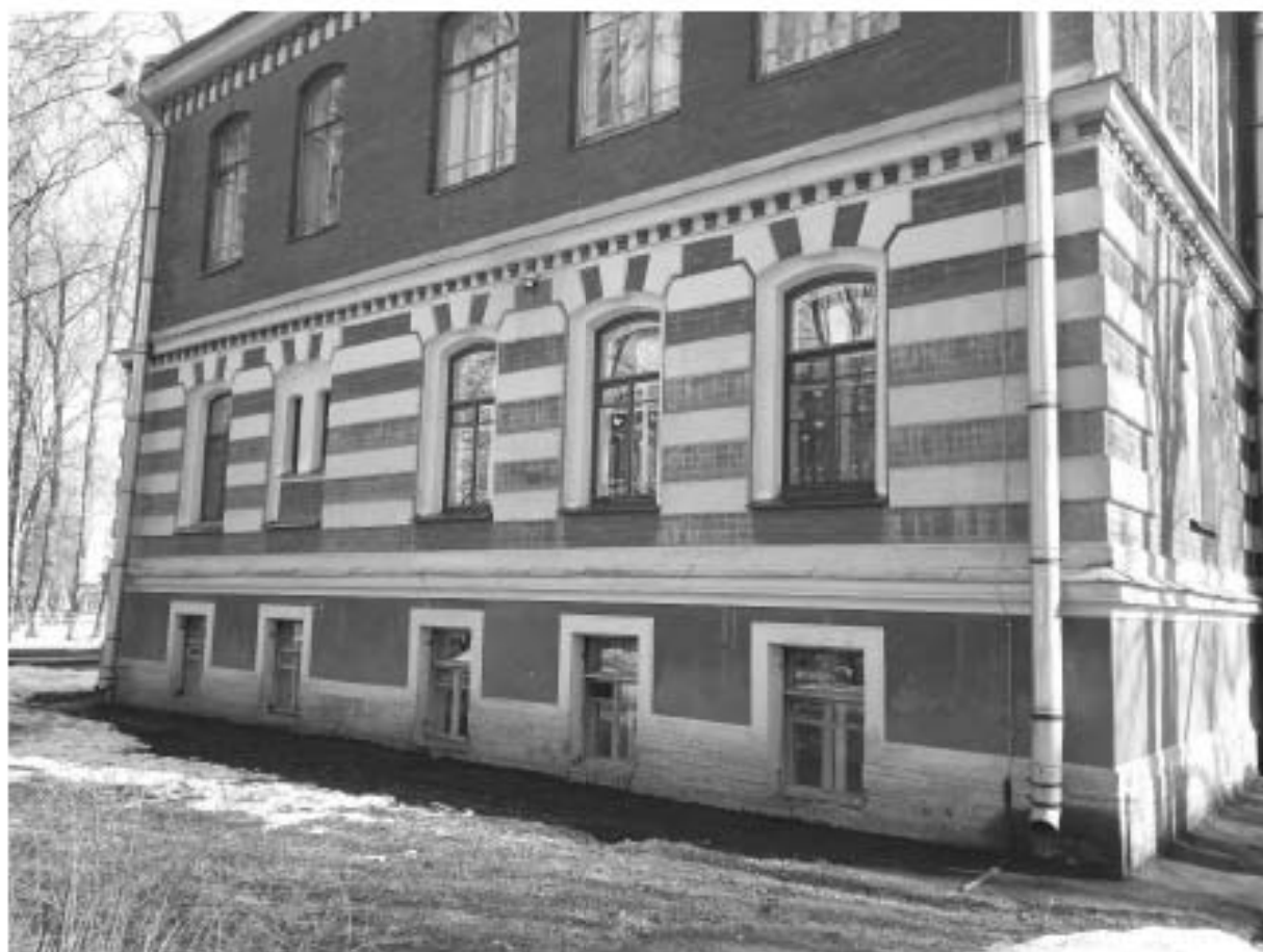
Фото 28. Фрагмент вида бокового фасада
