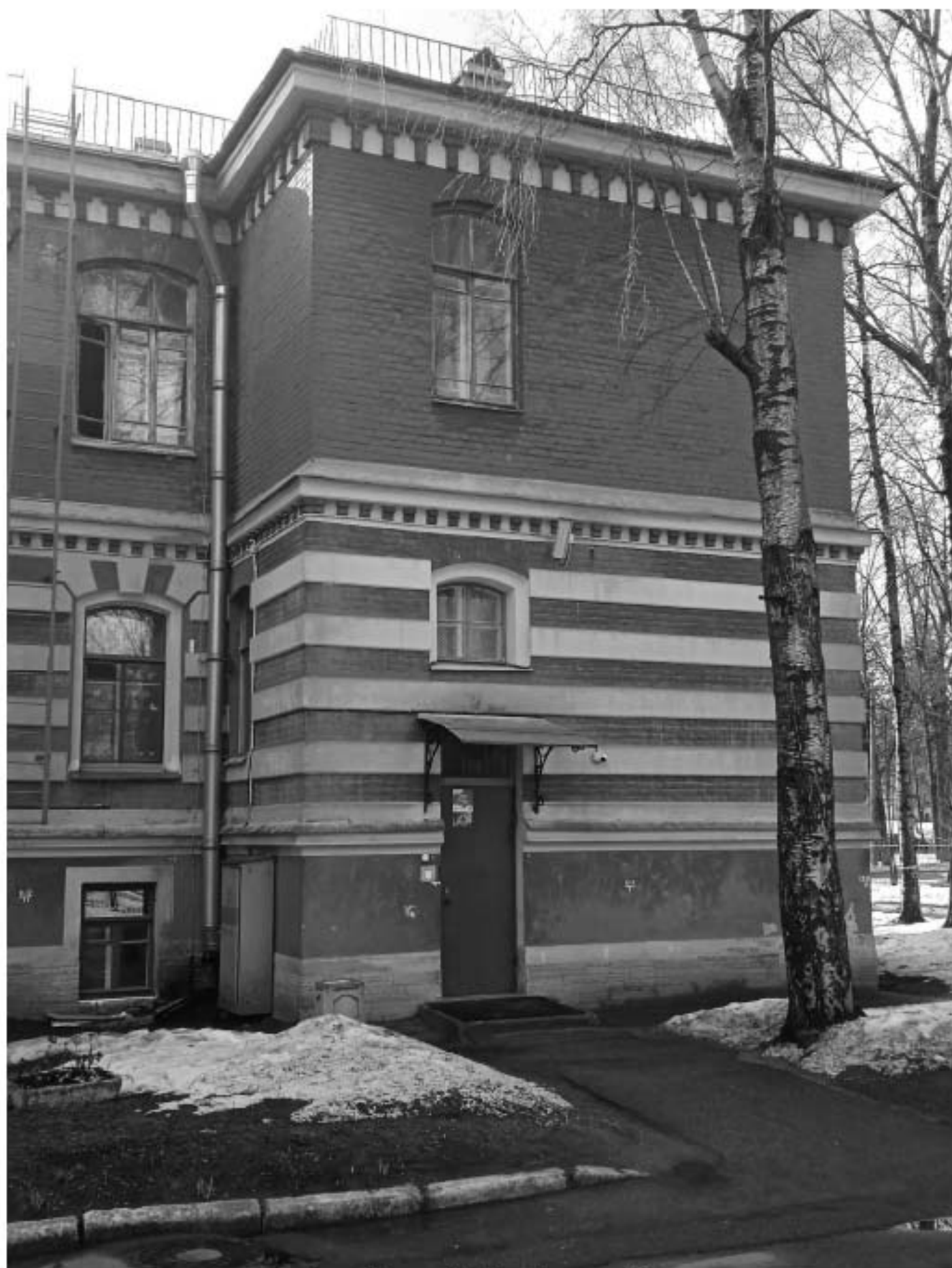
Фото 21. Вид оборотного фасада
