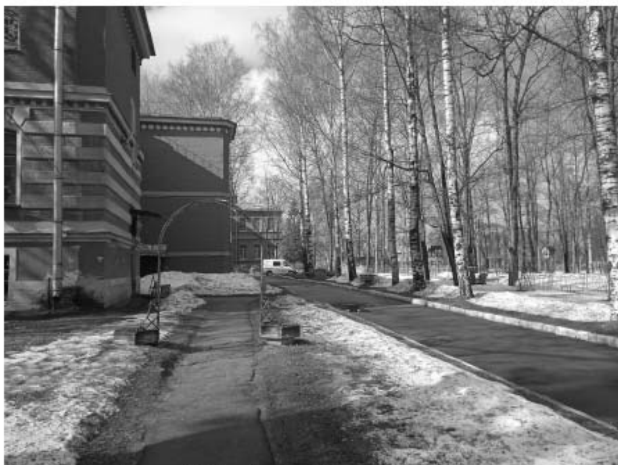
Фото 61. Вид дворовых фасадов со стороны Оранжерейной ул.
