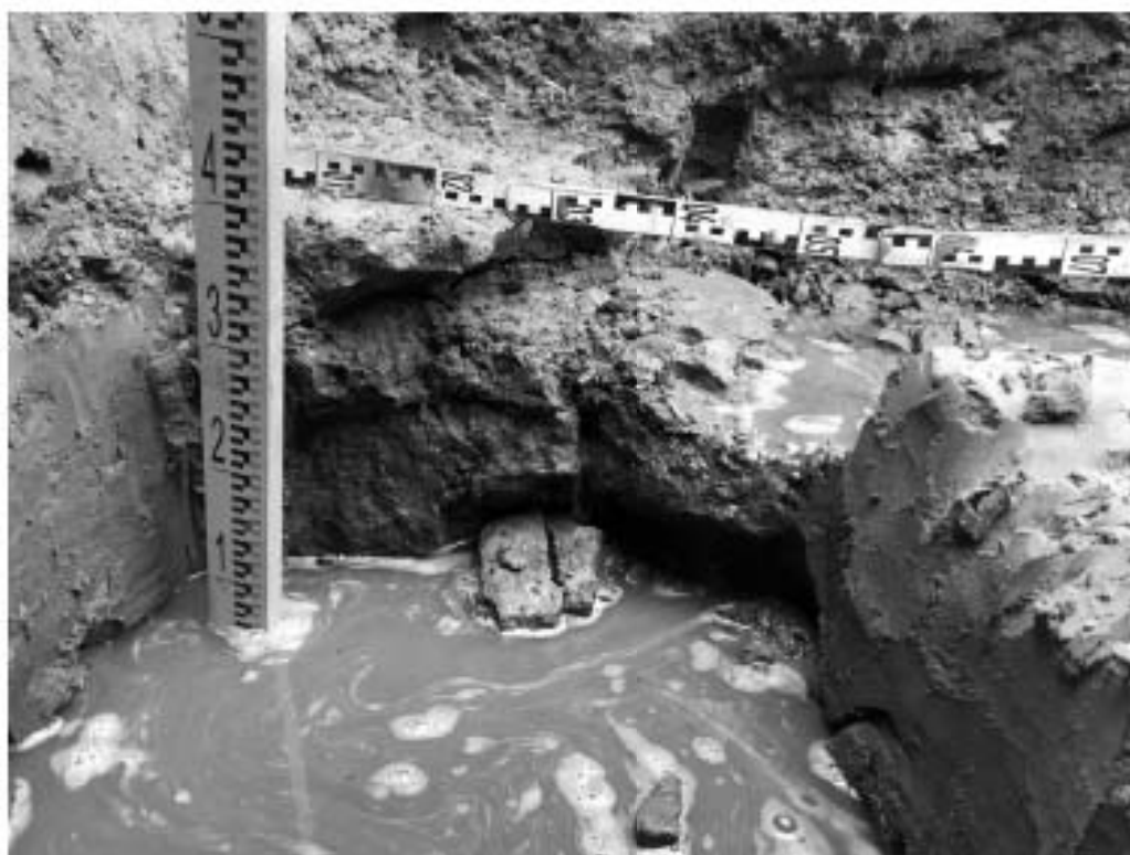
Илл. 45. Санкт-Петербург, ул. Масляный канал. Археологическая разведка. Шурф 1. Подсечка нижней плиты фундамента в прокопе материка. Вид с СВ.
