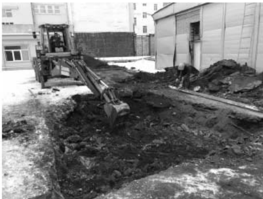
Илл. 31. Санкт-Петербург, Новгородская ул., д. 8, лит. А. Место закладки разведочного раскопа. Вскрышные работы. Вид с юга.
