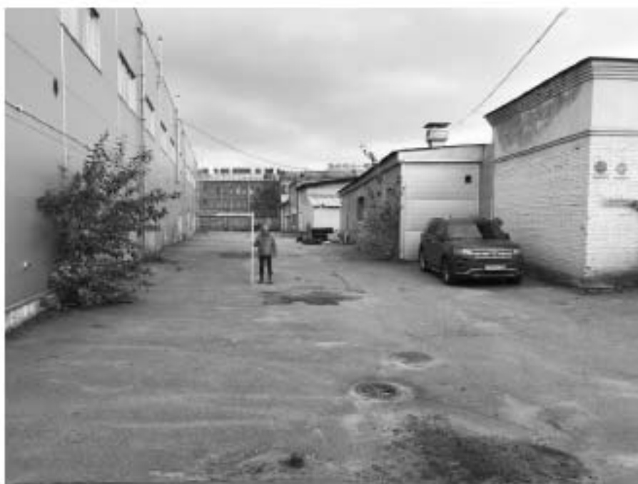
Илл. 4. Санкт-Петербург, Новгородская ул., д. 8, лит. А. Точка фотофиксации 1. Вид с северо-востока.
