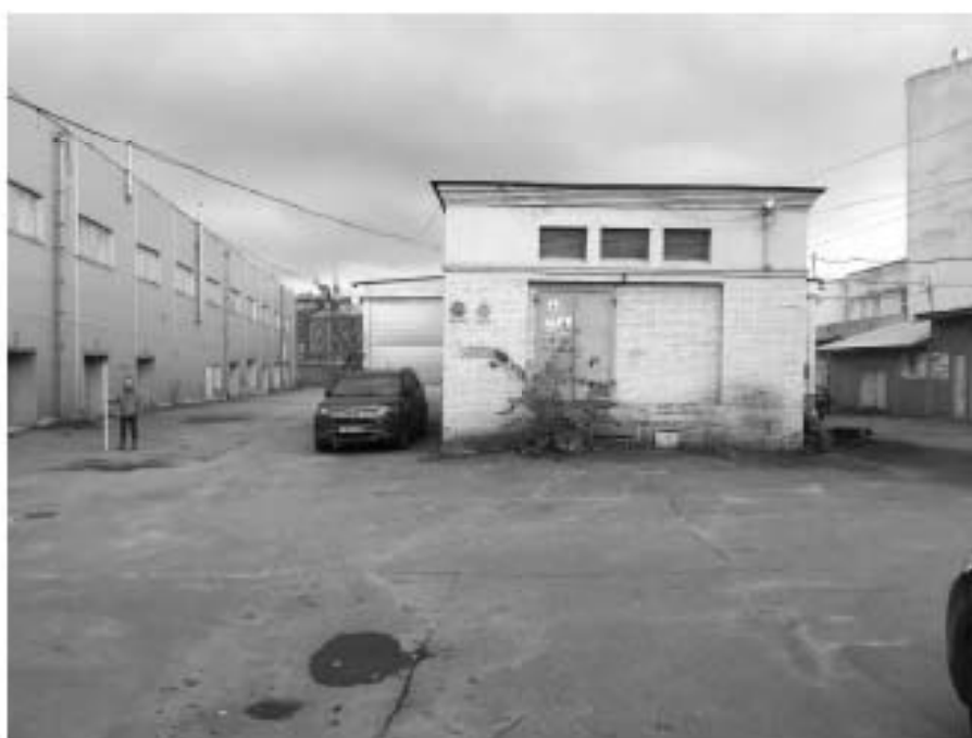
Илл. 5. Санкт-Петербург, Новгородская ул., д. 8, лит. А. Точка фотофиксации 2. Вид с северо-востока.
