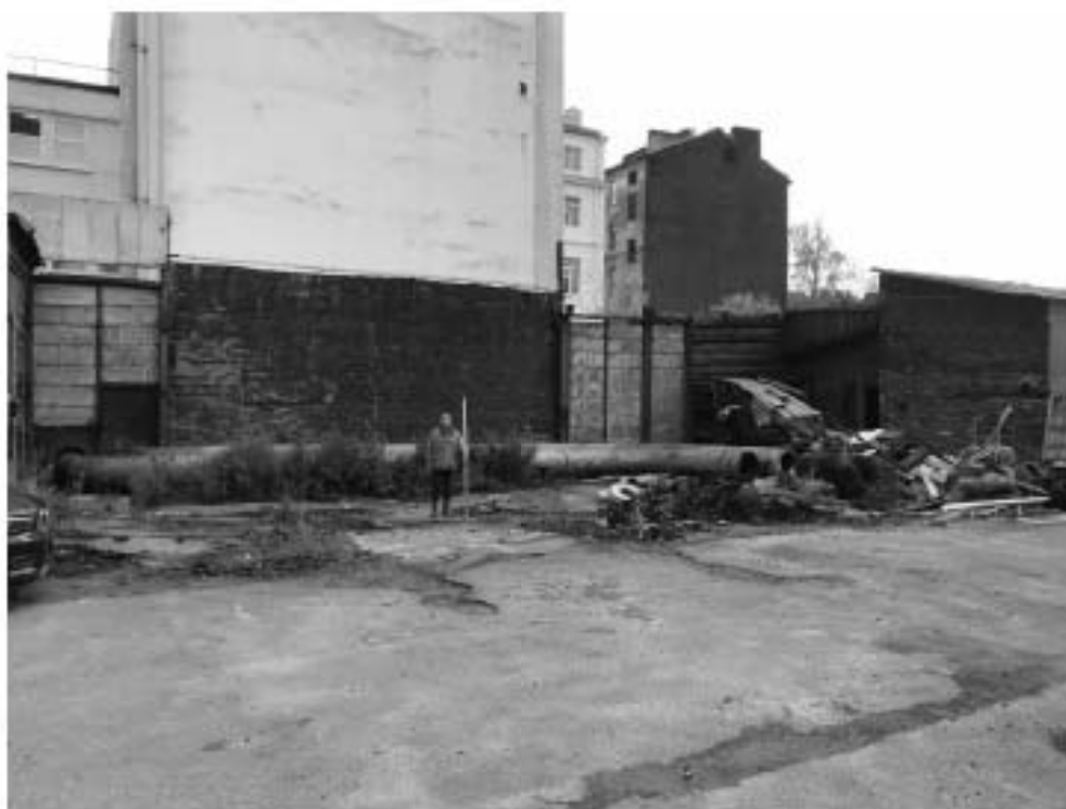
Илл. 10. Санкт-Петербург, Новгородская ул., д. 8, лит. А. Точка фотофиксации 7. Вид с юга.
