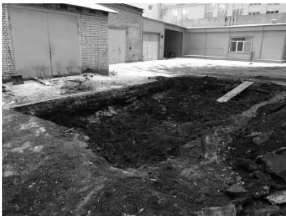
Илл. 31. Санкт-Петербург, Новгородская ул., д. 8, лит. А. Место закладки разведочного раскопа после завершения вскрыши. Вид с востока.
