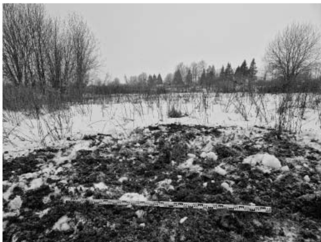
Рис. 45. СПб-2022. Пушкинский район. Пушкин. Территория северо-западнее Гатчинского шоссе. Шурф 7. Рекультивация. Вид с востока
