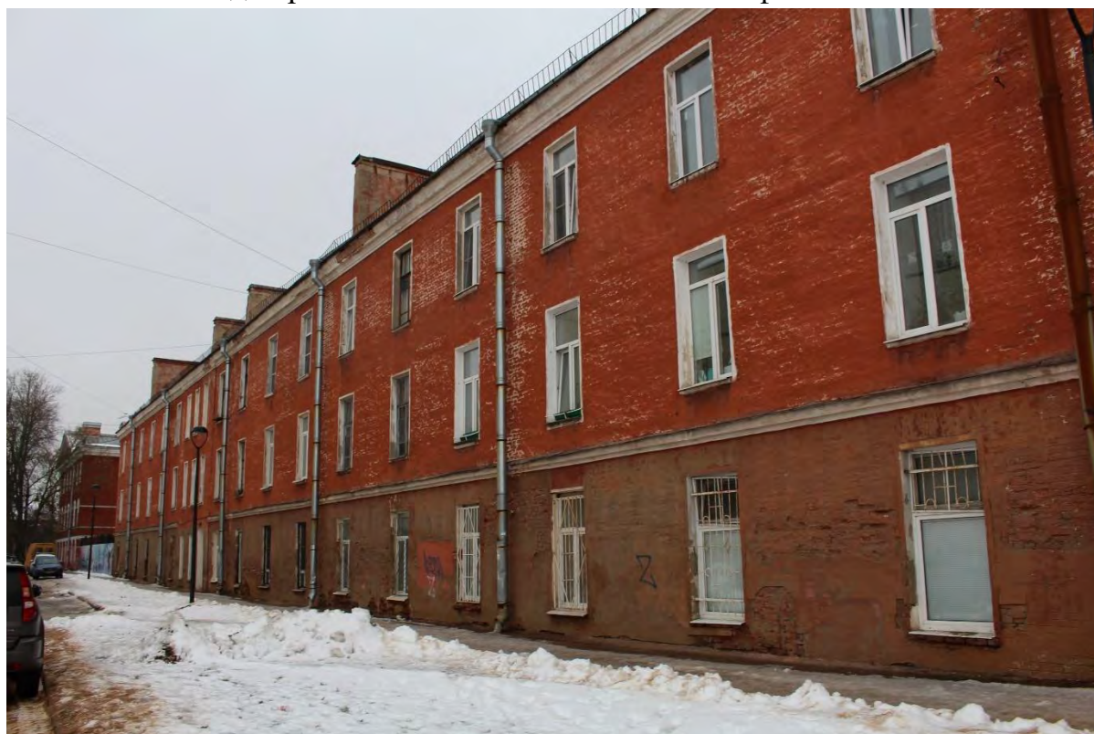
Фото 6. Вид на восточный фасад здания по адресу: Санкт-Петербург, г. Кронштадт, Флотская ул., 2, входящего в состав объекта культурного наследия регионального значения «Шесть флигелей».
