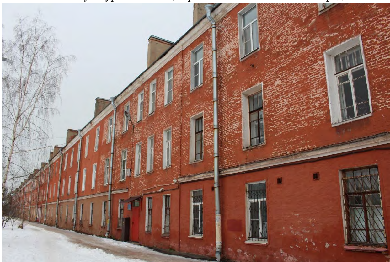
Фото 2. Вид на восточный фасад здания по адресу: Санкт-Петербург, г. Кронштадт, Флотская ул., 2, входящего в состав объекта культурного наследия регионального значения «Шесть флигелей».
