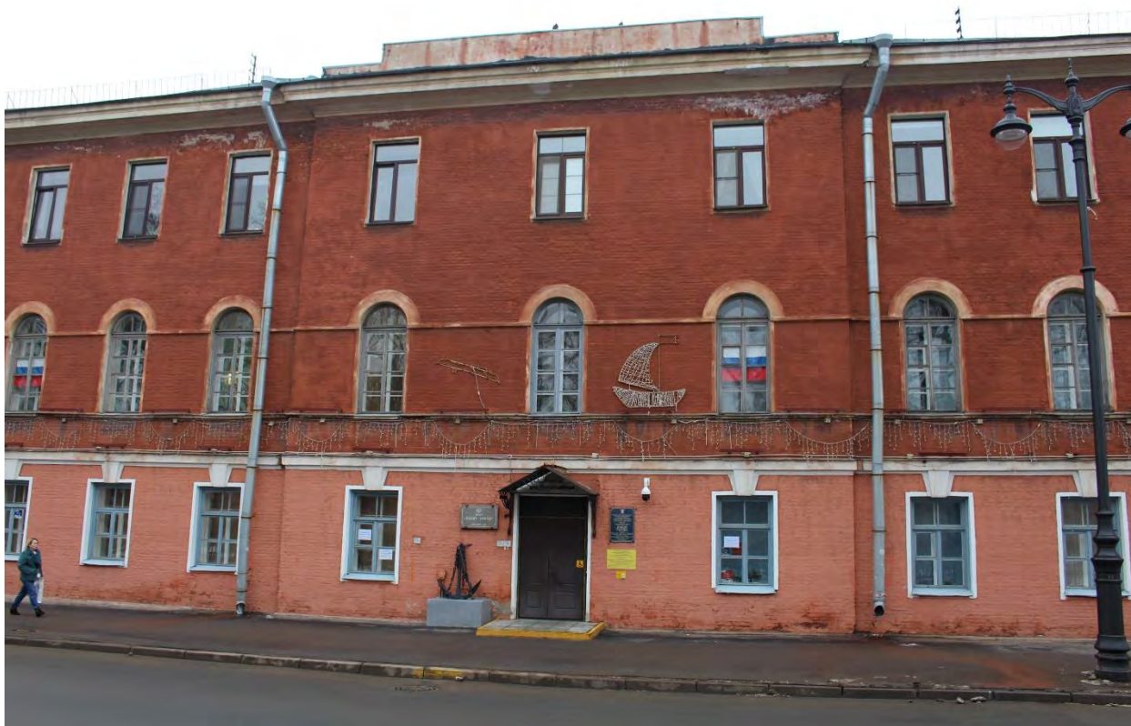
Фото 34. Вид на южный фасад здания по адресу: Санкт-Петербург, г. Кронштадт, Советская ул., 39, входящего в состав объекта культурного наследия регионального значения «Пять флигелей».
