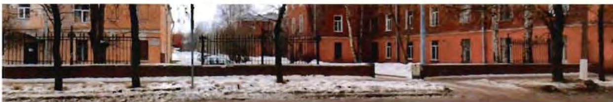
7–8. Часть объекта культурного наследия. Общий вид ограды между зданиями, расположенными по адресу: Флотская ул., 10А, 12А (согласно Закону Санкт-Петербурга № 174-27 от 05.07.1999: Флотская ул., 10, 12)
