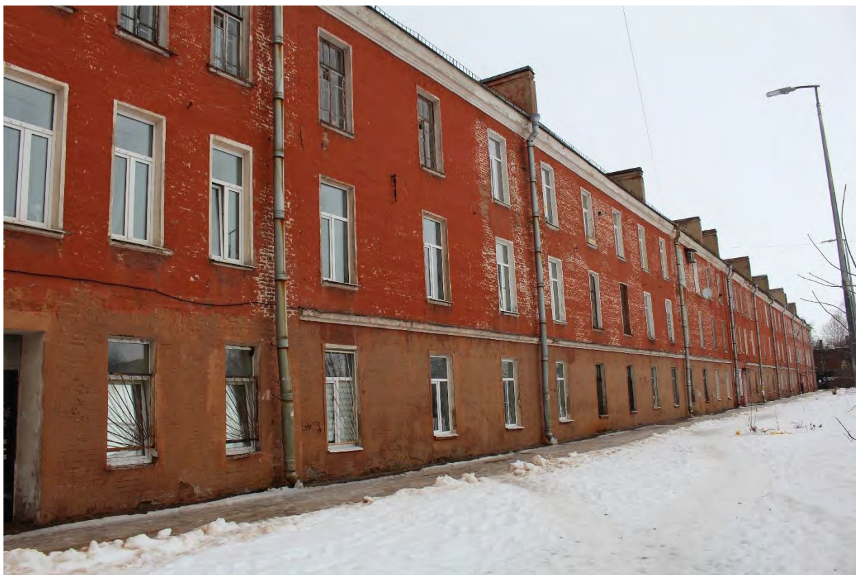
Фото 5. Вид на восточный фасад здания по адресу: Санкт-Петербург, г. Кронштадт, Флотская ул., 2, входящего в состав объекта культурного наследия регионального значения «Шесть флигелей».
