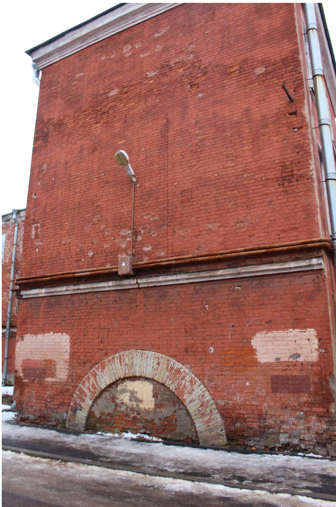
Фото 15. Вид на западный фасад ризалита здания по адресу: Санкт-Петербург, г. Кронштадт, Флотская ул., 2, входящего в состав объекта культурного наследия регионального значения «Шесть флигелей».
