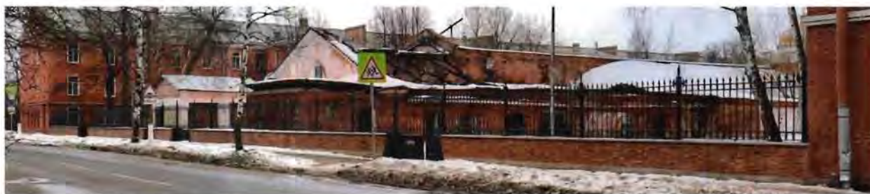
1. Часть объекта культурного наследия. Общий вид ограды между зданиями, расположенными по адресу: Флотская ул., 2А, 4А (согласно Закону Санкт-Петербурга № 174-27 от 05.07.1999: Флотская ул., 2, 4)
