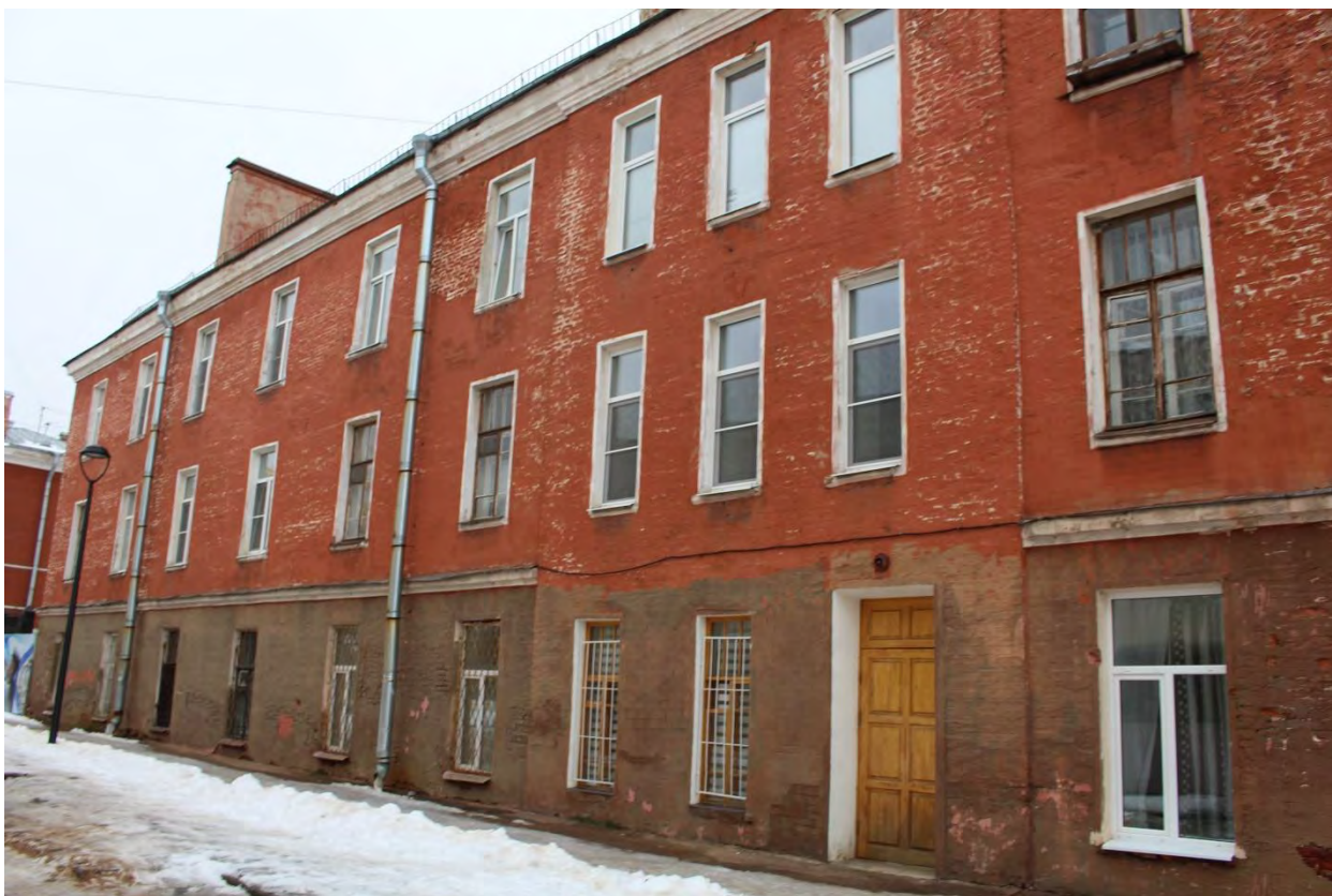
Фото 7. Вид на восточный фасад здания по адресу: Санкт-Петербург, г. Кронштадт, Флотская ул., 2, входящего в состав объекта культурного наследия регионального значения «Шесть флигелей».
