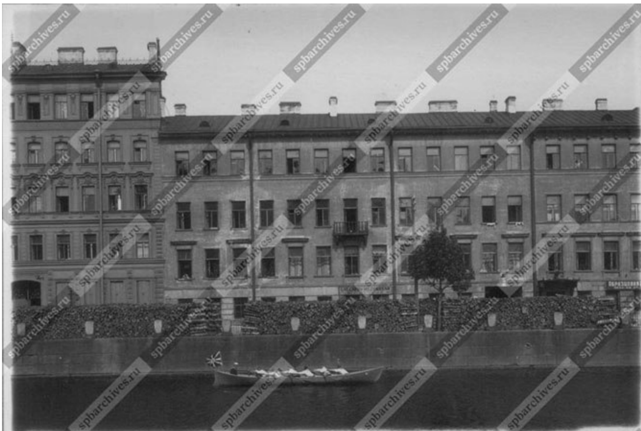
Илл. 11. ЦГАКФФД СПб, Гр 65887. Вид на лицевой фасад со стороны наб.р. Фонтанки. Съемка 1926 г.
