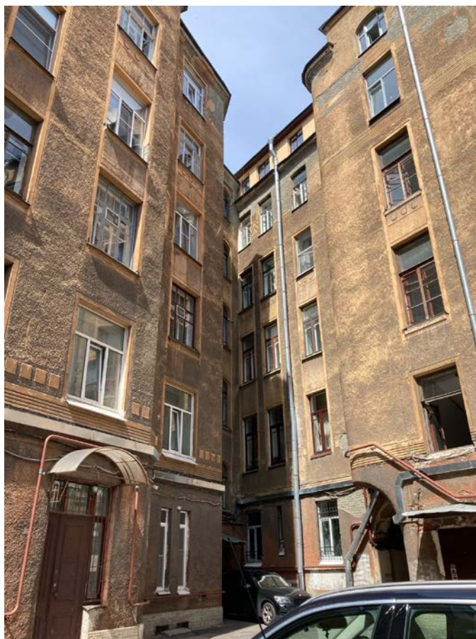
Фото 9. Фрагмент дворового фасада объекта культурного наследия регионального значения «Дом Л.Л. Кенига»
