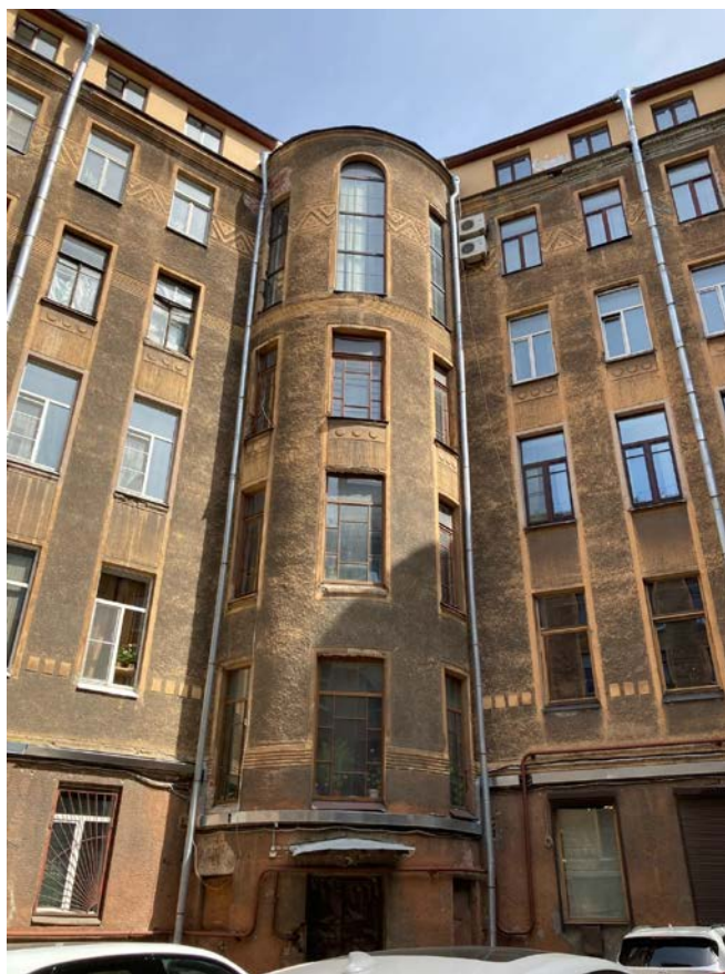
Фото 11. Фрагмент дворового фасада объекта культурного наследия регионального значения «Дом Л.Л. Кенига»
