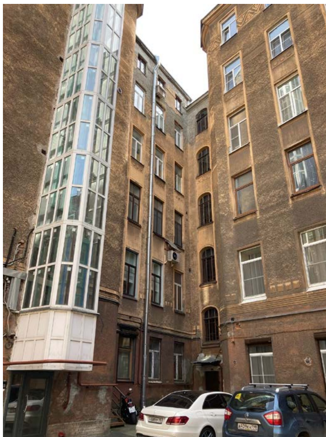
Фото 13. Фрагмент дворового фасада объекта культурного наследия регионального значения «Дом Л.Л. Кенига»
