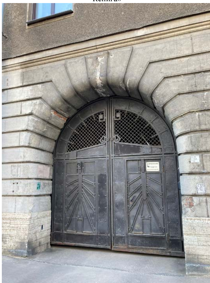
Фото 2. Фрагмент лицевого фасада объекта культурного наследия регионального значения «Дом Л.Л. Кенига», воротный проезд
