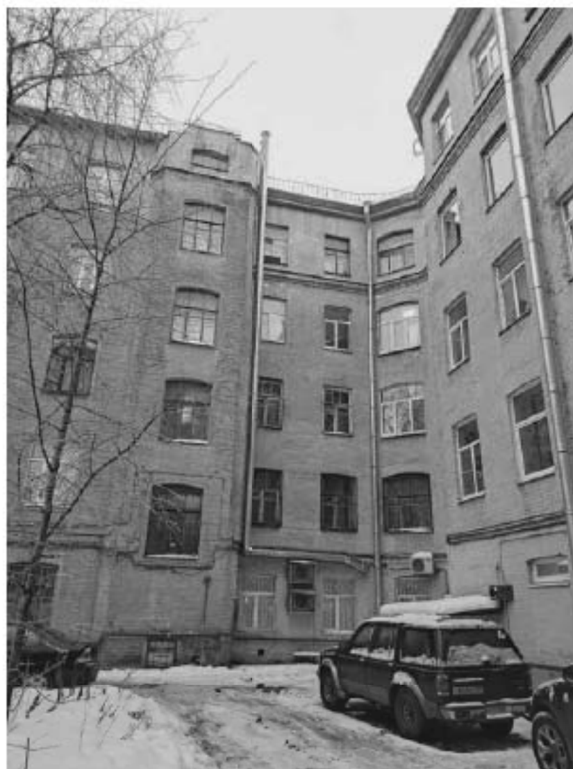
Фото 3. Фрагмент дворового фасада выявленного объекта культурного наследия «Дом Б.Е. Фурмана», по адресу: Санкт-Петербург, ул. Смольчкова, д. 15-17, лит. А (от 02.11.2022)
