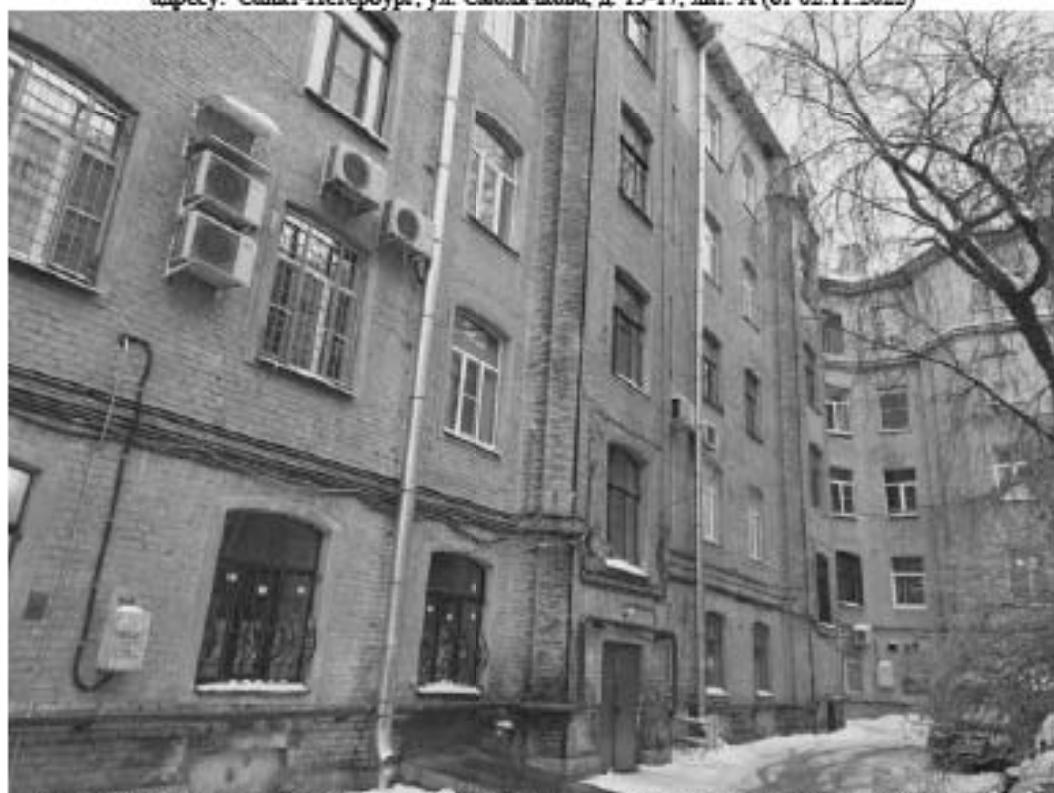
Фото 2. Фрагмент дворового фасада выявленного объекта культурного наследия «Дом Б.Е. Фурмана», по адресу: Санкт-Петербург, ул. Смольчкова, д. 15-17, лит. А (от 02.11.2022)
