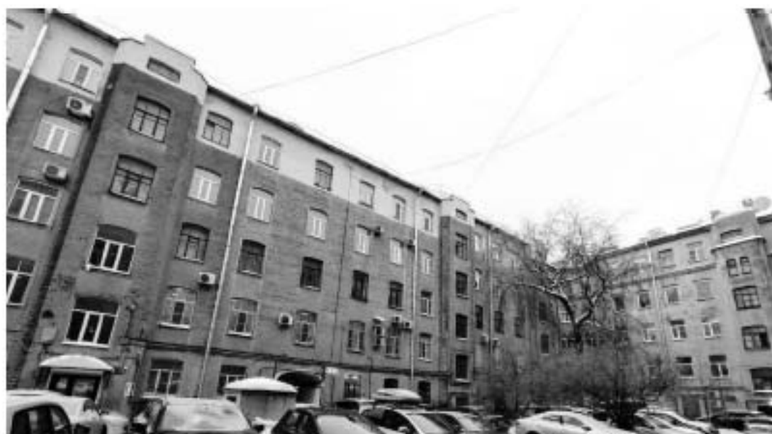
Фото 7 Фрагмент дворового фасада выявленного объекта культурного наследия «Дом Б.Е.Фурмана», по адресу: Санкт-Петербург, ул. Смольчкова, д. 15-17, лит. А (от 07.12.2022)
