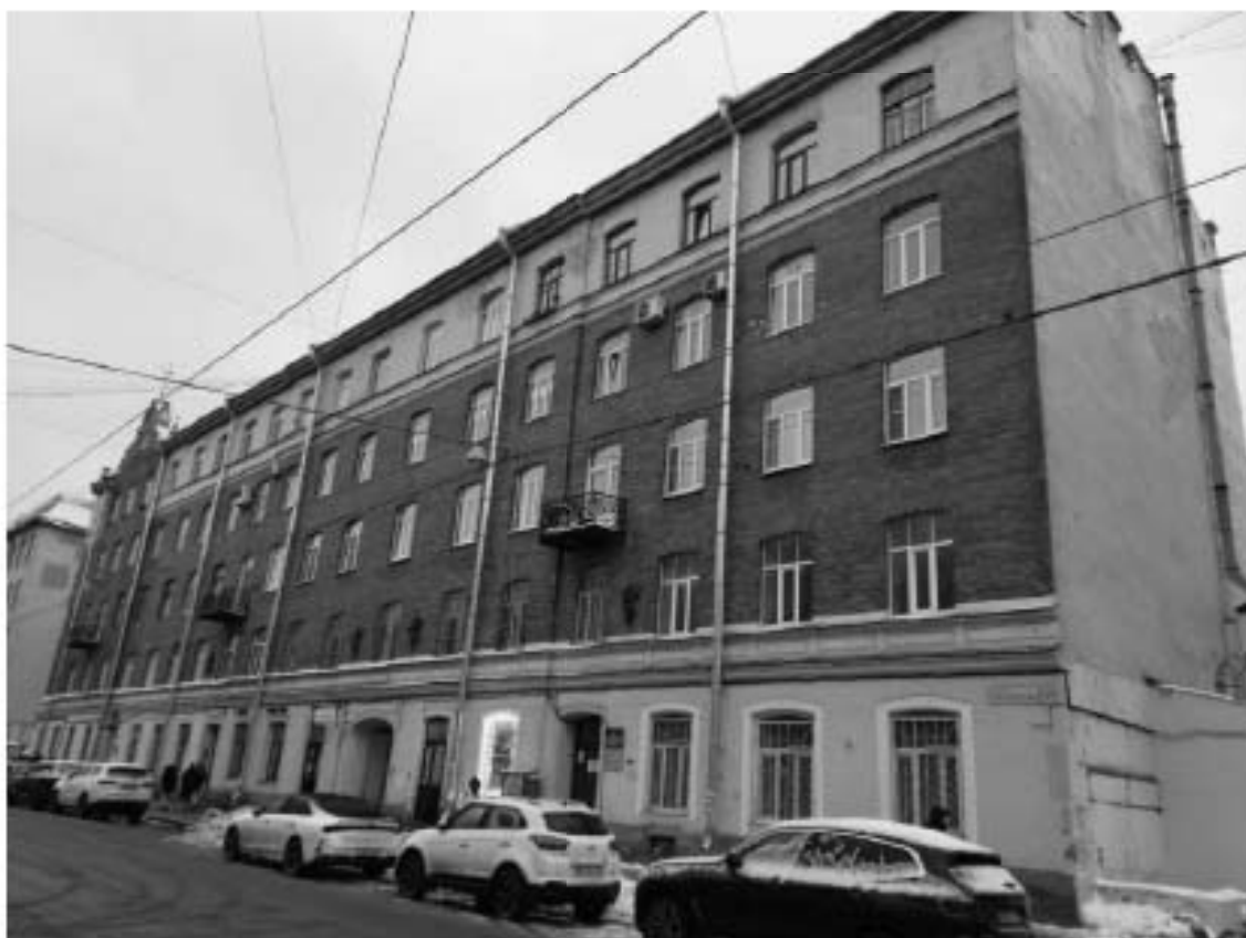
Фото 5 Лицевой фасад выявленного объекта культурного наследия «Дом Б.Е.Фурмана», по адресу: Санкт-Петербург, ул. Смольчкова, д. 15-17, лит. А (от 07.12.2022)
