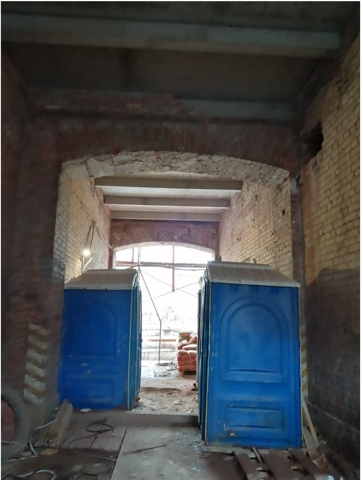
Фото 3. Объект «Производственный корпус» в составе ансамбля, объекта культурного наследия регионального значения «Постройки мебельно-столярной фабрики Ф.А.Мельцера», расположенного по адресу: Санкт-Петербург, наб. реки Карповки, дом 27, литера Б (Б4). Арочный проем.
