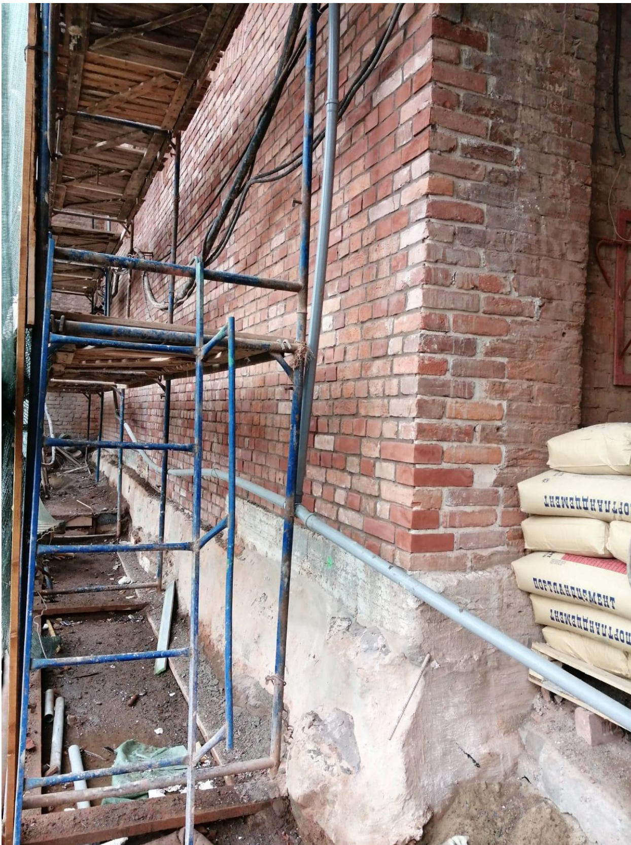
Фото 7. Объект «Производственный корпус» в составе ансамбля, объекта культурного наследия регионального значения «Постройки мебельно-столярной фабрики Ф.А.Мельцера», расположенного по адресу: Санкт-Петербург, наб. реки Карповки, дом 27, литера Б (Б4). Дворовый фасад, фрагмент, слева от арки.
