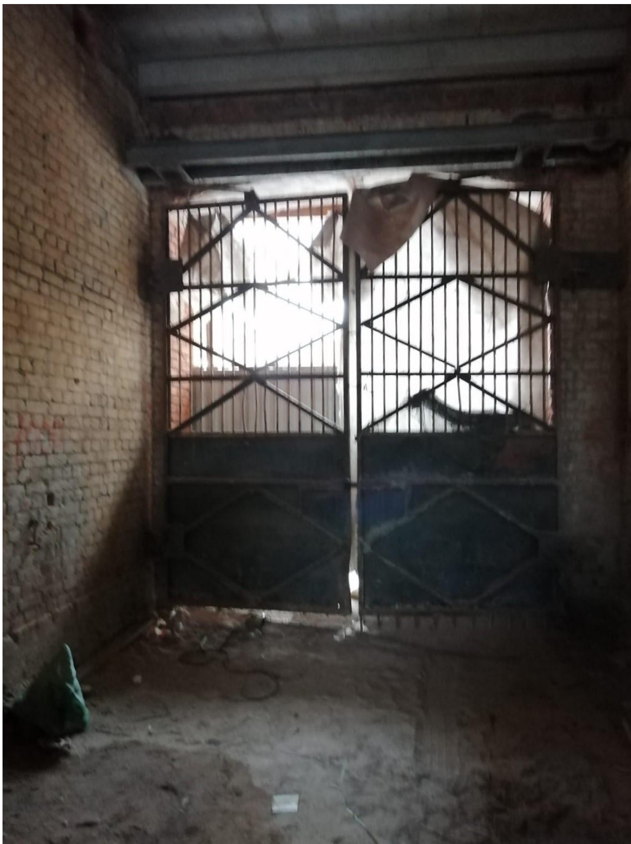
Фото 4. Объект «Производственный корпус» в составе ансамбля, объекта культурного наследия регионального значения «Постройки мебельно-столярной фабрики Ф.А.Мельцера», расположенного по адресу: Санкт-Петербург, наб. реки Карповки, дом 27, литера Б (Б4). Арочный проем здания, воротное заполнение.
