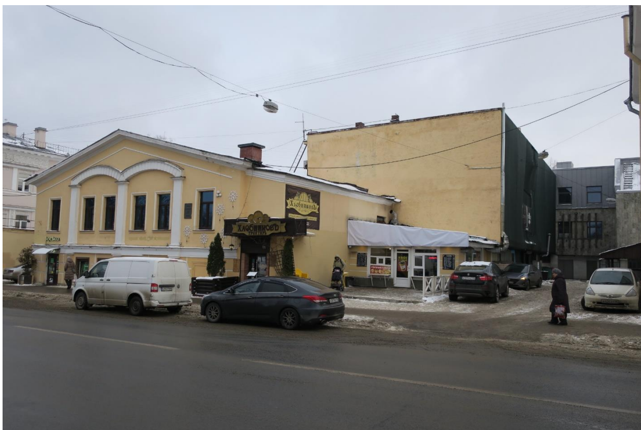
3. Вид на северо-западный фасад объекта культурного наследия регионального значения «Ансамбль домов по ул. Коминтерна. Дом Емельянова (Хлебникова)», расположенного по адресу: Санкт-Петербург, г. Пушкин, Оранжерейная ул., д. 21, литера А, и зону производства работ. 01.03.2023
