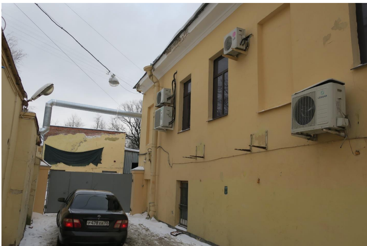
б. Вид на северо-западный фасад объекта культурного наследия регионального значения «Ансамбль домов по ул. Коминтерна. Дом Емельянова (Хлебникова)», расположенного по адресу: Санкт-Петербург, г. Пушкин, Оранжерейная ул., д. 21, литера А. Фрагмент. 01.03.2023
