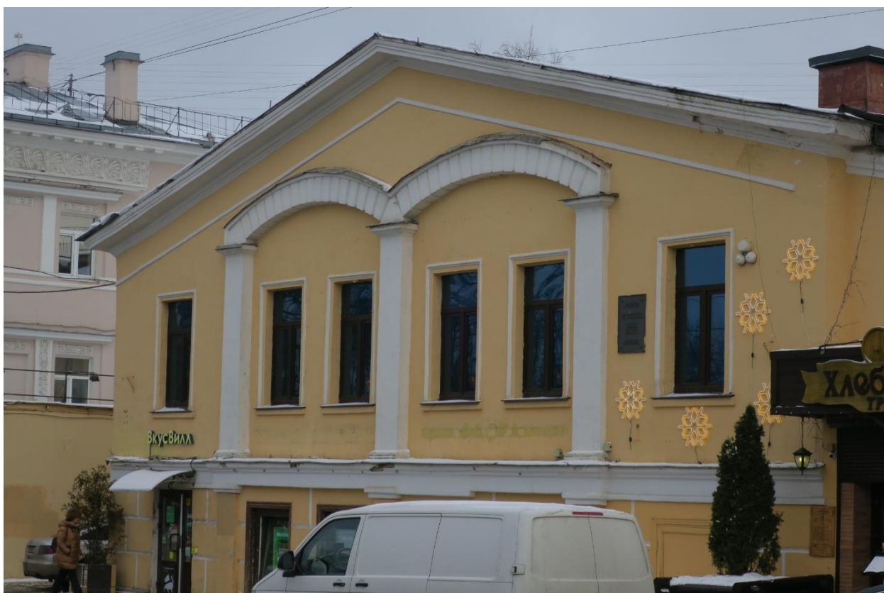
5. Вид на северо-западный фасад объекта культурного наследия регионального значения «Ансамбль домов по ул. Коминтерна. Дом Емельянова (Хлебникова)», расположенного по адресу: Санкт-Петербург, г. Пушкин, Оранжерейная ул., д. 21, литера А. Фрагмент. 01.03.2023
