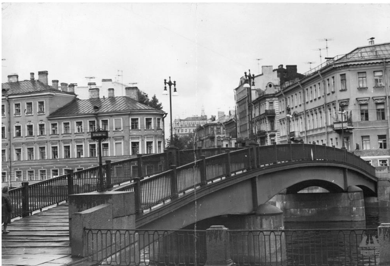
Илл. 13. Вид на Английский мост. 1963-1970-е гг. (источник: https://mostotrest-spb.ru/bridges/anglijskij ).
