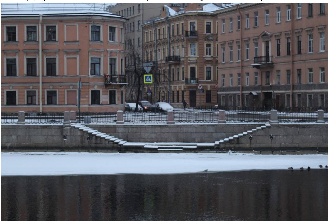
Фото 10. Вид на спуск № 15 левобережной части объекта культурного наследия федерального значения «Набережные со спусками» с правого берега реки Фонтанки.
