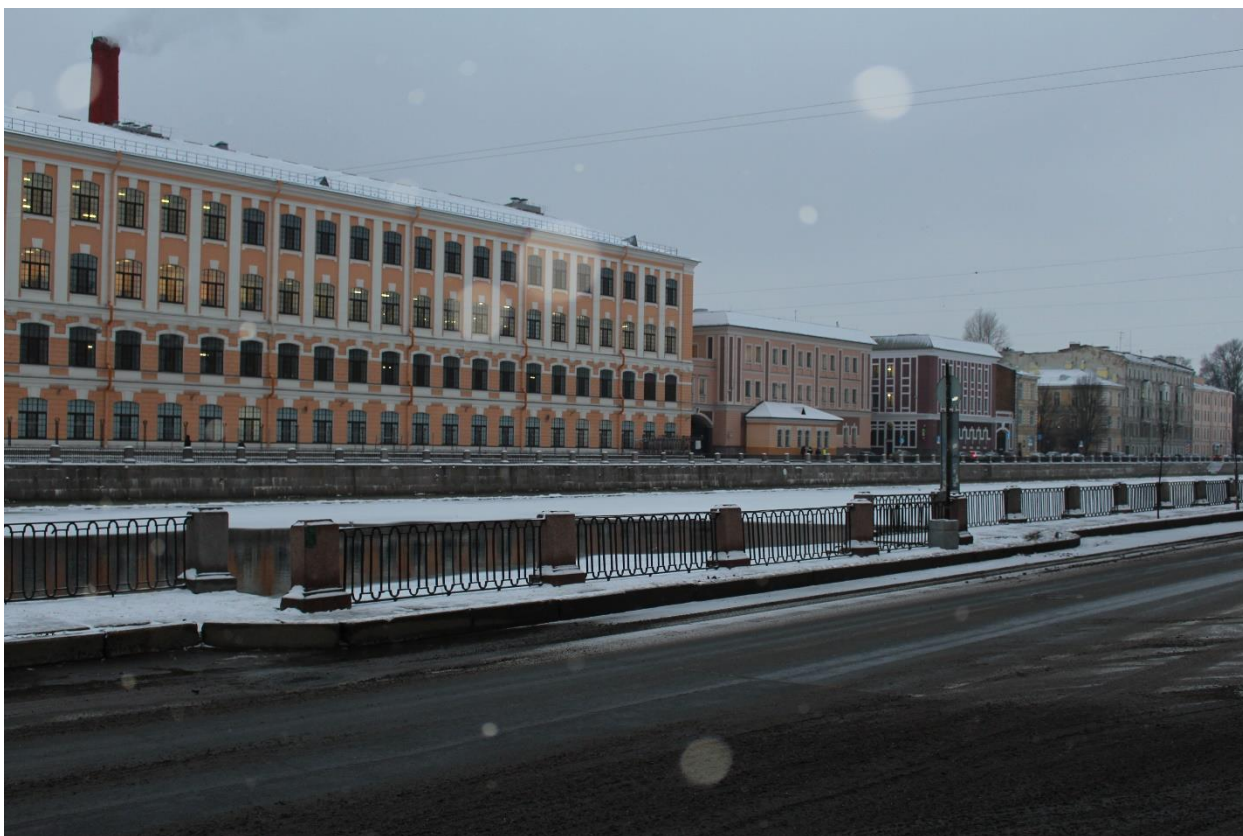
Фото 9. Вид на спуск № 15 левобережной части объекта культурного наследия федерального значения «Набережные со спусками» с северо-востока.
