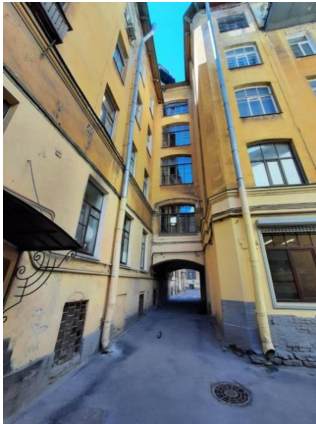
Фото 9 Фрагмент дворового фасада выявленного объекта культурного наследия «Дом Ф.Ф. Шпринга» расположенного по адресу: Санкт-Петербург, пер. Тучков, дом 11/5, литера А (Тучков пер., 11; Волховский пер., 5) (26.09.2022)
