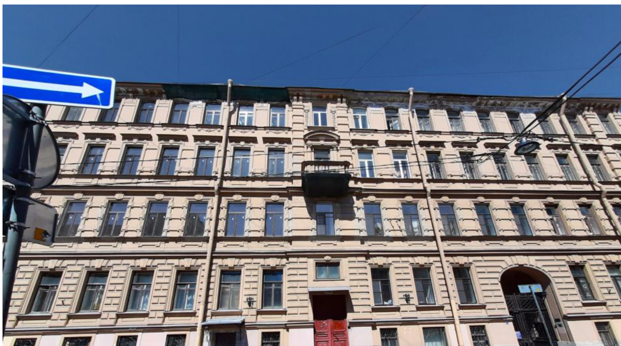
Фото 2 Фрагмент лицевого фасада выявленного объекта культурного наследия «Дом Ф.Ф. Шпринга» расположенного по адресу: Санкт-Петербург, пер. Тучков, дом 11/5, литера А (Тучков пер., 11; Волховский пер., 5) (30.05.2022)
