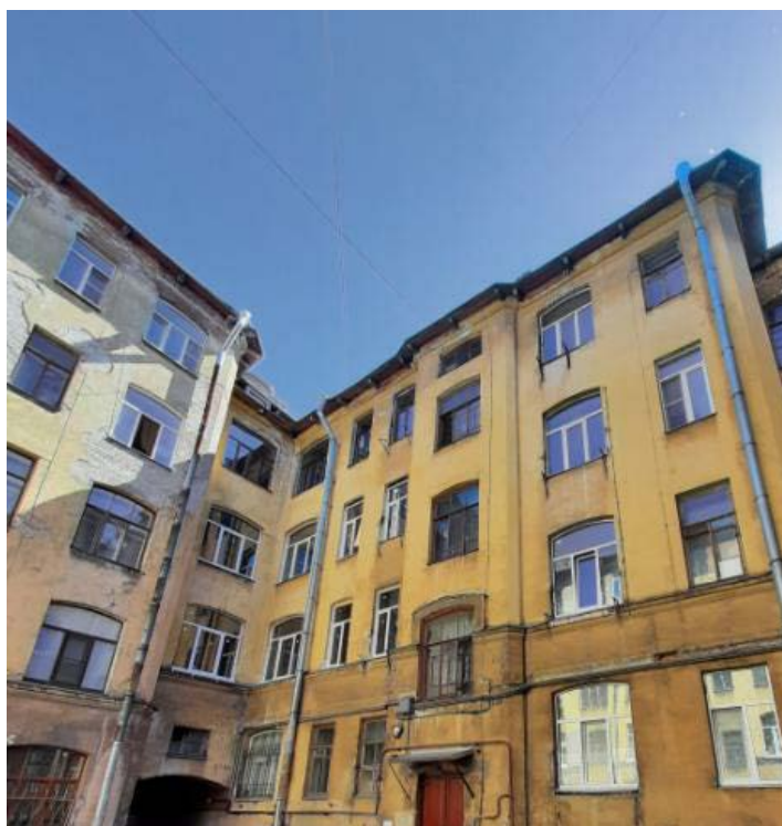
Фото 4 Фрагмент дворового фасада выявленного объекта культурного наследия «Дом Ф.Ф. Шпринга» расположенного по адресу: Санкт-Петербург, пер. Тучков, дом 11/5, литера А (Тучков пер., 11; Волховский пер., 5) (30.05.2022)
