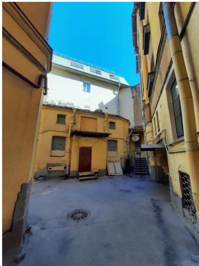
Фото 10 Фрагмент дворового фасада выявленного объекта культурного наследия «Дом Ф.Ф. Шпринга» расположенного по адресу: Санкт-Петербург, пер. Тучков, дом 11/5, литера А (Тучков пер., 11; Волховский пер., 5) (26.09.2022)
