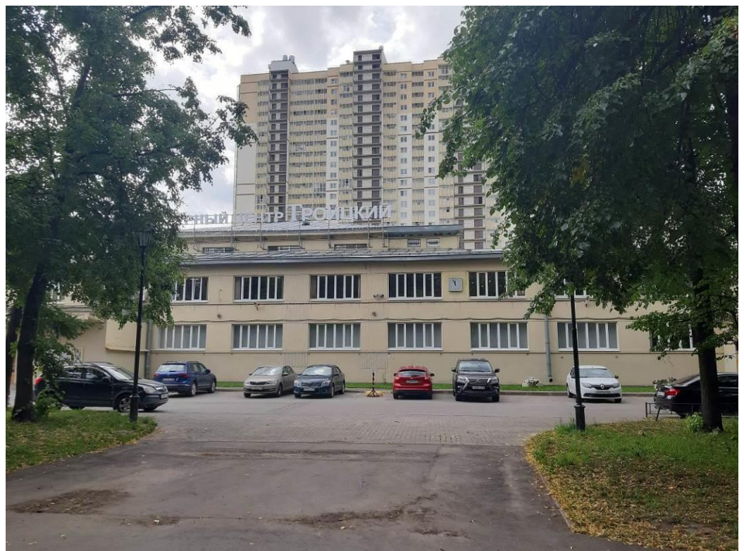
15. Дом культуры им. В.И. Ленина завода «Большевик». Санкт-Петербург, Обуховской Обороны пр., д.223, лит.А. Фото мест расположения оборудования и размещения кабельных трасс. Штиглиц М.С. 05.06.2022.
