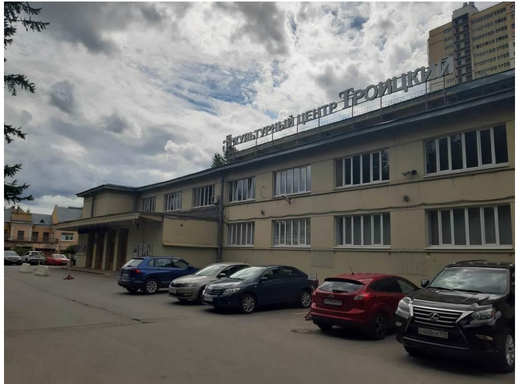
16. Дом культуры им. В.И. Ленина завода «Большевик». Санкт-Петербург, Обуховской Обороны пр., д.223, лит.А. Фото мест расположения оборудования и размещения кабельных трасс. Штиглиц М.С. 05.06.2022.
