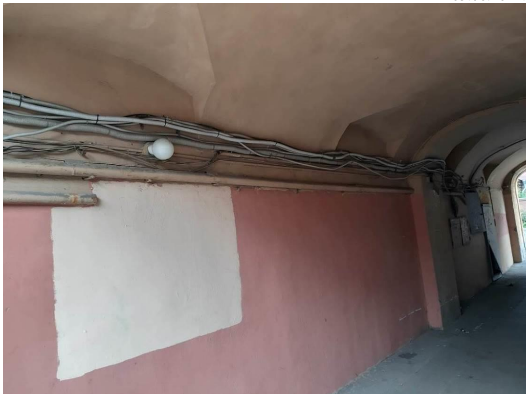
11. Дом, где находилась Смоленская (Корниловская) вечерне-воскресная школа для рабочих Невской заставы. Обуховской Обороны пр., д.107, лит.Б. Фото мест расположения оборудования и размещения кабельных трасс. Штиглиц М.С. 05.06.2022.
