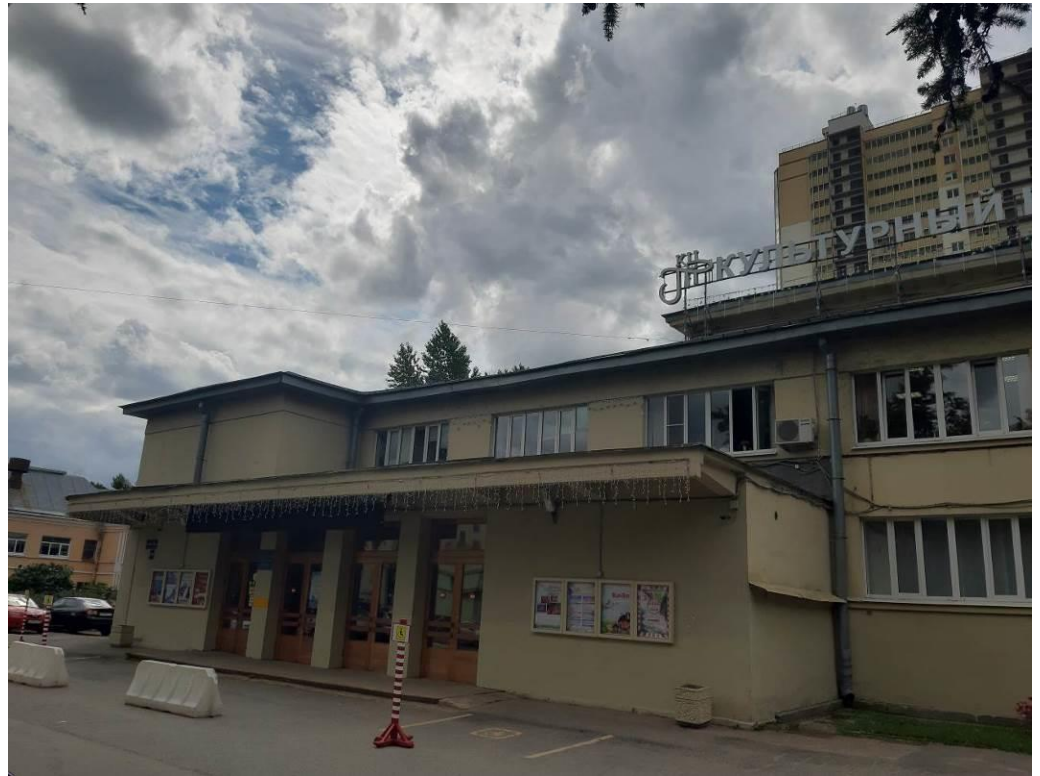
14. Дом культуры им. В.И. Ленина завода «Большевик». Санкт-Петербург, Обуховской Обороны пр., д.223, лит.А. Фото мест расположения оборудования и размещения кабельных трасс. Штиглиц М.С. 05.06.2022.
