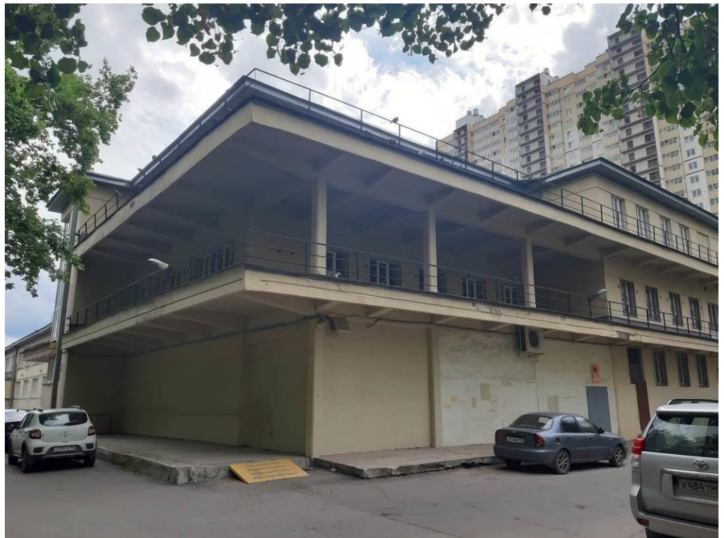
19. Дом культуры им. В.И. Ленина завода «Большевик». Санкт-Петербург, Обуховской Обороны пр., д.223, лит.А. Фото мест расположения оборудования и размещения кабельных трасс. Штиглиц М.С. 05.06.2022.
