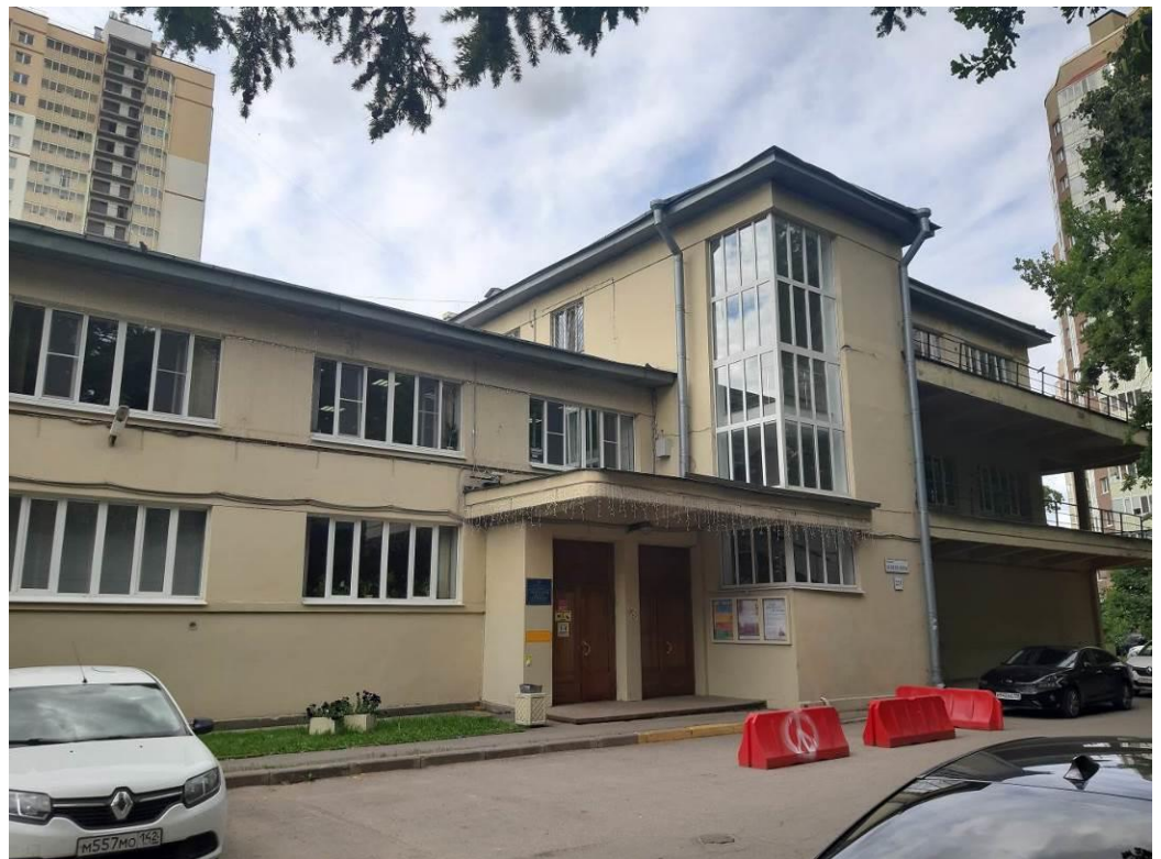
17. Дом культуры им. В.И. Ленина завода «Большевик». Санкт-Петербург, Обуховской Обороны пр., д.223, лит.А. Фото мест расположения оборудования и размещения кабельных трасс. Штиглиц М.С. 05.06.2022.
