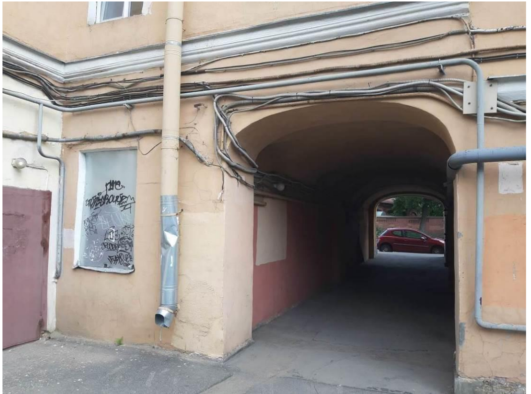
10. Дом, где находилась Смоленская (Корниловская) вечерне-воскресная школа для рабочих Невской заставы. Обуховской Обороны пр., д.107, лит.Б. Фото мест расположения оборудования и размещения кабельных трасс. Штиглиц М.С. 05.06.2022.
