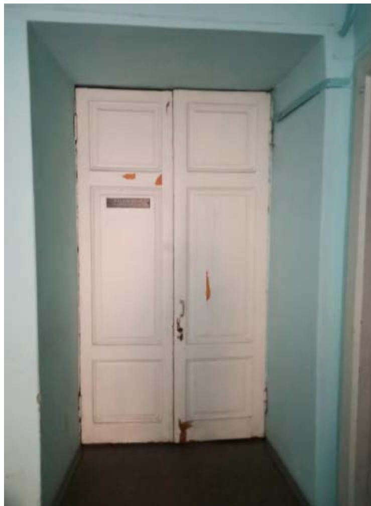
5. Помещение №11 (7-Н) объекта культурного наследия регионального значения «Дом Балашова А.Д. (Стенбок-Фермора)», расположенного по адресу: г. Санкт-Петербург, Макарова наб., д. 26, литера А. 30.08.2021.
