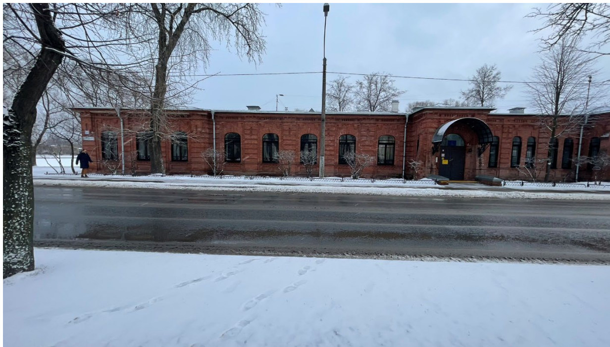
3. Общий вид на ГБУ СШОР «Ижора» по Адмиралтейской улице;
