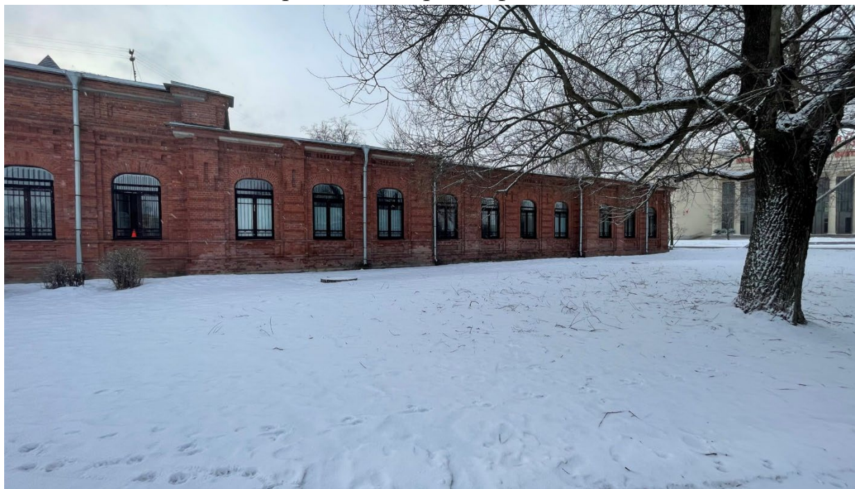
30.Фрагмент северного фасада здания;
