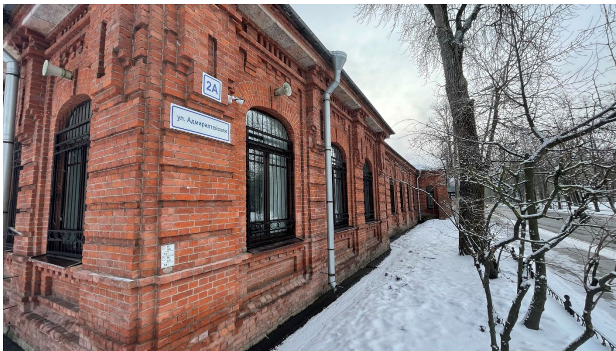
5. Вид на северо-западный фасад здания;
