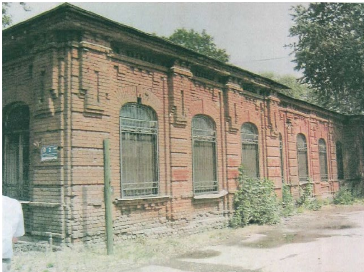
26. Колпино. Бывшая школа Адмиралтейских Ижорских заводов. Южный фасад. Фото 2011 года из «Отчёта об обследовании технического состояния материалов отделки фасадов». Центр технического сопровождения «Рубикон». СПб., 2011.
