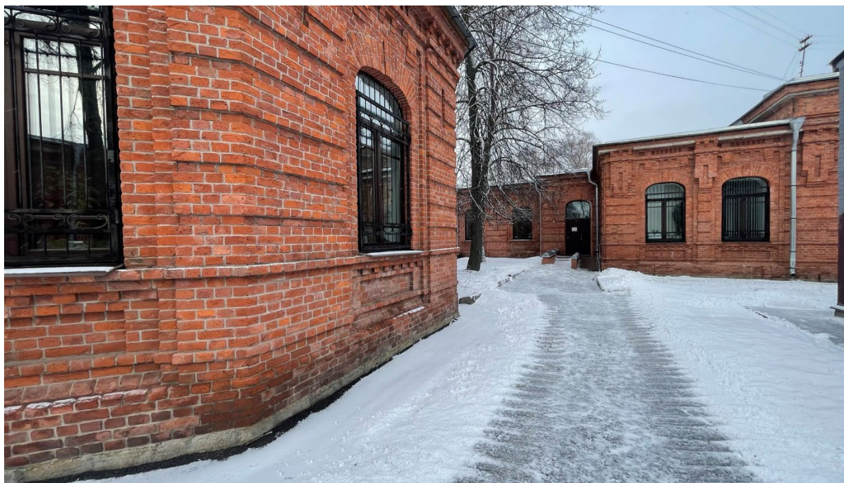
17. Вид на восточный фасад здания;
