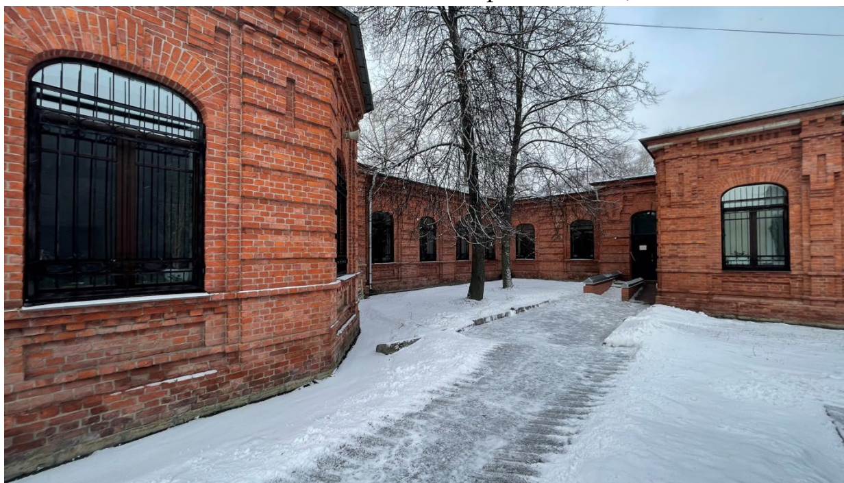
18. Вид на восточный фасад здания;
