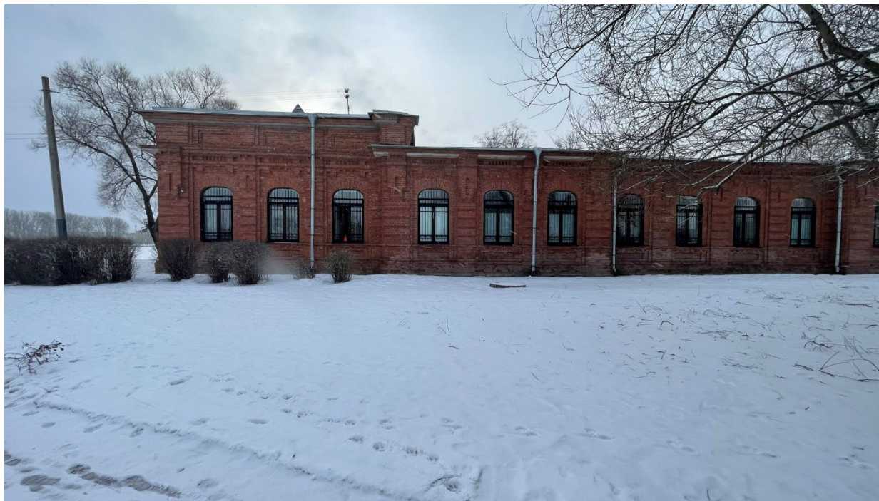
29.Фрагмент северного фасада здания;
