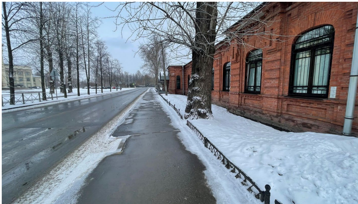
1. Вид на западный фасад здания по Адмиралтейской улице;
