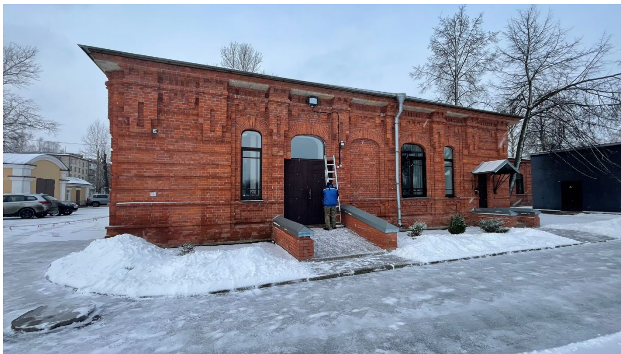
11. Вид на восточный фасад здания;
