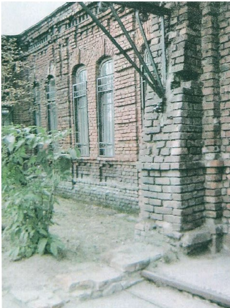
25. Колпино. Бывшая школа Адмиралтейских Ижорских заводов. Фрагмент западного фасада. Фото 2011 года из «Отчёта об обследовании технического состояния материалов отделки фасадов». Центр технического сопровождения «Рубикон». СПб., 2011.
