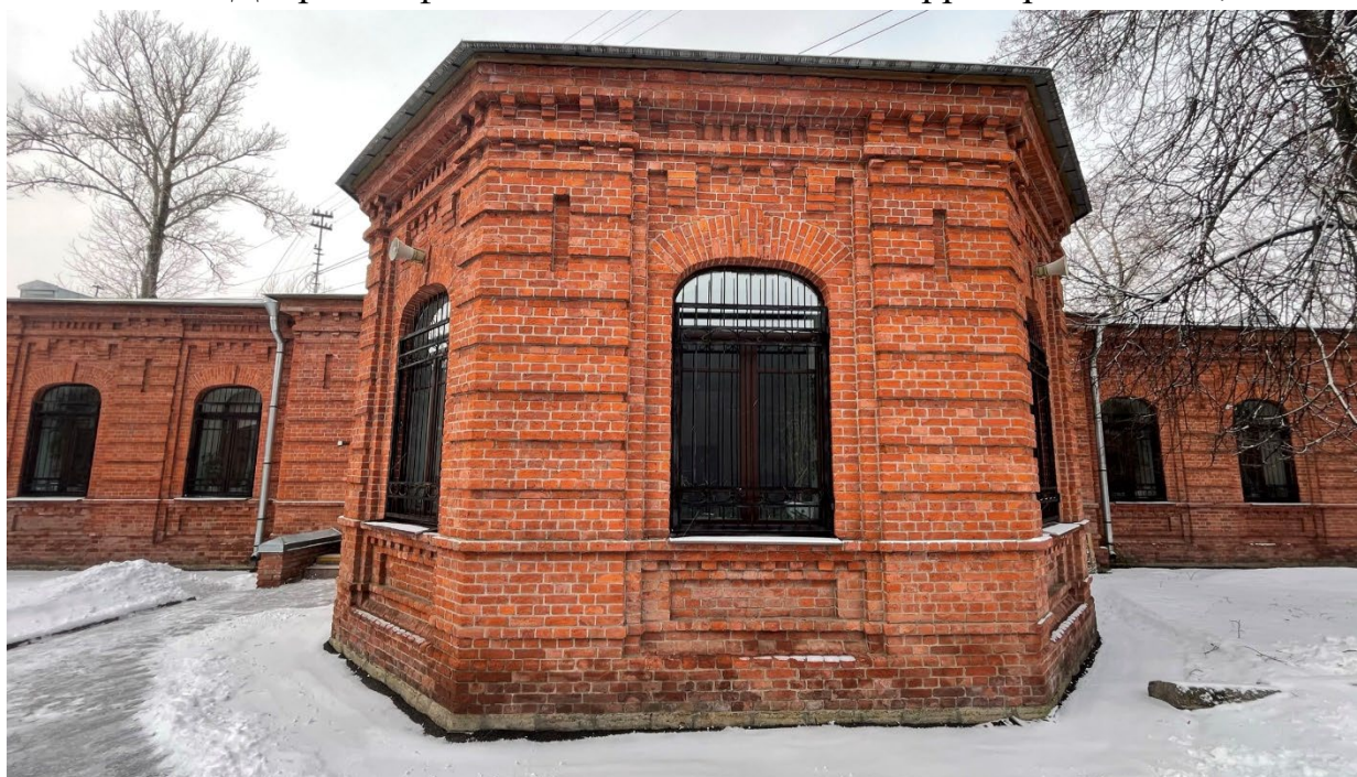
16. Вид на восточный фасад здания;
