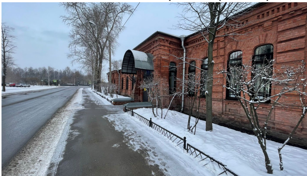
4. Вид на западный фасад здания;
