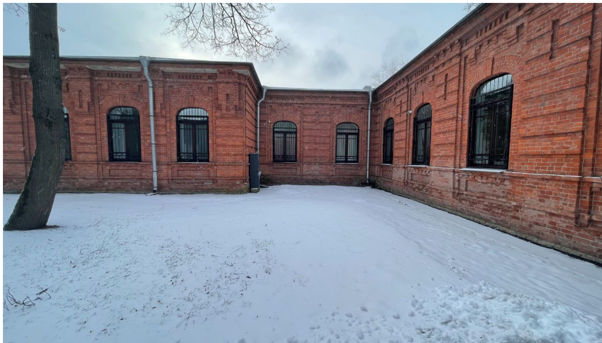
15. Дворовой фасад здания и общий вид территории школы;
