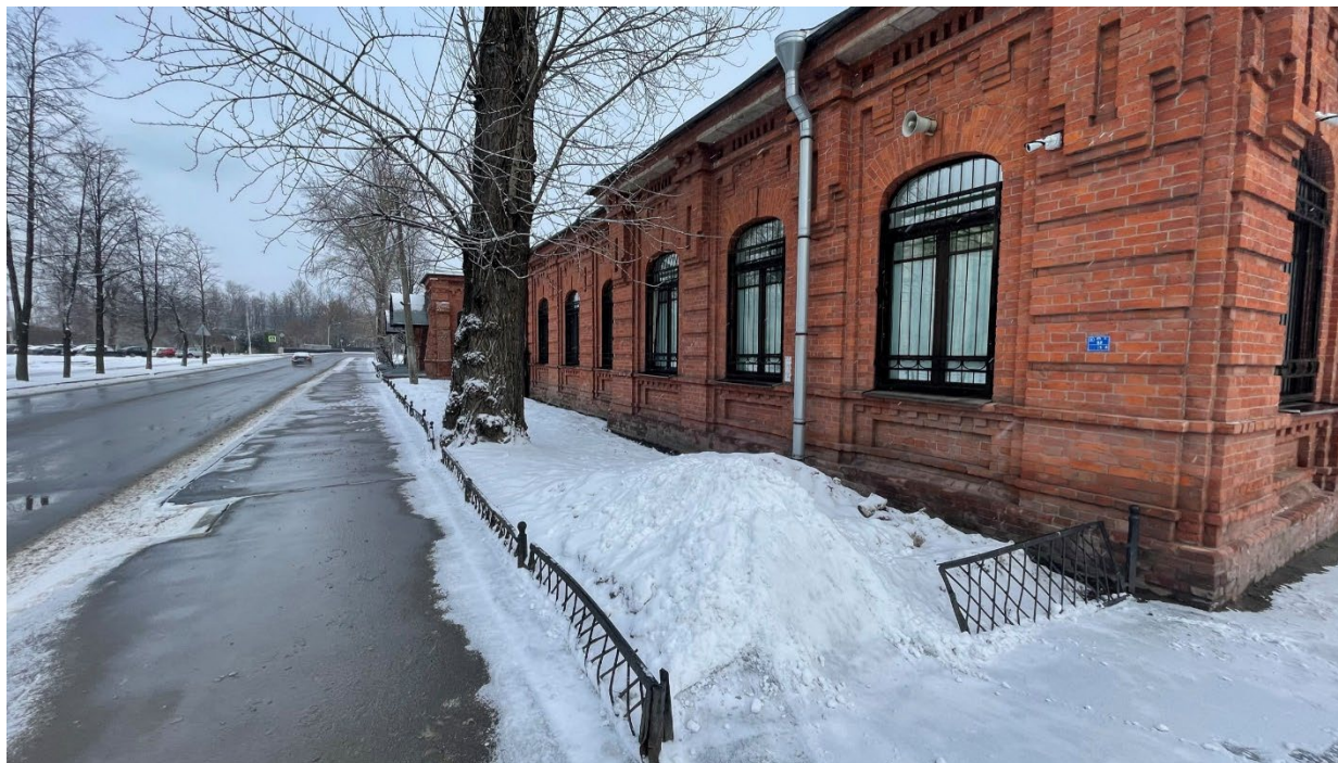
7. Вид на юго-западный фасад здания;
