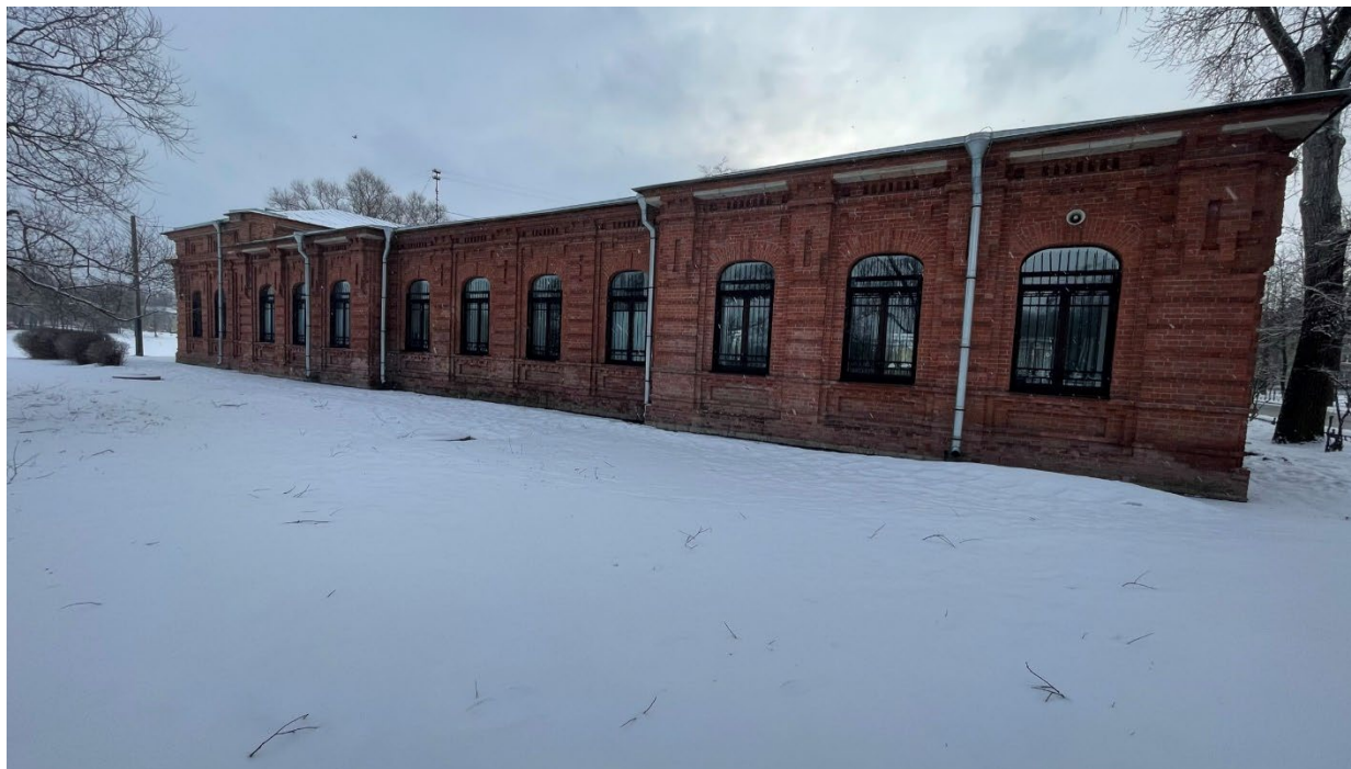
31.Фрагмент северного фасада здания с Адмиралтейской улицы;
