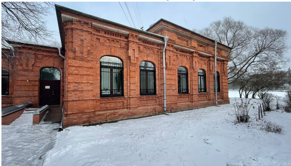
20.Вид на дворовой фасад;
