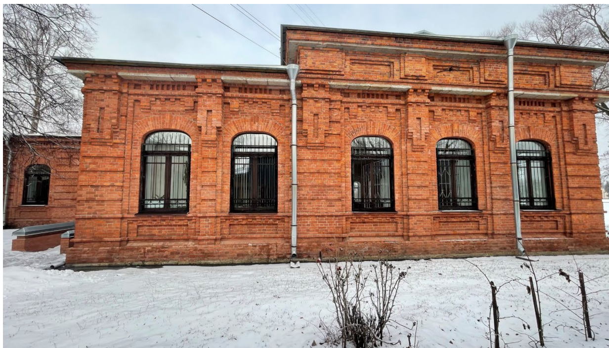
21. Вид на северный дворовой фасад школы;
