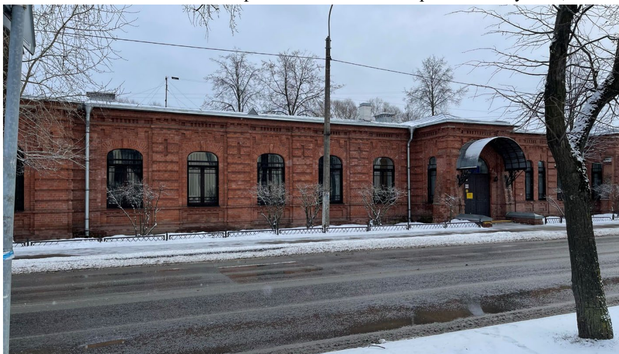
2. Вид на главный фасад здания по Адмиралтейской улице;
