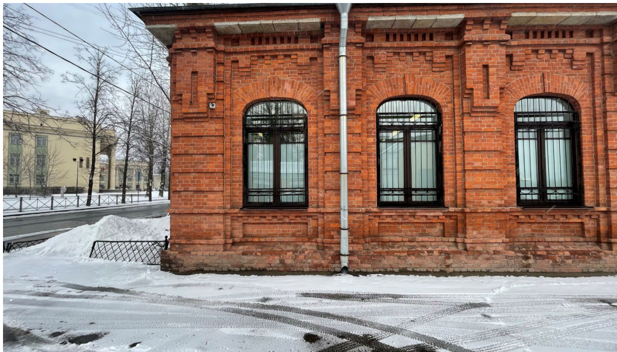
9. Вид на южный фасад здания;
