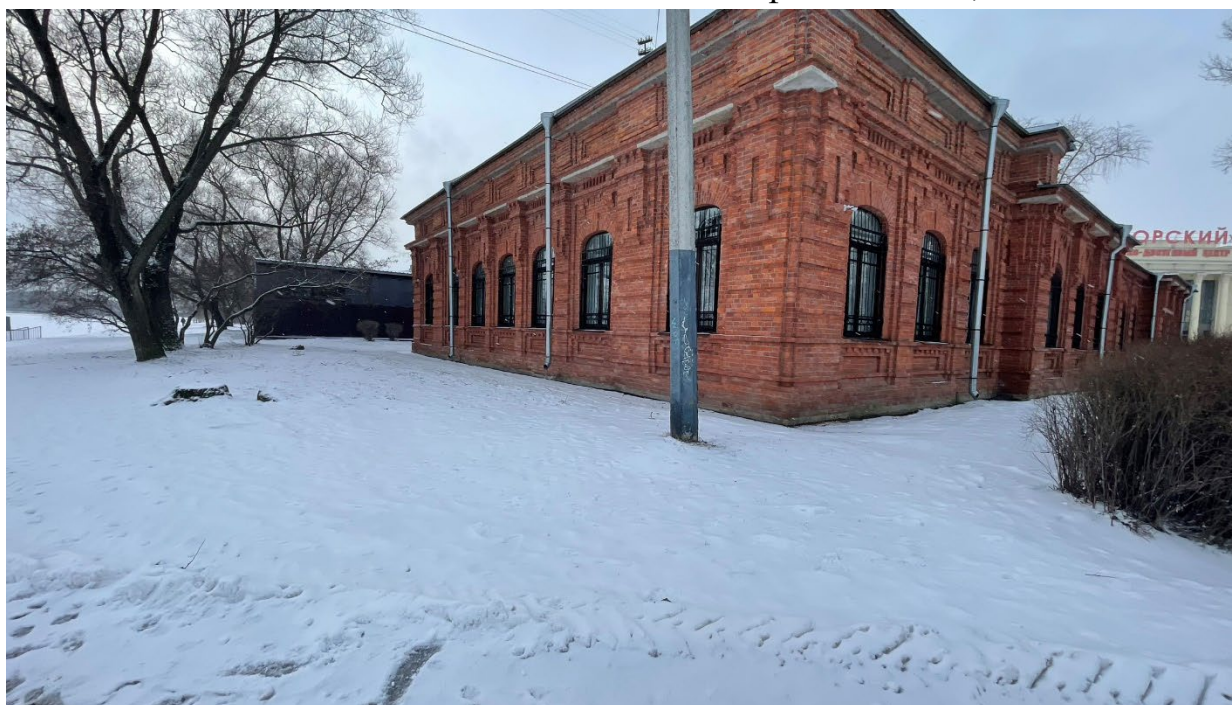
26.Общий вид на северо-восточный фасад здания;
