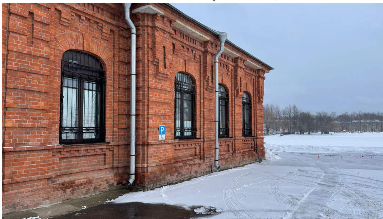
10. Вид на южный фасад здания;
