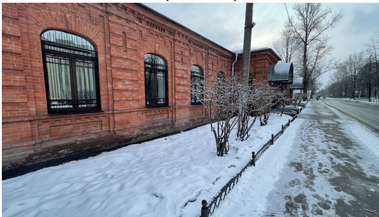
6. Вид на западный фасад здания по Адмиралтейской улице;
