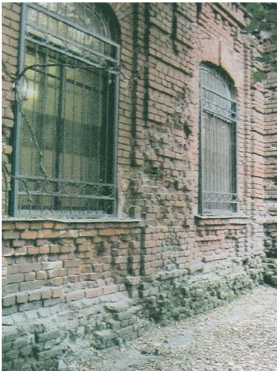
27. Колпино. Бывшая школа Адмиралтейских Ижорских заводов. Участок фасада здания. Фото 2011 года из «Отчёта об обследовании технического состояния материалов отделки фасадов». Центр технического сопровождения «Рубикон». СПб., 2011.
