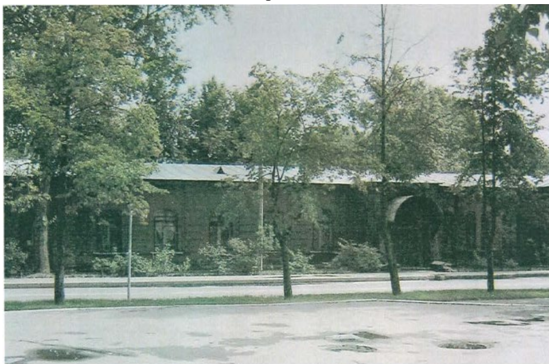
24. Колпино. Бывшая школа Адмиралтейских Ижорских заводов. Западный фасад. Фото 2011 года из «Отчёта об обследовании технического состояния материалов отделки фасадов». Центр технического сопровождения «Рубикон». СПб., 2011.
