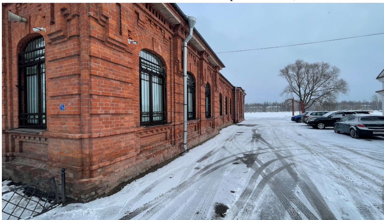
8. Общий вид южного фасада здания;
