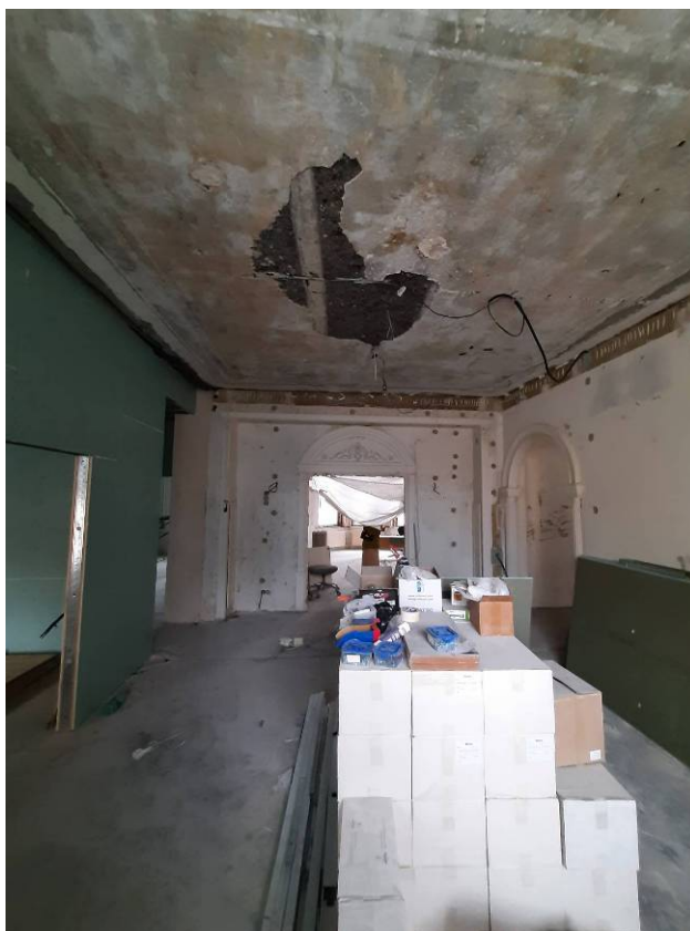
Фото 19. Интерьер квартиры № 6 выявленного объекта культурного наследия «Дом С.А.Визлер (А.Ф.Бубыря)»
