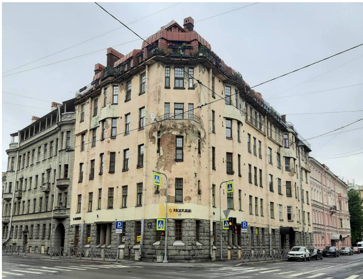
Фото 2. Фрагмент лицевого фасада выявленного объекта культурного наследия «Дом С.А.Визлер (А.Ф.Бубыря)»
