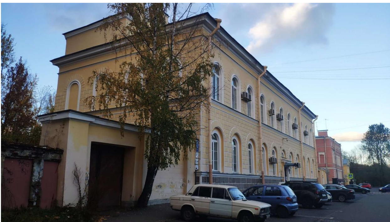
Фото 6. Общий вид объекта культурного наследия регионального значения «б.Здание Уездных присутственных мест»
