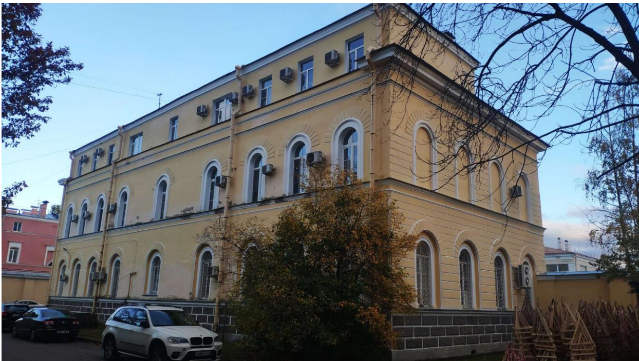
Фото 5. Общий вид объекта культурного наследия регионального значения «б.Здание Уездных присутственных мест»
