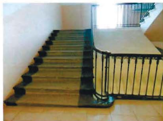
7, 8, 9. Внутренняя лестница по сводам.
