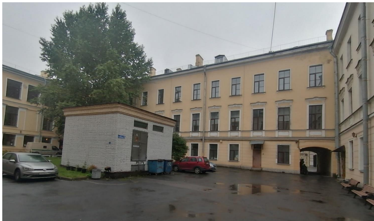
Фото 4. Здание детского отделения городской поликлиники №27. Западный фасад со стороны двора. Общий вид. 12.10.2022г.
