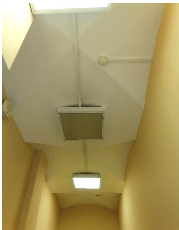
Фото 47. Здание детского отделения городской поликлиники №27. Коридор первого этажа. 6ЛК, II. 12.10.2022г.
