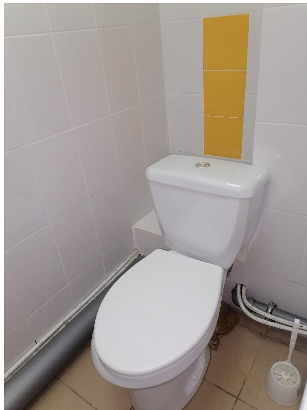
Фото 45. Здание детского отделения городской поликлиники №27. Санитарные комнаты. Пом.33 (1-Н). 12.10.2022г.
