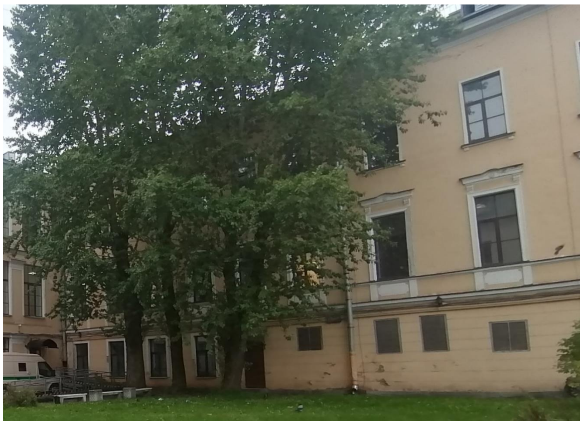
Фото 17. Здание детского отделения городской поликлиники №27. Западный фасад со стороны двора (у южной части здания). 12.10.2022г.
