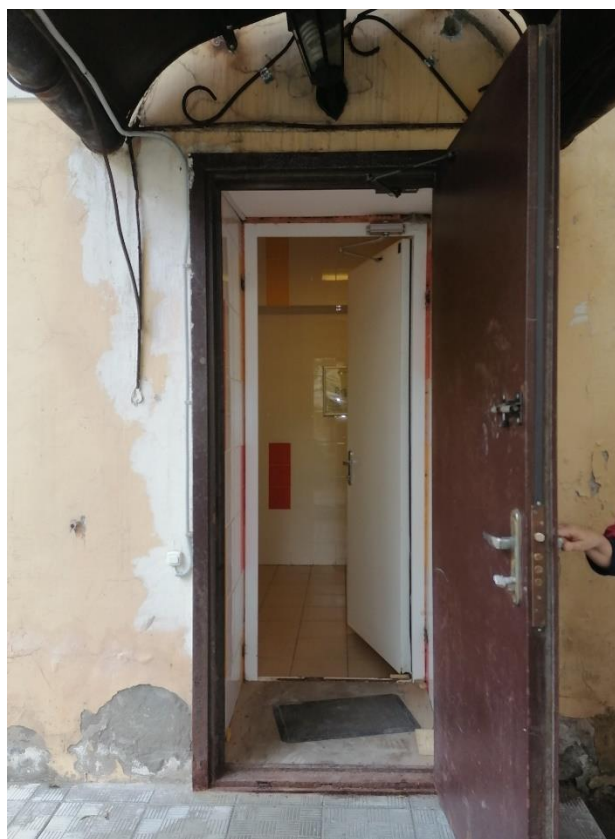
Фото 35. Здание детского отделения городской поликлиники №27. Вход с дворовой территории в пом.41 (10-Н). 12.10.2022г.
