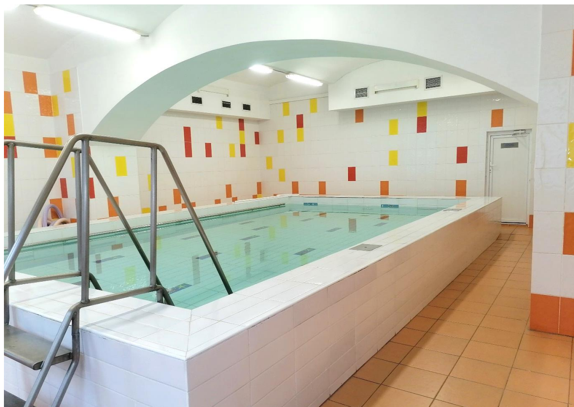
Фото 49. Здание детского отделения городской поликлиники №27. Лечебный бассейн на первом этаже. Пом.23 (1-Н). 12.10.2022г.
