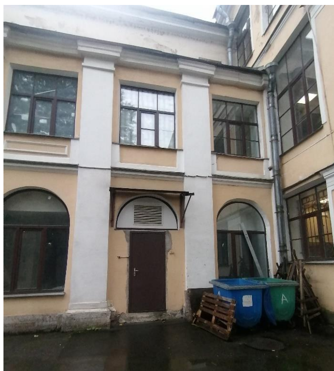
Фото 11. Здание детского отделения городской поликлиники №27. Служебный вход со стороны восточного дворового фасада. 12.10.2022г.
