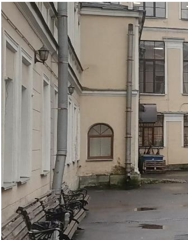
Фото 12. Здание детского отделения городской поликлиники №27. Фрагмент раскреповки дворового восточного фасада. 12.10.2022г.
