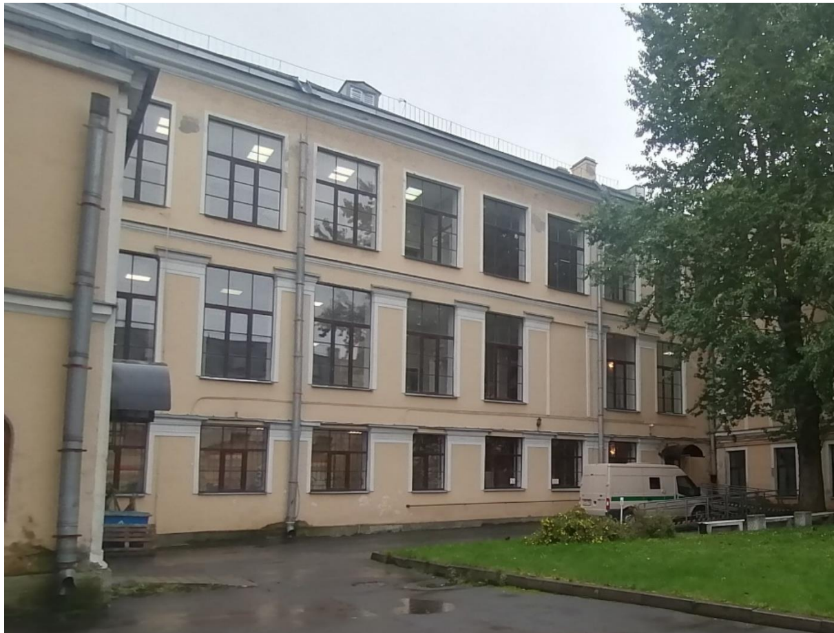
Фото 14. Здание детского отделения городской поликлиники №27. Южный фасад со стороны двора. 12.10.2022г.
