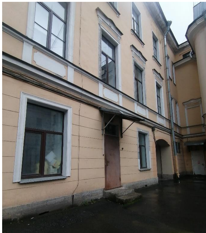
Фото 23. Здание детского отделения городской поликлиники №27. Фрагмент дворового западного фасада в примыкании к части здания, где размещается пенсионный фонд. 12.10.2022г.
