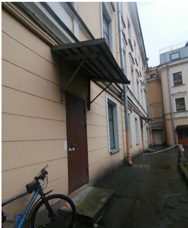
Фото 22. Здание детского отделения городской поликлиники №27. Служебный вход со стороны дворового западного фасада. 12.10.2022г.
