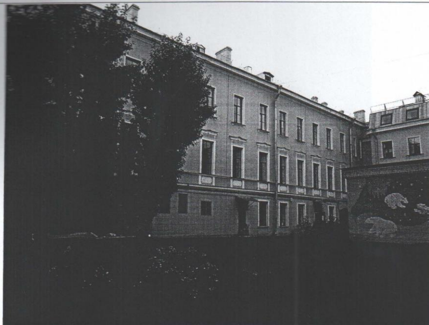
Дворовый фасад по ул. Глинки. Съёмка 04.10.2012. В.Ю.Белая
