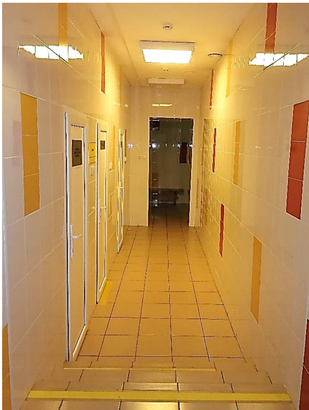
Фото 37. Здание детского отделения городской поликлиники №27. Коридор перед комплексом лечебного бассейна на первом этаже. Пом.30 (1-Н). 12.10.2022г.
