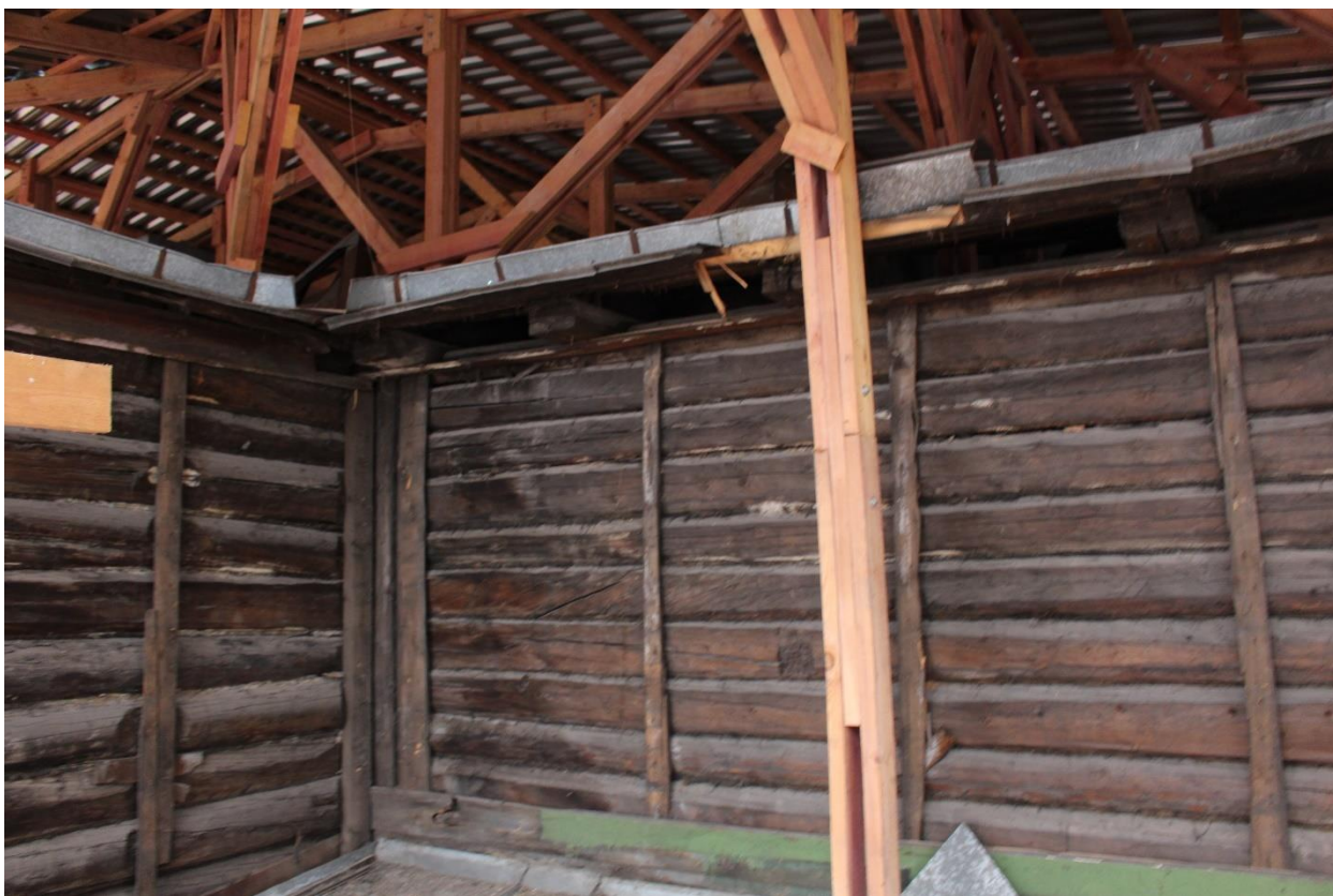
Фото 15. Вид на северо-западный фасад объекта культурного наследия регионального значения «Обособняк Э.Э. Бремме».
