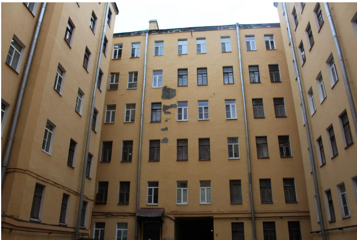
Фото 26. Вид на северо-восточный фасад западного дворового корпуса объекта культурного наследия регионального значения «Дом И.Д. Коробкова, В.Н. Самоцветовой».
