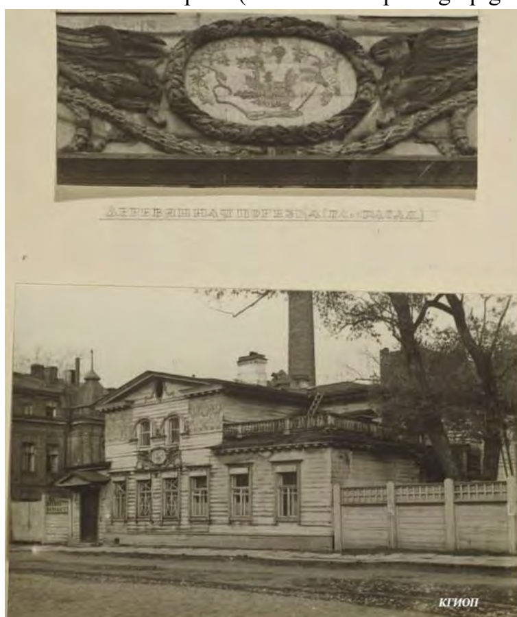
Илл. 85. Деревянная порезка. Вид с 12й линии. Обмеры 1942 г. Кроки. Жилой дом № 37 по 12-й линии Васильевского Острова (источник: https://kgior.gov.spb.ru/ ).
