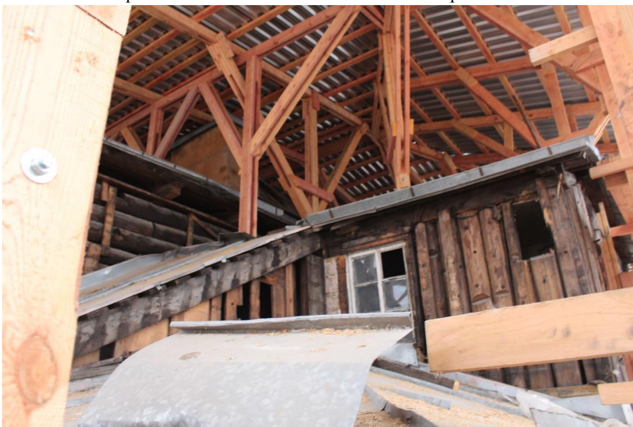
Фото 14. Вид на северо-западный фасад объекта культурного наследия регионального значения «Особняк Э.Э. Бремме».
