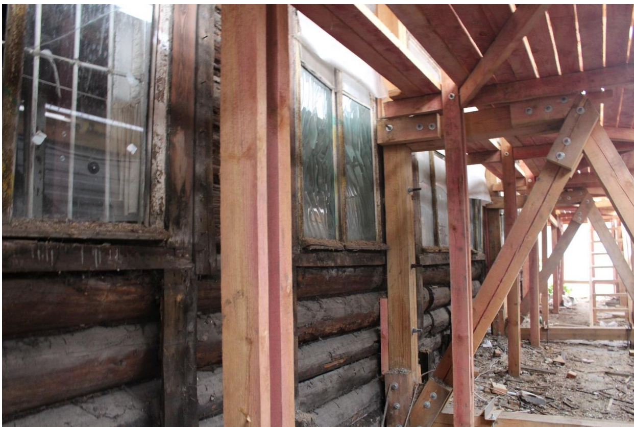
Фото 5. Вид на юго-западный фасад объекта культурного наследия регионального значения «Особняк Э.Э. Бремме».
