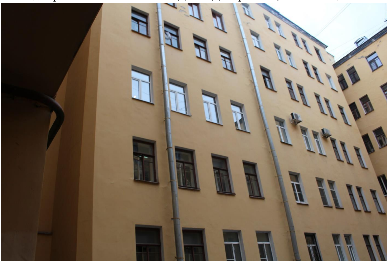
Фото 24. Вид на фасад северного дворового корпуса объекта культурного наследия регионального значения «Дом И.Д. Коробкова, В.Н. Самоцветовой».
