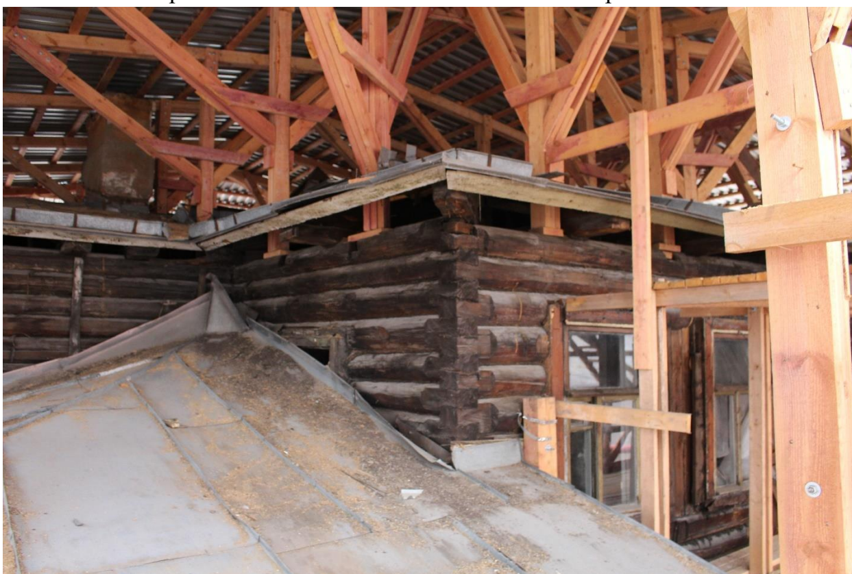
Фото 16. Вид на северо-западный фасад объекта культурного наследия регионального значения «Обособняк Э.Э. Бремме».
