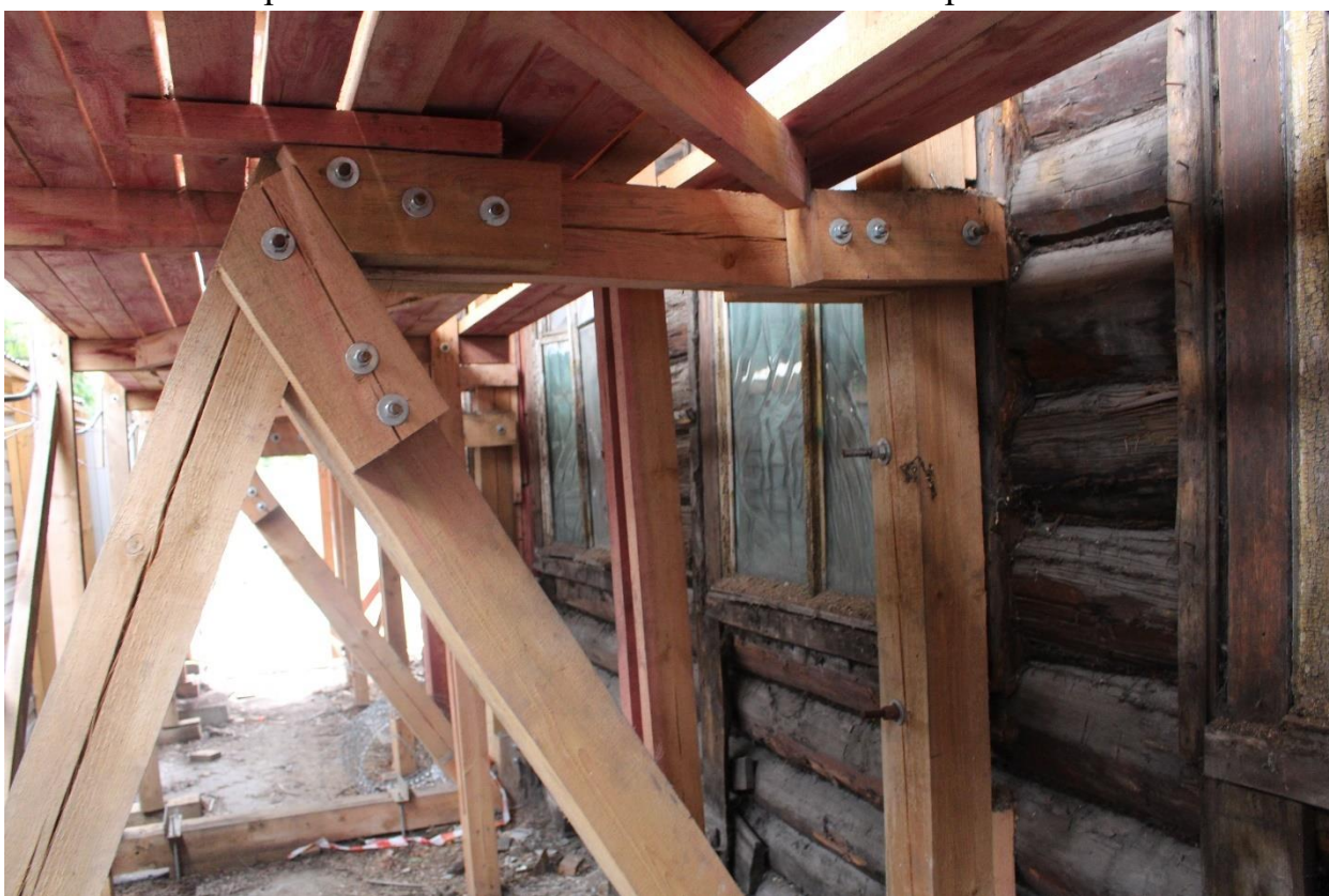
Фото 6. Вид на юго-западный фасад объекта культурного наследия регионального значения «Особняк Э.Э. Бремме».
