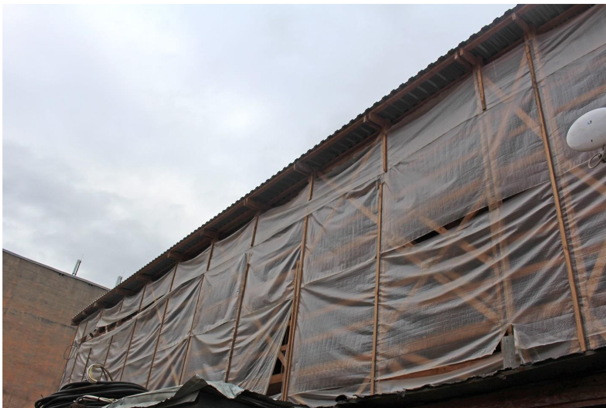
Фото 3. Вид на северо-восточный фасад объекта культурного наследия регионального значения «Особняк Э.Э. Бремме».
