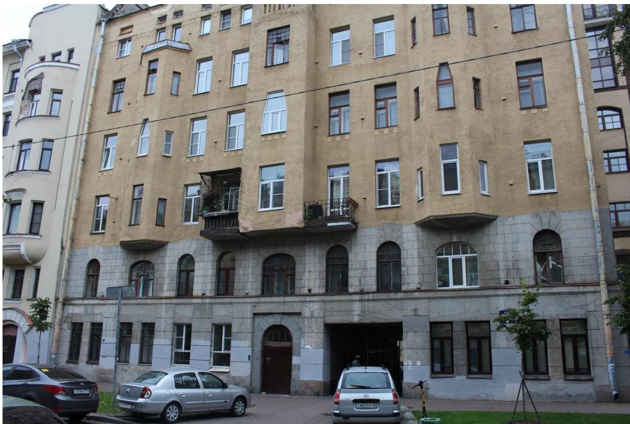
Фото 30. Вид на лицевой (северо-восточный) фасад выявленного объекта культурного наследия «Дом И.Л. Львова».
